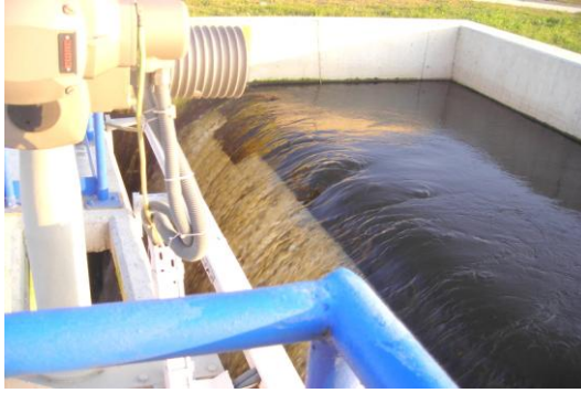
Şekil 3.10. Arıtılmış su yapısı (Anonim 2006)
