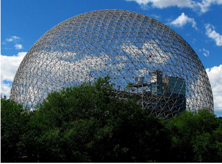
Şekil 2.13. R. B. Fuller'in Montreal fuarında (1967) yaptığı jeodezik kubbe
