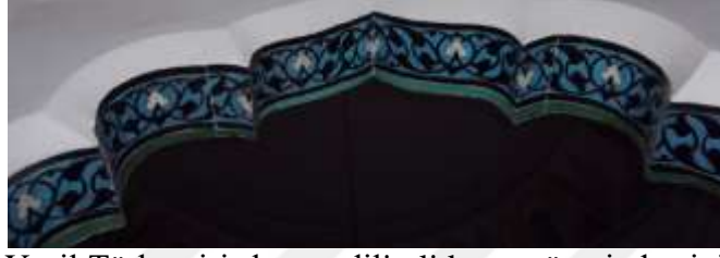
Şekil 2. 76. Bursa Yeşil Türbe giriş kapısı dilimli kemer üzerinde çini uygulaması (Gök arşivi) 09.02.2018
