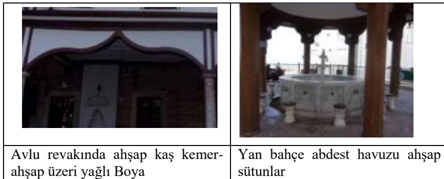
Şekil 4. 15. Bursa Emir Sultan Cami Taşıyıcı elemanlarda ahşap malzeme kullanımı (Gök arşivi) 07.12.2017
