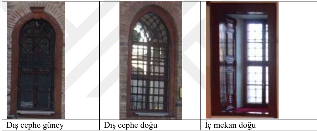
Şekil 4. 14. Bursa Emir Sultan Cami pencerelerde ahşap malzeme kullanımı (Gök arşivi) 07.12.2017
