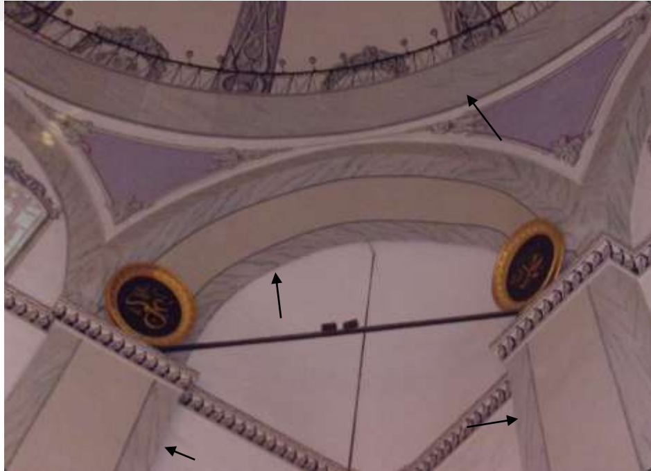
Şekil 4. 80. Pilastrlar, tromp ve kasnak bölümlerinde mermer görünümlü kalem işi (Gök arşivi) 09.02.2018
