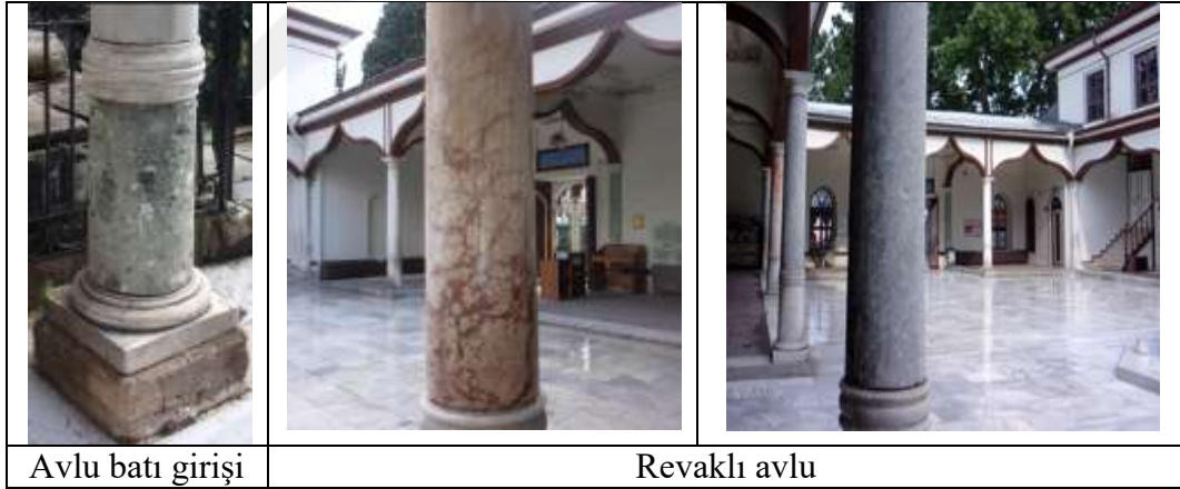
Şekil 4. 19. Bursa Emir Sultan Cami renkli taş uygulaması (Gök arşivi) 26.06.2018
