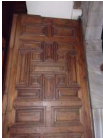
Şekil 2. 59. Bursa Ulu Cami Batı kapı kanadı düz yüzeyli oyma tekniği (Gök arşivi) 11.01.2018
