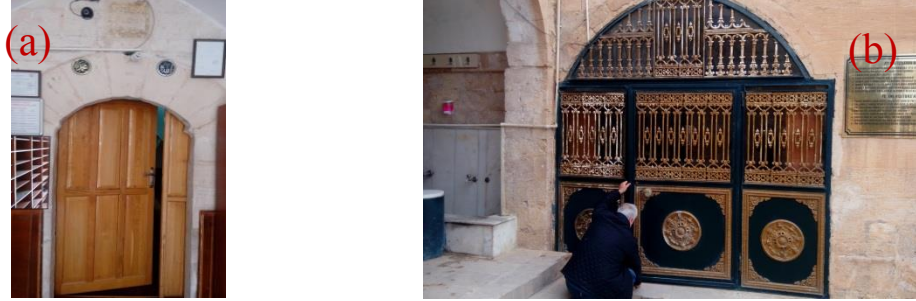
Şekil 4.185. 1 numaralı kapı(a), 2 numaralı kapı(b)
