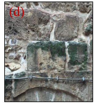
Şekil 4.326. Çimento k., yosunlaşma(a-b), yüzey kirlilięi(c), oyuklanma, yosunlaşma(d)
