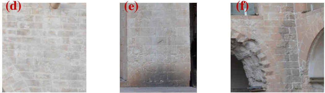
Şekil 4.454. Renk değişimi, kavlanma(d), oyuklanma(e), renk değişimi(f)
