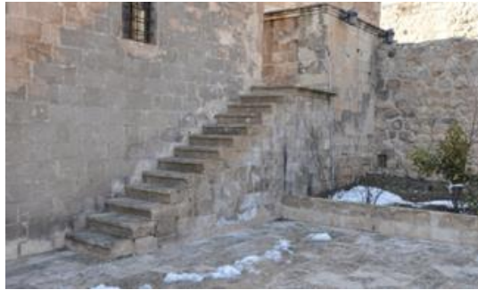
Şekil 4.135. Üst avluya çıkan merdiven görünüşü
