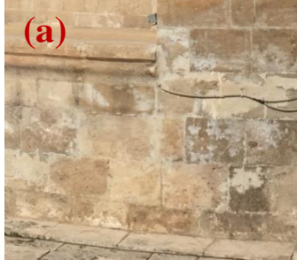
Şekil 4.374. Çimento kullanımı(a),çiçeklenme(b)
