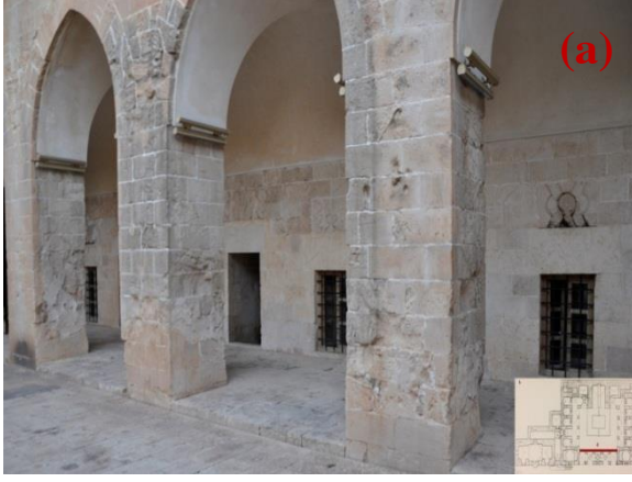
Şekil 4.435. Ayakta yüzey kaybı, oyuklanma(a), yüzeyde oyuklanma(b)
