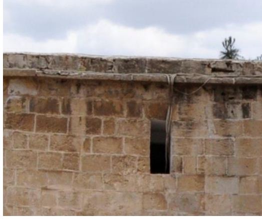
Şekil 4.74. Çimento kullanımı, Renk değişimi
