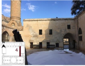
Şekil 4.141. Latifiye Cami iç avluya bakan doğu cephesindeki pencere ve kapılar
