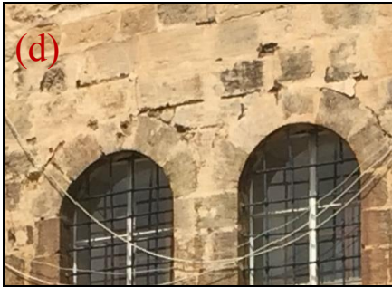
Şekil 4.317. Kavlanma(d), form kaybı(e)
