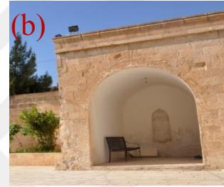
Şekil 4.294. 1 nolu mekânda kullanılan düz döşeme(a), 2 nolu mekânda beşik tonoz(b)
