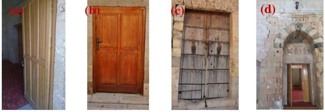
Şekil 4.432. Tip 5(5 ve 6 numaralı kapı)(a), Tip 6(7 numaralı kapı)(b), Tip 7(8 numaralı Kapı)(c), Tip 8(9 numaralı kapı)(d)
