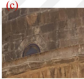
Şekil 4.59. Renk değişimi(c), renk değişimi ve çimento kullanımı(d)
