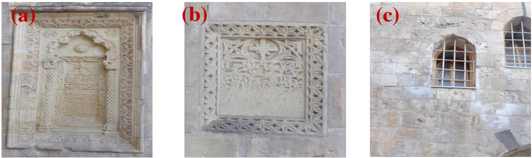
Şekil 4.476. Form kaybı (a), Form kaybı(b), Renk değişimi ve Oyuklanma(c)
