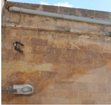
Şekil 4.264. Renk değişimi(a), Renk değişimi(b), Boşluk-delik(c)
