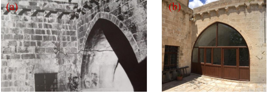
Şekil 4.230. Hamidiye Cami kuzey kanadı revaklı kısım, 1967(Altun 1971) (a), Hamidiye Cami kuzey kanadındaki revakların kapatılmış mevcut durumu, 2017(b)
