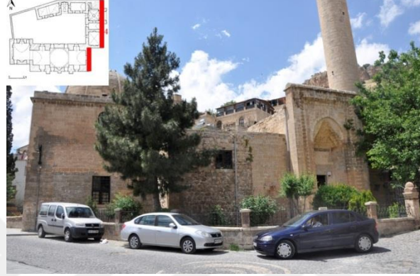
Şekil 4.54. Yapı doğu kanadının meydana bakan doğu cephesi
