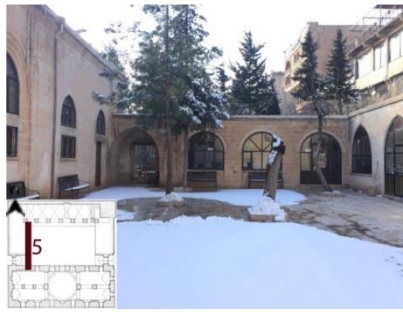
Şekil 4.142. Latifiye Cami batı cephesindeki pencere ve kapılar
