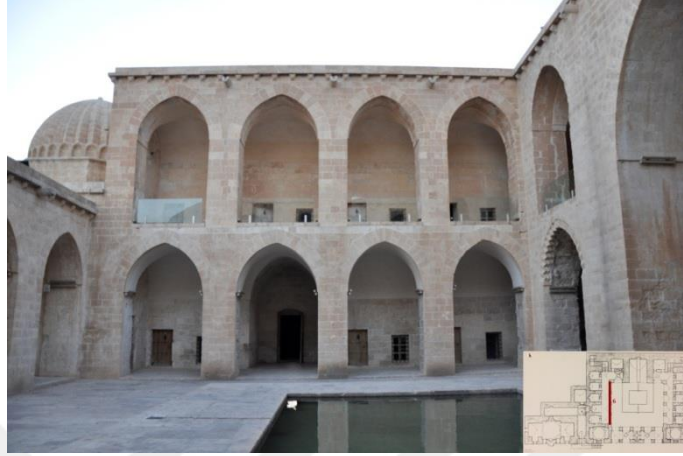
Şekil 4.443. Kasımiye Medresesi avlu batı cephesi
