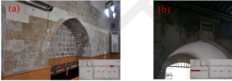
Şekil 4.267. İç mekânda duvarda çiçeklenme(a) , renk değişimi(b)
