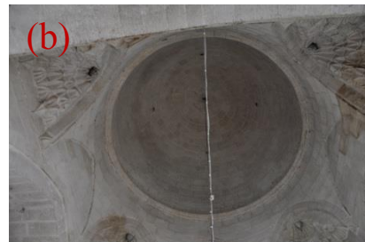
Şekil 4.271. 5 numaralı mekânda çapraz tonoz kullanımı(a), 6 numaralı mekânda kullanılan kubbe(b)
