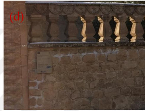
Şekil 4.110. Çiçeklenme(c), Çiçeklenme(d)
