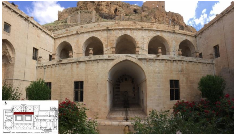
Şekil 4.400. Avlu güney cephesi(2 numaralı cephe)
