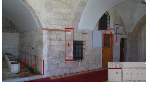
Şekil 4.265. İç mekânda duvarda Yosunlaşma(a) , Çimento(b) kullanımı
