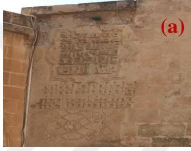
Şekil 4.367. Form kaybı(a), renk değişimi ve çimento kullanımı(b)
