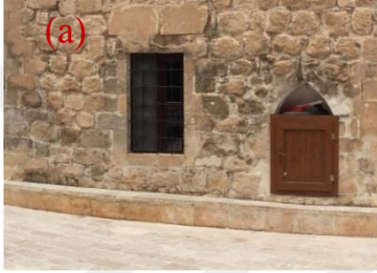
Şekil 4.66. Renk değişimi, çimento kullanımı(a),yosunlaşma(b)
