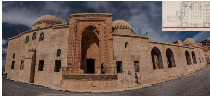
Şekil 4.438. Kasımiye Medresesi güney cephesi(1 numaralı cephe)
