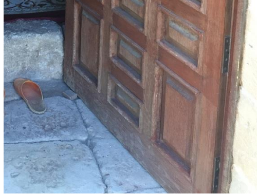
Şekil 4.303. 3 nolu kapıda aşınma
