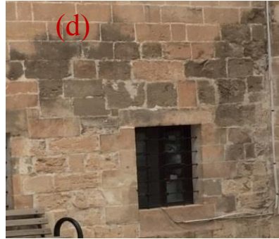
Şekil 4.67. Çimento kullanımı(c), renk değişimi ve çimento kullanımı(d)
