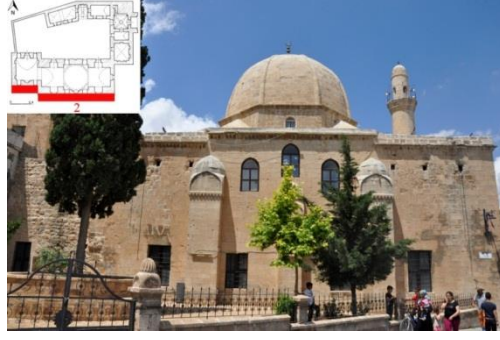
Şekil 4.52. Camii sokağa açılan güney cephesi
