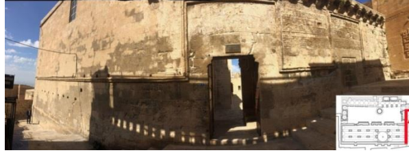
Şekil 4.9. Ulu Cami sokağa bakan doğu cephesi
