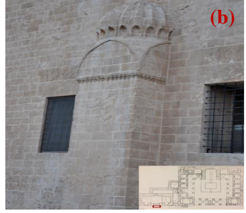
Şekil 4.435. Ayakta yüzey kaybı, oyuklanma(a), yüzeyde oyuklanma(b)
