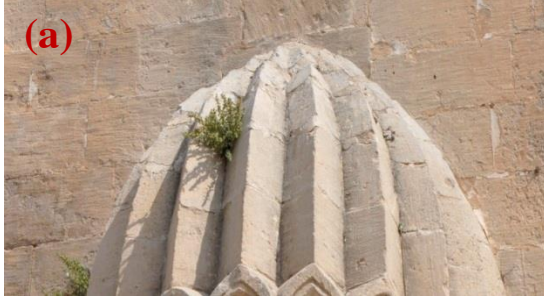
Şekil 4.423. Kubbede bitki oluşumu(a), 5 numaralı mekânda düz döşemede yosunlaşma(b)
