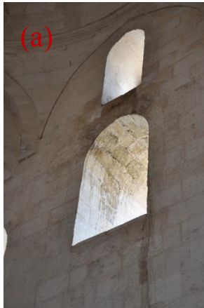
Şekil 4.76. Renk değişimi(a), renk değişimi(b), oyuklanma (c)
