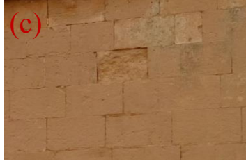
Şekil 4.173. Yüzey kaybı(c), boşluk-delik oluşumu ve pas lekesi(d)
