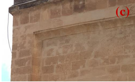
Şekil 4.368. Çimento kullanımı(c), çimento kullanımı(d)
