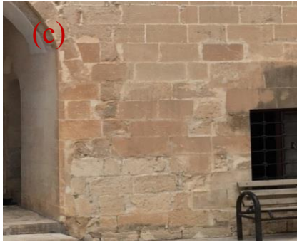
Şekil 4.67. Çimento kullanımı(c), renk değişimi ve çimento kullanımı(d)
