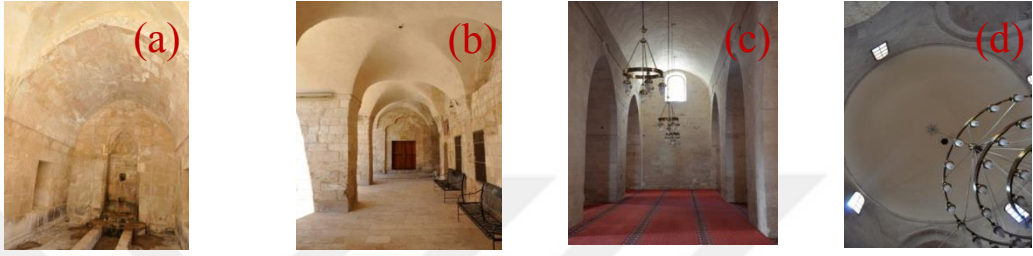
Şekil 4.33. 3 nolu mekânda sivri tonoz(a), 6 nolu mekânda çapraz tonozlar(b), 7 nolu mekânda beşik tonozlar(c), 8 nolu mekânda tonoz(d)
