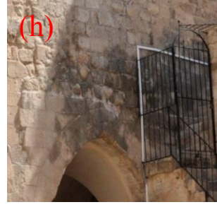
Şekil 4.20. Hatalı onarım (çimento kullanımı)(g), renk değişimi(h)
