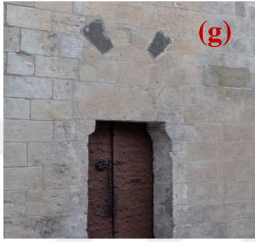
Şekil 4.478. Hatalı onarım(g), renk değişimi (h)
