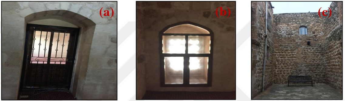
Şekil 4.340. İç mekânda kapı üzerinde kemer kullanımı(a), iç mekânda pencere üzerinde kemer kullanımı(b), iç avluda pencere üzerinde kemer kullanımı(c)
