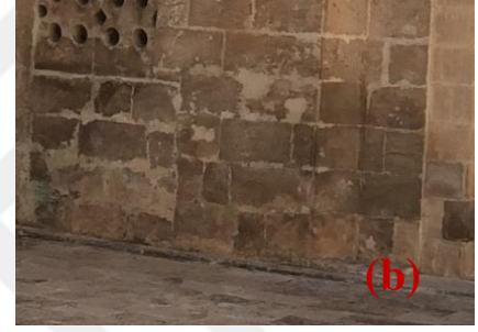
Şekil 4.367. Form kaybı(a), renk değişimi ve çimento kullanımı(b)
