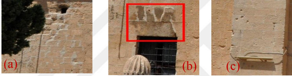
Şekil 4.62. Çimento kullanımı(a), renk değişimi, çimento kullanımı(b), oyuklanma(c)
