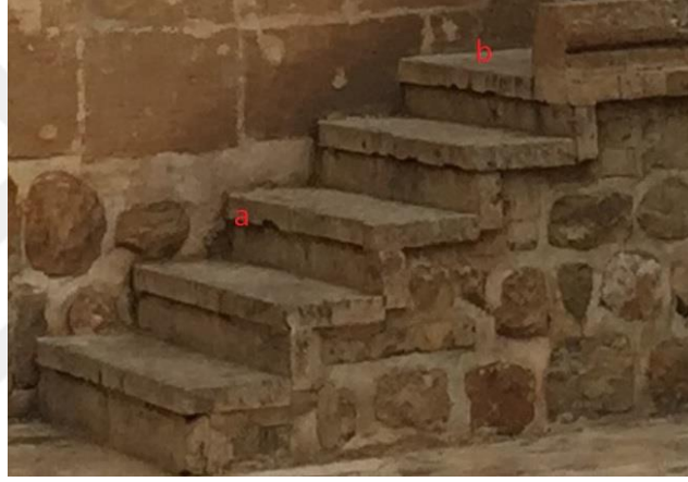
Şekil 4.332. Yüzey kaybı(a), aşınma(b)
