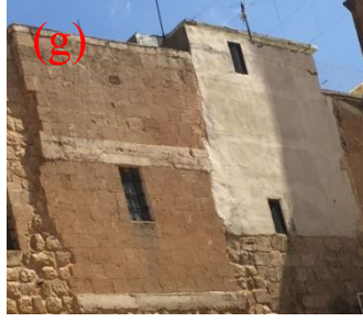
Şekil 4.20. Hatalı onarım (çimento kullanımı)(g), renk değişimi(h)
