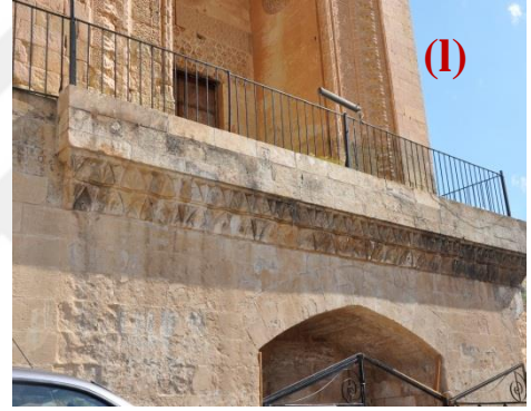
Şekil 4.415. Derz boşalması(k), oyuklanma(l)
