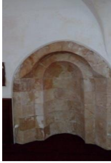
Şekil 4.177. İç mekânda mihrapta hatalı onarım
