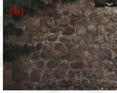
Şekil 4.69. Renk değişimi(a), renk değişimi, çimento kullanımı(b)
