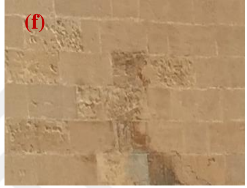
Şekil 4.412. Form Kaybı(e) ve oyuklanma(f)
