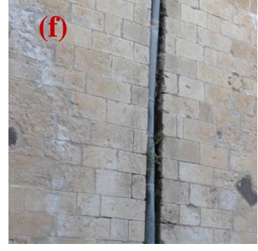
Şekil 4.477. Çiçeklenme (e), derz boşalması(f)
