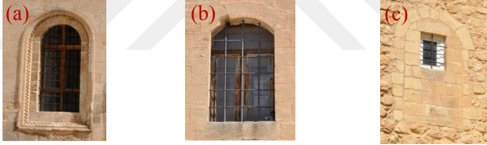
Şekil 4.43. 6 numaralı pencerede çatlak – kırık, aşınma ve renk değişimi(a), kuzey cephesinde ikinci kat özgün olmayan pencerede korozyon(b), kuzey cephesinde ikinci kat özgün olmayan pencerede hatalı onarım(c)
