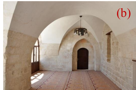
Şekil 4.242. 3 numaralı mekânda kubbe kullanımı(a), 4 numaralı mekânda kullanılan çapraz tonoz(b)
