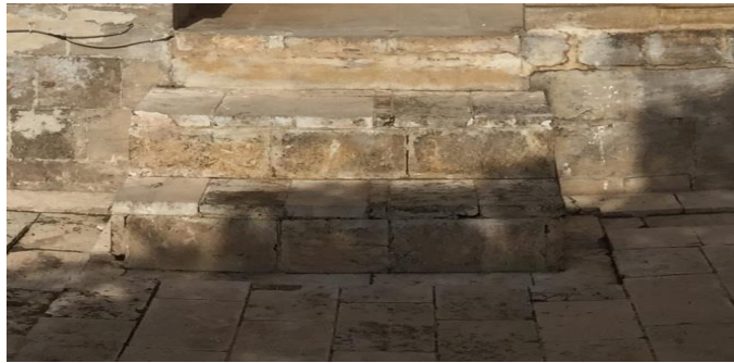
Şekil 4.381. Merdivende aşınma
