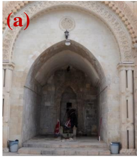
Şekil 4.377. 2 numaralı mekânda kullanılan beşik tonoz(a),3 numaralı mekânda beşik tonoz kullanımı(b),13 numaralı mekânda kullanılan çapraz tonozlar(c)
