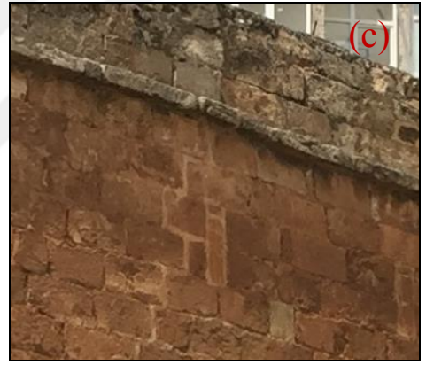
Şekil 4.316. Çiçeklenme (a-b), renk değişimi (c)
