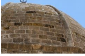
Şekil 4.79. 1 numaralı mekânda kubbede renk deęiřimi
