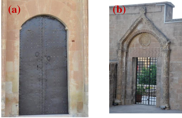
Şekil 4.516. 5 numaralı kapı(a), 7 numaralı kapı(b)
