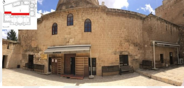
Şekil 4.51. Cami kuzey cephesi
