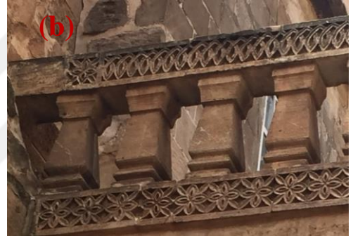
Şekil 4.345. Mukarnaslarda çimento kullanımı(a), şebekede yüzey kirliliği(b)
