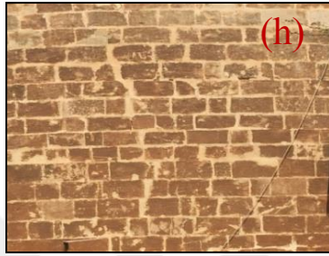
Şekil 4.319. Çimento kullanımı (h), renk değişimi(g)
