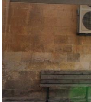
Şekil 4.264. Renk değişimi(a), Renk değişimi(b), Boşluk-delik(c)
