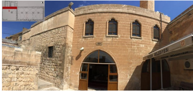
Şekil 4.258. Kuzey kanadı avluya bakan güney cephesi(1 numaralı cephe)
