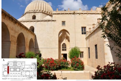
Şekil 4.402. Avlu doğu cephesi(4 numaralı cephe)
