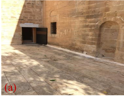
Şekil 4.289. Renk değişimi(a), renk değişimi ve hatalı onarım(b)
