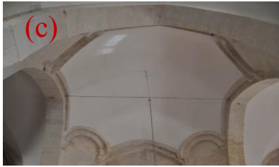
Şekil 4.295. 5 nolu mekânda kullanılan kubbe(c), 5 nolu mekânda çapraz tonoz kullanımı(d)
