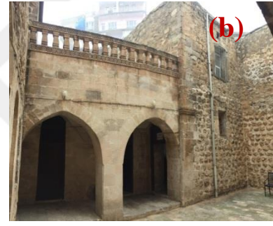
Şekil 4.343. Tromp kullanımı(a), iç avludaki şebekeler(b)
