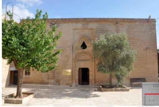
Şekil 4.284. Cami kuzey cephesi
