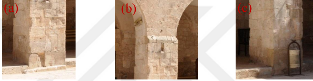
Şekil 4.15. Yüzey kaybı(a), boşluk-delik(b), renk değişimi(c)
