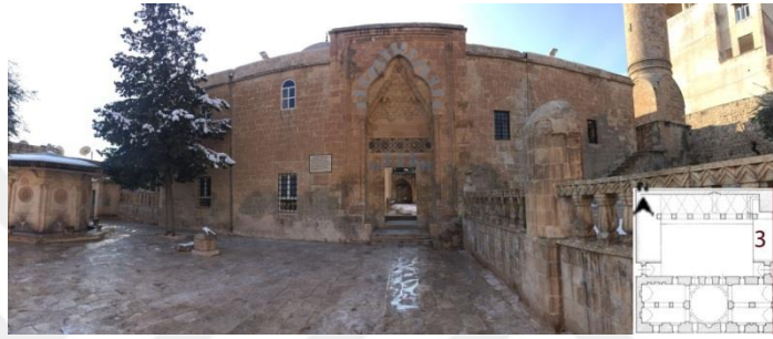
Şekil 4.101. Latifiye Cami ön avluya bakan doğu cephesi
