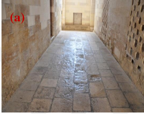
Şekil 4.424. 11 numaralı mekânda düz döşemede aşınma(a), 12 numaralı mekânda kubbede çimento kullanımı(hatalı onarım)(b)
