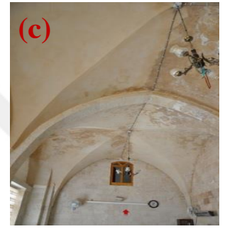
Şekil 4.377. 2 numaralı mekânda kullanılan beşik tonoz(a),3 numaralı mekânda beşik tonoz kullanımı(b),13 numaralı mekânda kullanılan çapraz tonozlar(c)
