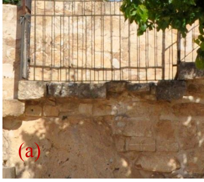
Şekil 4.298. Yüzey kaybı(a), yüzey kaybı ve renk deęiřimi(b)
