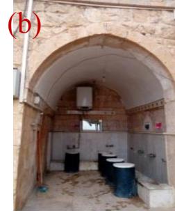
Şekil 4.179. 2 numaralı mekânda beşik ve çapraz tonoz kullanımı (a),5 numaralı mekânda sivri tonoz (b)
