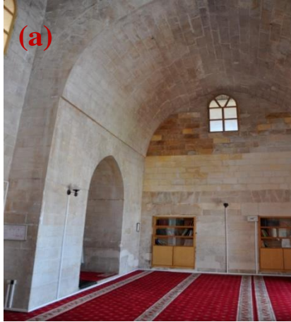
Şekil 4.425. 12 numaralı mekânda sivri tonozda çiçeklenme, renk değişimi(a), 13 numaralı mekânda çapraz tonozda sıvada kabarma, dökülme(b)
