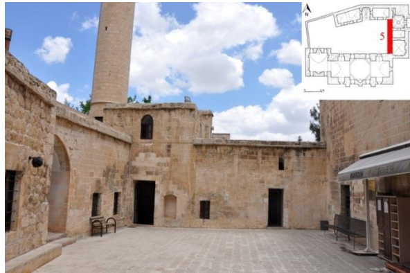
Şekil 4.55. Yapı doğu kanadı avluya bakan batı cephesi
