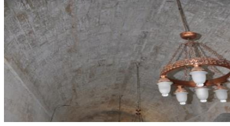
Şekil 4.200. 1 numaralı mekândaki tonozda renk deęiřimi, imento kullanımı
