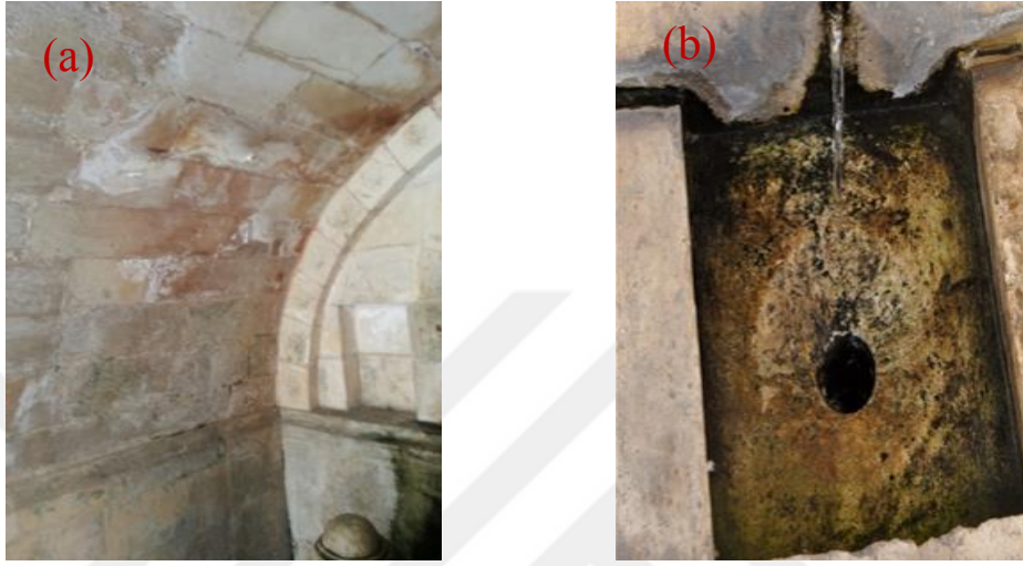
Şekil 4.130. Selsebil tonozunda çiçeklenme(a) ve renk değişimi, selsebilin havuzunda yosunlaşma(b)
