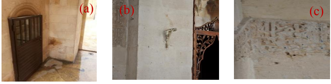
Şekil 4.128. Çiçeklenme, renk değişimi(a), iç duvarda oyuklanma(b), iç mekânda boşluk-delik(b)
