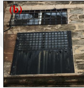
Şekil 4.338. Bahçe giriş kapısında paslanma(a), Metal kapıda paslanma(b)
