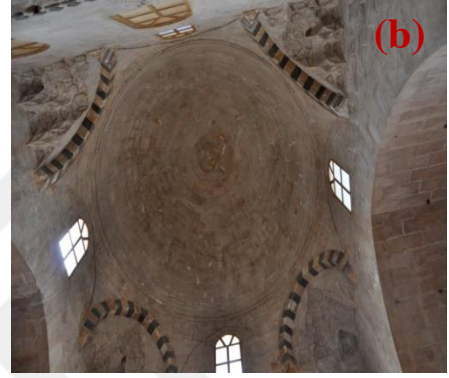
Şekil 4.424. 11 numaralı mekânda düz döşemede aşınma(a), 12 numaralı mekânda kubbede çimento kullanımı(hatalı onarım)(b)
