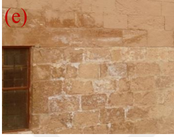
Şekil 4.174. Hatalı onarım(e), yüzey kaybı ve renk değişimi(f)
