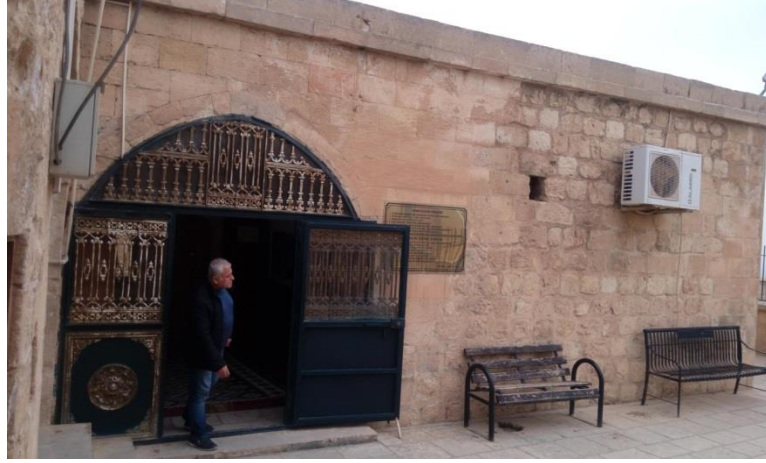
Şekil 4.167. Şeyh Çabuk Cami Batı Cephesi(2 numaralı cephe)
