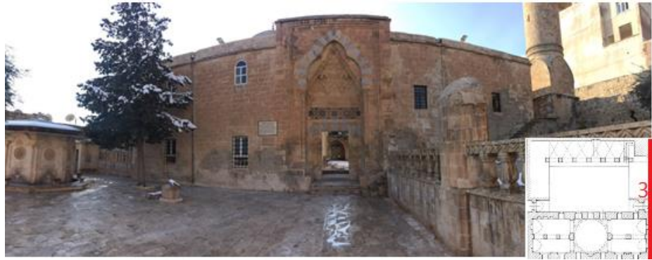
Şekil 4.140. Latifiye Cami ön avluya bakan doğu cephesindeki pencere ve kapılar
