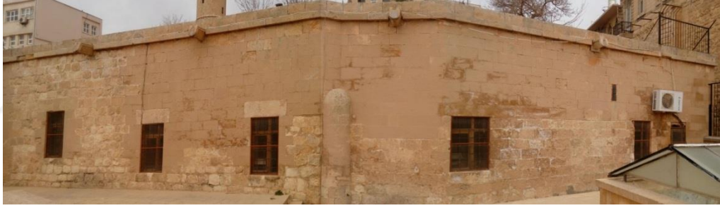
Şekil 4.166. Şeyh Çabuk Cami güney cephesi(1 numaralı cephe)
