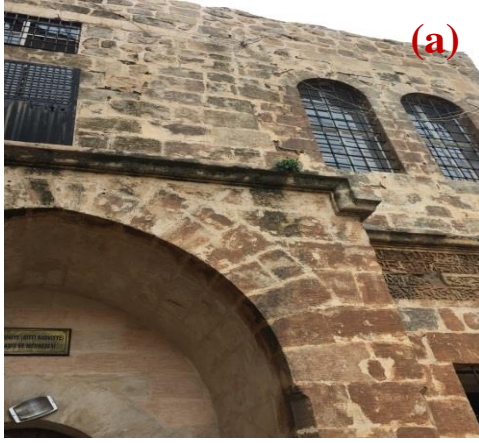
Şekil 4.344. Silmede kabuk oluşumu, yosunlaşma, bitki oluşumu(a), Çörtende yüzey kaybı(b)
