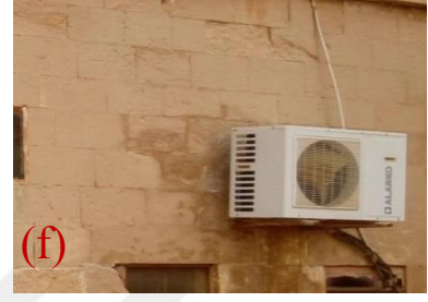
Şekil 4.174. Hatalı onarım(e), yüzey kaybı ve renk değişimi(f)
