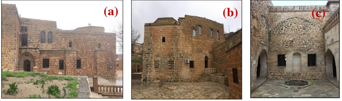
Şekil 4.339. Yapının güney cephesinde kemer kullanımı(a), Yapının doğu cephesinde kemer kullanımı(b), İç avluda kemer kullanımı(c)
