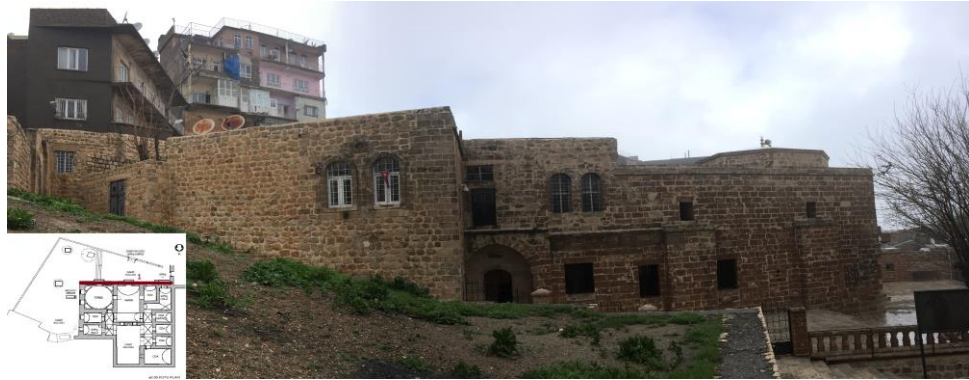
Şekil 4.310. 1 numaralı cephe- Cami güney Cephesi
