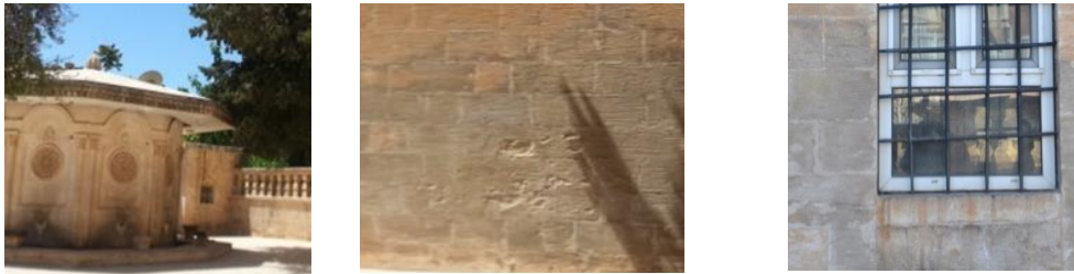
Şekil 4.118. Renk değişimi(a), oyuklanma(b), pas lekesi(c)
