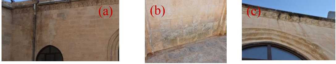
Şekil 4.115. Çiçeklenme ve renk değişikliği (a), oyuklanma(b), yüzey kirliliği(c)
