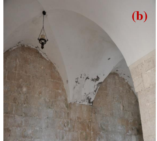
Şekil 4.425. 12 numaralı mekânda sivri tonozda çiçeklenme, renk değişimi(a), 13 numaralı mekânda çapraz tonozda sıvada kabarma, dökülme(b)
