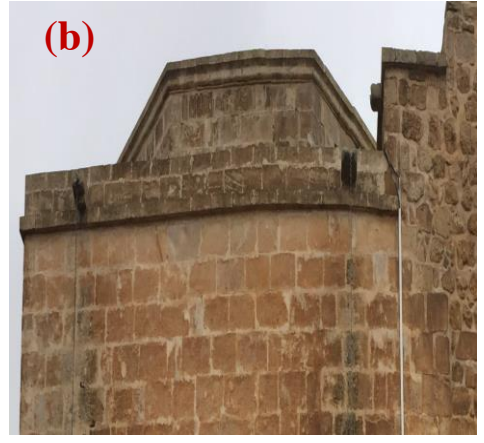
Şekil 4.344. Silmede kabuk oluşumu, yosunlaşma, bitki oluşumu(a), Çörtende yüzey kaybı(b)
