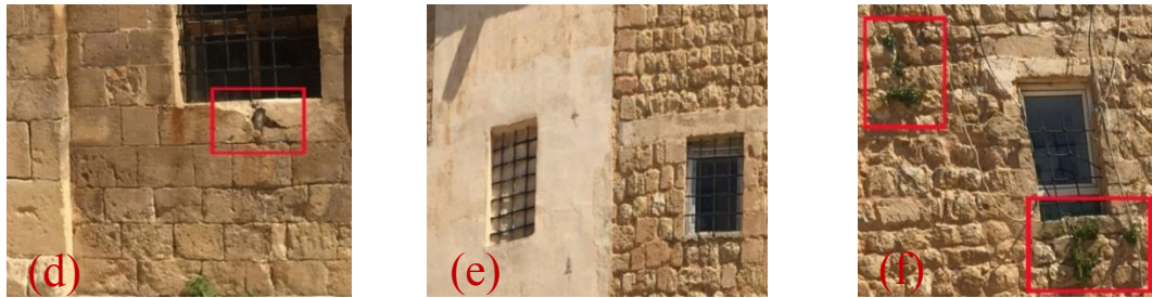
Şekil 4.19. Yüzey kaybı(d), hatalı onarım(e), bitki oluşumu(f)
