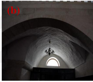
Şekil 4.377. 2 numaralı mekânda kullanılan beşik tonoz(a),3 numaralı mekânda beşik tonoz kullanımı(b),13 numaralı mekânda kullanılan çapraz tonozlar(c)
