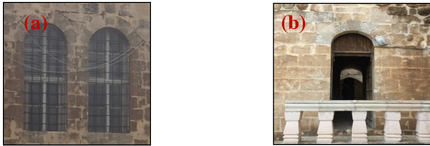
Şekil 4.341. Kemerde kavlanma(a), kemerde renk değişimi(b)
