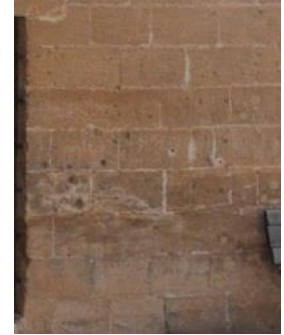
Şekil 4.264. Renk değişimi(a), Renk değişimi(b), Boşluk-delik(c)
