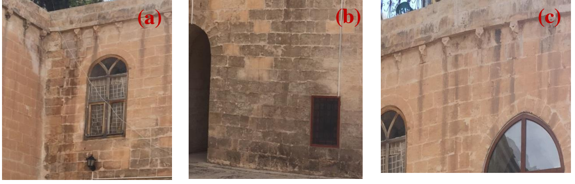
Şekil 4.371. Renk değişimi(a), Çimento kullanımı(b), Yüzey kirliliği(c)
