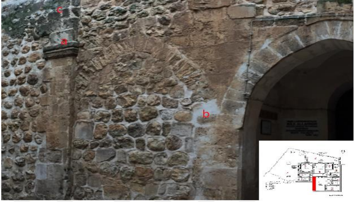
Şekil 4.314. Ayakta çimento k.(a), ayakta çimento kullanımı(b) ,hatalı onarım (c)
