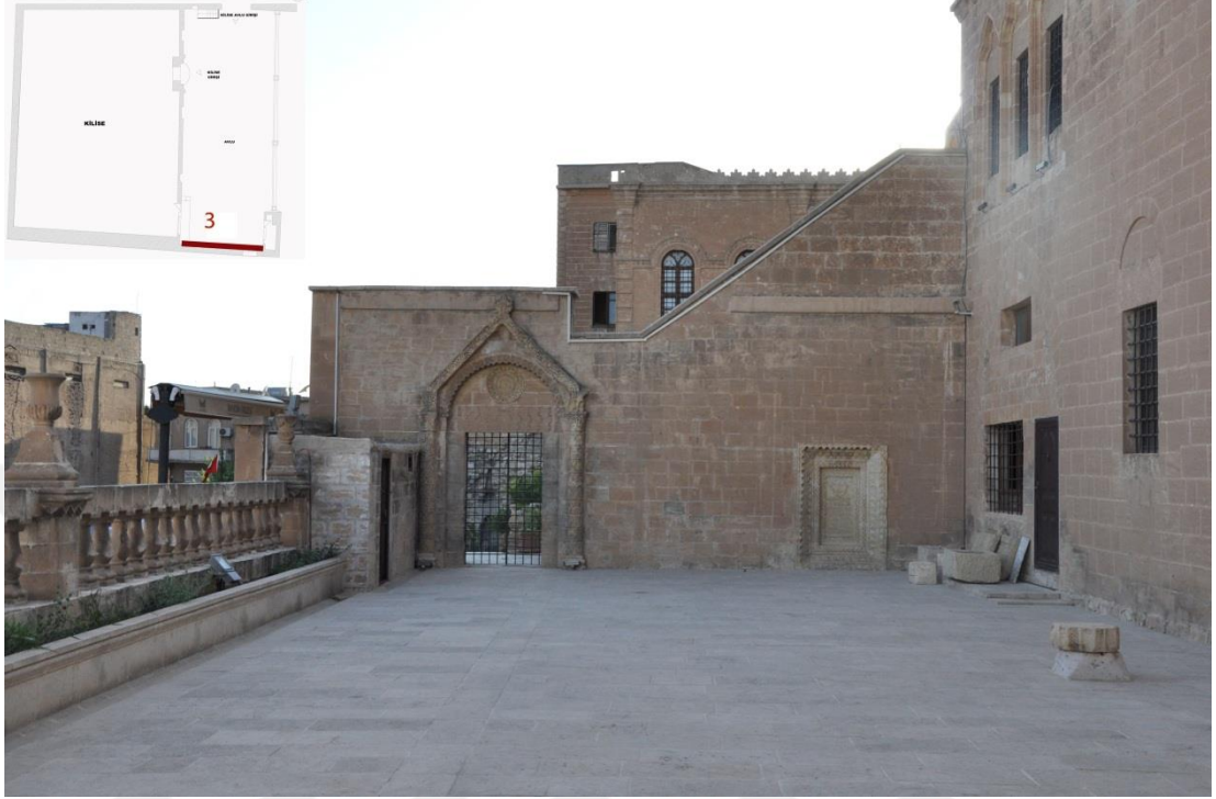
řekil 4.504. Avlu dođu cephesindeki duvarlarda yzey kaybı, sjslemelerde form kaybı ve renk deđiřimi ve hatalı onarımlar
