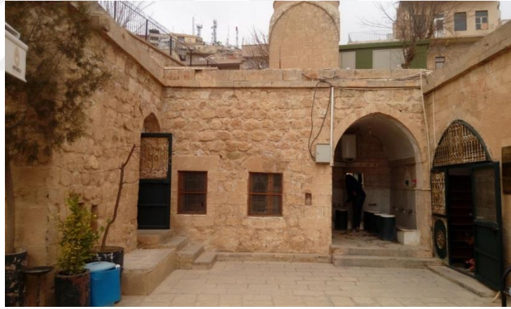
Şekil 4.168. Şeyh Çabuk Cami Avlu Kuzey Cephesi(3 numaralı cephe)
