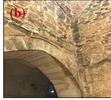
Şekil 4.342. Hatalı onarım(a), kemerde renk değişimi (b)
