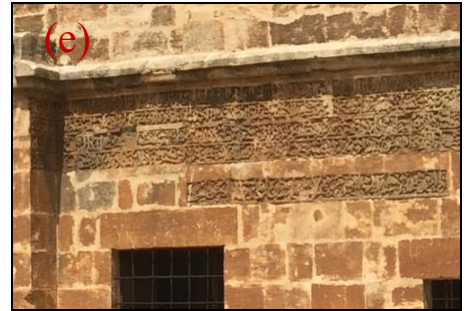
Şekil 4.317. Kavlanma(d), form kaybı(e)
