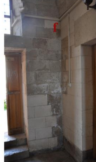
Şekil 4.420. İç mekânda duvarlarda bozulmalar: çiçeklenme (a) , çiçeklenme- renk değişimi(b), çiçeklenme-renk değişimi(c), renk değişimi-çimento kullanımı(d) ,renk değişimi(e) ,çiçeklenme-renk değişimi(f) (Altun 2006'deki plan üzerinden işlenerek)
