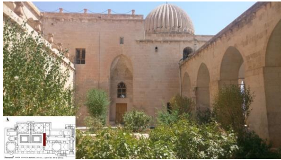
Şekil 4.403. Avlu batı cephesi(5 numaralı cephe)
