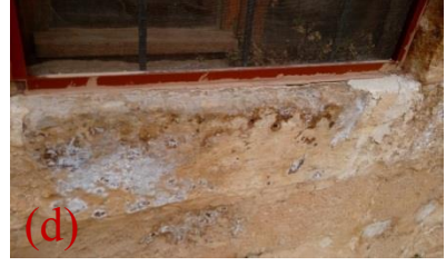
Şekil 4.173. Yüzey kaybı(c), boşluk-delik oluşumu ve pas lekesi(d)
