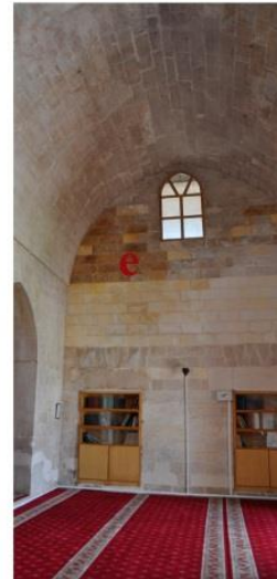
Şekil 4.420. İç mekânda duvarlarda bozulmalar: çiçeklenme (a) , çiçeklenme- renk değişimi(b), çiçeklenme-renk değişimi(c), renk değişimi-çimento kullanımı(d) ,renk değişimi(e) ,çiçeklenme-renk değişimi(f) (Altun 2006'deki plan üzerinden işlenerek)
