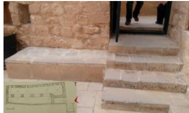
Şekil 4.181. Merdivende aşınma
