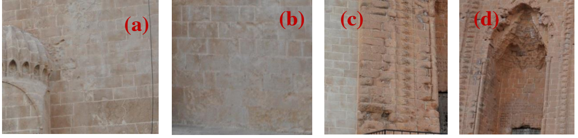
Şekil 4.449. Oyuklanma(a), oyuklanma (b), yüzey kaybı, derz boşalması(c), form kaybı(d)
