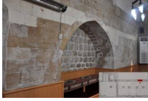
Şekil 4.279. Kemerde çiçeklenme, renk değişimi
