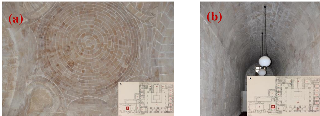
Şekil 4.458. (1 numaralı mekânda) kubbede renk değişimi(a), 2 numaralı mekânda beşik tonozda çiçeklenme(b)
