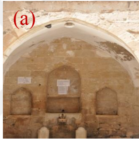
Şekil 4.81. 5 numaralı mekânda sivri tonozda hatalı onarım(a), 8 numaralı mekânda yıldız tonozda çiçeklenme, renk deęiřimi(b)
