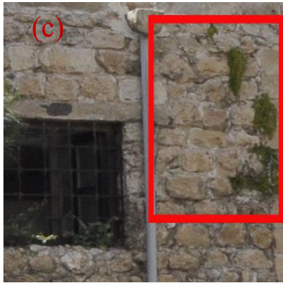
Şekil 4.70. Bitki oluşumu(c), hatalı onarım(d)
