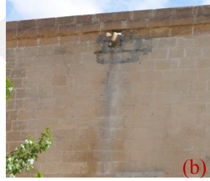
Şekil 4.289. Renk değişimi(a), renk değişimi ve hatalı onarım(b)
