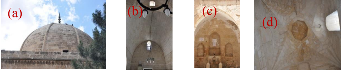
Şekil 4.78. 1 numaralı mekânda kullanılan kubbe(a), 1 numaralı mekânda sivri tonoz kullanımı(b), 5 nolu mekânda beşik tonoz kullanımı(c), 8 nolu mekânda kullanılan yıldız tonoz(d)
