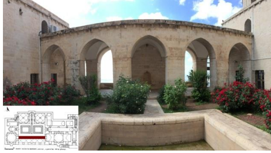
Şekil 4.399. Avlu kuzey cephesi(1 numaralı cephe)
