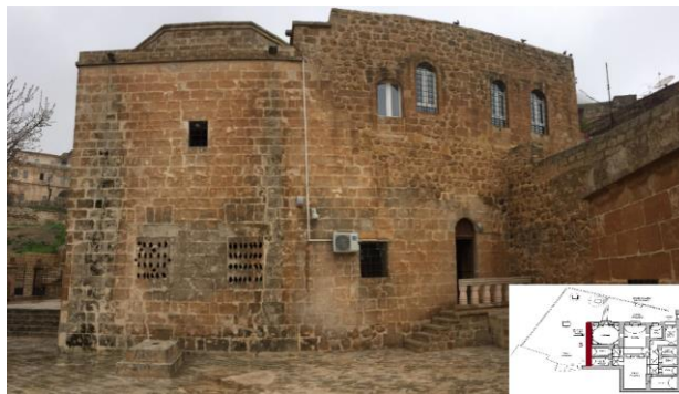
Şekil 4.334. Hatuniye medresesi doğu cephesinde duvar boşlukları
