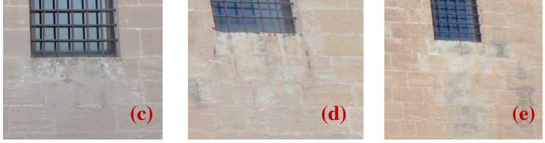
Şekil 4.501. Pas lekesi(c),pas lekesi(d), pas lekesi ve renk deęiřimi(e)
