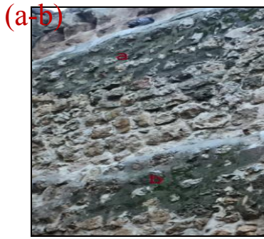
Şekil 4.326. Çimento k., yosunlaşma(a-b), yüzey kirlilięi(c), oyuklanma, yosunlaşma(d)
