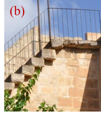
Şekil 4.298. Yüzey kaybı(a), yüzey kaybı ve renk deęiřimi(b)
