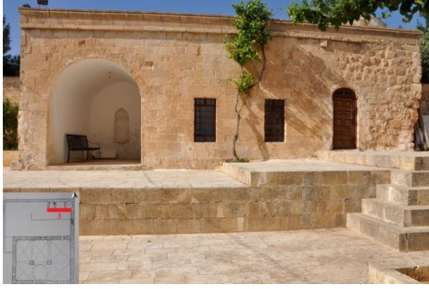
Şekil 4.286. Yapı ekleri avluya açılan güney cephesi (3 numaralı cephe)
