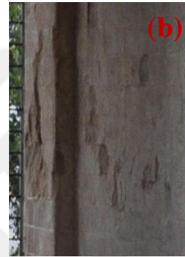
Şekil 4.456. Form kaybı, renk değişimi, hatalı onarım(a), yüzey kaybı(b)
