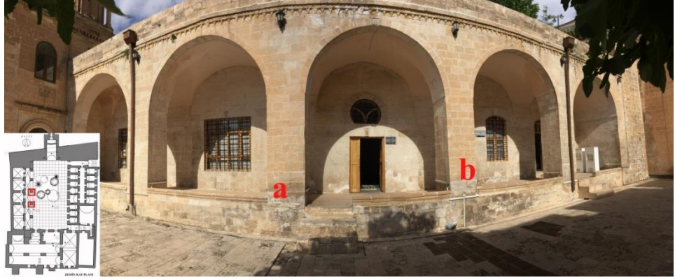
Şekil 4.361. Yapıda ayaktaki bozulmalar
