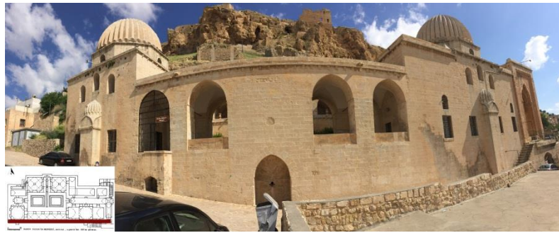
Şekil 4.401. Sokağa açılan güney cephesi(3 numaralı cephe)
