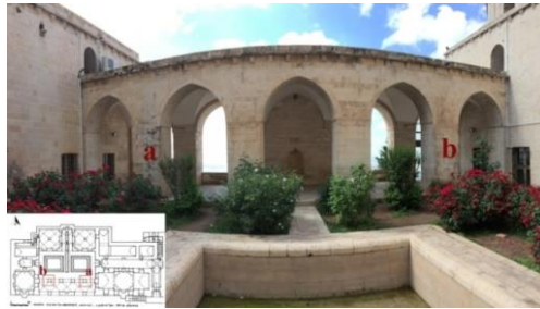
Şekil 4.405. Yapıda ayaktaki bozulmalar renk değişimi(a), çimento kullanımı(b)
