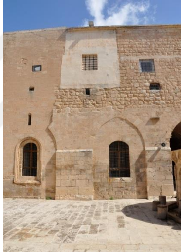
Şekil 4.2. Kuzey cephesindeki batı kısmında kapatılmış revaklar
