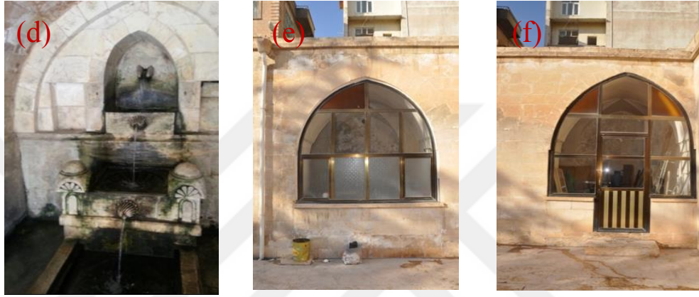
Şekil 4.113. Yosunlanma, renk değişimi(d), çiçeklenme- renk değişimi(e), yosunlanma- renk değişimi(f)
