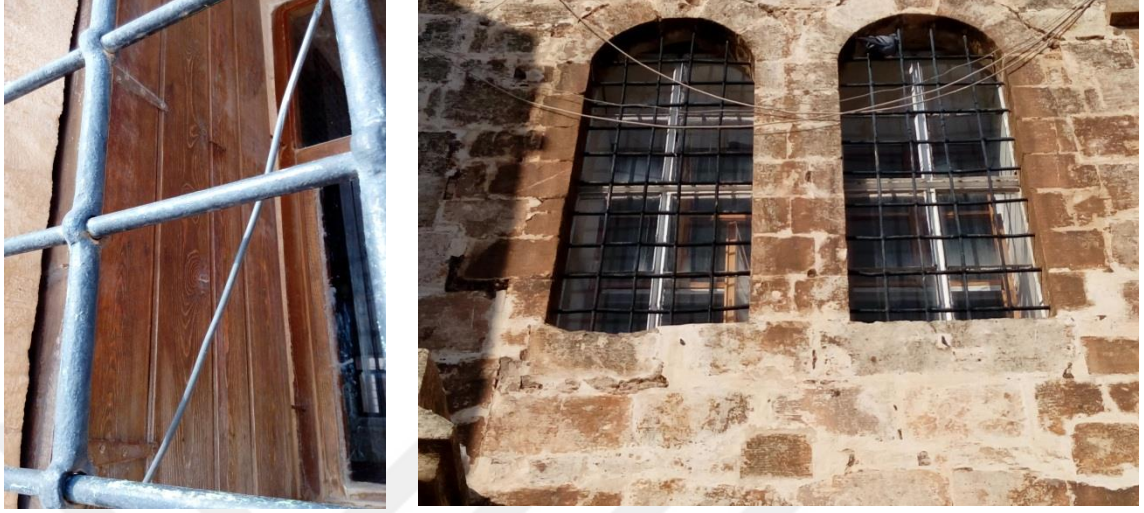
Şekil 4.335. Cephedeki ahşap pencerelerde çatlak-kırık, biçimsel deformasyon, aşınma, renk değişimi
