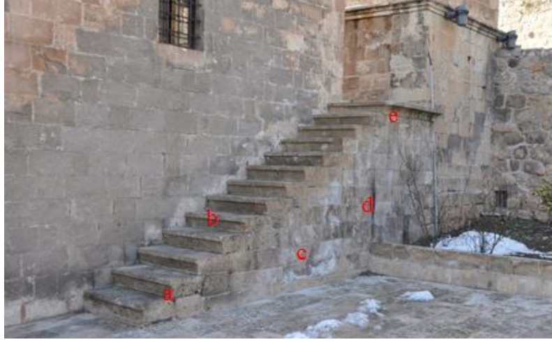
Şekil 4.136. Oyuklanma(a),Aşınma(b),Çiçeklenme(c),Yüzey kirliliği(d),Yosunlaşma(e)
