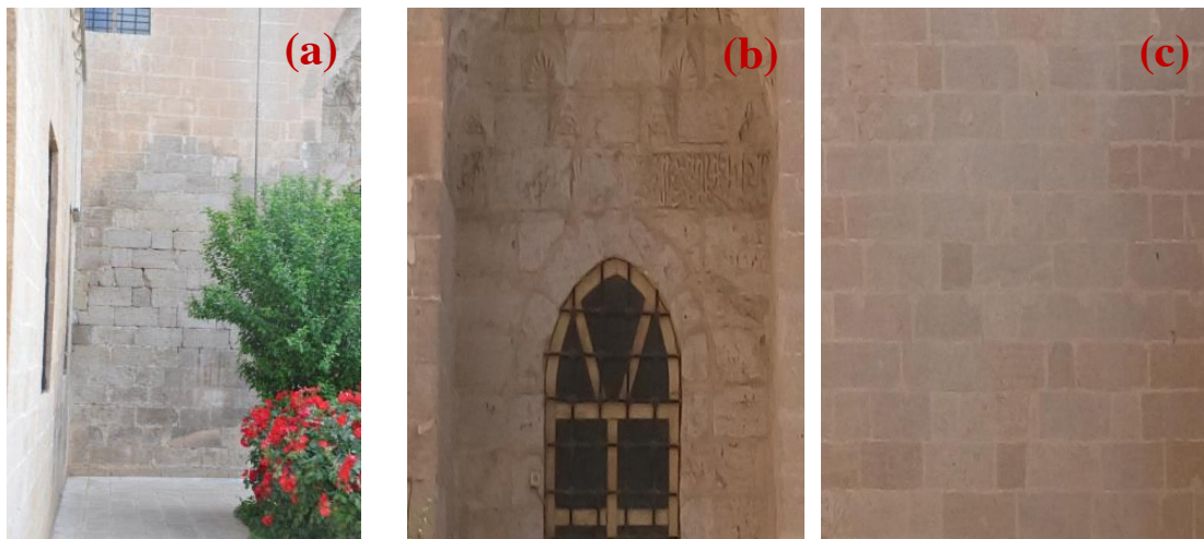
Şekil 4.419. Derz boşalması, renk değişimi(a), form kaybı(b), renk değişimi(c)
