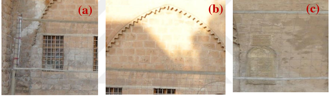
Şekil 4.481. Çiçeklenme-renk değişimi (a), oyuklanma(b), Form kaybı- hatalı onarım(c)
