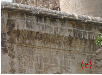
Şekil 4.71. Renk değişimi(e), renk değişimi ve çimento kullanımı(f)
