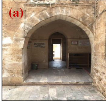
Şekil 4.342. Hatalı onarım(a), kemerde renk değişimi (b)
