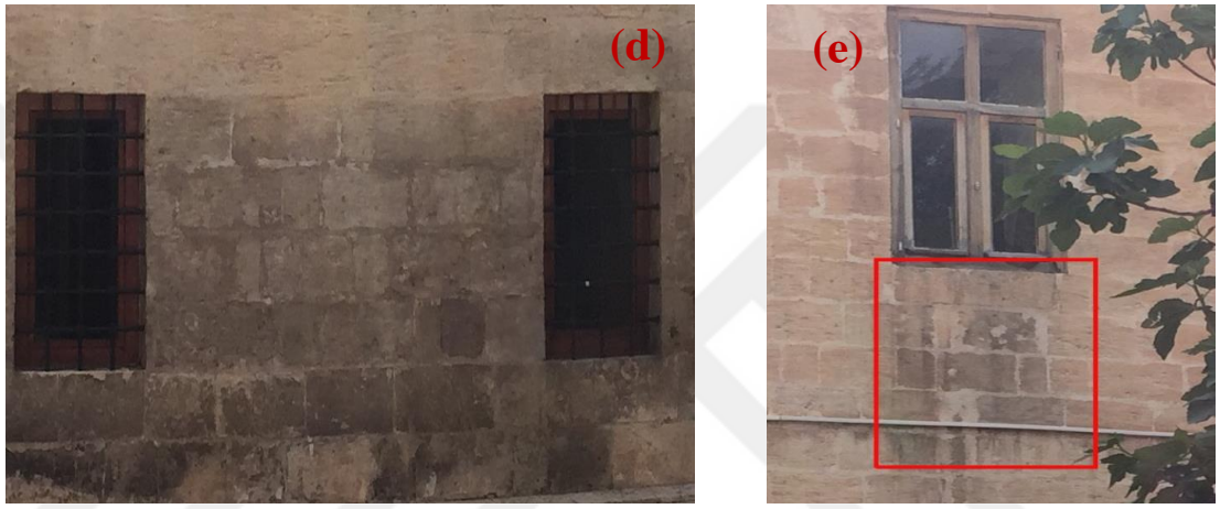
Şekil 4.372. Renk değişimi(d), çimento kullanımı(e)
