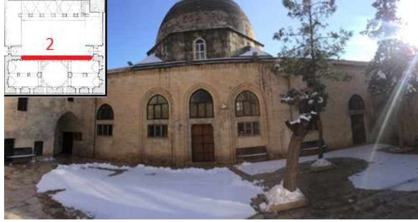
Şekil 4.139. Latifiye Cami güney cephesindeki pencere ve kapılar
