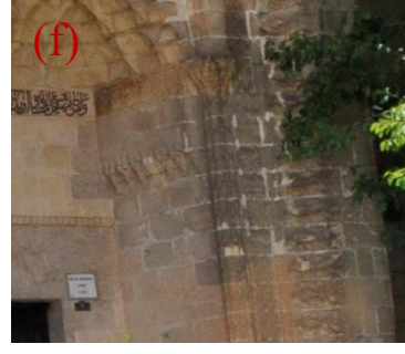
Şekil 4.71. Renk değişimi(e), renk değişimi ve çimento kullanımı(f)
