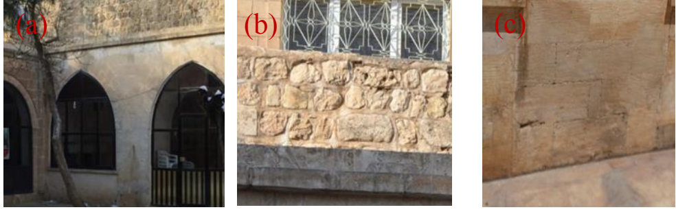
Şekil 4.112. Çiçeklenme(a), Boşluk-delik(b), Derz boşalması(c)
