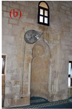
Şekil 4.76. Renk değişimi(a), renk değişimi(b), oyuklanma (c)
