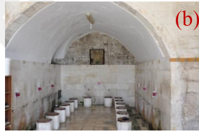
Şekil 4.270. 1 numaralı mekânda kullanılan düz döşeme(a), 2 numaralı mekânda kullanılan beşik tonoz(b)
