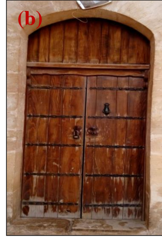
Şekil 4.337. Doğu cephesindeki giriş ahşap kapıda yüzey kaybı, Çatlak-kırık, , biçimsel deformasyon, aşınma, renk değişimi(a), Güney cephesindeki giriş ahşap kapıda yüzey kaybı, Çatlak-kırık, , biçimsel deformasyon, aşınma, renk değişimi(b)
