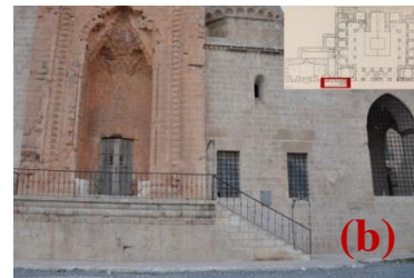
Şekil 4.461. Merdivende aşınma(a), girişteki(güney cephesi) merdivende yüzey kaybı(b)
