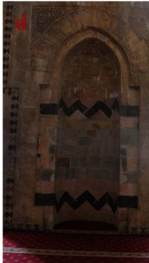
Şekil 4.420. İç mekânda duvarlarda bozulmalar: çiçeklenme (a) , çiçeklenme- renk değişimi(b), çiçeklenme-renk değişimi(c), renk değişimi-çimento kullanımı(d) ,renk değişimi(e) ,çiçeklenme-renk değişimi(f) (Altun 2006'deki plan üzerinden işlenerek)
