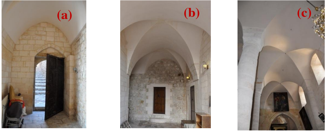
Şekil 4.507. (1 numaralı mekânda) sivri tonoz kullanımı(a), 2 numaralı mekânda haç tonoz kullanımı(b), 4 numaralı mekânda haç tonoz kullanımı(c)
