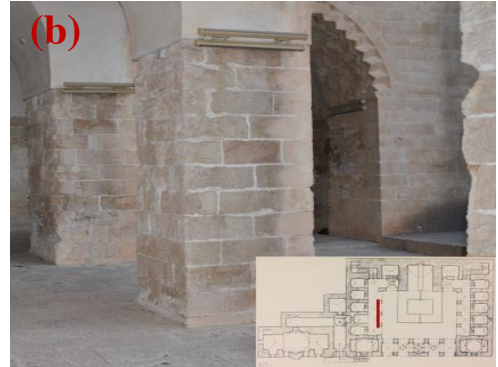
Şekil 4.447. Renk değişimi(a), renk değişimi ve hatalı onarım(b)
