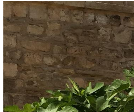
Şekil 4.196. Hatalı onarım(d), hatalı onarım(e)
