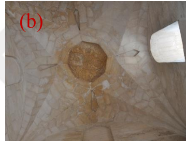
Şekil 4.81. 5 numaralı mekânda sivri tonozda hatalı onarım(a), 8 numaralı mekânda yıldız tonozda çiçeklenme, renk deęiřimi(b)
