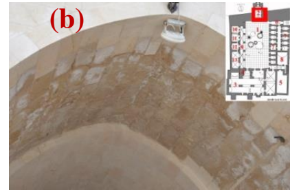
Şekil 4.378. 1 numaralı mekânda düz döşemede aşınma(a), 2 numaralı mekânda beşik tonozda çiçeklenme(b)
