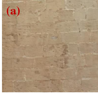
Şekil 4.408. 1 numaralı duvarda çimento kullanımı(a), 2 numaralı duvarda kavlanma(b)
