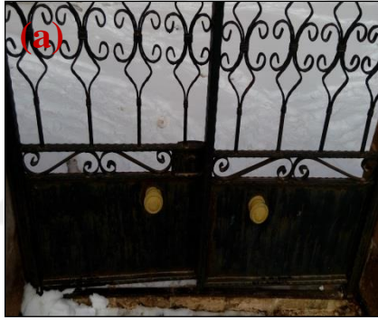
Şekil 4.338. Bahçe giriş kapısında paslanma(a), Metal kapıda paslanma(b)
