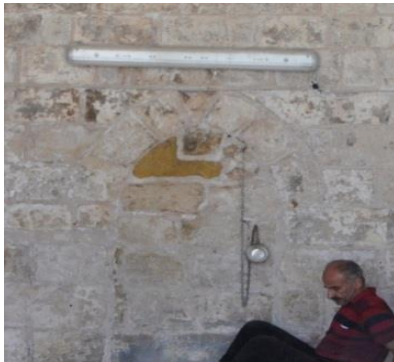
Şekil 4.196. Hatalı onarım(d), hatalı onarım(e)
