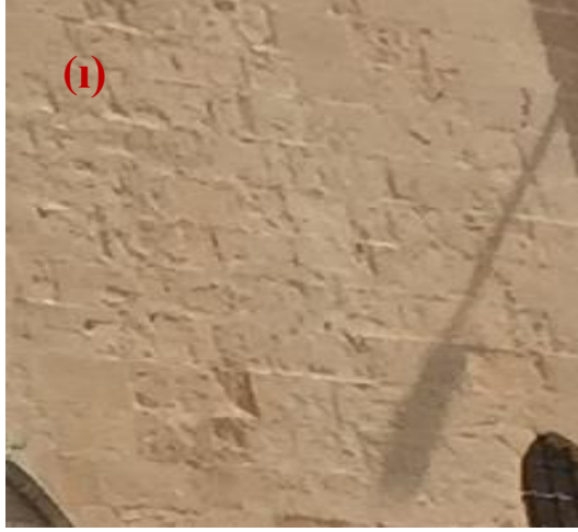
Şekil 4.414. Oyuklanma(i), yüzey kaybı-derz boşalması ve renk değişimi(j)
