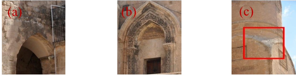
Şekil 4.45. Renk değişimi(a), kabuk ol.(b), renk değişimi(c)
