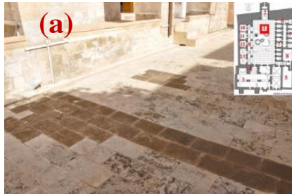
Şekil 4.378. 1 numaralı mekânda düz döşemede aşınma(a), 2 numaralı mekânda beşik tonozda çiçeklenme(b)
