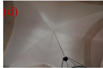
Şekil 4.295. 5 nolu mekânda kullanılan kubbe(c), 5 nolu mekânda çapraz tonoz kullanımı(d)
