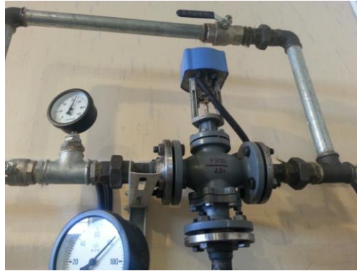
Şekil 4.25. Üç yollu motorlu vana
