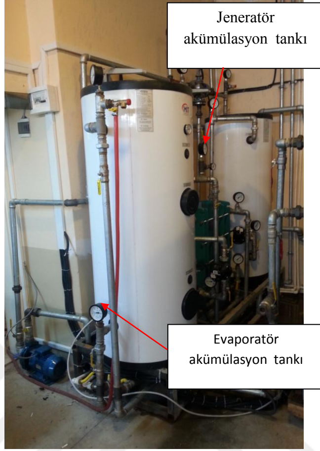
Şekil 4.22. Jeneratör ve evaporatör besleme hatları
