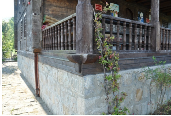
Şekil 4.694. Hüseyin Hoca Camii kuzey cephesi çantı tekniği (Aydın 2016)
