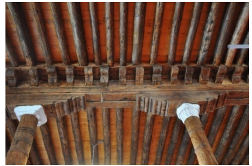
Şekil 4.89. Sivrihisar Ulu Camii ahşap tavan ve dikme başlık görünümü (Aydın 2015)
