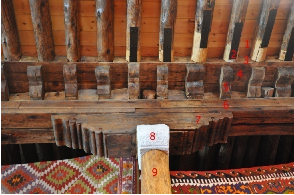
Şekil 4.94. Sivrihisar Ulu Camii dikme detayı(Aydın 2015)
