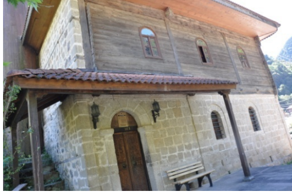
Şekil 4.616. Taşköprü Köyü Camii batı cephesi(Aydın 2016)
