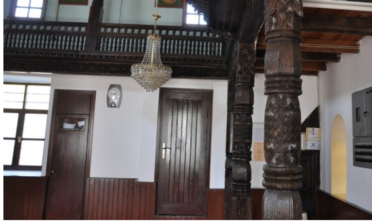
Şekil 4.541. Mithat Paşa Camii hanımlar mahfiline çıkış kapısı ve merdiven altındaki oda görünümü (Aydın 2016)
