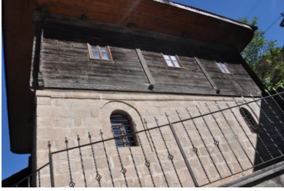
Şekil 4.609. Taşköprü Camii güney cephesi (Aydın 2016)
