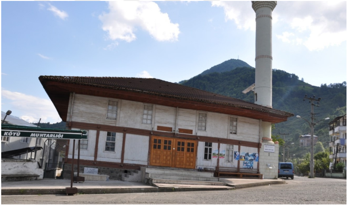
Şekil 4.799. Muratlı Köyü Camii genel görünümü(Aydın 2016)
