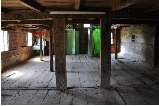
Şekil 4.486. Kargılı Camii mahfil taşıyıcıları(Aydın 2016)
