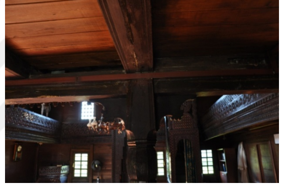
Şekil 4.710. Hüseyin Hoca Camii ahşap birleştirme örneği (Aydın 2016)
