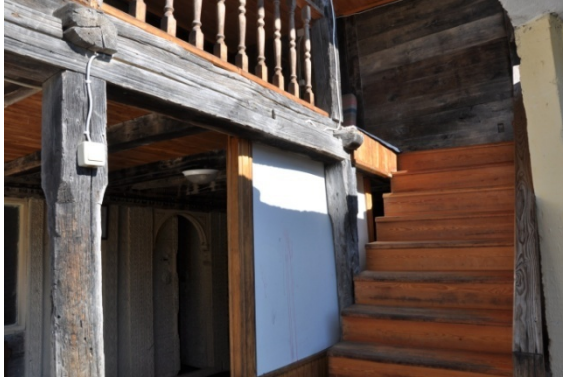
Şekil 4.577. Serindere Camii üst kata çıkış merdiveni (Aydın 2016)
