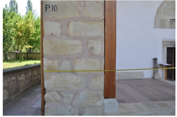
Şekil 4.313. Mahmut Bey Camii kuzey cephesi (Aydın 2014)
