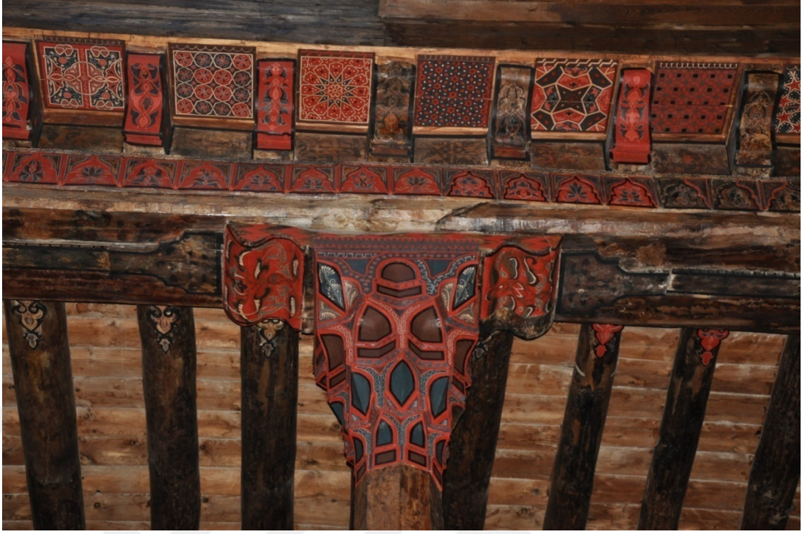
Şekil 4.2. Beyşehir Eşrefoğlu Camii ahşap dikme başlığı görünümü (Aydın 2015)
