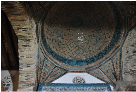
Şekil 4.213. Eşrefoğlu Süleyman Bey Camii mihrap önü kubbesi (Aydın 2015)
