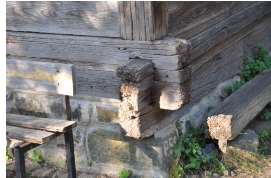
Şekil 4.721. Düzköy Camii çantı tekniği (Aydın 2016)
