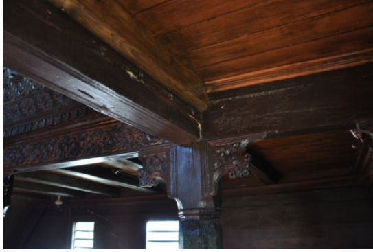
Şekil 4.709. Hüseyin Hoca Camii taşıyıcı dikmeler (Aydın 2016)
