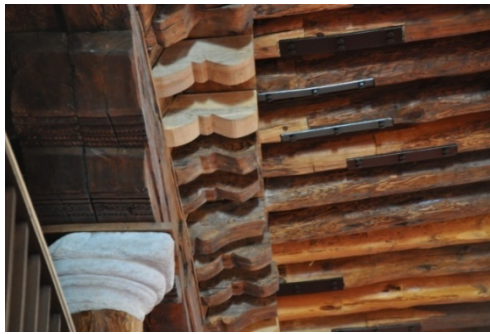
Şekil 4.88. Sivrihisar Ulu Camii ahşap dikme ve tavan görünümü (Aydın 2015)
