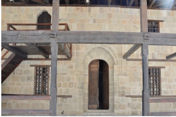
Şekil 4.747. Zeytinlik Köyü Camii Kuzey Cephesi (Aydın,2016)
