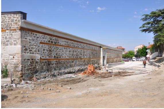
Şekil 4.55. Sivrihisar Ulu Camii kuzey cephesi genel görünümü(Aydın 2015)
