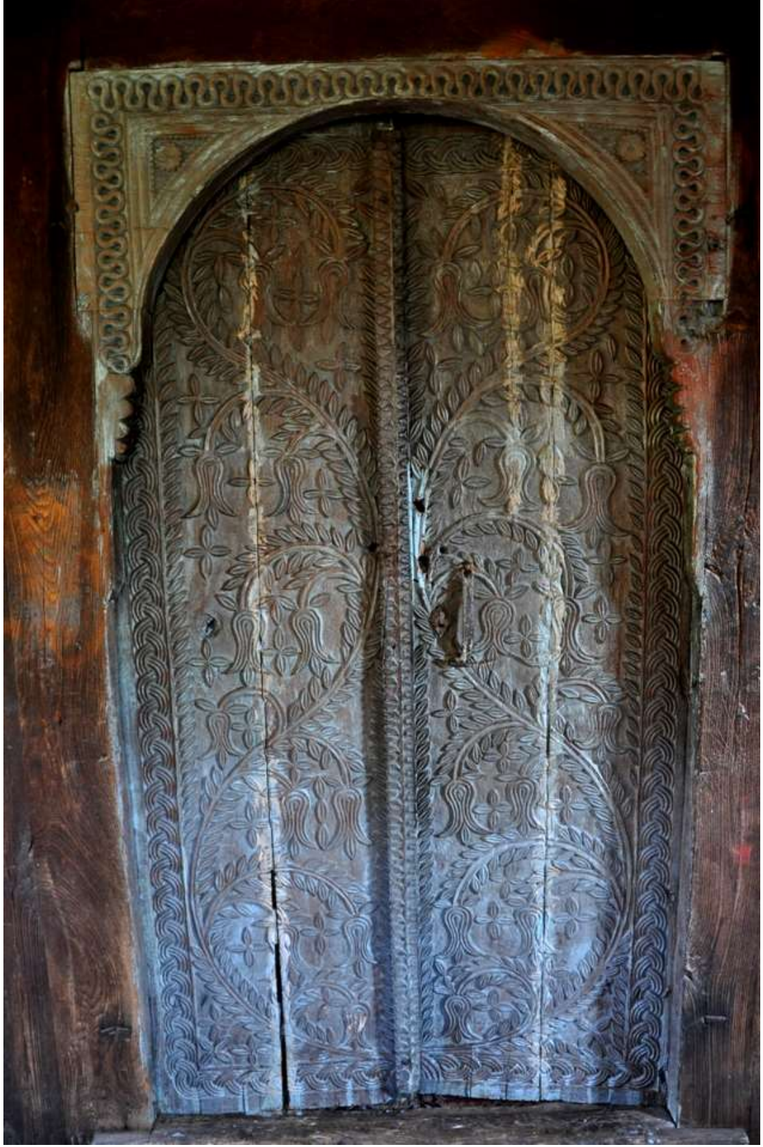
Şekil 4.5. Artvin Düzköy Köyü Camii harim kapısı (Aydın 2016)
