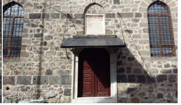
Şekil 4.120. Afyon Ulu Cami doğu cephesi giriş kapısı ve kitabe görünümü(Aydın 2015)
