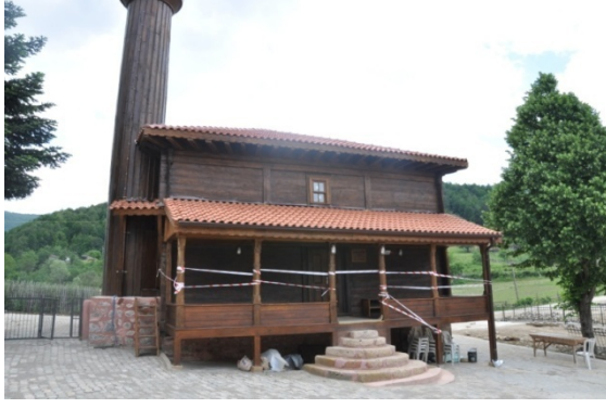
Şekil 4.12. İznik Elmalı Camii kuzey cephesi(Aydın 2015)
