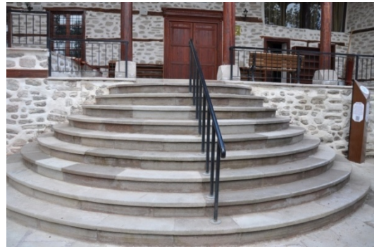
Şekil 4.234. Ak Cami doğu cephesi merdivenleri (Aydın 2015)
