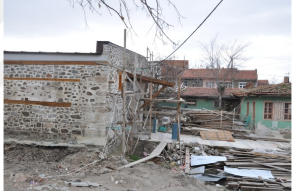
Şekil 4.39. Sivrihisar Ulu Camii batı cephesinde restorasyon sonrası yıkılan binaların görünümü (Aydın 2015)
