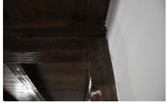
Şekil 4.780. Zeytinlik Köyü Camii dikme,mertek birleşim detayı (Aydın 2016)
