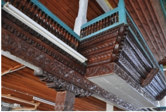
Şekil 4.809. Muratlı Köyü Camii mahfil çıkıntısı (Aydın 2016)
