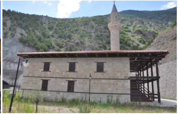
Şekil 4.740. Zeytinlik Köyü Camii doğu cephesi (Aydın 2016)
