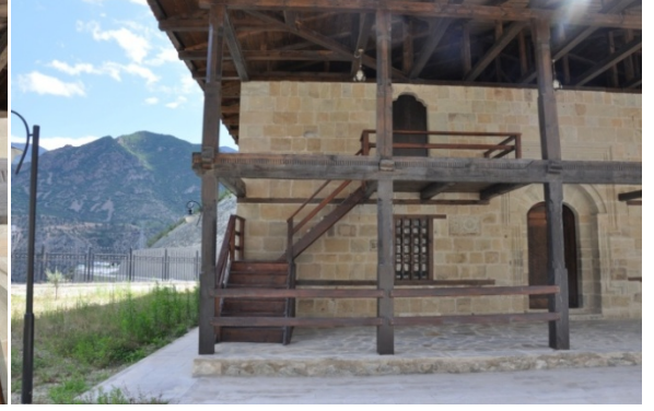
Şekil 4.751. Zeytinlik Köyü Camii kuzey cephesi (Aydın 2016)
