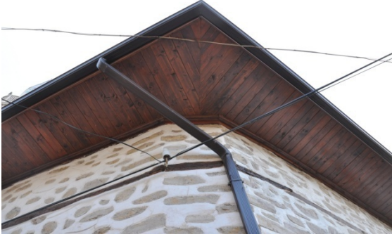
Şekil 4.245. Sille Ak Cami çatı saçağı (Aydın 2015)
