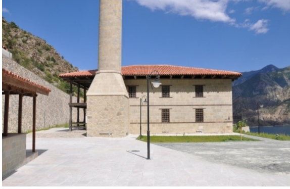
Şekil 4.743. Zeytinlik Köyü Camii batı cephesi (Aydın 2016)
