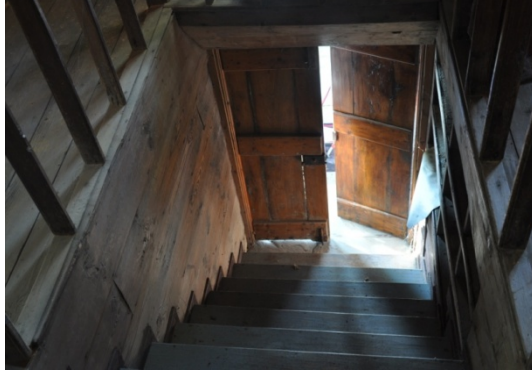
Şekil 4.365. Beldeğirmen Köyü Camii harime çıkış (Aydın 2014)
