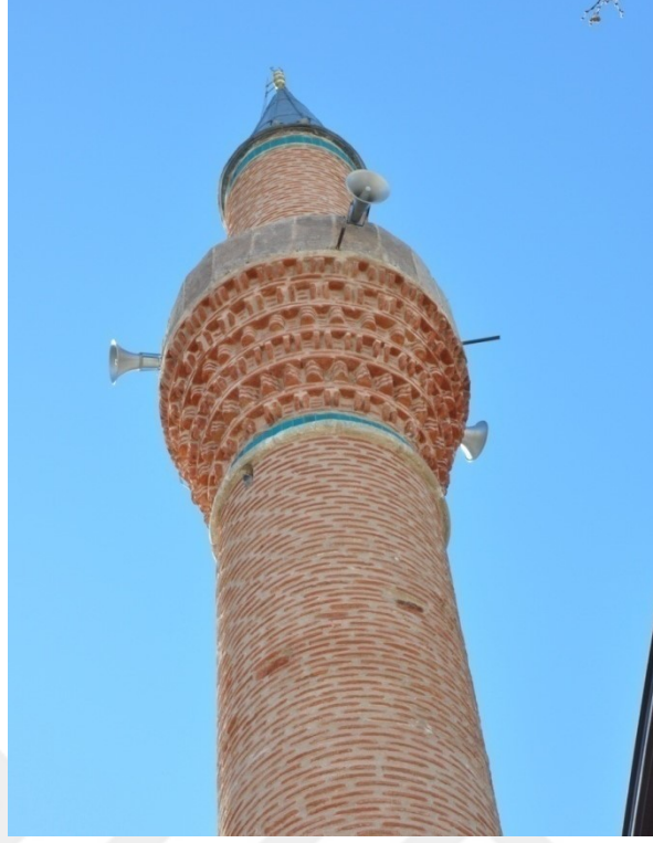
Şekil 4.299. Sille Çay Camii minaresi (Aydın 2015)
