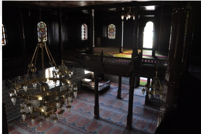
Şekil 4.674. Akköse Camii Harim müezzin mahfili ve taşıyıcı dikme görünümü(Aydın 2016)
