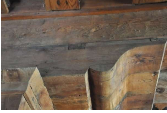
Şekil 4.163. Afyon Ulu Camii mukarnas başlık birleşim detayı (Aydın 2015)
