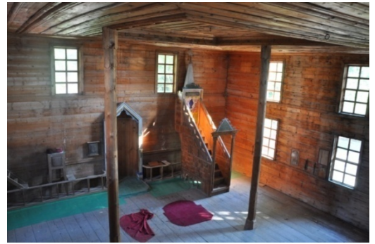
Şekil 4.402. Beldeğirmeni Köyü Camii ahşap tavan görünümü (Aydın 2014)
