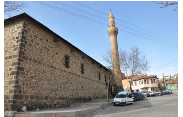
Şekil 4.128. Afyon Ulu Cami kuzey cephesi (Aydın 2015)
