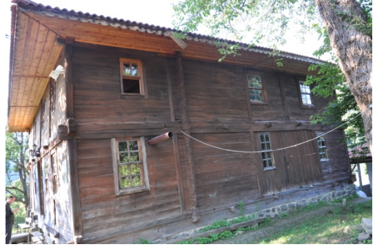
Şekil 4.717. Düzköy Camii güney cephesi (Aydın 2016)
