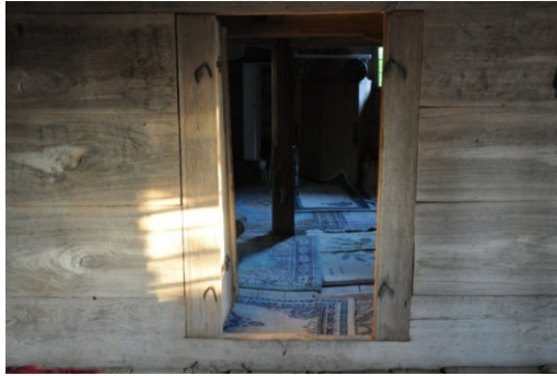
Şekil 4.441. Ustacalı Köyü Camii harim giriş kapısı (Aydın 2016)
