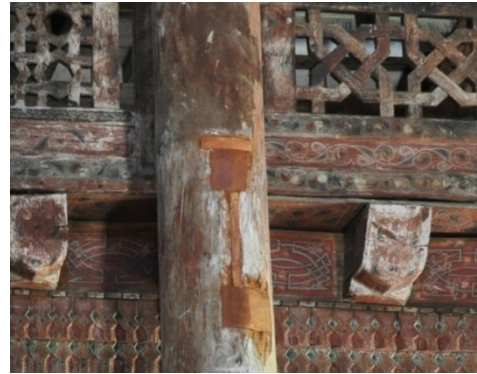
Şekil 4.341. Mahmut Bey Camii ahşap dikme onarım örneği (Aydın 2014)
