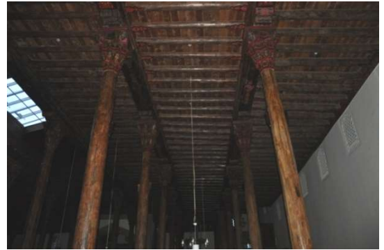
Şekil 4.201. Eşrefoğlu Süleyman Bey Camii ahşap dikme görünümü (Aydın 2015)
