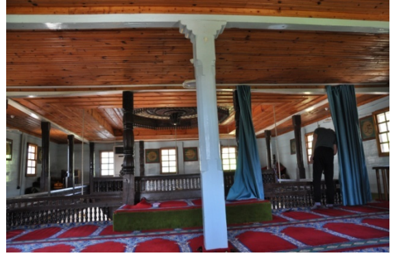
Şekil 4.546. Mithat Paşa Camii hanımlar mahfili dikme görünümü (Aydın 2016)
