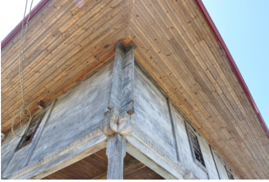
Şekil 4.517. Mithat Paşa Camii kuzeydoğu köşesi çantı tekniği (Aydın 2016)
