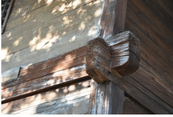
Şekil 4.722. Düzköy Camii çantı tekniği (Aydın 2016)
