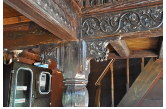
Şekil 4.708. Hüseyin Hoca Camii taşıyıcı dikme ve mahfil merdiveni (Aydın 2016)
