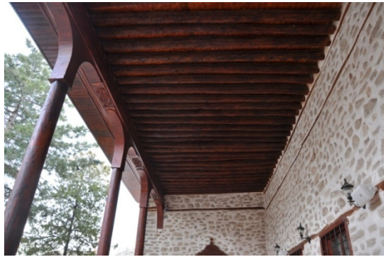
Şekil 4.239. Sille Ak Cami son cemaat bölümü çatı altı mertek ve dikmeleri (Aydın 2015)
