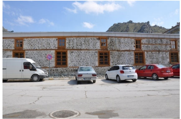
Şekil 4.43. Sivrihisar Ulu Camii güney cephesi genel görünümü(Aydın 2015)
