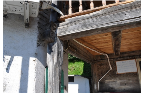
Şekil 4.588. Serindere Camii çatı tekniği (Aydın 2016)
