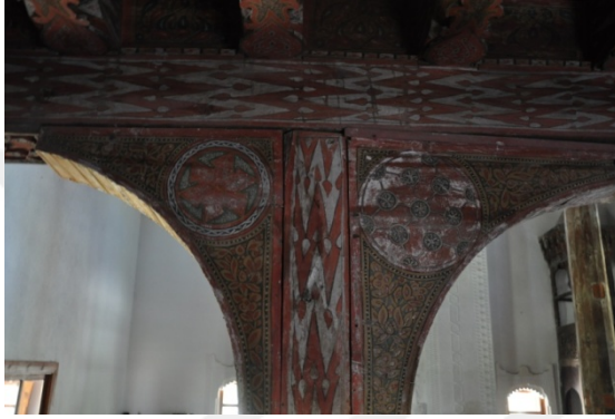
Şekil 4.338. Mahmut Bey Camii mahfil altı ahşap dikme süsleme detayı (Aydın 2014)
