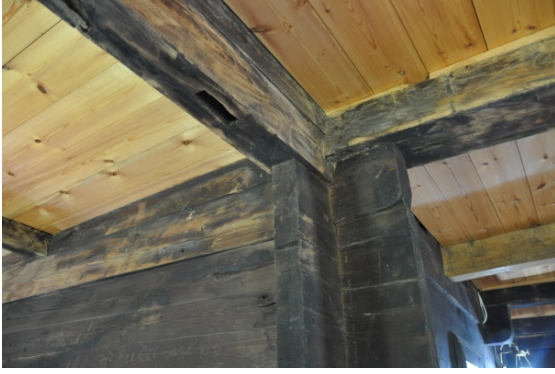
Şekil 4.728. Düzköy Camii birleşim tekniği(Aydın 2016)
