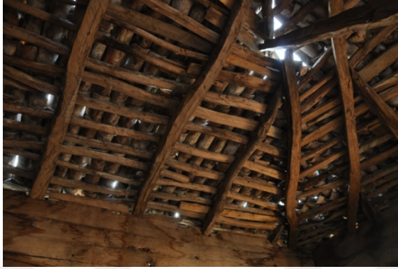
Şekil 4.421. Kuşhane Köyü Camii tavanı (Aydın 2016)
