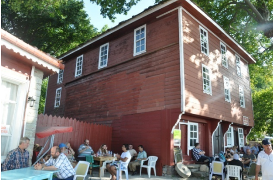
Şekil 4.361. Beldeğirmen Köyü Camii doğu cephesi (Aydın 2014)
