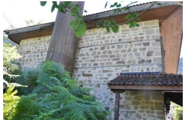
Şekil 4.612. Taşköprü Camii kuzey cephesi (Aydın 2016)
