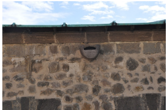
řekil 4.112. Afyon Ulu Cami batı cephesi oluk grnm(Aydın 2015)
