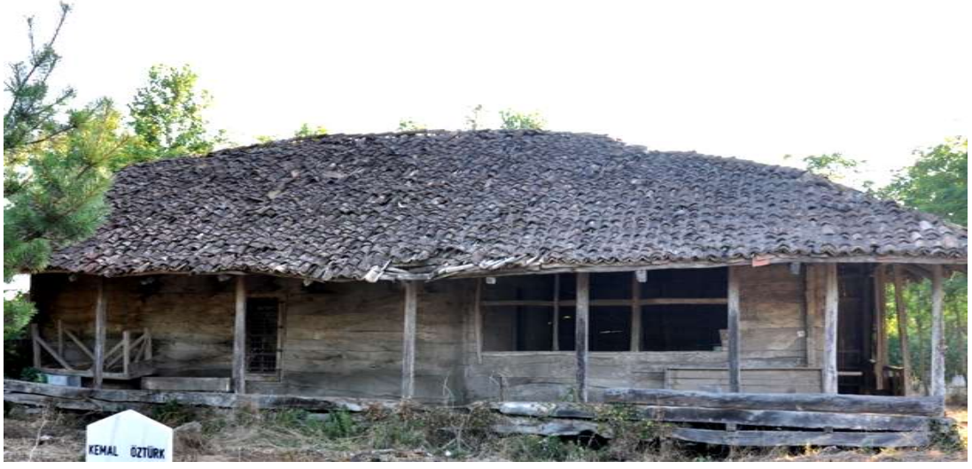
Şekil 4.9. Samsun Kuşhane Köyü Camii genel görünümü(Aydın 2016)
