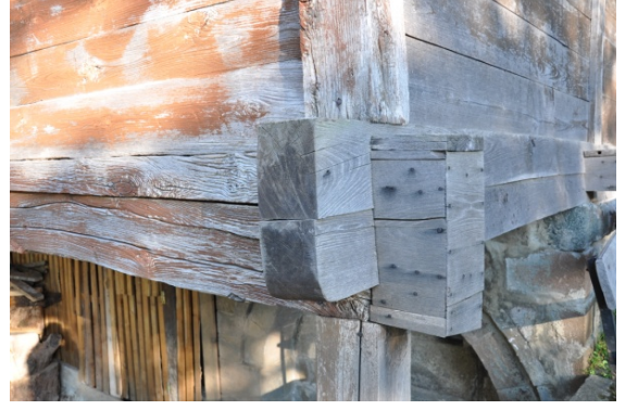
Şekil 4.723. Düzköy Camii çantı tekniği (Aydın 2016)
