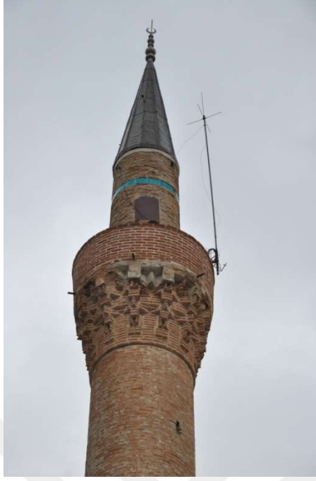
Şekil 4.101. Sivrihisar Ulu Camii minare görünümü(Aydın 2015)
