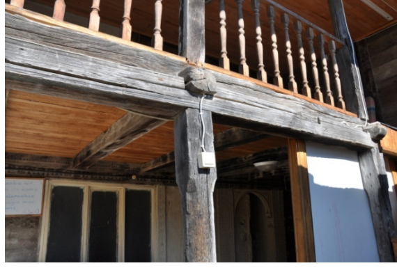
Şekil 4.589. Serindere Camii dikme ve aşık birleşimi (Aydın 2016)
