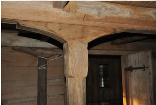
Şekil 4.449. Ustacalı Köyü Camii dikme görünümü (Aydın 2016)
