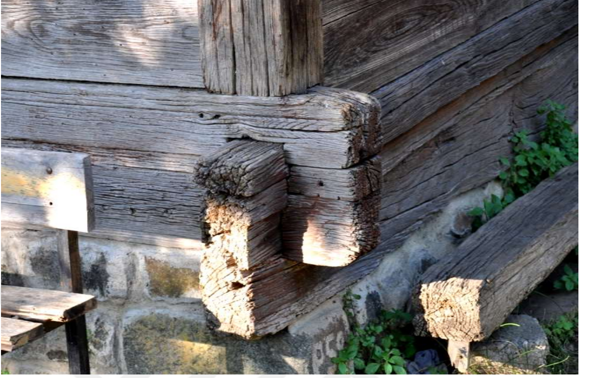
Şekil 4.8. Artvin Düzköy Köyü Camii temel çantı detayı(Aydın 2016)
