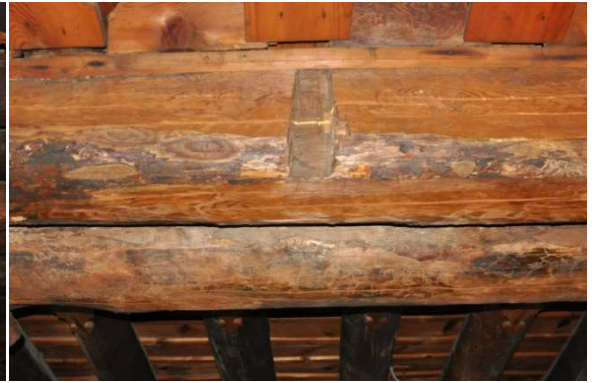
Şekil 4.181. Afyon Ulu Camii deforme örneği (Aydın 2016)
