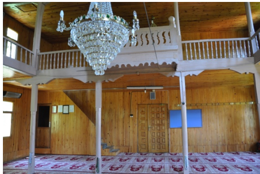
Şekil 4.465. Çayır Camii harim ve mahfil merdiven görünümü(Aydın 2016)
