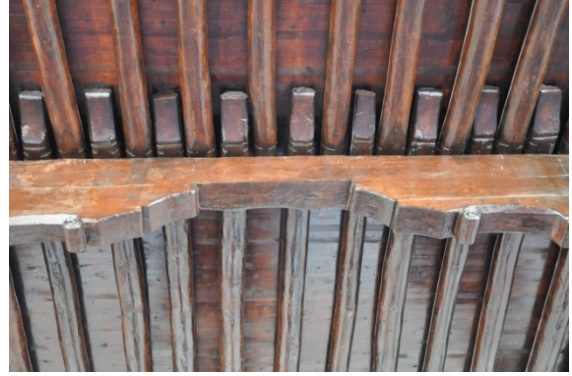
Şekil 4.268. Sille Çay Camii son cemaat bölümü ahşap taşıyıcı sistemi (Aydın 2015)
