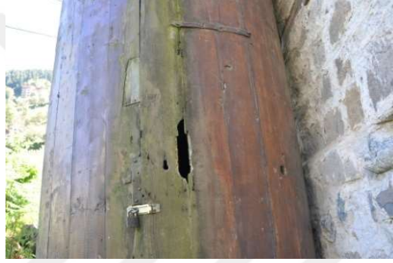
Şekil4.615. Taşköprü Camii minaresinde deformasyon örneği (Aydın 2016)
