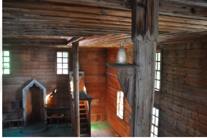
Şekil 4.400. Beldeğirmeni Köyü Camii pencere ve fenerlik görünümü (Aydın 2014)
