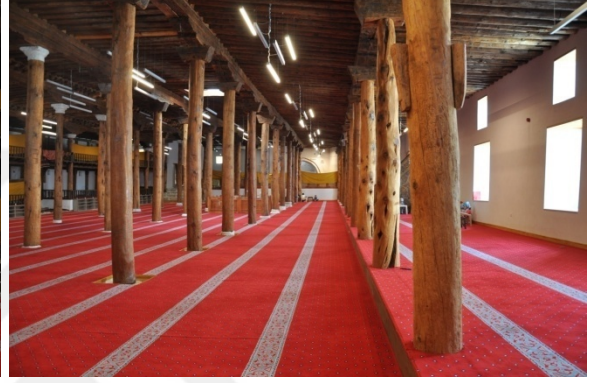
Şekil 4.75. Sivrihisar Ulu Camii ahşap dikmeleri (Aydın 2015)
