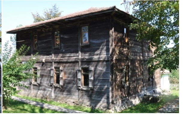
Şekil 4.458. Çayır Camii batı cephesi(Aydın 2016)
