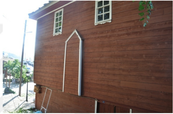
Şekil 4.360. Beldeğirmen Köyü Camii güney cephesi (Aydın 2014)
