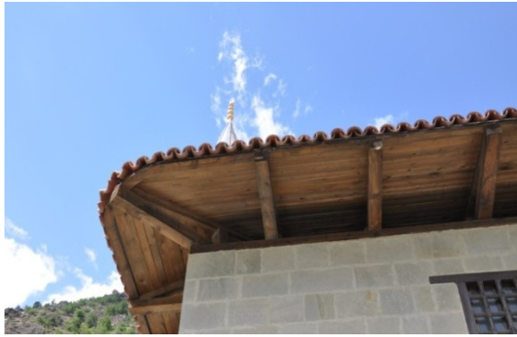
Şekil 4.739. Zeytinlik Köyü Camii çatı detayı (Aydın 2016)
