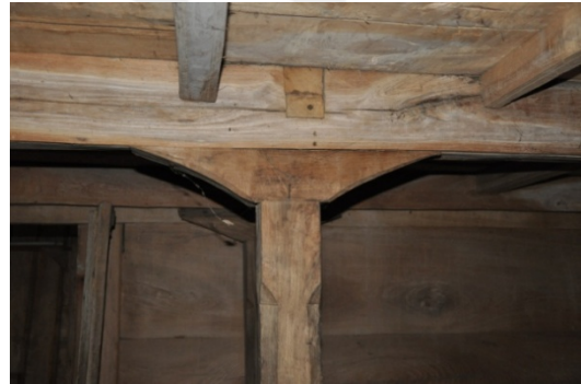
Şekil 4.450. Ustacalı Köyü Camii dikme görünümü (Aydın 2016)
