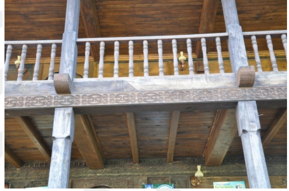
Şekil 4.687. Hüseyin Hoca Camii son cemaat yeri ahşap birleştirme tekniği (Aydın 2016)
