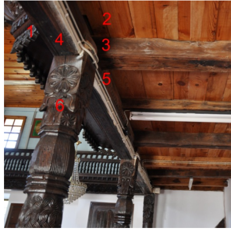
Şekil 4.531. Mithat Paşa Camii taşıyıcı dikme detayı (Aydın 2016)
