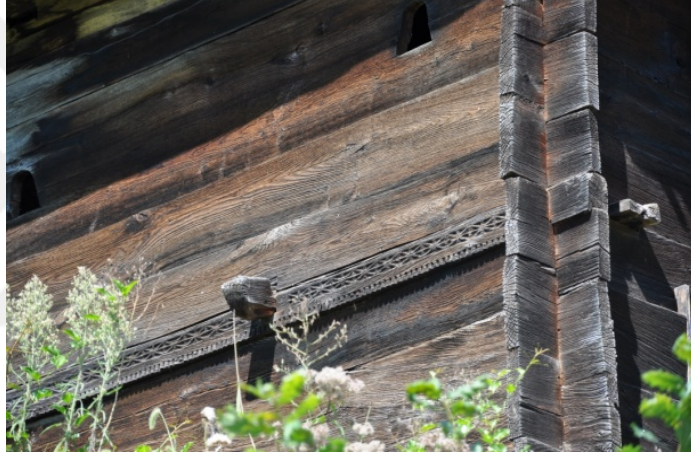
Şekil 4.477. Kargılı Camii çantı örneği (Aydın 2016)
