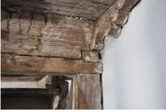
Şekil 4.332. Mahfil Döşeme ve dikme birleşim detayı (Aydın 2014)
