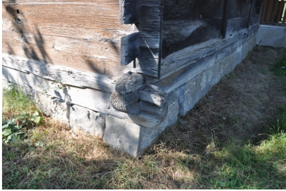
Şekil 4.501. Yeni Cuma Camii temel görünümü ve Çantı tekniği (Aydın 2016)
