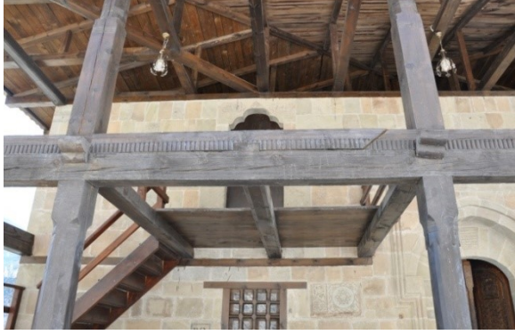
Şekil 4.750. Zeytinlik Köyü Camii kuzey cephesi (Aydın 2016)
