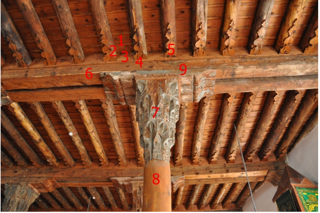
Şekil 4.160. Dikme başı ve taşıyıcı sistem detayı (Aydın 2015)
