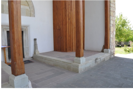
Şekil 4.312. Mahmut Bey Camii kuzey cephesi son cemaat yeri minare girişi (Aydın 2014)
