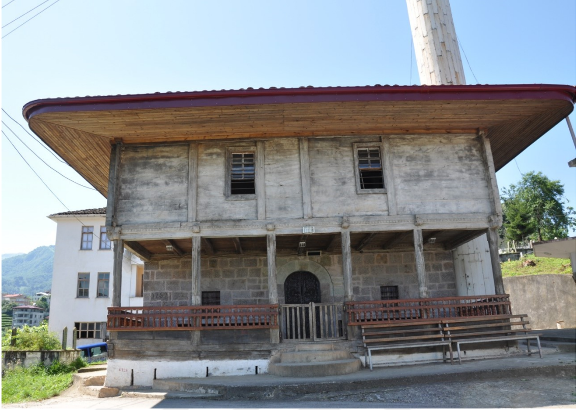
Şekil 4.516. Mithat Paşa Camii kuzey cephesi (Aydın 2016)
