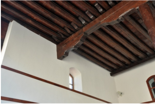
Şekil 4.273. Sille Çay Camii son cemaat bölümü ahşap taşıyıcı sistemi (Aydın 2015)
