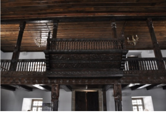
Şekil 4.791. Zeytinlik Köyü Camii üst mahfil görünümü (Aydın 2016)
