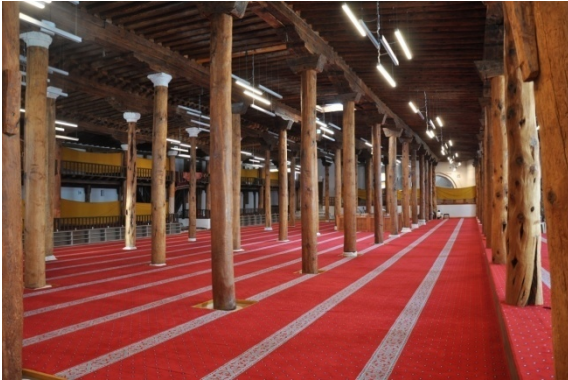
Şekil 4.76. Sivrihisar Ulu Camii ahşap dikmeleri (Aydın 2015)
