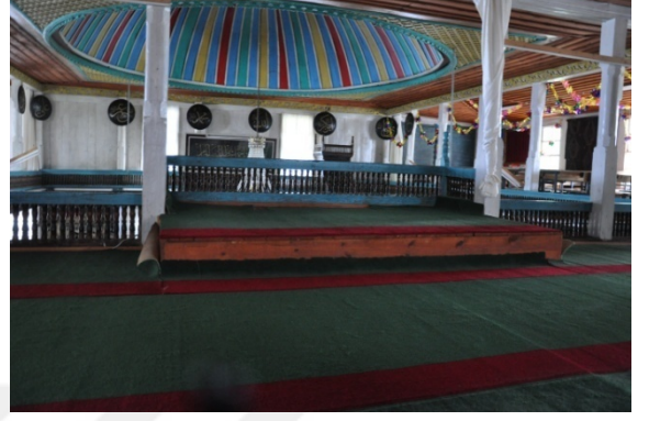
Őekil 4.814. Muratlı Ky Camii kubbe ve mahfil ıkıntısı (Aydın 2016)
