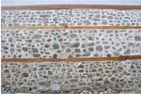
Şekil 4.57. Sivrihisar Ulu Camii kuzey cephe duvarı (Aydın 2015)
