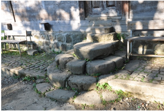
Şekil 4.724. Düzköy Camii batı cephesi giriş merdiveni (Aydın 2016)
