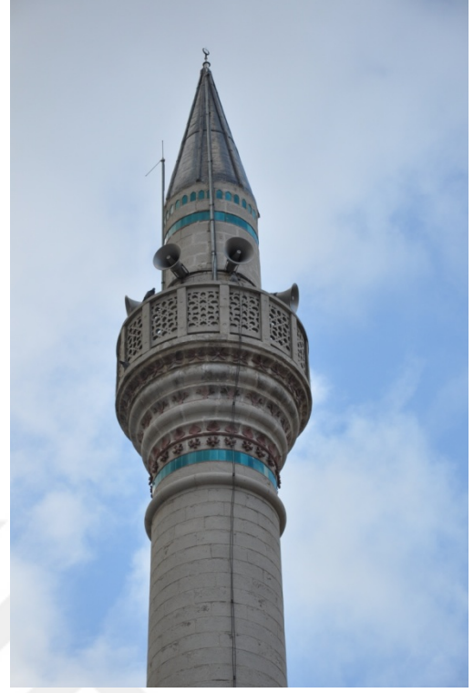
Şekil 4.248.Sille Ak Cami minaresi (Aydın 2015)
