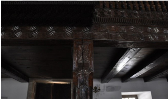
Şekil 4.773. Zeytinlik Köyü Camii dikme birleşim detayı (Aydın 2016)
