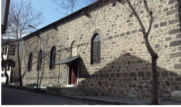
Şekil 4.119. Afyon Ulu Cami doğu cephesi(Aydın 2015)
