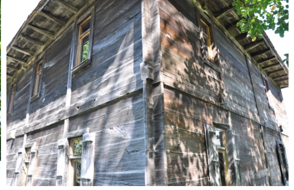
Şekil 4.460. Çayır Camii çantı tekniği(Aydın 2016)
