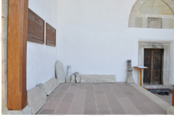
Şekil 4.310. Mahmut Bey Camii kuzey cephesi son cemaat yeri (Aydın 2014)
