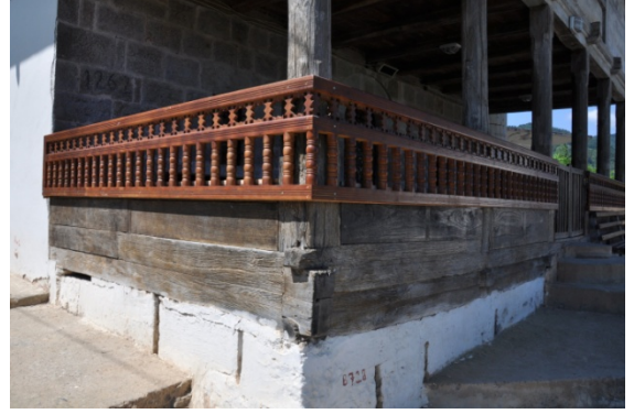
Şekil 4.518. Mithat Paşa Camii kuzeydoğu köşesi çantı tekniği (Aydın 2016)
