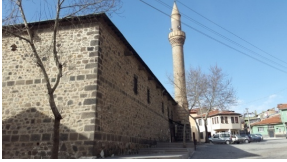
Şekil 4.123. Afyon Ulu Cami kuzey cephesi (Aydın 2015)
