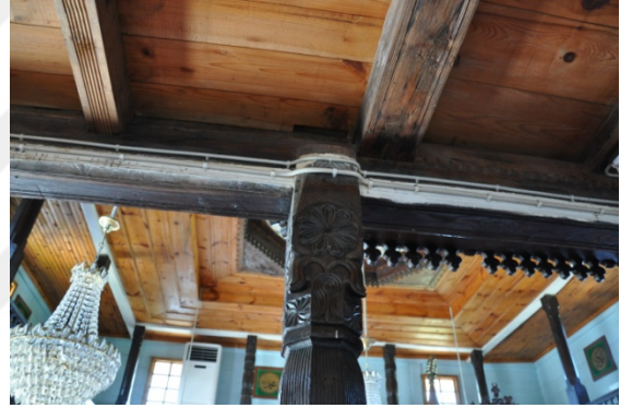
Şekil 4.534. Mithat Paşa Camii mahfil taşıyıcı dikmeleri (Aydın 2016)
