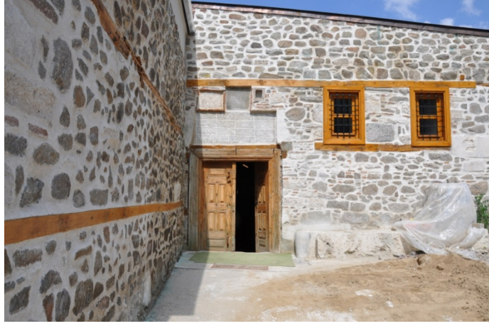
Şekil 4.52. Sivrihisar Ulu Camii doğu cephesi ahşap kapı görünümü (Aydın 2015)
