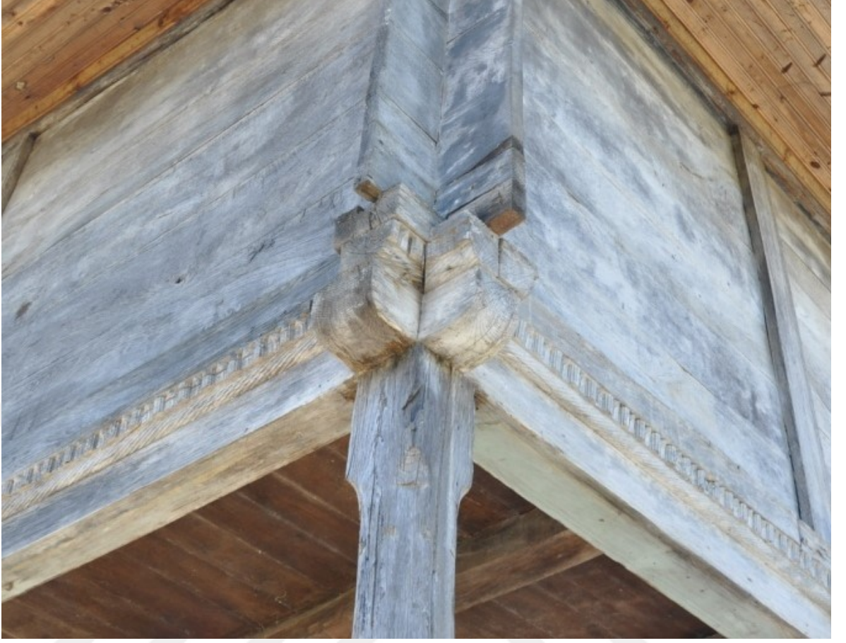
Şekil4.519. Mithat Paşa Camii kuzeydoğu köşesi çanta tekniği (Aydın 2016)
