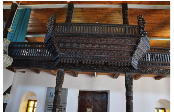
Şekil 4.536. Mithat Paşa Camii mahfil korkuluğu (Aydın 2016)
