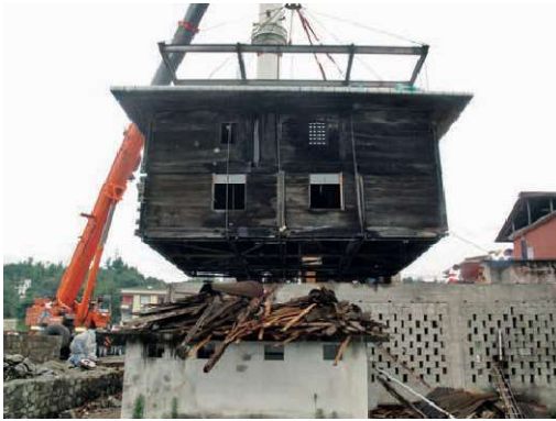
Şekil 4.684. Vinç yardımı ile taşınma işlemi (Rize Valiliği,Haziran 2010)
