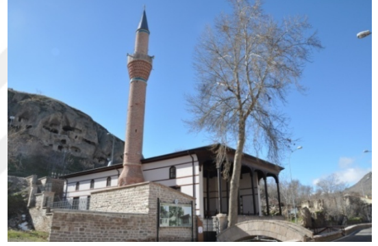
Şekil 4.254. Sille Çay Cami çevresi (Aydın 2015)
