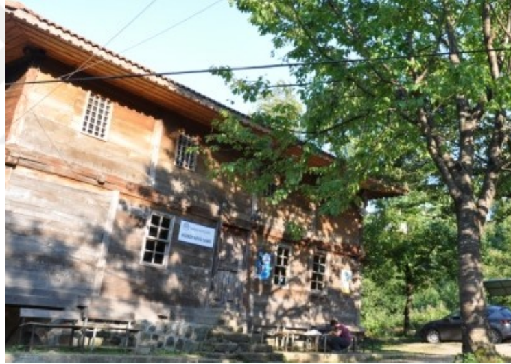
Şekil 4.715. Düzköy Camii genel görünümü (Aydın 2016)
