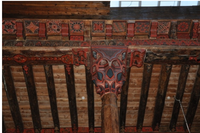
Şekil 4.203. Eşrefoğlu Süleyman Bey Camiidikme başlığı görünümü (Aydın 2015)
