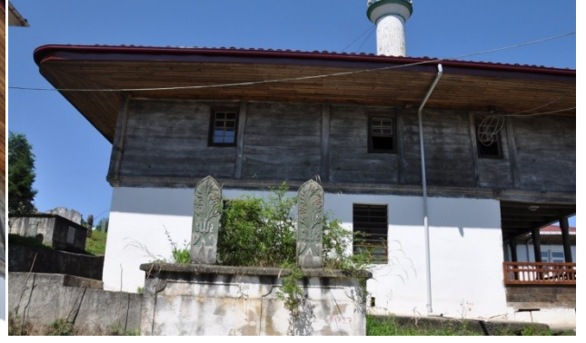
Şekil 4.521. Mithat Paşa Camii doğu cephesi (Aydın 2016)
