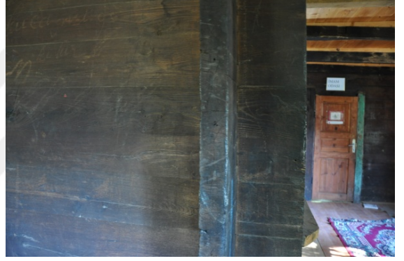
Şekil 4.729. Düzköy Camii birleşim tekniği(Aydın 2016)
