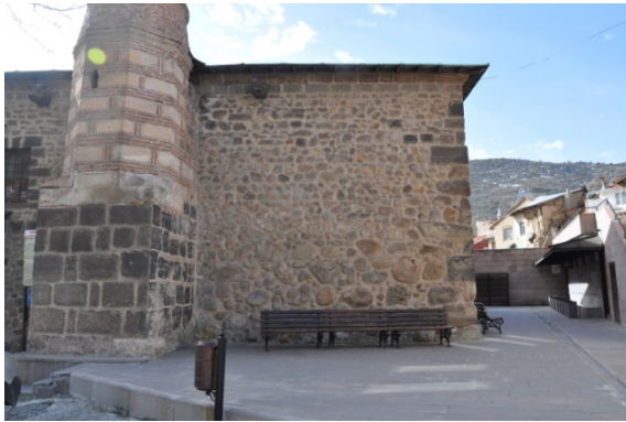
Şekil 4.127. Afyon Ulu Cami kuzey cephesi (Aydın 2015)
