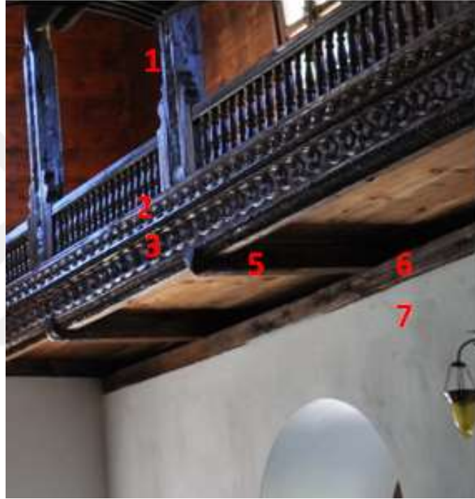
Şekil 4.621. Taşköprü Camii mahfil taşıyıcıları detay görünümü(Aydın 2016)
