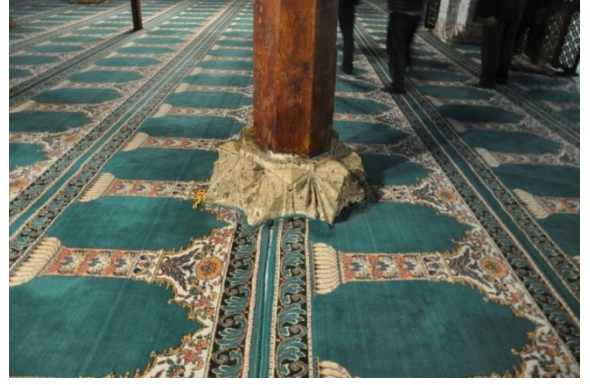
Şekil 4.205. Eşrefoğlu Süleyman Bey Camii dikme ayağı (Aydın 2015)
