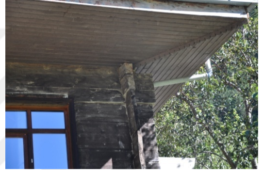
Şekil 4.654. Filak Camii güney cephesi çantı örneği (Aydın 2016)
