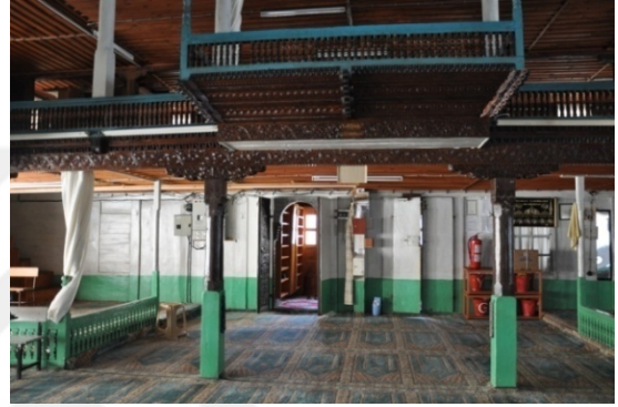
Şekil 4.810. Muratlı Köyü Camii mahfil çıkıntısı ve taşıyıcı dikme görünümü (Aydın 2016)
