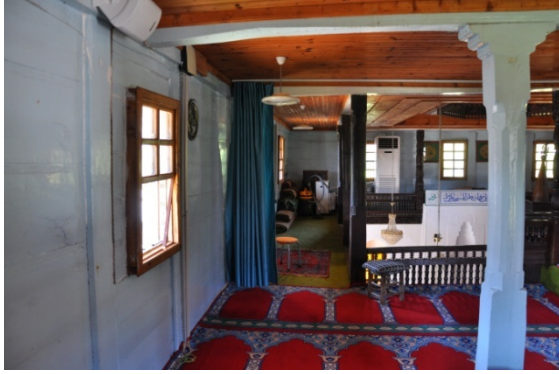
Şekil 4.555. Mithat Paşa Camii hanımlar mahfili taşıyıcı dikmeler (Aydın 2016)
