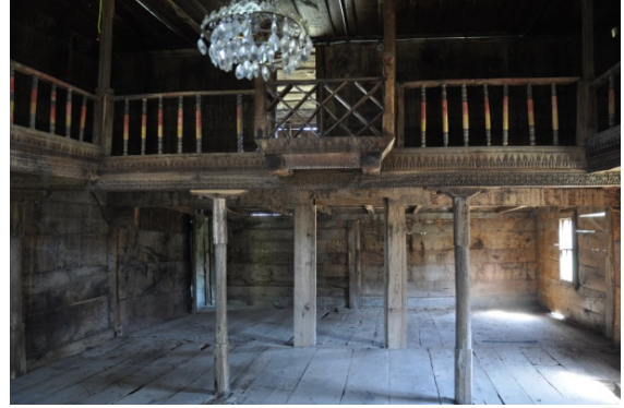
Şekil 4.487. Kargılı Camii taşıyıcı dikme görünümü(Aydın 2016)
