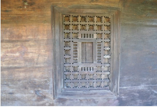
Şekil 4.690. Hüseyin Hoca Camii batı cephesi pencere görünümü (Aydın 2016)
