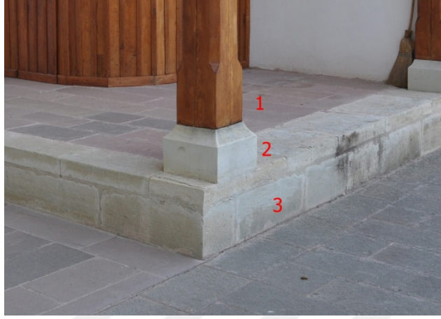
Şekil 4.314. Mahmut Bey Camii sonn cemaat yeri ahşap dikme ayağı detayı (Aydın 2014)
