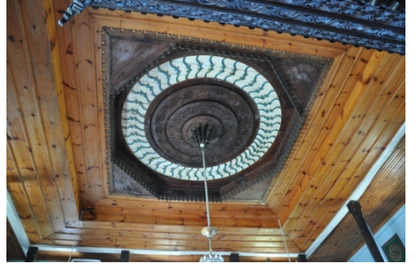
Şekil 4.560. Mithat Paşa Camii ahşap tavan göbeği (Aydın 2016)
