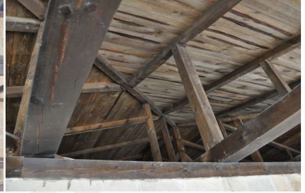
Şekil 4.748. Zeytinlik Köyü Camii çatı taşıyıcı sistemi (Aydın 2016)
