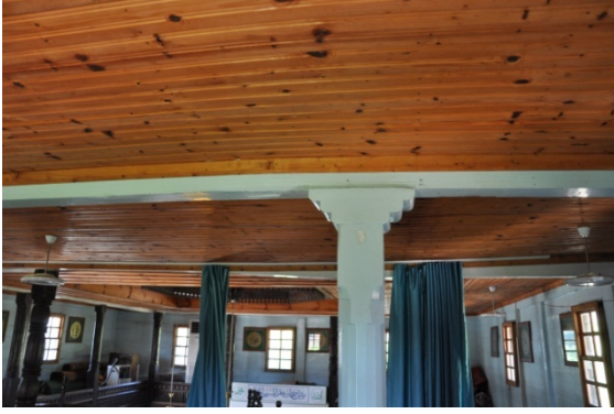
Şekil 4.547. Mithat Paşa Camii dikme görünümü (Aydın 2016)
