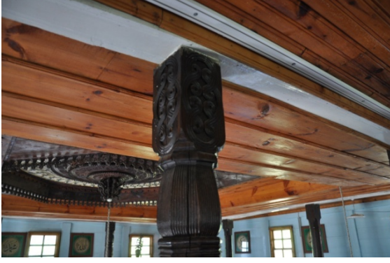
Şekil 4.545. Mithat Paşa Camii hanımlar mahfili dikme görünümü (Aydın 2016)
