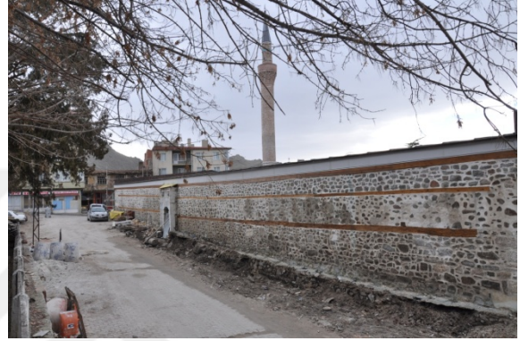
Şekil 4.56. Sivrihisar Ulu Camii kuzey cephesi genel görünümü(Aydın 2015)
