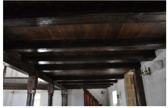
Şekil 4.771. Zeytinlik Köyü Camii üst mahfil taşıyıcı sistemi (Aydın 2016)
