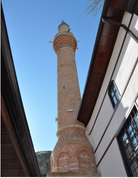
Şekil 4.257. Sille Çay Camii minaresi (Aydın 2015)
