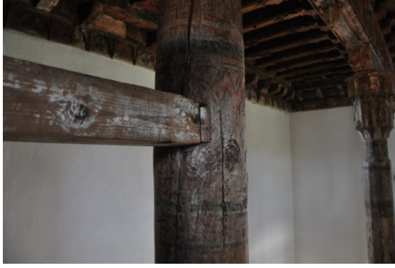
Şekil 4.349. Mahmut Bey Camii mahfil birleşim detayı (Aydın 2014)
