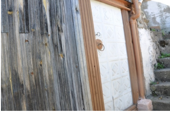
Şekil 4.597. Çamlıbel Köyü Camii bodrum giriş kapısı (Aydın 2016)
