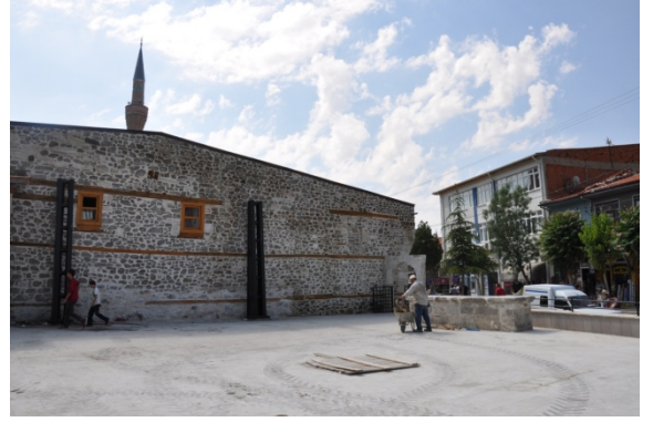
Şekil 4.37. Sivrihisar Ulu Camii batı cephesi genel görünümü (Aydın 2015)
