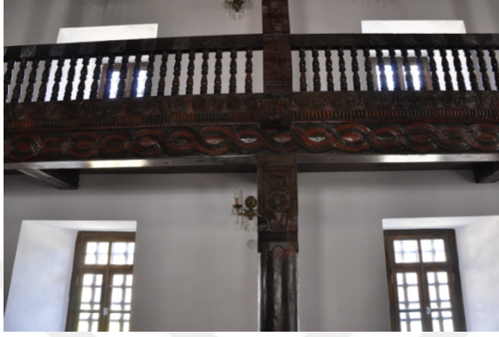
Şekil 4.785. Zeytinlik Köyü Camii üst mahfil korkuluk görünümü (Aydın 2016)
