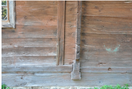
Şekil 4.720. Düzköy Camii cephe birleştirme tekniği (Aydın 2016)
