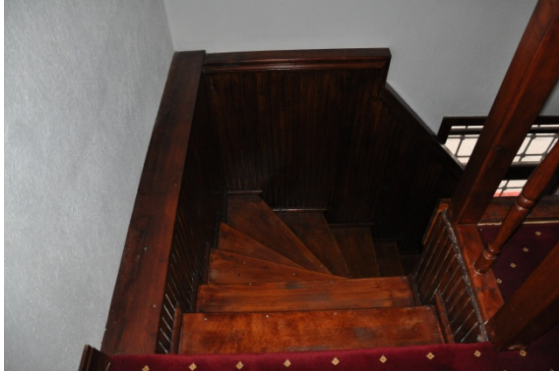
Şekil 4.284. Sille Çay Camii mahfile çıkış merdiveni (Aydın 2015)
