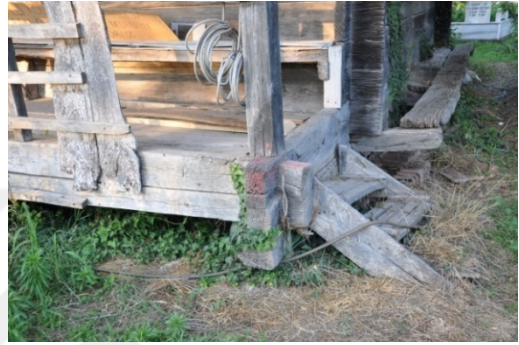
Şekil 4.440. Ustacalı Köyü Camii giriş merdiveni (Aydın 2016)
