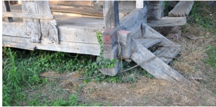
Şekil4.431. Ustacalı Köyü Camii döşeme aşık görünümü (Aydın 2016)
