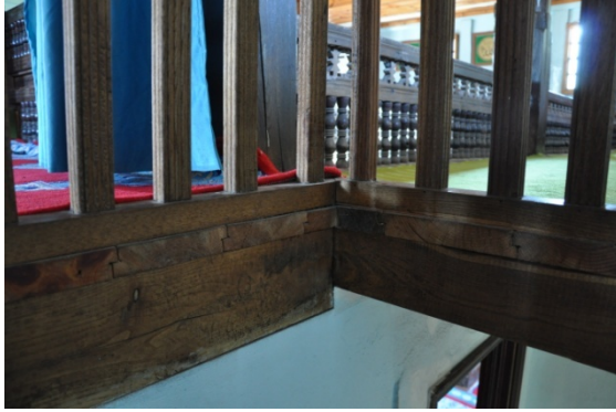
Şekil 4.551. Mithat Paşa Camii mahfil katı ahşap birleştirme tekniği (Aydın 2016)
