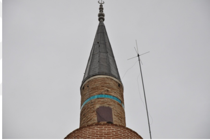
Şekil 4.100. Sivrihisar Ulu Camii minare görünümü(Aydın 2015)
