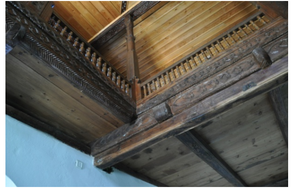
Şekil 4.620. Taşköprü Camii mahfil taşıyıcıları (Aydın 2016)
