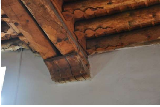
Şekil. 4.165. Afyon Ulu Camii tavanı ahşap birleşim detayı (Aydın 2015)
