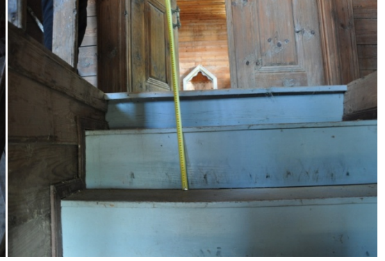
Şekil 4.366. Beldeğirmen Köyü Camii harime çıkış merdiveni (Aydın 2014)
