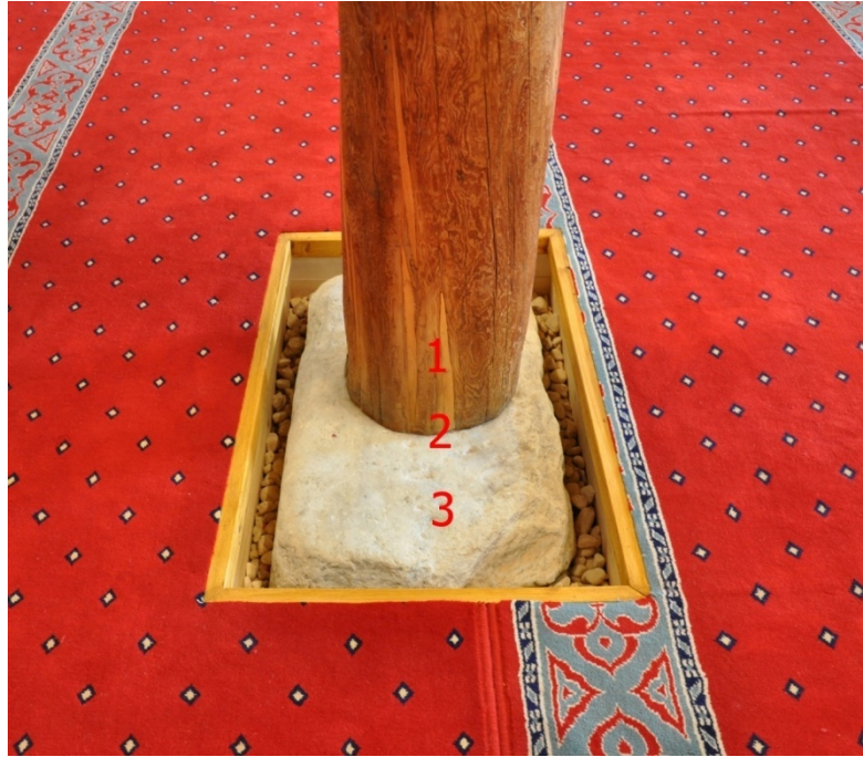
Şekil 4.97. Sivrihisar Ulu Camii dikme detay görünümü(Aydın 2015)
