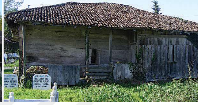
Şekil 4.433. Ustacalı Köyü Camii doğu cephesi (Aydın 2016)
