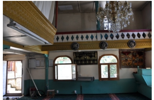
Şekil 4.604. Çamlıbel Köyü Camii harim görünümü(Aydın 2016)
