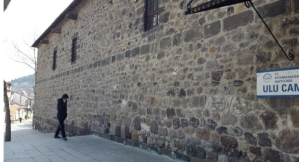
Şekil 4.125. Afyon Ulu Cami kuzey cephesi (Aydın 2015)
