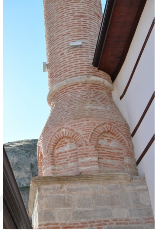
Şekil 4.258. Sille Çay Camii minaresi (Aydın 2015)
