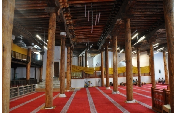
Şekil 4.77. Sivrihisar Ulu Camii ahşap dikmeleri (Aydın 2015)
