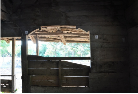
Şekil 4.426. Kuşhane Köyü Camii son cemaat yeri pencere açıklığı (Aydın 2016)
