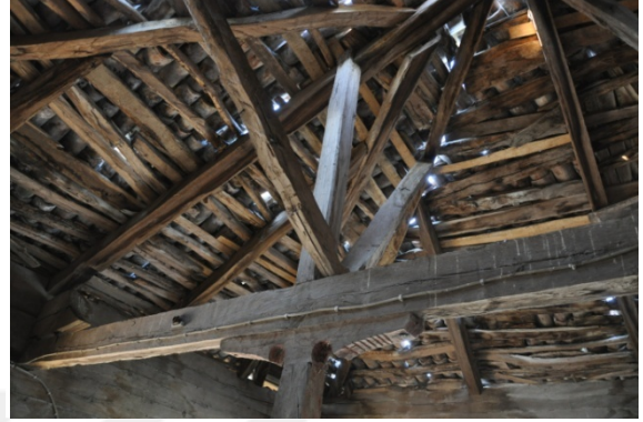
Şekil 4.422. Kuşhane Köyü Camii tavanı (Aydın 2016)
