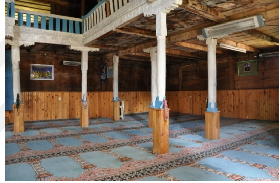
Şekil 4.511. Yeni Cuma Camii ahşap dikme görünümü(Aydın 2016)
