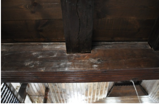
Şekil 4.779. Zeytinlik Köyü Camii mertek,aşık birleşim detayı (Aydın 2016)
