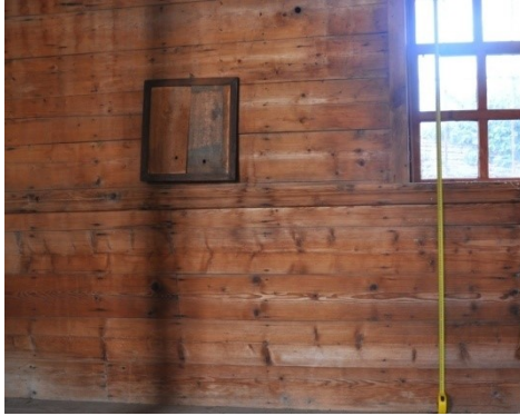
Şekil 4.379. Beldeğirmen Köyü Camii ahşap duvar görünümü (Aydın 2014)
