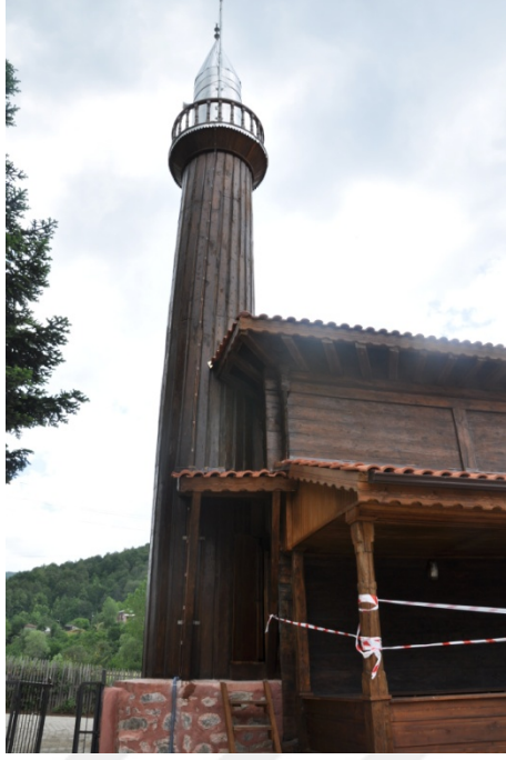
Şekil 4.32. İznik Elmali Camii minare görünümü(Aydın 2015)
