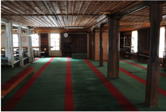
Şekil 4.811. Muratlı Köyü Camii Mahfil Katı (Aydın 2016)
