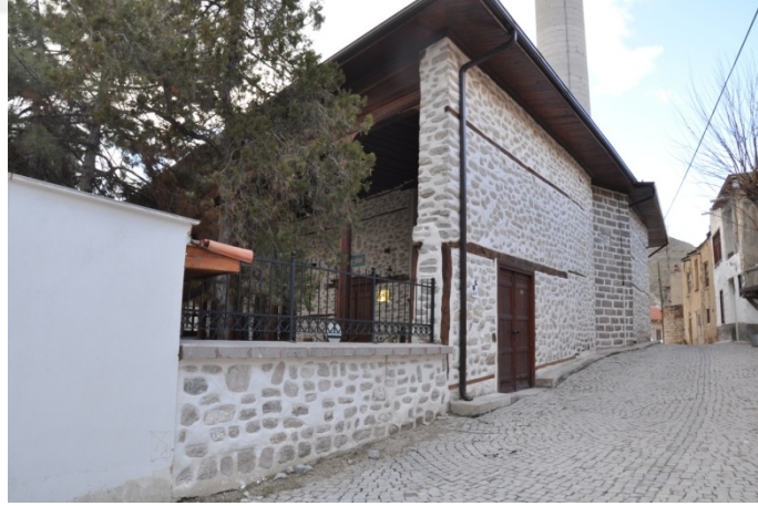
Şekil 4.249.Sille Ak Cami kuzey cephesi (Aydın 2015)
