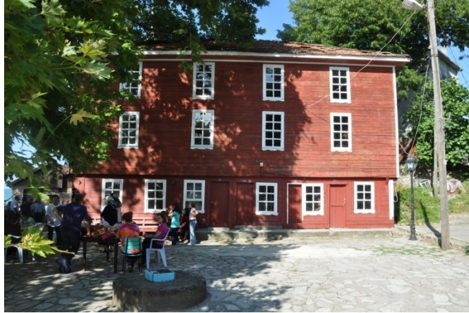
Şekil 4.363. Beldeğirmen Köyü Camii batı cephesi (Aydın 2014)
