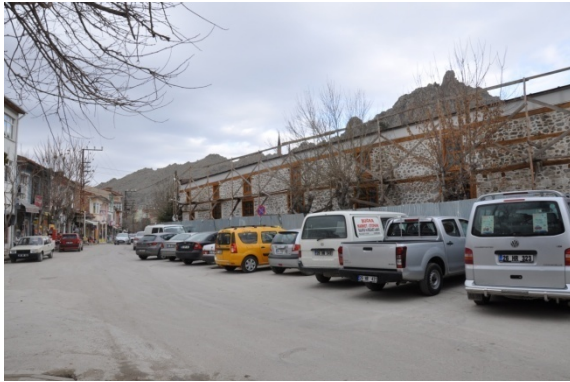
Şekil 4.42. Sivrihisar Ulu Camii güney cephesi genel görünümü(Aydın 2015)
