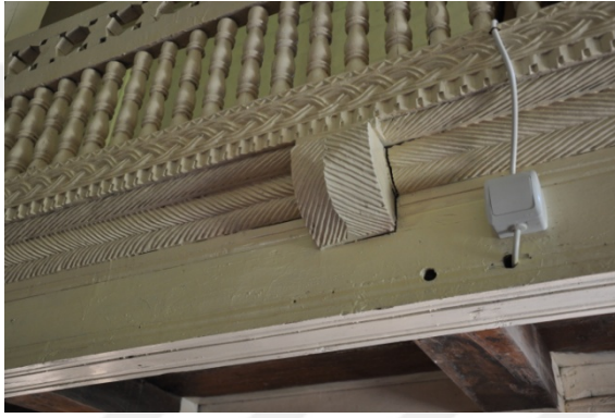
Şekil 4.590. Serindere Camii çantı tekniği (Aydın 2016)
