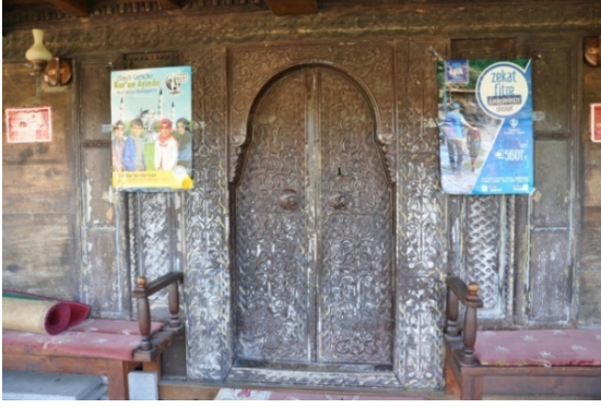
Şekil 4.688. Hüseyin Hoca Camii giriş kapısı (Aydın 2016)
