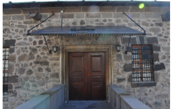
Şekil 4.108. Afyon Ulu Cami batı cephesi giriş kapısı(Aydın 2015)
