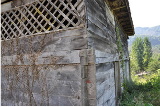
Şekil 4.480. Kargılı Camii kuzeybatı giriş görünümü(Aydın 2016)
