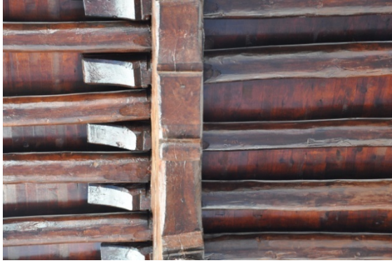
Şekil 4.267. Sille Çay Camii son cemaat bölümü ahşap taşıyıcı sistemi (Aydın 2015)
