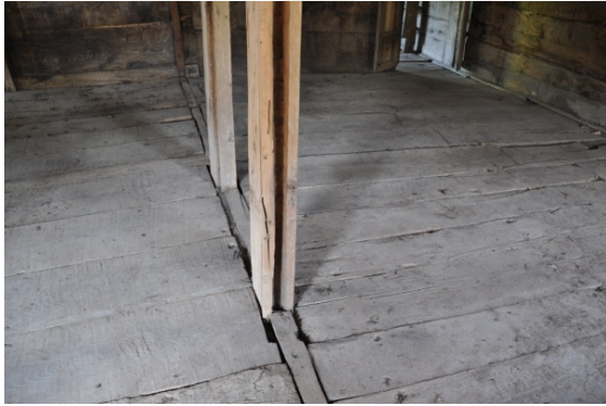
Şekil 4.488. Kargılı Camii dikme birleşim örneği (Aydın 2016)
