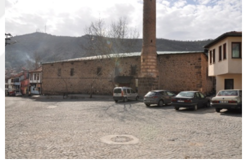
Şekil 4.126. Afyon Ulu Cami kuzey cephesi (Aydın 2015)
