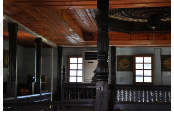
Şekil 4.548. Mithat Paşa Camii dikme görünümü (Aydın 2016)
