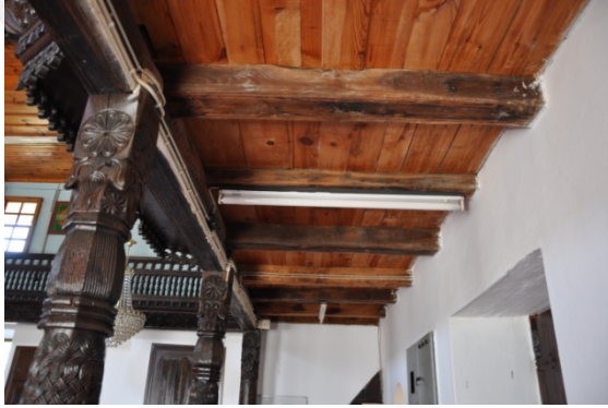
Şekil 4.533. Mithat Paşa Camii mahfil taşıyıcı dikmeleri (Aydın 2016)
