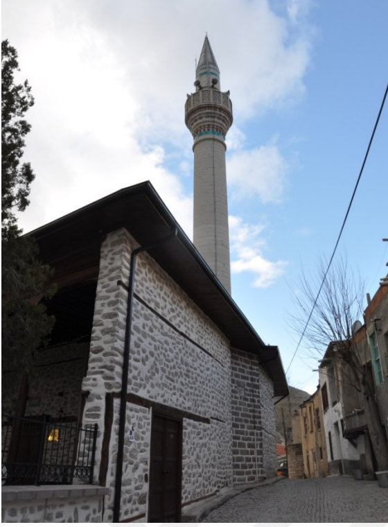
Şekil 4.247.Sille Ak Cami Kuzey Cephesi (Aydın 2015)
