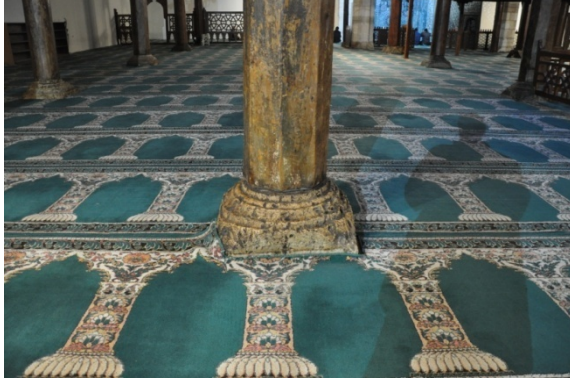
Şekil 4.204. Eşrefoğlu Süleyman Bey Camii dikme ayağı (Aydın 2015)
