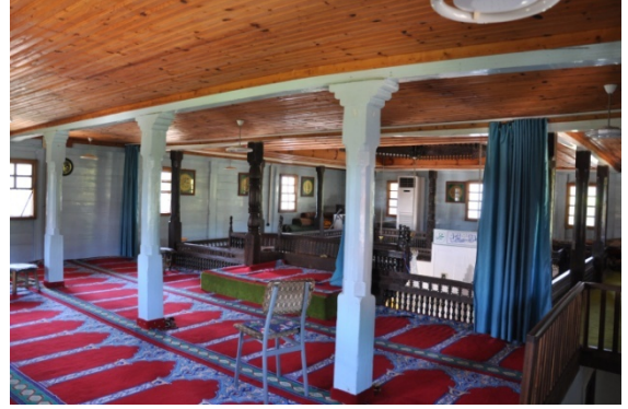
Şekil 4.556. Mithat Paşa Camii hanımlar mahfili taşıyıcı dikmeler (Aydın 2016)
