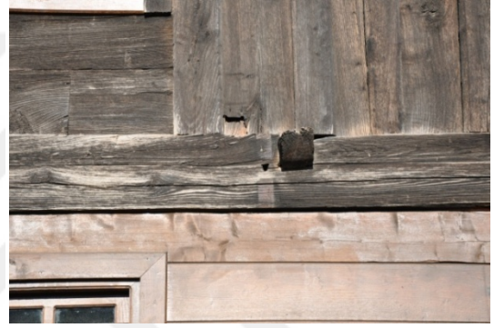
Şekil 4.698. Hüseyin Hoca Camii doğu cephesi birleştirme tekniği (Aydın 2016)
