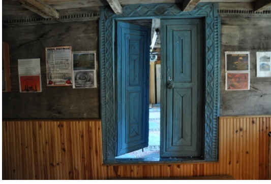
Şekil 4.508. Yeni Cuma Camii harim kapısı(Aydın 2016)
