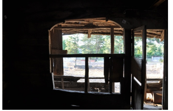
Şekil 4.427. Kuşhane Köyü Camii Son Cemaat yeri pencere açıklığı (Aydın 2016)
