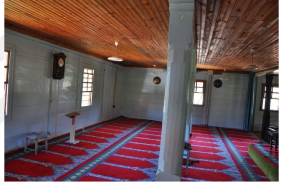
Şekil 4.552. Mithat Paşa Camii mahfil dikme görünümü (Aydın 2016)
