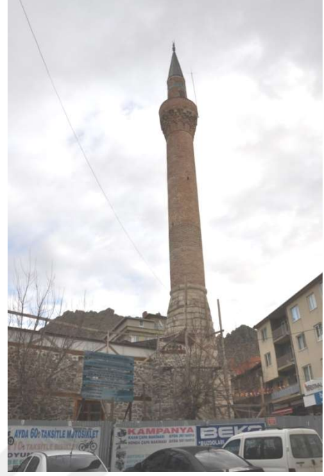
Şekil 4.102. Sivrihisar Ulu Camii minare görünümü (Aydın 2015)
