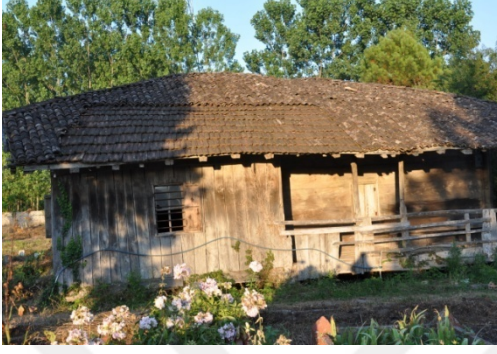
Şekil 4.432. Ustacalı Köyü Camii batı cephesi (Aydın 2016)
