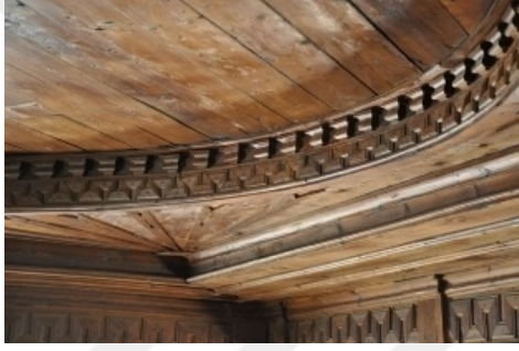
Şekil 4.22. İznik Elmalı Camii kademeli ahşap tavan detayı(Aydın 2015)
