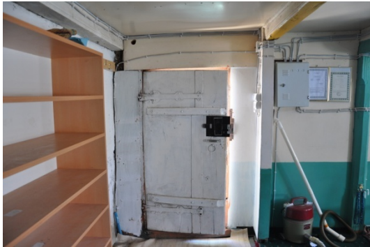
Şekil 4.599. Çamlıbel Köyü Camii harim kapısı(Aydın 2016)
