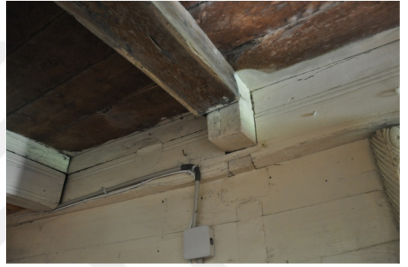
Şekil 4.591. Serindere Camii çantı tekniği (Aydın 2016)
