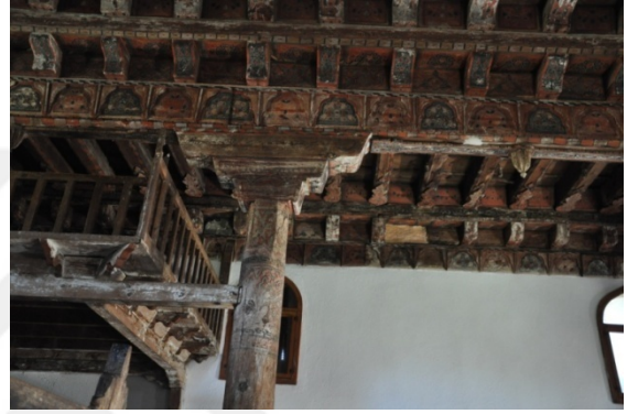
Şekil 4.339. Mahmut Bey Camii ahşap dikme başlık detayı (Aydın 2014)
