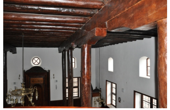
Şekil 4.296. SilleÇay Camii ahşap taşıyıcı detay görünümü (Aydın 2015)
