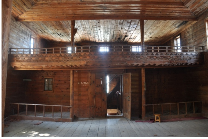
Şekil 4.369. Beldeğirmen Köyü Camii harim girişi ve mahfil görünümü (Aydın 2014)
