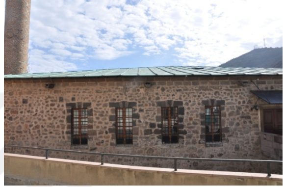
řekil 4.110. Afyon Ulu Cami batı cephesinde yer alan pencereler(Aydın 2015)
