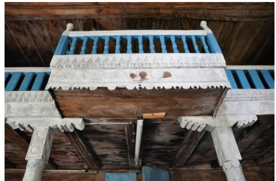
Şekil 4.513. Yeni Cuma Camii mahfil çıkıntısı(Aydın 2016)
