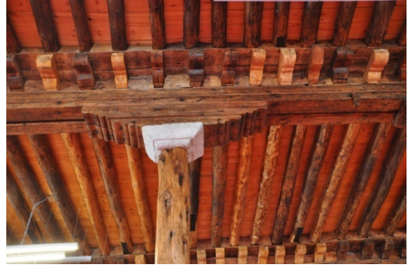
Şekil 4.85. Sivrihisar Ulu Camii ahşap dikme başlığı ve tavan görünümü (Aydın 2015)
