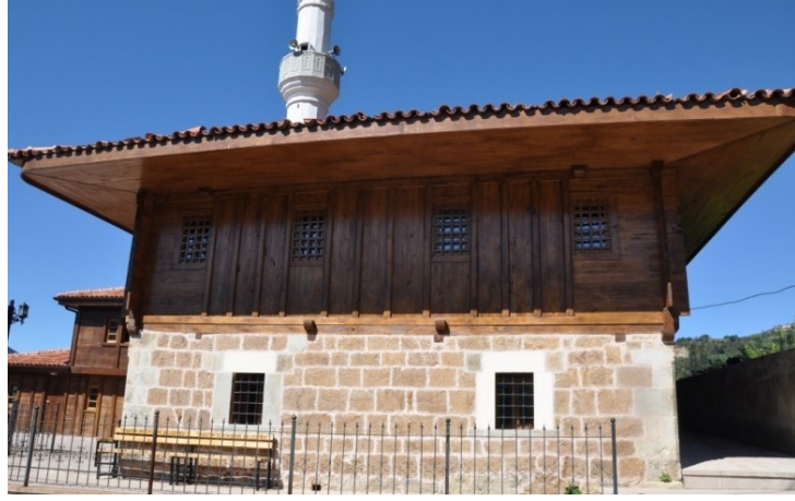
Şekil 4.635. Taşören Köyü Camii güney cephesi(Aydın 2016)
