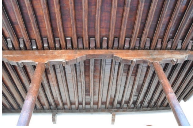
Şekil 4.269. Sille Çay Camii son cemaat bölümü revak detayı (Aydın 2015)
