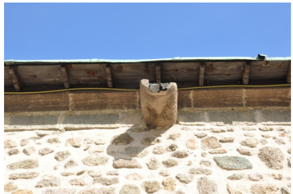
Şekil 4.116. Afyon Ulu Cami güney cephesi oluk görünümü (Aydın 2015)
