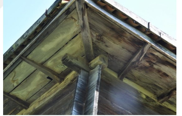
Şekil 4.502. Yeni Cuma Camii saçak görünümü ve çantı tekniği (Aydın 2016)
