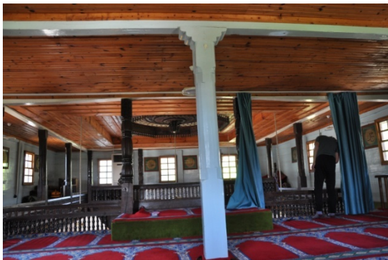
Şekil 4.553. Mithat Paşa Camii mahfil dikme görünümü (Aydın 2016)
