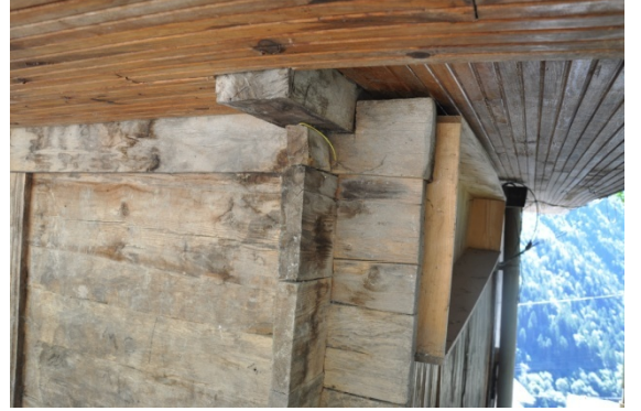
řekil 4.594. amlıbel Ky Camii kuzey cephesi grnm (Aydın 2016)
