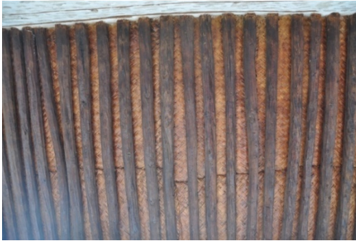
Şekil 4.237. Sille Ak Cami Son Cemaat bölümü mertekler (Aydın 2015)
