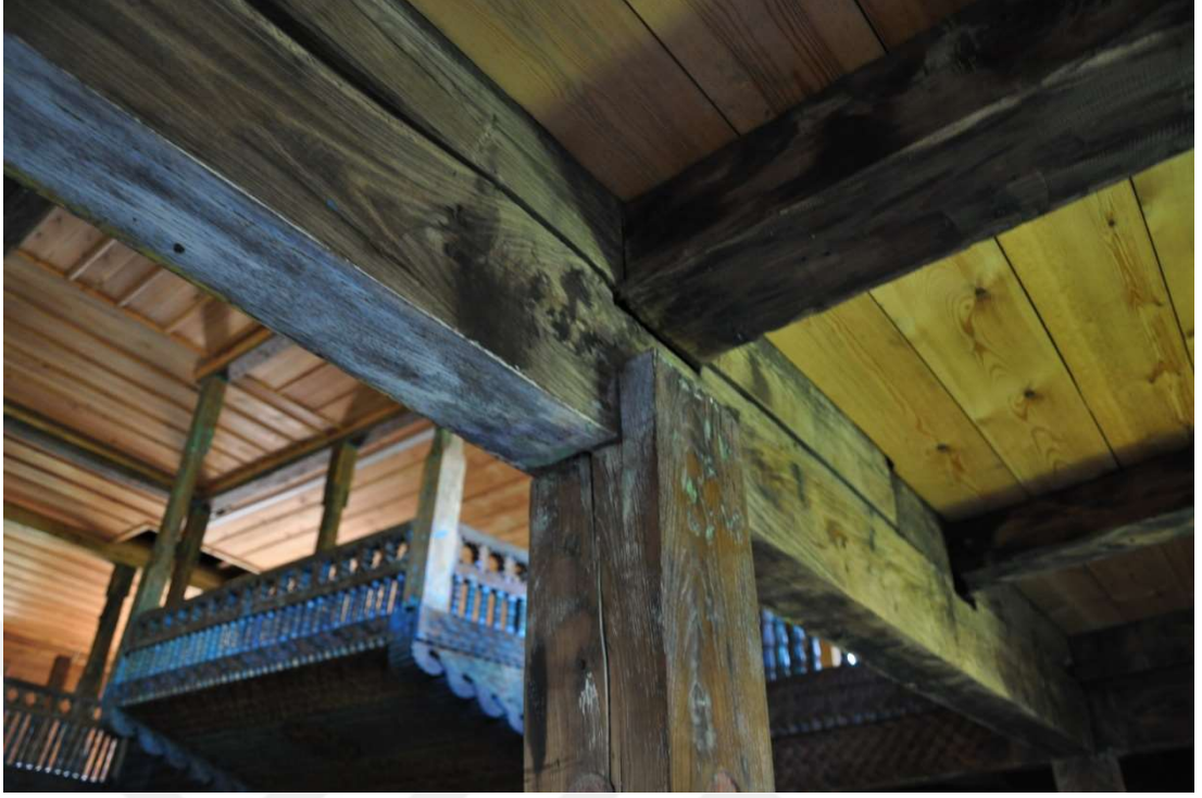
Şekil 4.6. Artvin Düzköy Köyü Camii dikme ve kiriş birleşimi (Aydın 2016)
