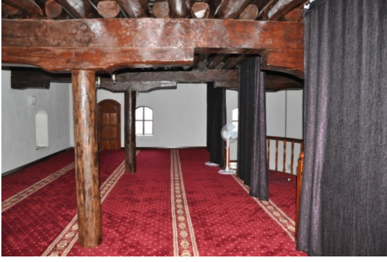
Şekil 4.286. Sille Çay Camii mahfil katı (Aydın 2015)
