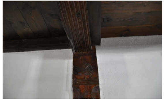
Şekil 4.776. Zeytinlik Köyü Camii dikme birleşim detayı (Aydın 2016)
