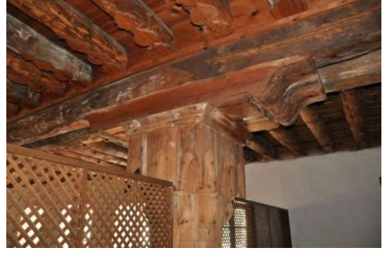
Şekil 4.164. Afyon Ulu Camii mukarnas başlık birleşim detayı (Aydın 2015)
