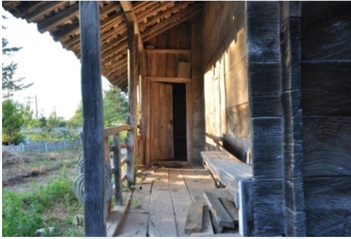
Şekil 4.439. Ustacalı Köyü Camii batı cephesi giriş kapısı (Aydın 2016)
