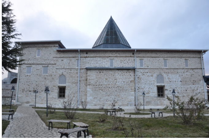
Şekil 4.184. Eşrefoğlu Süleyman Bey Camii güney cephe görünümü (Aydın 2015)
