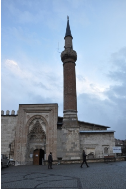
Şekil 4.185. Eşrefoğlu Süleyman Bey Camii ana cephe taç kapı görünümü (Aydın 2015)
