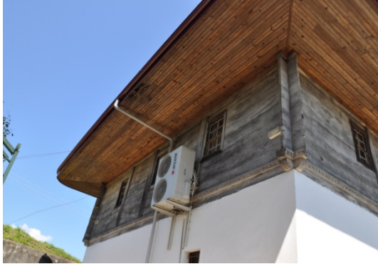
Şekil 4.520. Mithat Paşa Camii güney cephesi (Aydın 2016)
