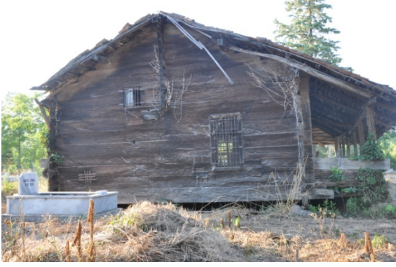
Şekil 4.405. Kuşhane Köyü Camii güney cephesi (Aydın 2016)
