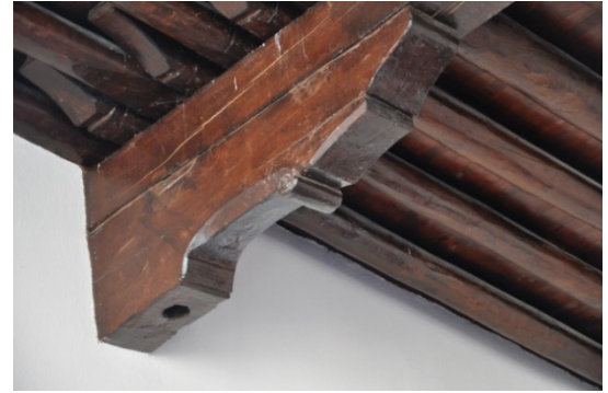
Şekil 4.274. Sille Çay Camii son cemaat bölümü ahşap taşıyıcı sistemi (Aydın 2015)
