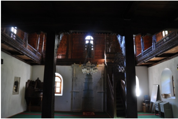
Şekil 4.619. Taşköprü Camii harim genel görünümü(Aydın 2016)
