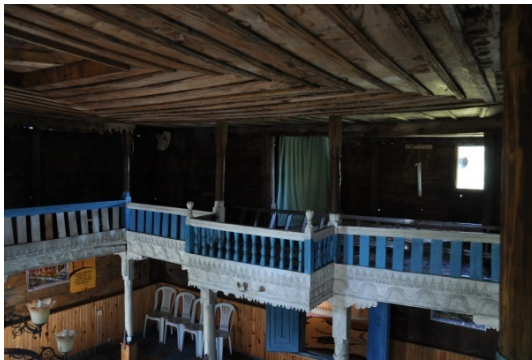
Şekil 4.512. Yeni Cuma Camii mahfil görünümü(Aydın 2016)
