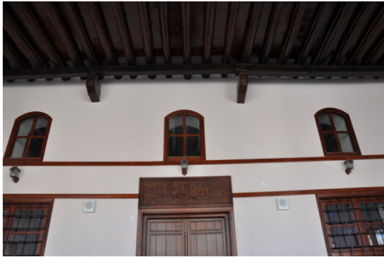
Şekil 4.263. Sille Çay Camii son cemaat bölümü (Aydın 2015)
