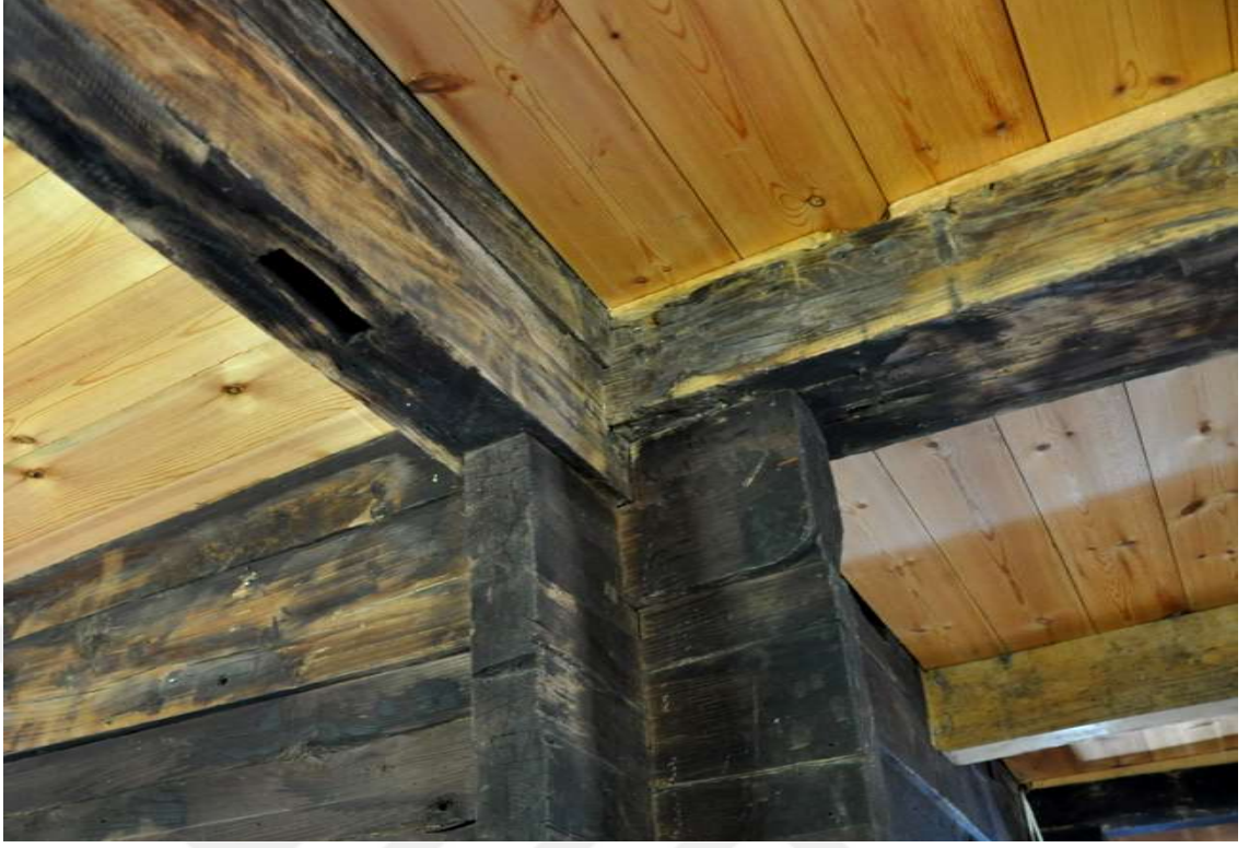
Şekil 4.4. Artvin Düzköy Köyü Camii duvar ve kiriş birleşimi(Aydın 2016)
