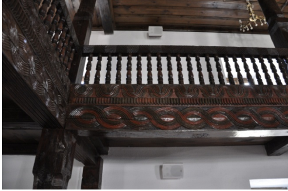
Şekil 4.787. Zeytinlik Köyü Camii üst mahfil korkuluk görünümü (Aydın 2016)
