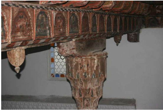
Şekil 4.340. Mahmut Bey Camii ahşap dikme detay görünümü (Aydın 2014)
