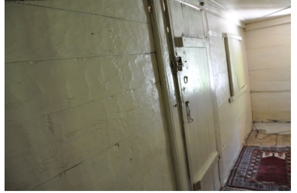
Şekil 4.578. Serindere Camii mahfil kapısı (Aydın 2016)
