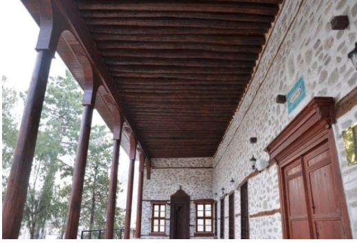
Şekil 4.235. Sille Ak Cami son cemaat bölümü (Aydın 2015)
