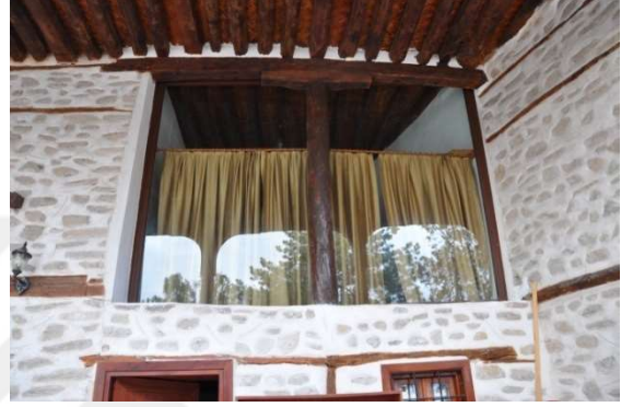
Şekil 4.241. Sille Ak Cami son cemaat bölümü (Aydın 2015)
