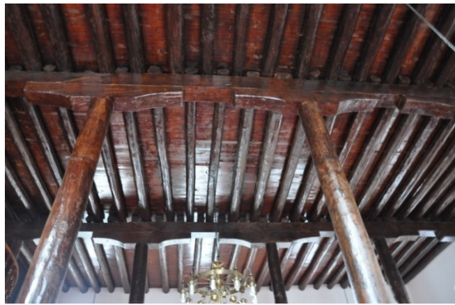
Şekil 4.294. Sille Çay Camii ahşap taşıyıcı sistemi (Aydın 2015)
