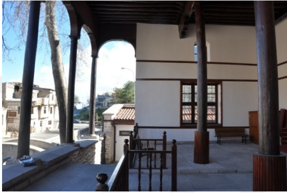
Şekil 4.261. Sille Çay Camii son cemaat bölümü (Aydın 2015)
