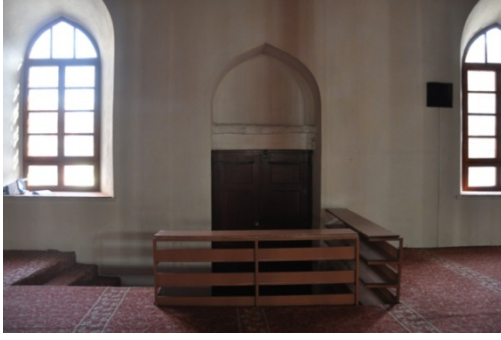
Şekil 4.132. Afyon Ulu Camii doğu girişi (Aydın 2015)
