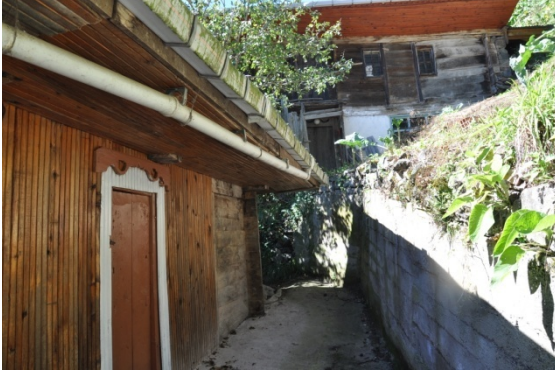
řekil 4.593. amlıbel Ky Camii kuzey cephesi grnm (Aydın 2016)
