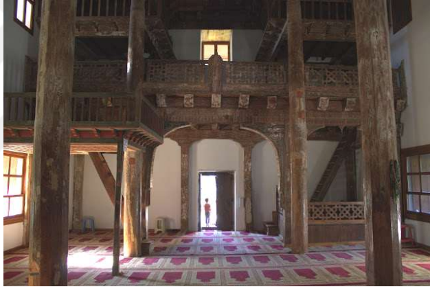
Şekil 4.327. Mahmut Bey Camii ahşap taşıyıcıları (Aydın 2014)
