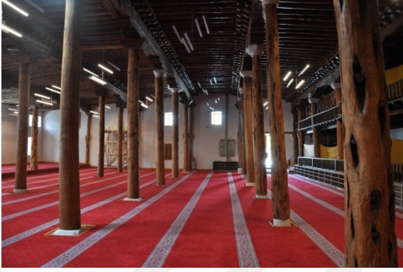
Şekil 4.74. Sivrihisar Ulu Camii ahşap dikmeleri (Aydın 2015)
