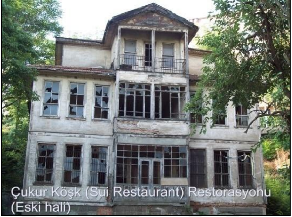
FOTOĞRAF-2 (RESTORASYON ÖNCESİ GÖRÜNÜŞÜ) (Seki Mimarlık arşivinden)
