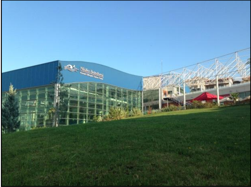
FOTOĞRAF-1 (KONAK OLİMPİK YÜZME HAVUZU KUZEY GÖRÜNÜŞÜ)
