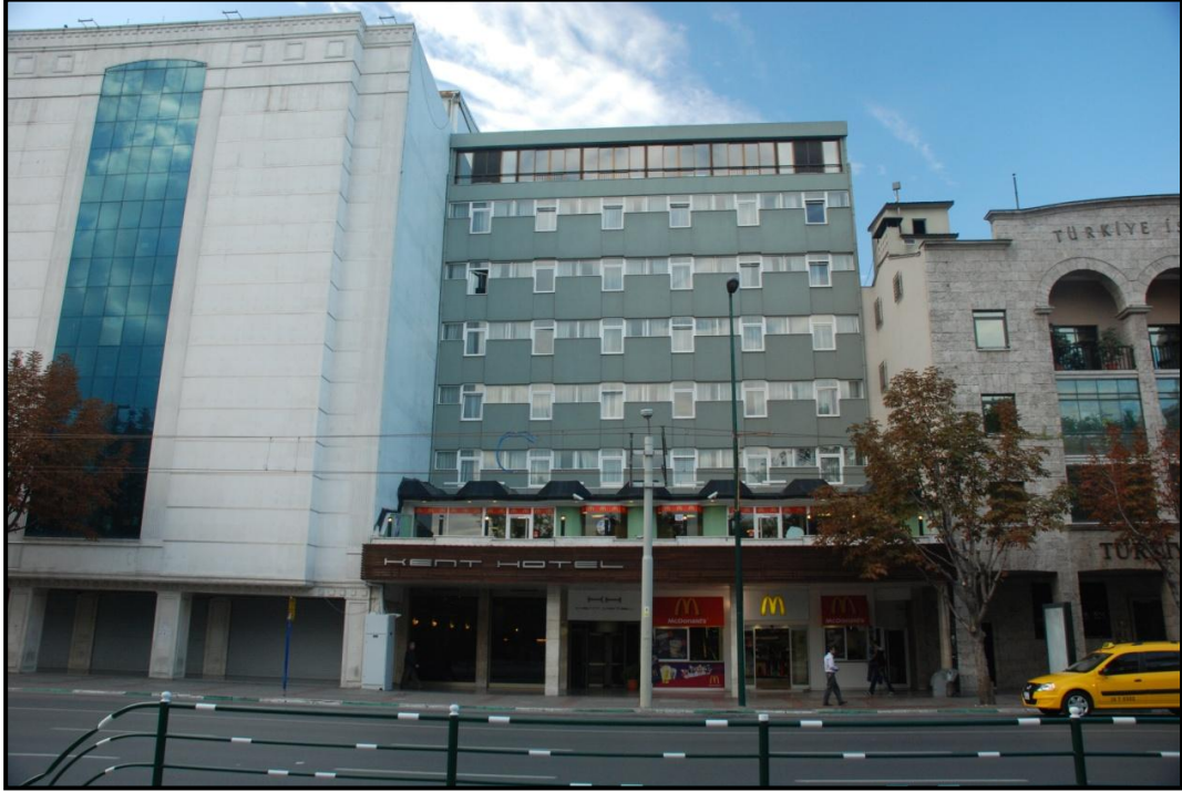
FOTOĞRAF-1 (KENT OTEL KUZEY GÖRÜNÜŞÜ)
