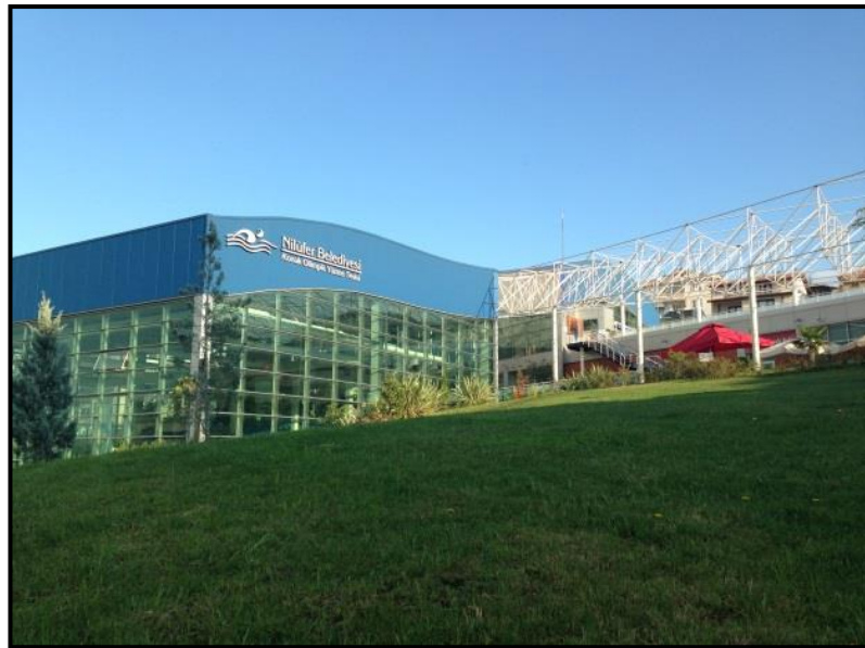
Şekil 3.17. Polikarbonat panel cephe kaplama malzemeleri (Konak Kapalı Spor Salonu)
