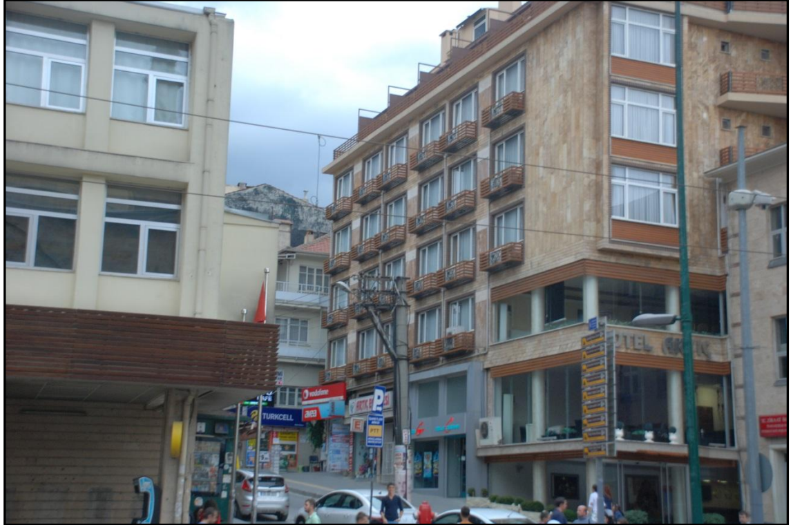
FOTOĞRAF-1 (ARTIÇ OTEL DOĞU VE GÜNEY GÖRÜNÜŞÜ)
