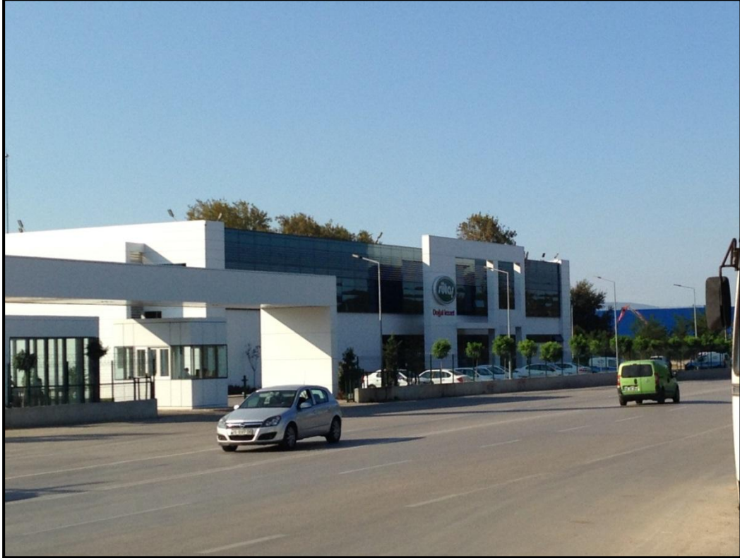
FOTOĞRAF-1 (SÜTAŞ BURSA BÖLGE MÜDÜRLÜĞÜ DOĞU GÖRÜNÜŞÜ)
