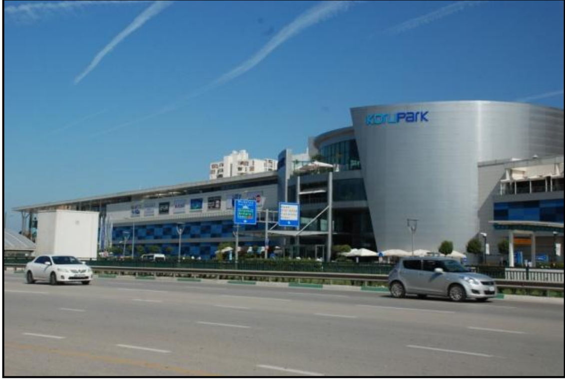
FOTOĞRAF-1 (KORUPARK GÜNEY GÖRÜNÜŐÜ)
