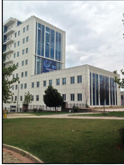
Şekil 3.8. Metal Kompozit esaslı cephe kaplama malzemeleri (Türk Telekom Bursa Bölge Müdürlüğü)
