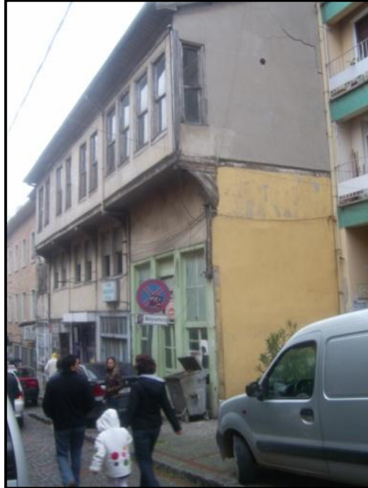
FOTOĞRAF-3 (YENİ ANKARA OTELİ RESTORASYON ÖNCESİ GÖRÜNÜŞÜ) (Seki Mimarlık arşivinden)
