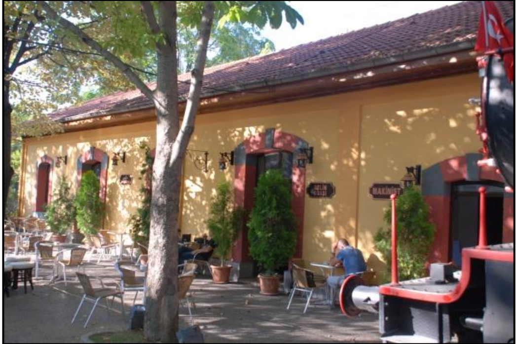
FOTOĞRAF-1 (ESKİ MERİ NOS TREN İSTASYONU GÜNEY GÖRÜNÜŞÜ)
