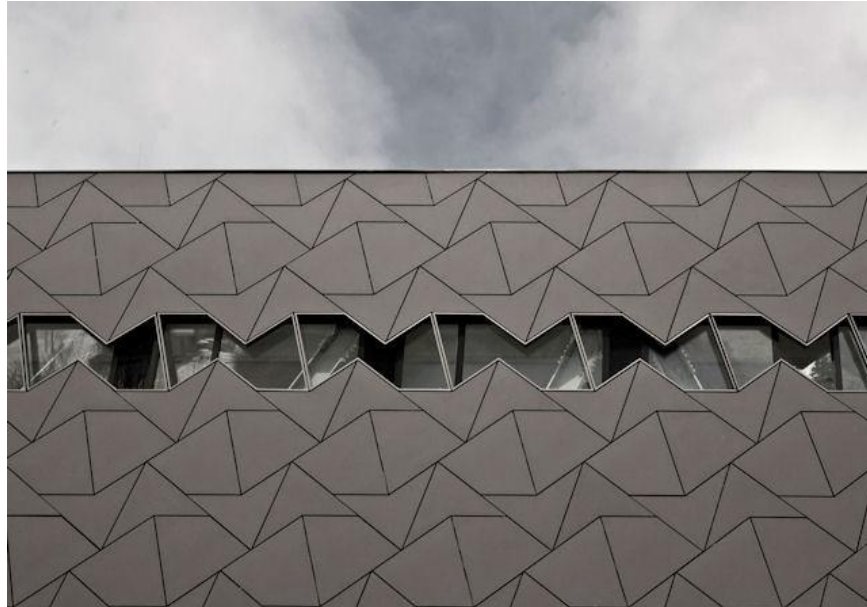
Şekil 3.15. Çimento esaslı yonga levha cephe kaplama malzemeleri ( http://galeri3.arkitera.com/var/albums/Urun/2013/ozdemiryapi_01/sErl_Festival-hall-05.jpg , 2016)
