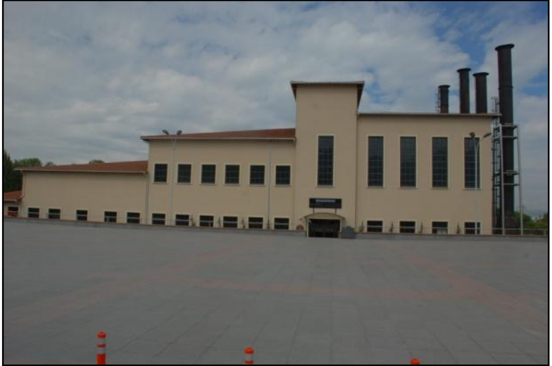
FOTOĞRAF-1 (BURSAENERJİ MÜZESİ GÜNEY GÖRÜNÜŞÜ)
