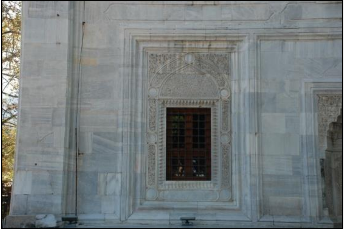
Şekil 3.13. Mermer cephe kaplama malzemeleri (Bursa Yeşil Camii)
