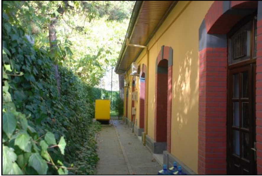
Şekil 3.10. Tuğla cephe kaplama malzemeleri (Eski Merinos Tren İstasyonu)
