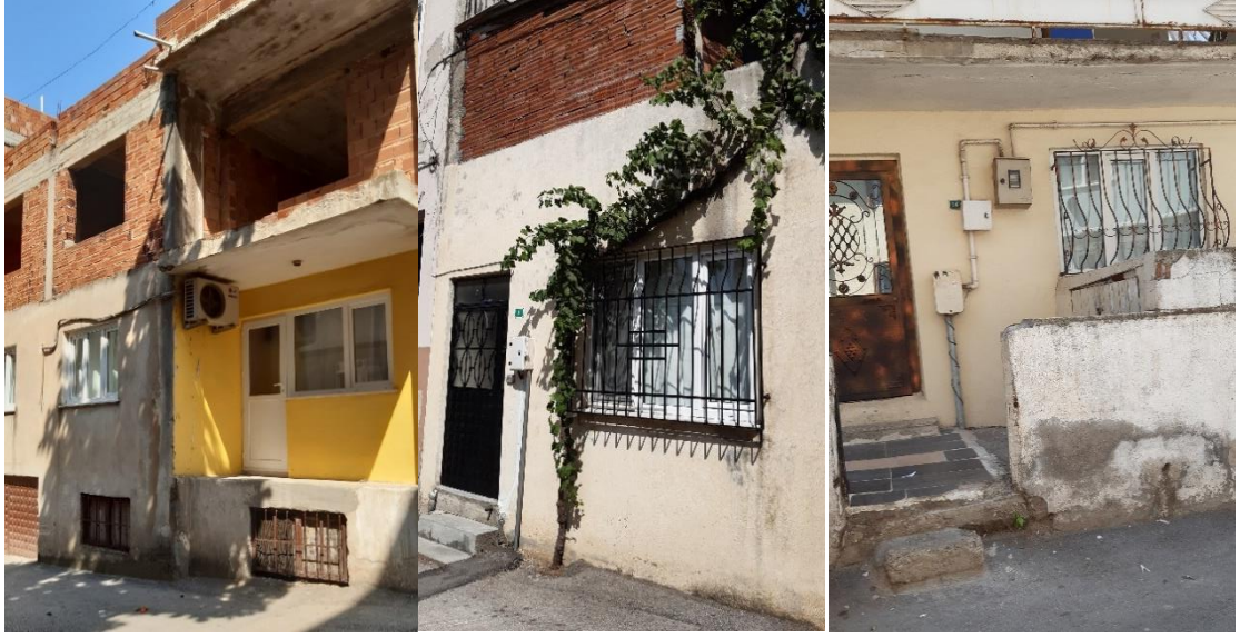
Şekil 3.28. Yiğitler Mahallesiindeki niteliksiz yapılar ve kullanılan yapı malzemeleri
