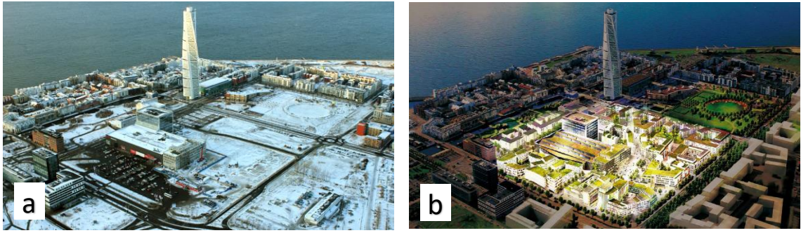
Şekil 2.19. Mathusen kentsel dönüşüm alanı eski hali ve öngörülen proje ((a) bölgenin mevcut durumu, (b) bölge için hazırlanan proje) (Anonim 2012d)
