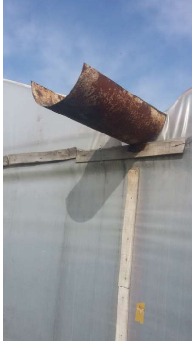
Şekil 4.3. Araştırma alanındaki seralarda kullanılan metal oluklar
