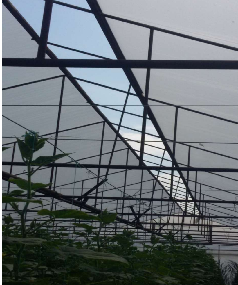
Şekil 4.6. Beşik çatılı plastik serada çatı havalandırma açıklığı
