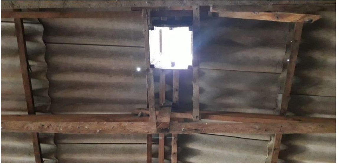
Şekil 2.2. Barınak çatısında bırakılan doğal havalandırma açıklığı
