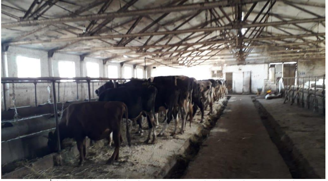
Şekil 4.3. İskelet malzemesi demir ve trapez sac olarak yapılmış çatı kaplaması örneği
