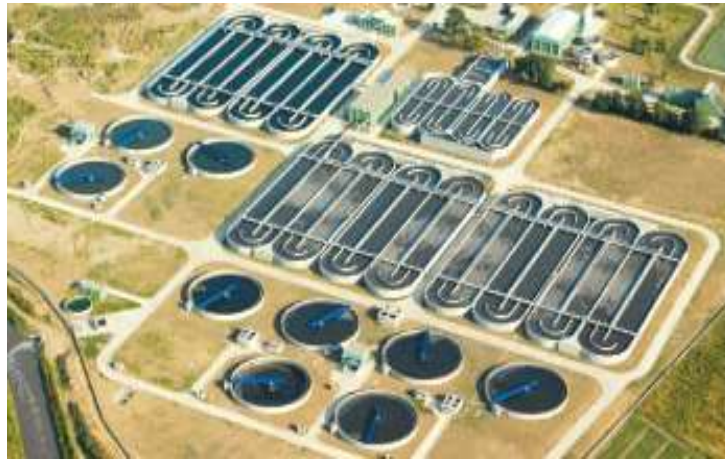
Şekil 3.1. BUSKİ Doğu Atıksu Arıtma Tesisi
