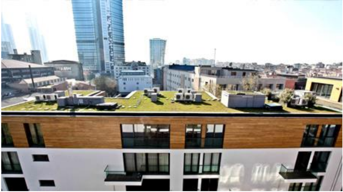
Şekil 3.8. Tekfen Bomonti Evleri yeşil çatı uygulaması ( http://i.dunyainsaat.com.tr/2/710/400/images/haberler/img53f12f1dc61cb.jpg?v=1408309200 ) (10.10.2018)
