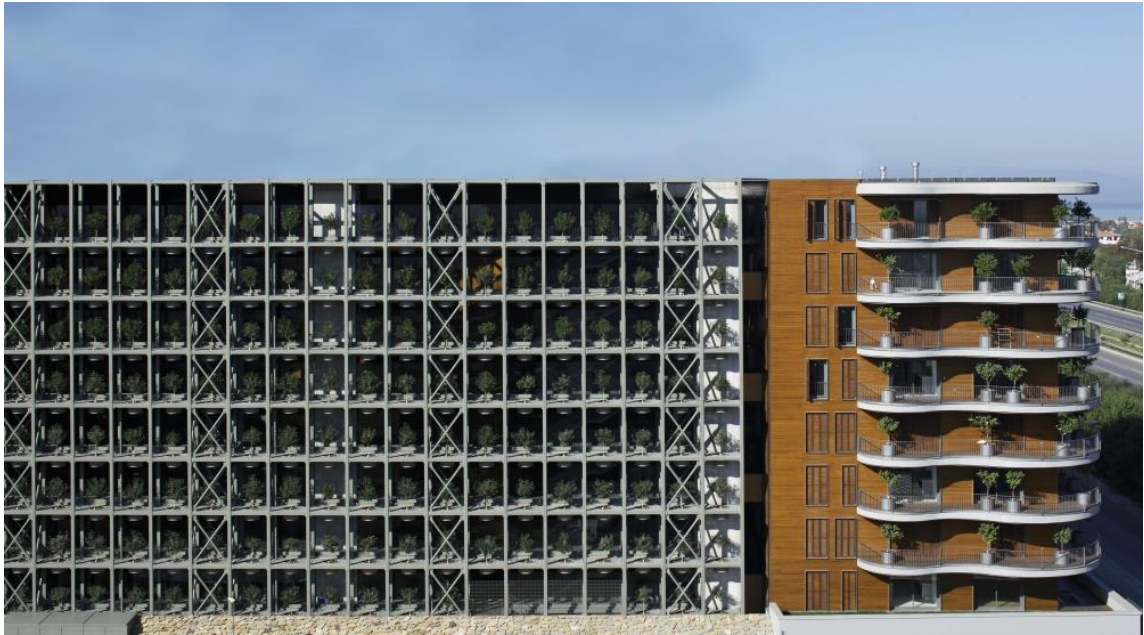
Şekil 3.11. Folkart Narlıdere cephedeki metal strüktür ( http://www.arkiv.com.tr/proje/folkart-narlidere-konutlari/1458 ) (05.07.2019)
