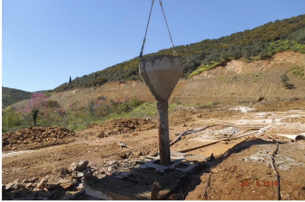
Şekil 3.34. Bentonit ile dolu hendeğe tremie borusunun yerleştirilmesi
