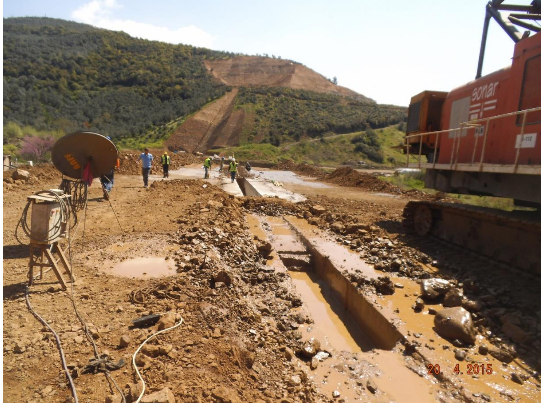
Şekil 3.33. Hendeğin bentonit ile desteklenmesi
