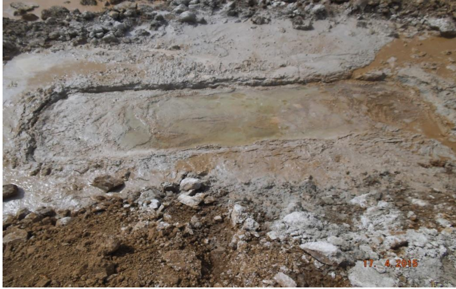
Şekil 3.36. Tamamlanmış slurry trench imalatı
