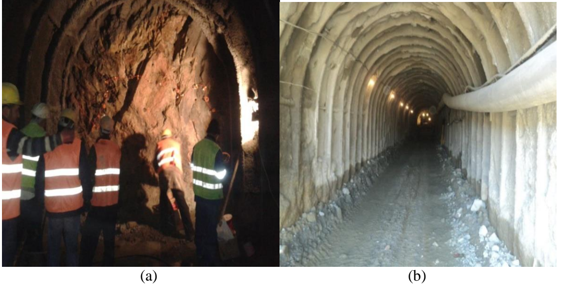
Şekil 3.15. (a) Tünel kazısı (b) Destekleme çalışmaları
