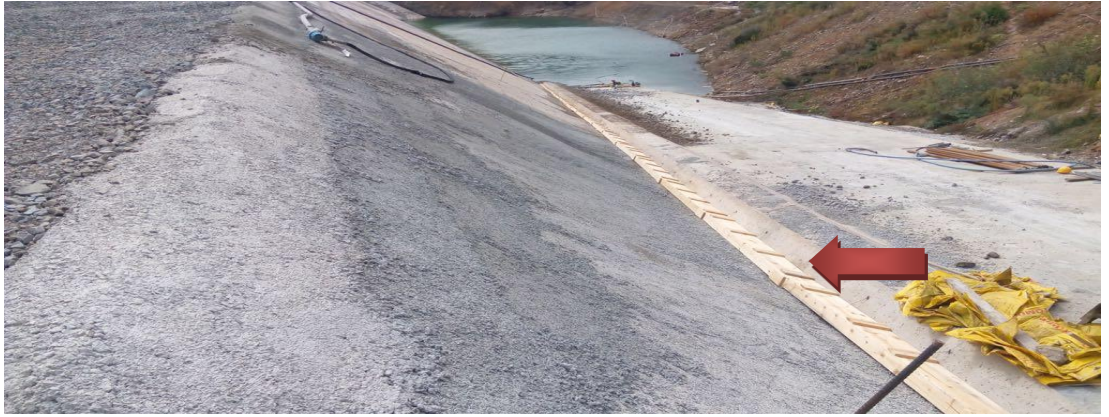
Şekil 3.23. Bakır su tutucuların ahşap takozlarla korunması
