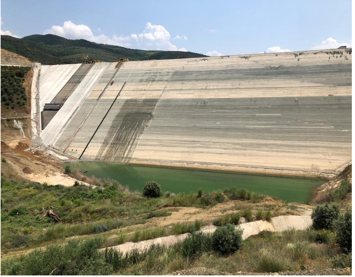
Şekil 3.22. Yapım aşaması genel görünüm
