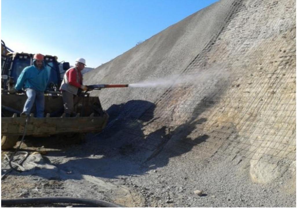
Şekil 3.14. Püskürtme betonu uygulaması
