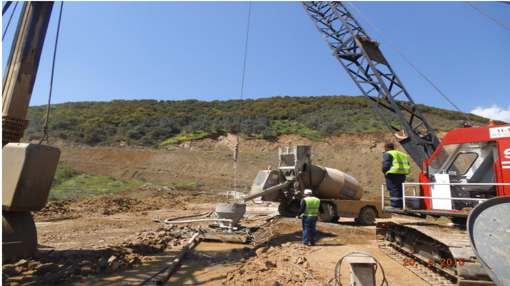
Şekil 3.35. Panellere slurry dökümü sırasında bentonit çamurununun dışarı çıkışı
