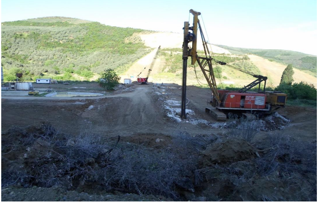
Şekil 3.32. Hendeklerin kazılması
