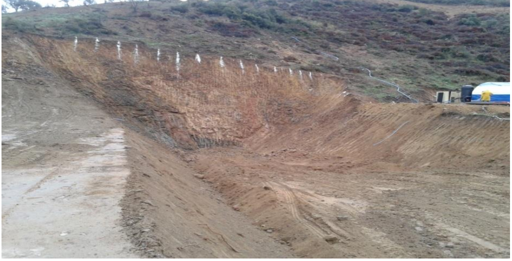
Şekil 3.13. Portal kazıları başlangıcı
