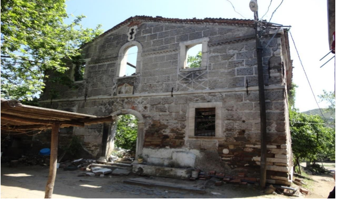
Şekil 3.6. Yapının ön cephe görünüşü
