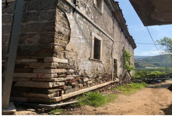
Şekil 3.2. Erdek Ballıpınar Kilisesi Taşıyıcı duvarlar
