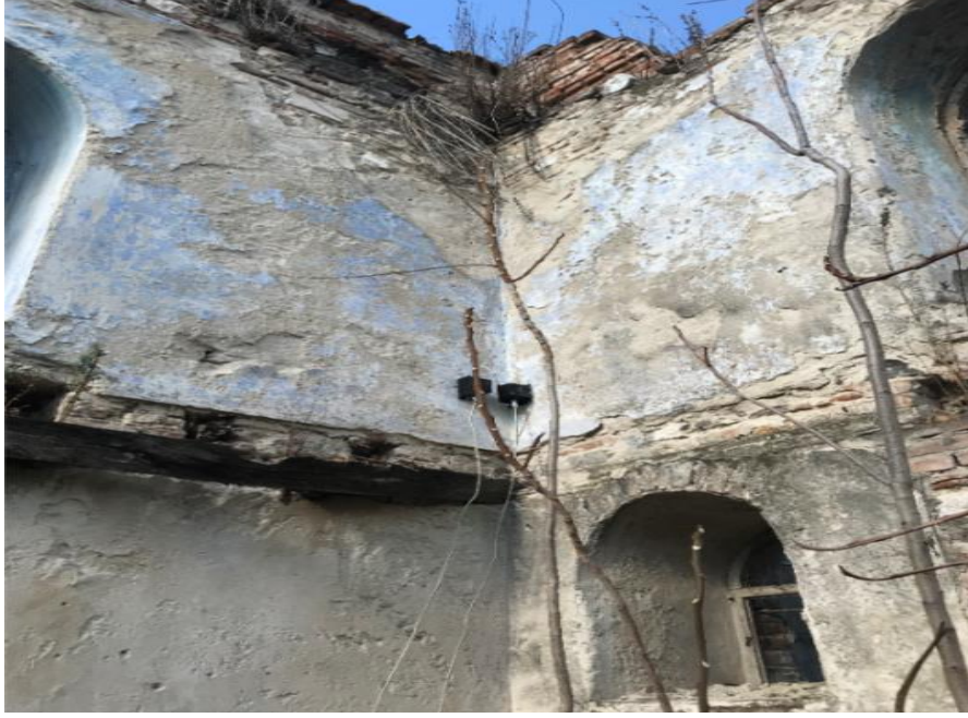
Şekil 3.20. BallıpınarKilisesi 1-4 no'lu sensörlerin yerleşimi
