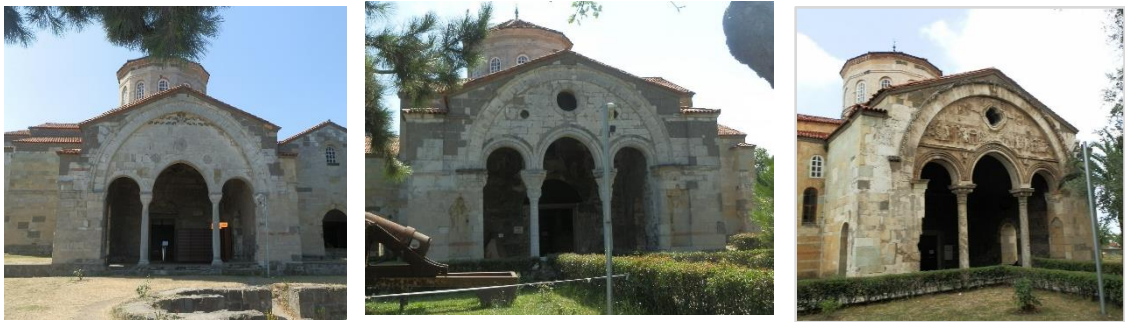
Şekil 4.30. Ayasofya Cami kuzey, batı ve güney cephesi (Anonim 2018)
