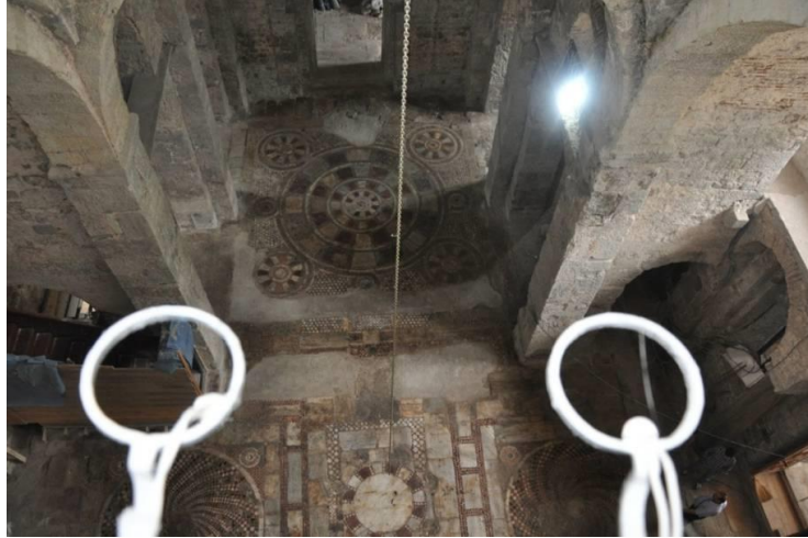
Şekil 4.7. Fatih Cami restorasyon sırasında açığa çıkarılan genel zemin döşemesi görünümü (Anonim 2018)
