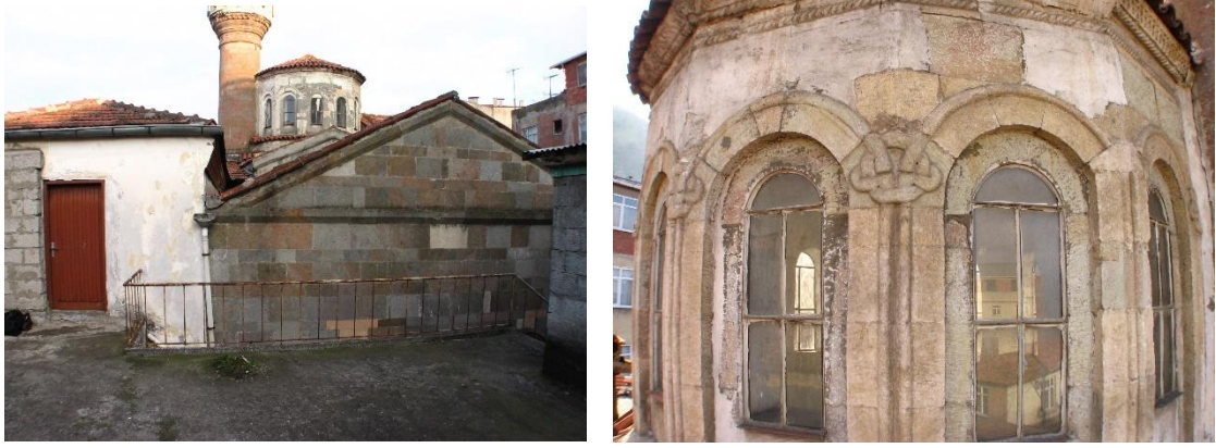
Şekil 4.41. Kudrettin Cami Batı cephesi ve kubbesi (Trabzon Vakıflar Bölge Müdürlüğü 2018)
