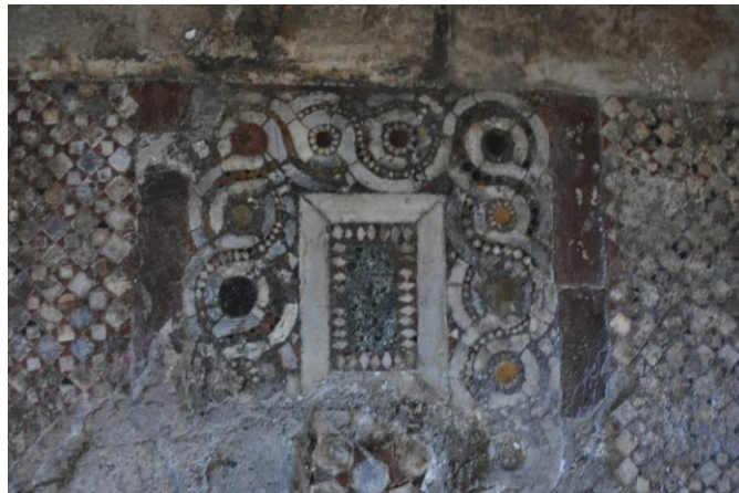
Şekil 4.9. Fatih Cami restorasyon sırasında açığa çıkarılan zemin döşemesi antrolac tasarımı (Anonim 2018)
