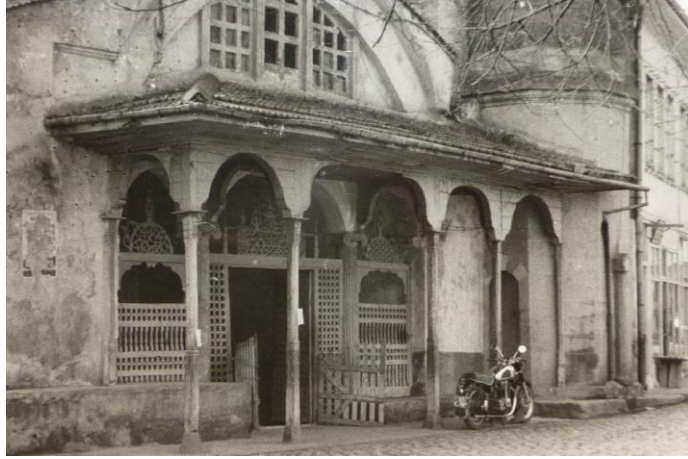
Şekil 4.14. Fatih Cami kuzey cephe ahşap sundurma (Anonim 2018)
