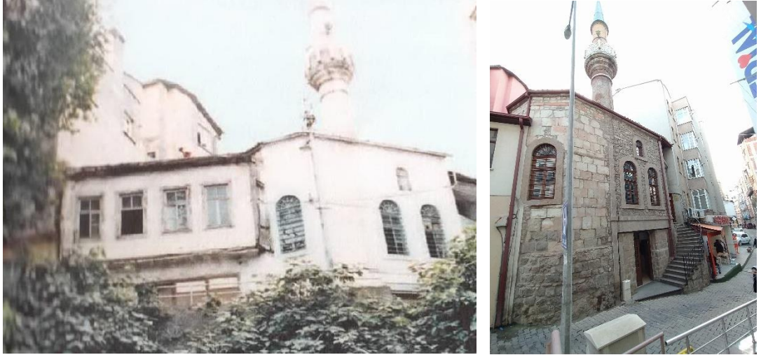
Şekil 4.27. a)Kemer kaya Cami restorasyon öncesi (Anonim 2018), b) restorasyon sonrası, 2019
