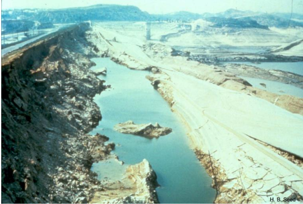
ekil 2.7. 1971 yılında gerekle en The Lower an Fernando depremi sırasında olu an akma gçmesi
