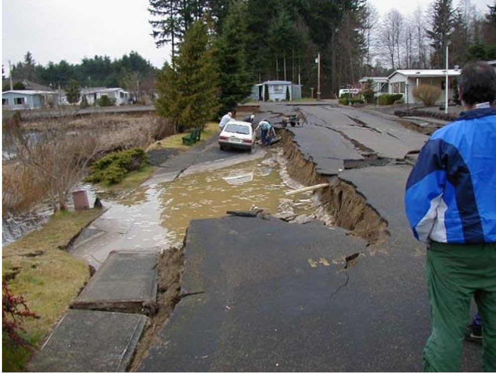
ekil 2.6. 2001 yılında Nisqually depremi sonrası olu an yanal yayılma durumu
