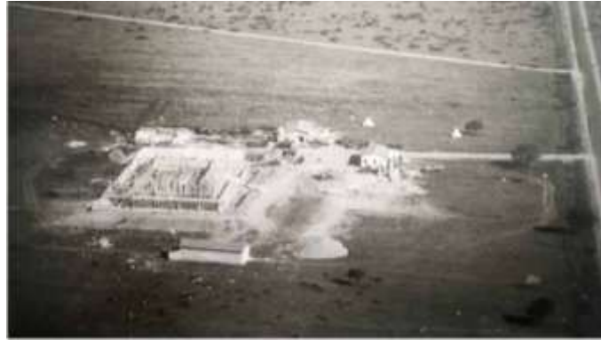
Şekil 3.23. BOSB'ın İlk Hali 1963 SİFAŞ Fabrikası İnşaatı. (Kuter 2017'den alınan Üstün Ürdül Arşivi)
