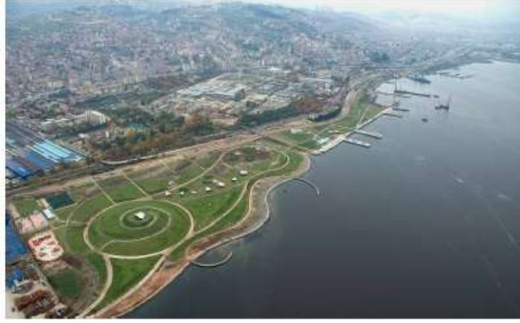
Şekil 2.12. Sekapark Tamamlanmış Olan Sahil Bölümü (Kocaeli Büyükşehir Belediyesi, Güzel 2010).
