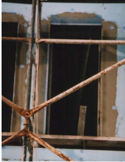
Fotoğraf 3.3. Pencere Dönüşlerinde Hazır Sıva Uygulanma Aşaması
