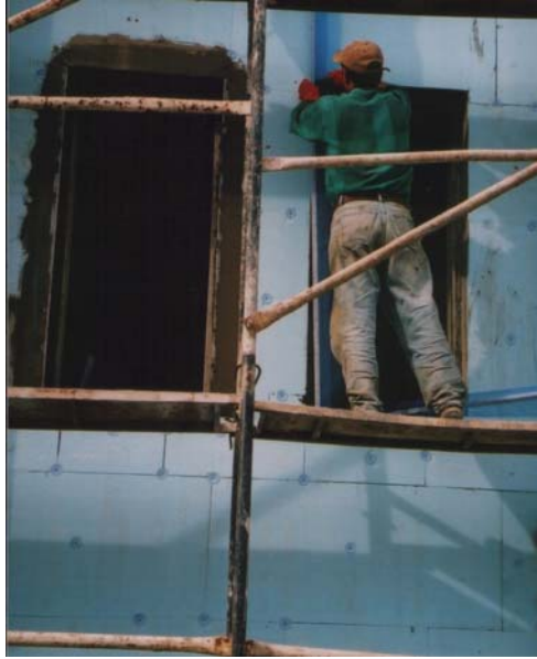
Fotoğraf 3.2. Köşe Profillerinin Yerleştirilme Aşaması
