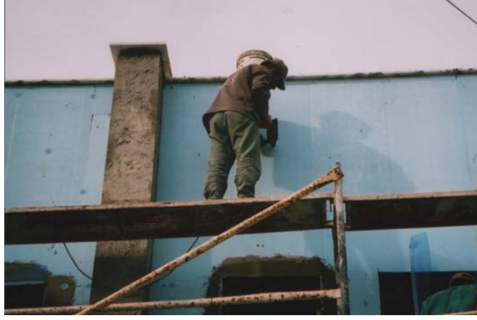
Fotoğraf 3.1. Isı Yalıtım Levhalarının Dübellenme Aşaması
