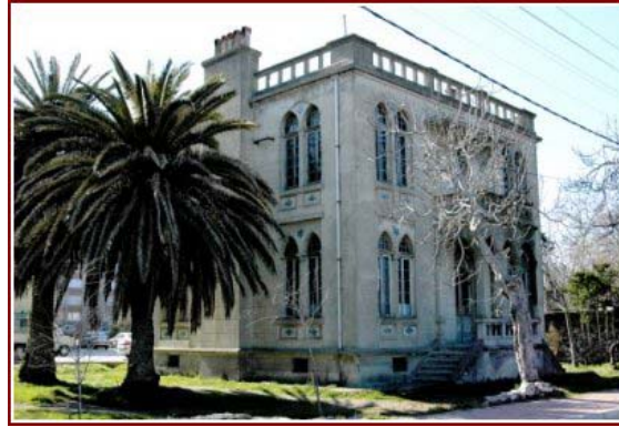
Şekil 14: Eski Bursa-Mudanya Demiryolu İstasyon İşletme Binası, Bursa ( http://www.mudanyaonline.net ) 29.08.2005
