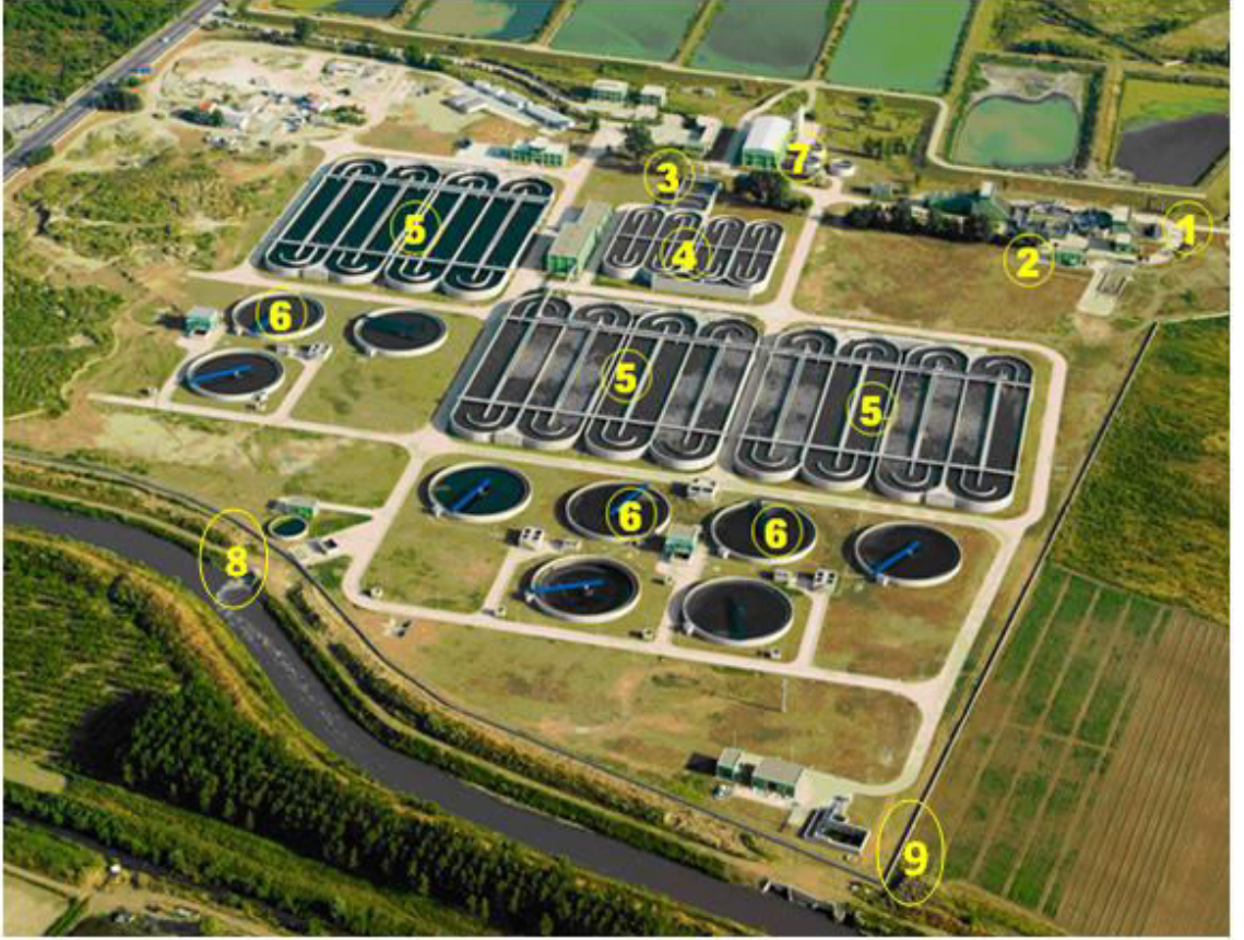
Şekil 2.5. Doğu Atıksu Arıtma Tesisi genel görünümü
