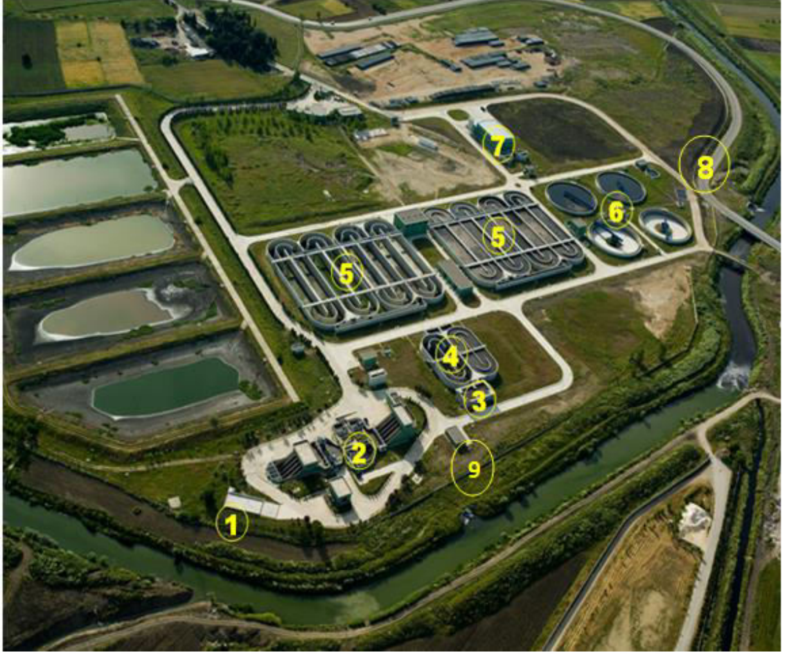
Şekil 2.6. Batı Atıksu Arıtma Tesisi genel görünümü
