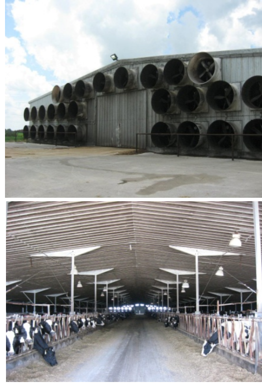
Resim 2. Süt sığırı yetiştiriciliğinde kullanılmaya başlanan Tünel Havalandırma Sistemleri (Florida, ABD).
