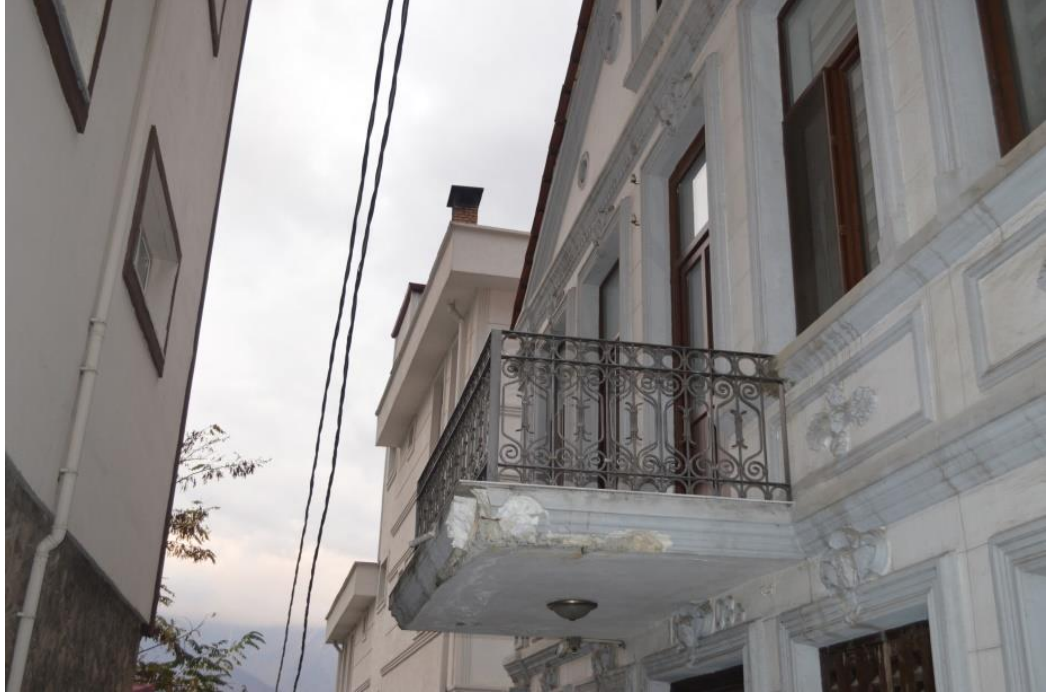
Fotoğraf 8: Eski Tekel İl Müdürlüğü Binası, kuzey cephede bulunan balkon.
