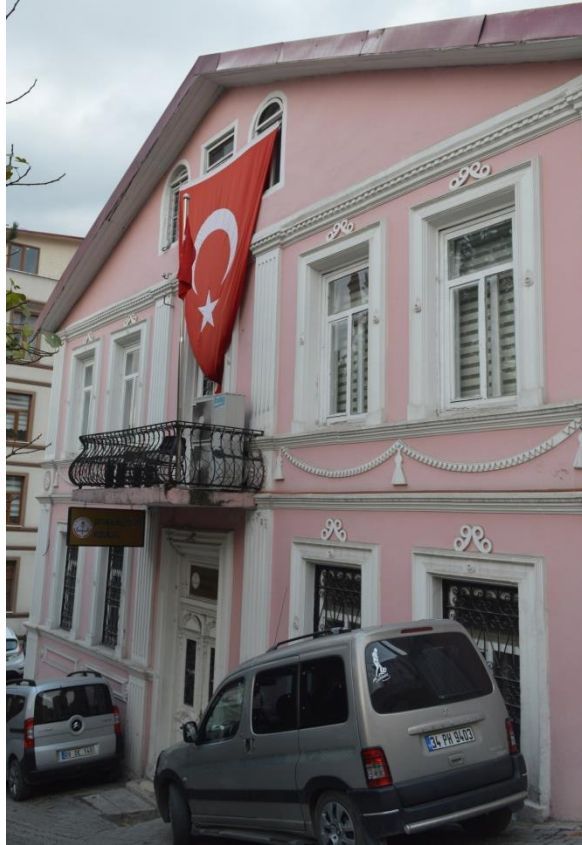
Fotoğraf 18: Eski Adliye Binası, kuzeyden görünüm (restorasyon sonrası hali).
