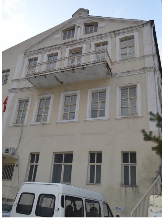
Fotoğraf 27: Kadastro Müdürlüğü Binası, güneyden görünüş (restorasyon sonrası hali)
