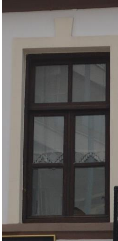
Fotoğraf 23: Eski Askerlik Şubesi Binası, pencere.
