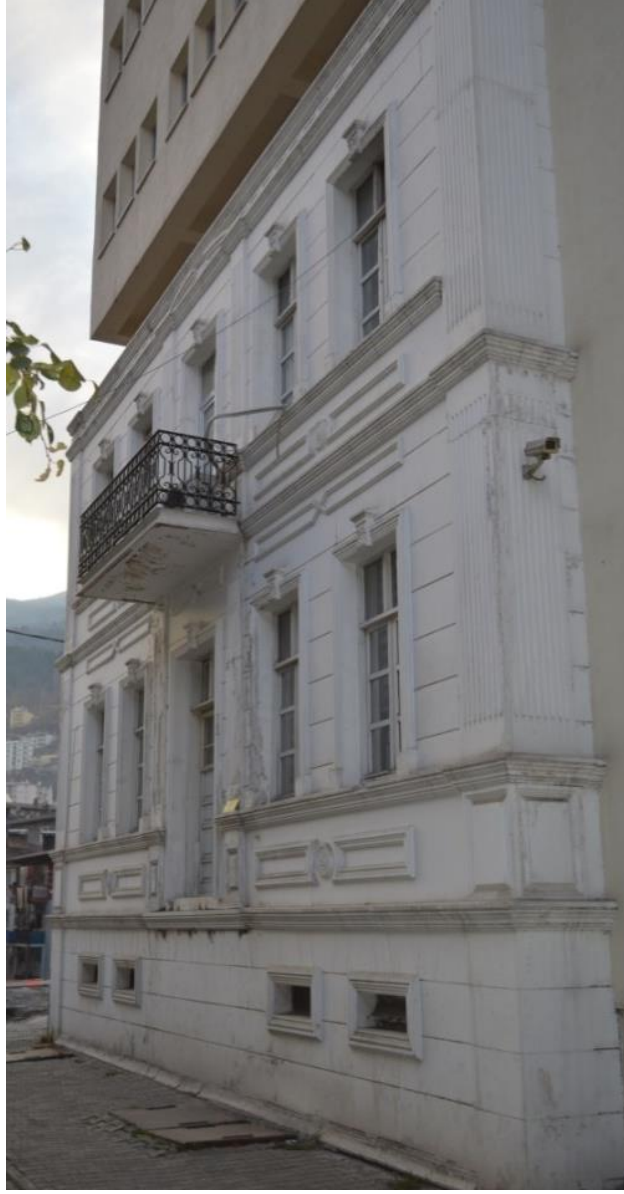
Fotoğraf 33: Eski Sağlık Müdürlüğü Binası 3, güney cephe.
