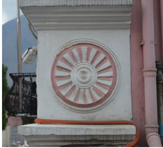
Fotoğraf 21: Eski Adliye Binası, pilaster detayı.
