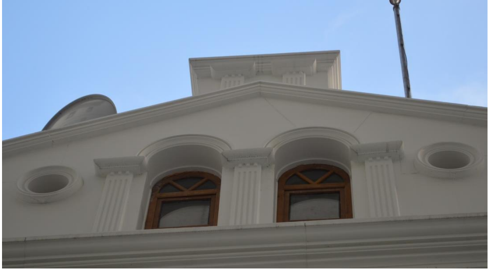
Fotoğraf 16: Eski Sağlık Müdürlüğü Binası, çatı katı, kuzeyden görünüş.
