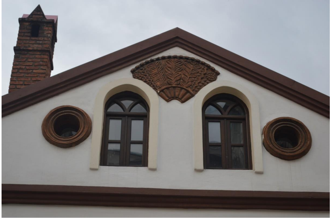
Fotoğraf 25: Eski Askerlik Şubesi Binası, çatı katı, kuzeyden görünüş.
