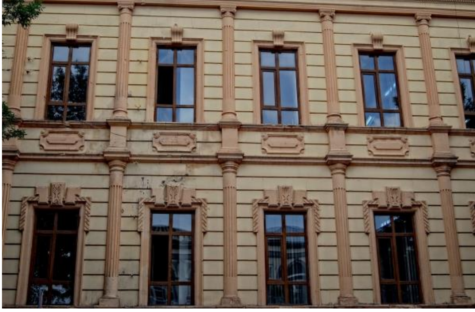
Fotoğraf 56: Kars Defterdarlık Binası 105 .
