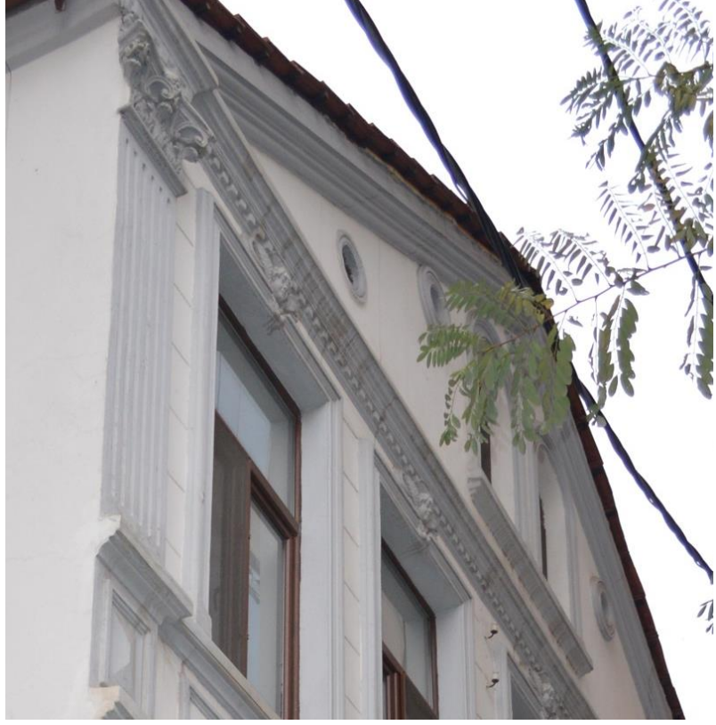
Fotoğraf 52: Eski Tekel Müdürlüğü binası, dış sırası motifi.
