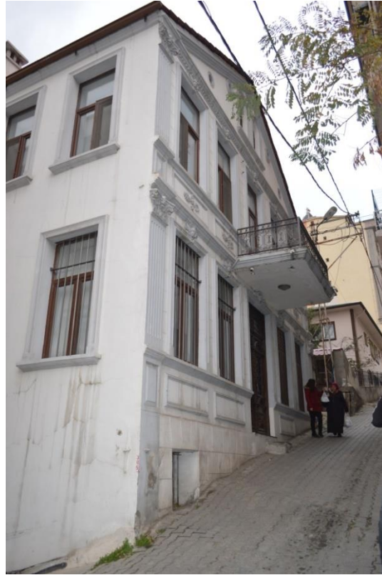
Fotoğraf 5: Eski Tekel İl Müdürlüğü Binası, kuzeyden görünüş.
