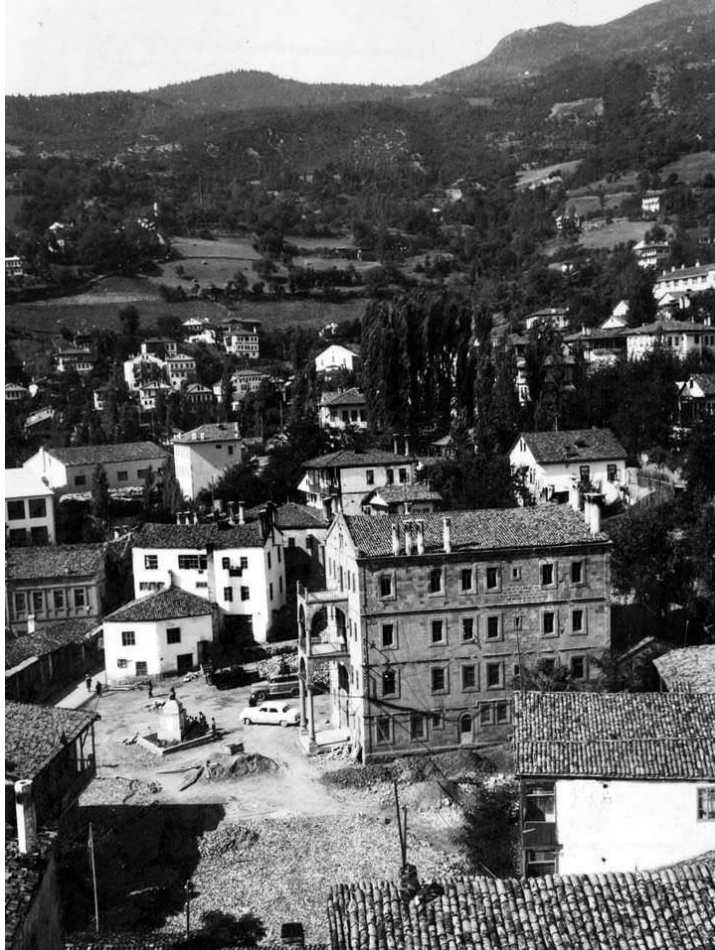
Fotoğraf 38: Artvin Eski Hükümet Konağı, kuzeyden görünüş (1952) 80 .
