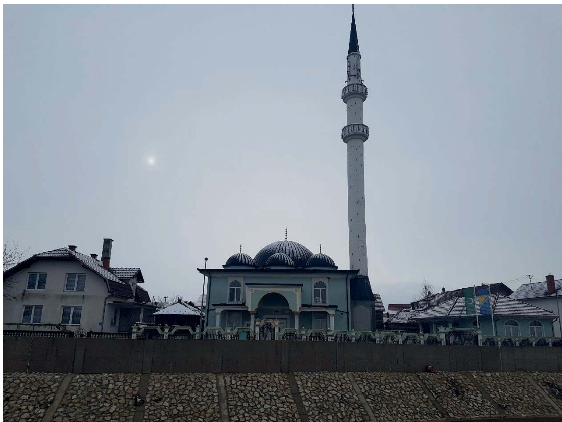
Foto 7. 2005 yılında yeniden yapılan Džedid Cami (27.02.2020)
