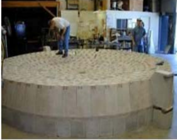
Şekil 3.28. Refraktör kemer ( Taban Çukuru ) ve kubbe
