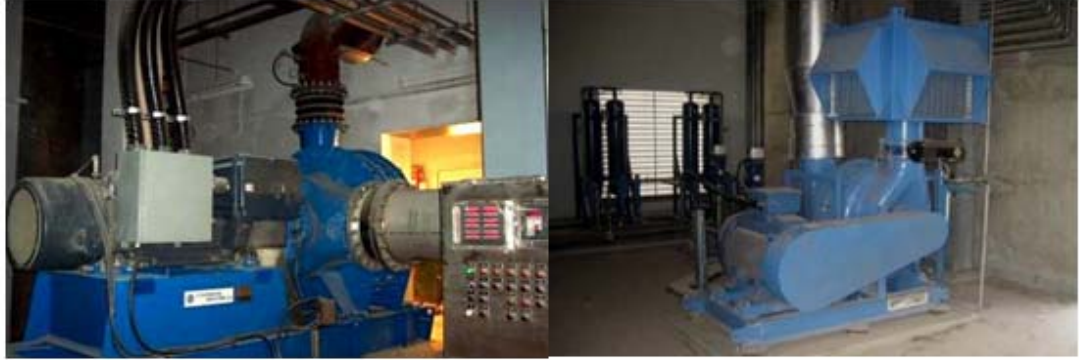
Şekil 3.32. Akışkanlaştırma Hava Bloweri
