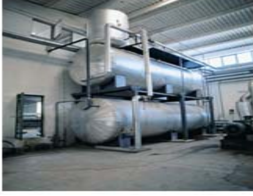
Şekil 3.43. Degazör Detay Resimleri
