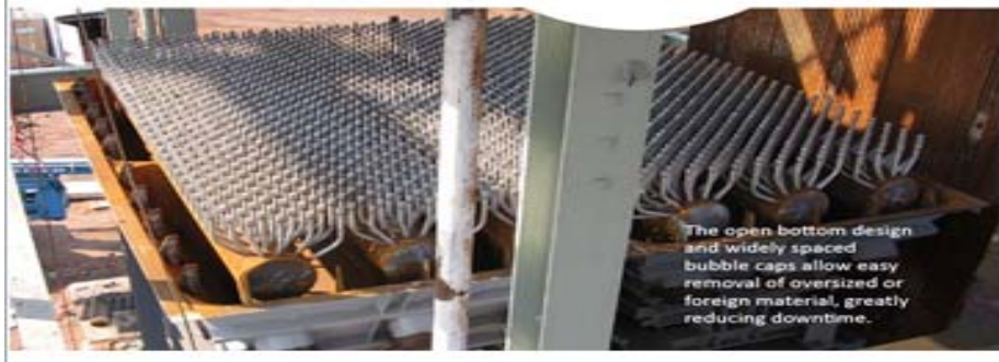
Şekil 3.19. Dolaşımli Akışkan Yataklı Kazan Detay Resmi
