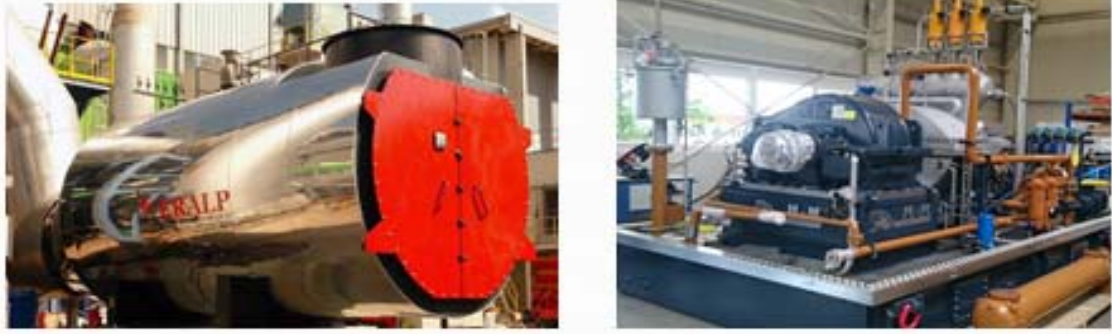
Şekil 3.41. Atık Isı Kazanı ile Buhar Türbini Detay Resmi
