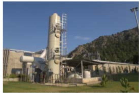
Şekil 3.50. Venturi Soğutucu -DYYK Akım Şeması ve Genel Görünümü
