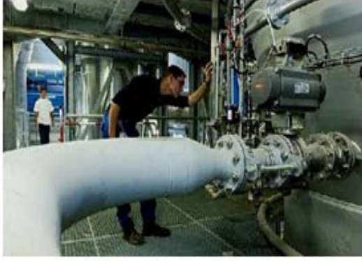
Şekil 3.34. Çamurun fırına enjeksiyonu (beslenmesi)
