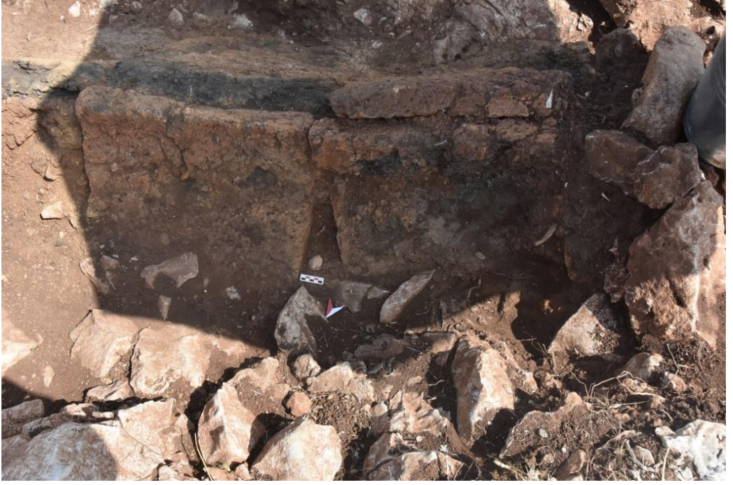
Resim 47: Çökme Nedeniyle Oluşan Açıklıklar.
