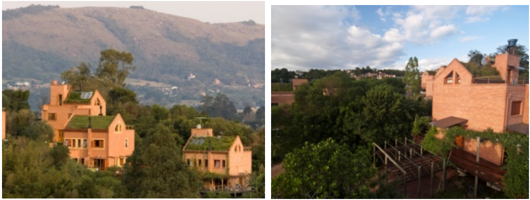
Şekil 2.16. Condomínio Ecoovilla yerel malzemeler ile yapılmış konut cephesi (Anonim 2019y)
