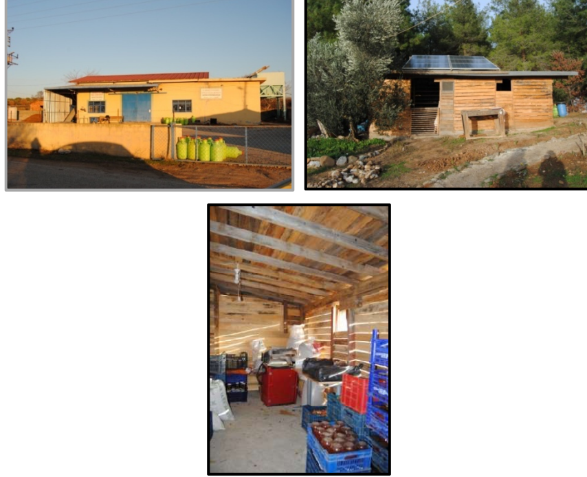
Şekil 4.34. Zeytinli köyündeki zeytinyağı fabrikası ve Zeytinli ekolojik ortak yaşam kurutmalık ve depo alanı (Bartu 2019-2020 arşivinden alınmıştır)
