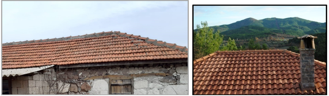
Şekil 4.20. Küçükusun kırma çatı ve Ormanya çatı (Bartu 2019-2020 arşivinden alınmıştır)
