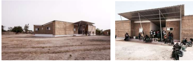
Şekil 2.18. Mbam yerel malzeme ile inşa edilen konut cephesi (Oliver 2014)
