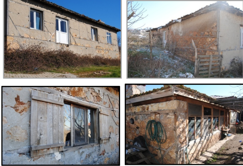
Şekil 4.38. Muratlar konut yapısı taş yığma konut yapısı ve Bayramiç/Yeniköy taş yığma mutfak yapısı (Bartu 2019-2020 arşivinden alınmıştır)
