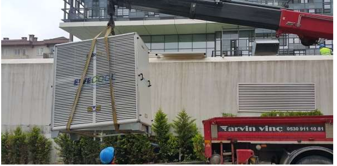
Şekil 3.23. Dış Ünite Montajı
