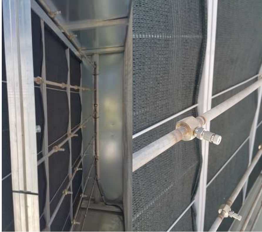
Şekil 3.22. 0,2 mm Çapındaki Nozullar
