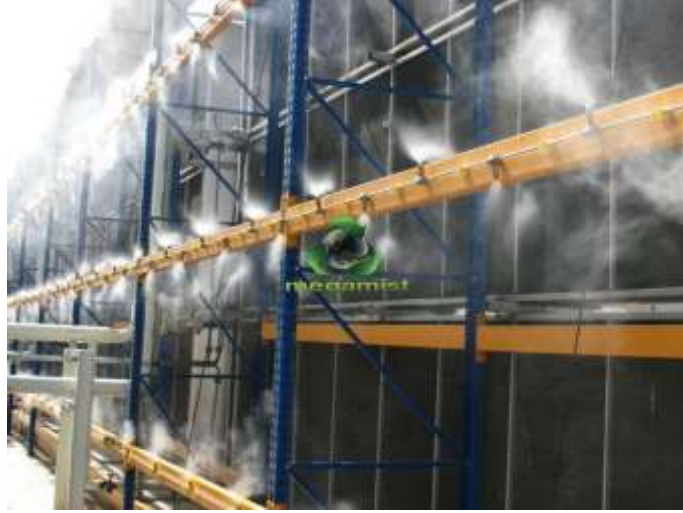
Şekil 3.7. Doğrudan püskürtme ile evaporatif soğutma
