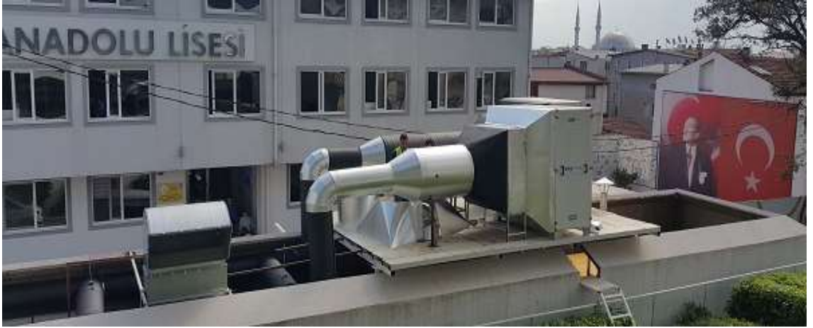
Şekil 3.26. Kanal İzolasyon Çalışması
