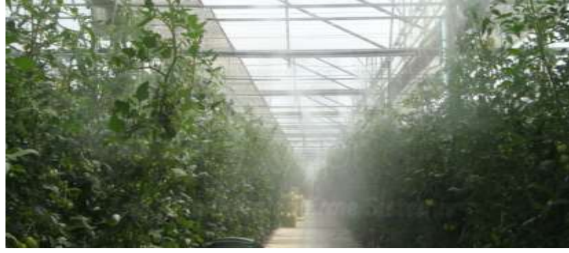
Şekil 3.5. Evaporatif soğutma ile sera soğutması
