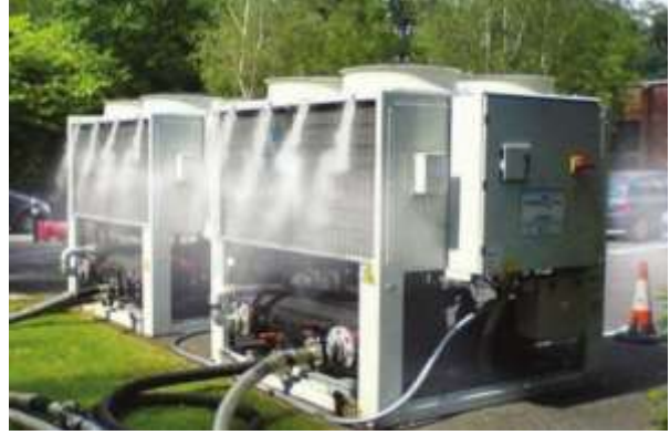
Şekil 3.16. Su Püskürtme (Nozzle) ile Evaporatif Soğutma Sistemi
