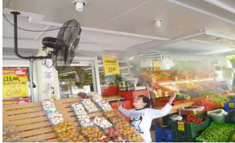
Şekil 3.6. Evaporatif soğutma ile gıda soğutması
