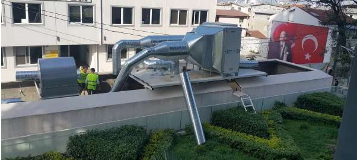
Şekil 3.24. Kanal Montajı
