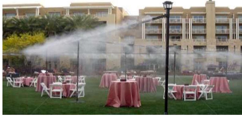
Şekil 3.4. Evaporatif soğutma ile açık alan soğutması
