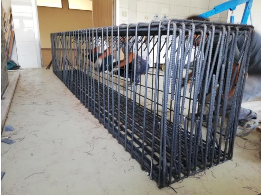
Şekil 3.4. Güçlü kirişin donatı detayı
