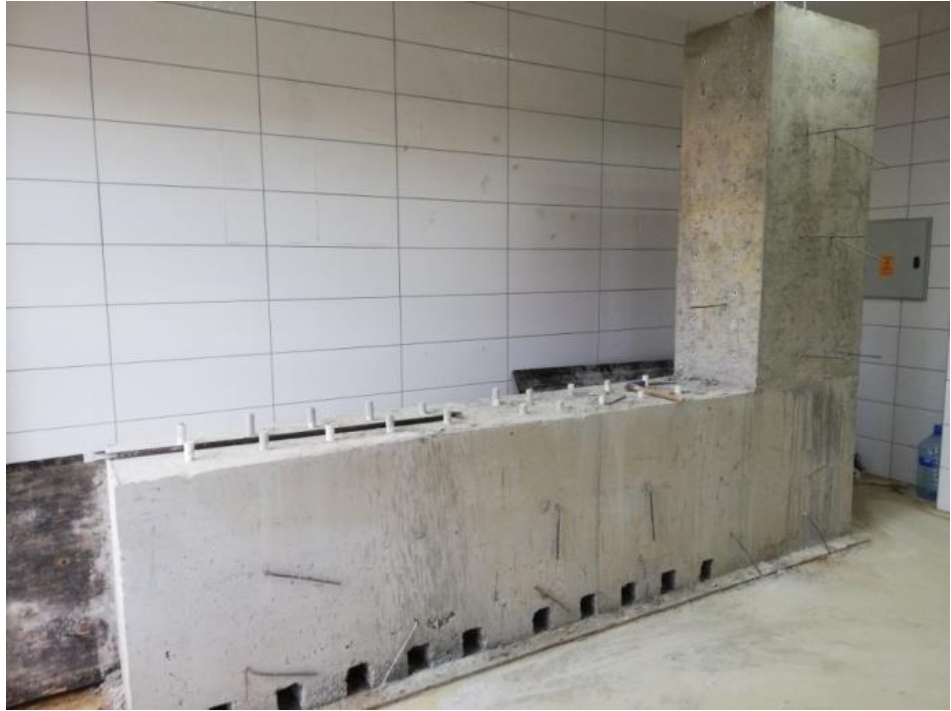
Şekil 3.10. Deney Düzeneğinin kurulacağı betonarme yapının son hali
