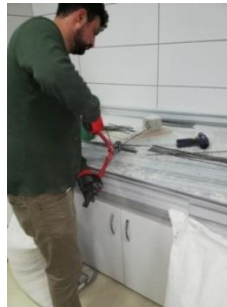
Şekil 3.16. Donatıların demir makası ile kesilmesi
