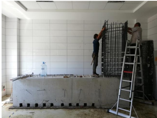
řekil 3.8. Gçl kolon donatı montajı
