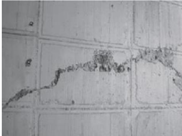
Şekil 1.2. Plansız olarak bırakılan bir soğuk derz (Turan 2019)
