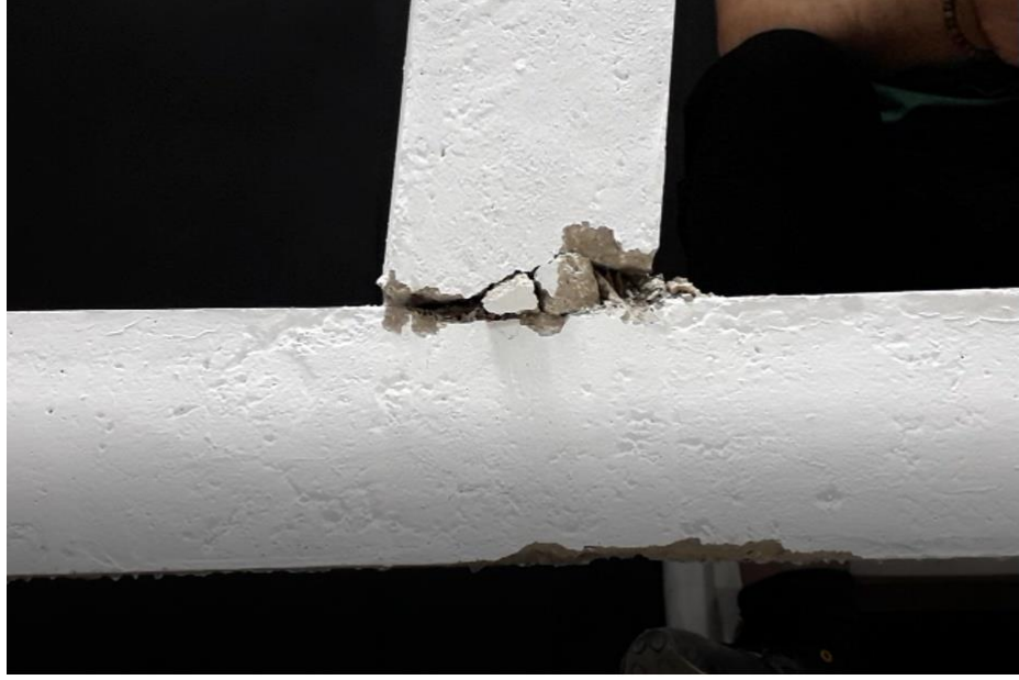
Şekil 4.27. 3 nolu deneyde +90 milimetrelık deplasman sonucunda birleşim bölgesinin hasar durumu
