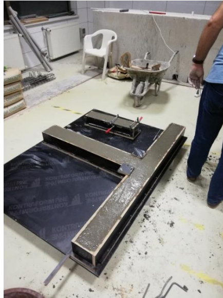
Şekil 3. 20. Üretilen betonun kalıba yerleştirilmesi
