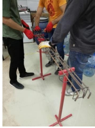
Şekil 3.17. Etriyelerin boyuna donatılara bağlama teli ile montajı
