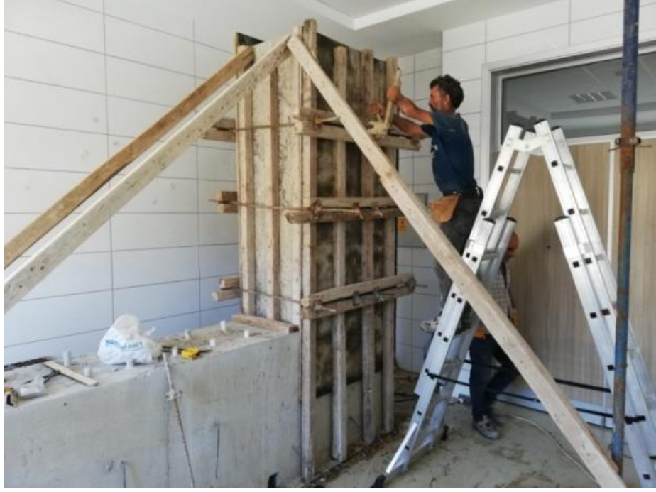
Şekil 3.9. Güçlü kolonun kalıp montajı
