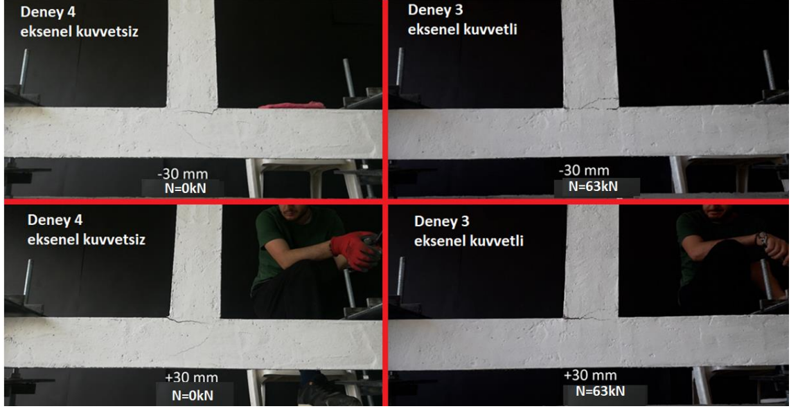
Şekil 4.16. -30/+30 milimetrelik deplasman sonucunda birleşim bölgelerinde oluşan çatlaklar (Deney 3 ve Deney 4)
