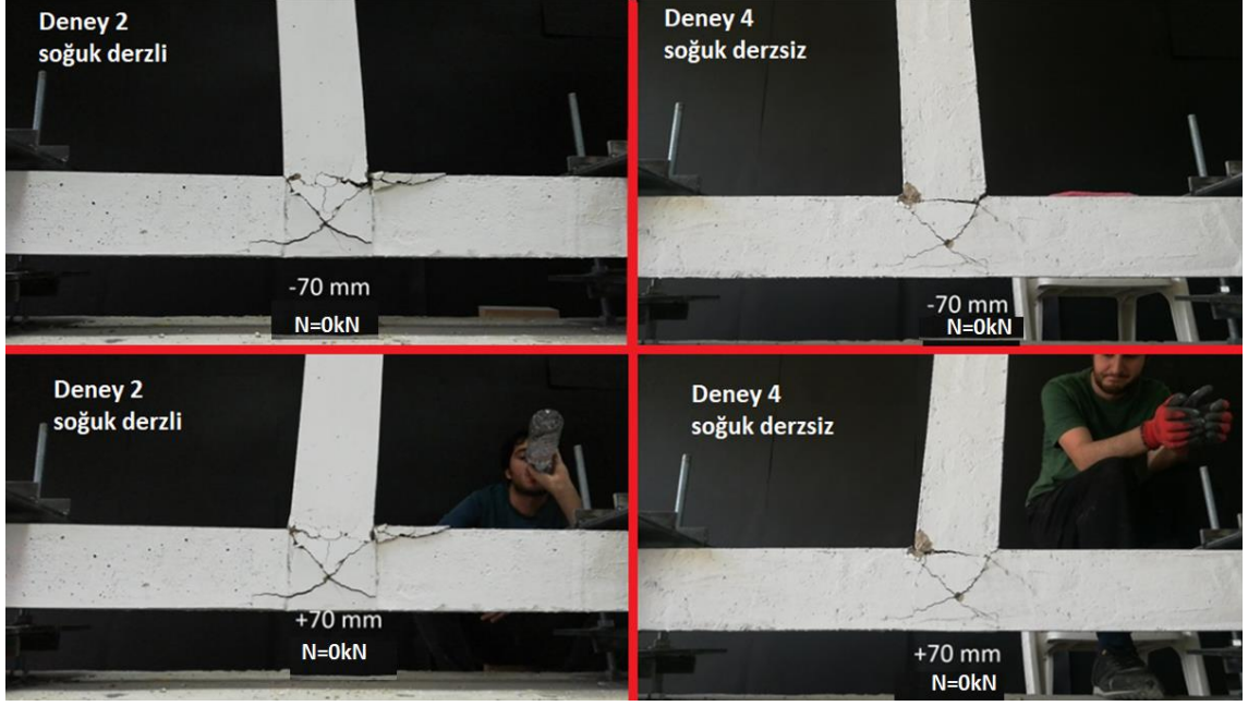
Şekil 4.12. -70/+70 milimetrelık deplasman sonucunda birleşim bölgelerinde oluşan çatlaklar (Deney 2 ve Deney 4)
