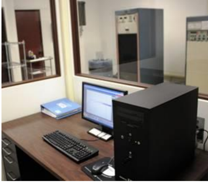
Şekil 2.11. Örnek bir sarsıcı sistemi kontrolcü odası
