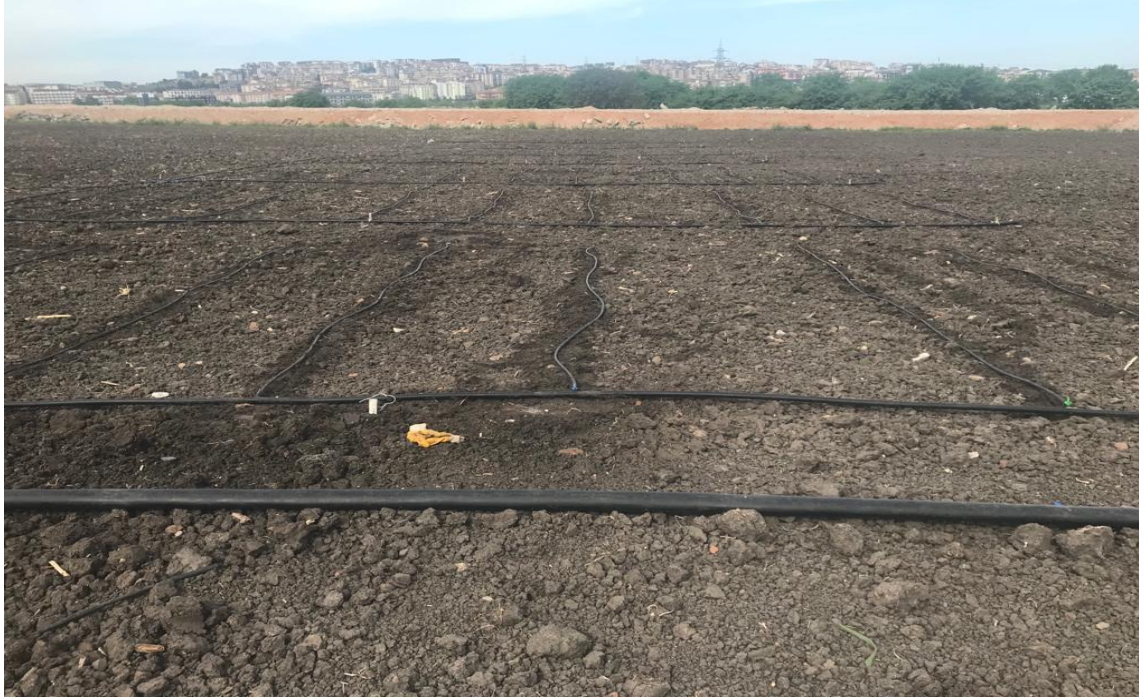
Şekil 3.2. Damla sulama sisteminin kurulumu
