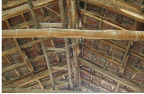
Şekil 2.33. Ahşap iskelet sistem çatı örneği (Perker 2012)
