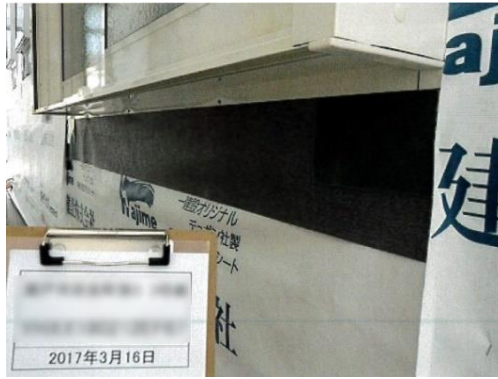
Şekil 3.54. Japonya örneği, pencere yalıtım uygulaması (Anonim 2017)
