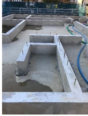
Şekil 3.37. Tamamlanmış temel uygulaması (Anonim 2019o)
