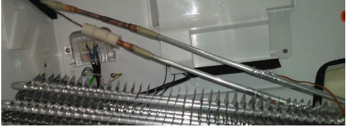
Şekil 3.35. Isıl çiftin buharlaştırıcı çıkışı bağlantısı
