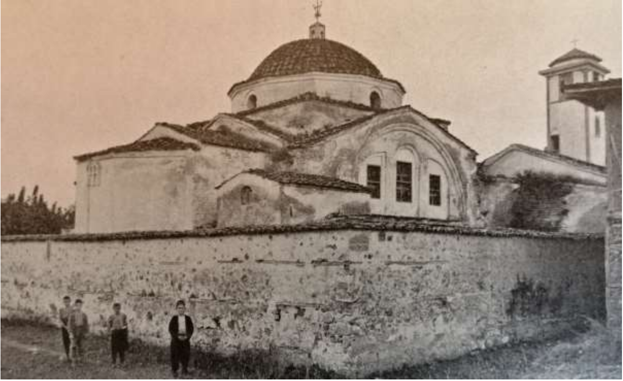
Resim 1: Kuzeydoğudan görünüm, çevre duvarları ve çan kulesi (Schmit 1927: Tafel II)
