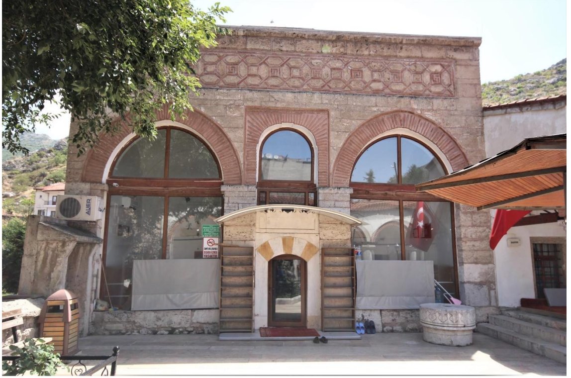
Fotoğraf 202: Şamlar Camii Kuzey Cephesi
