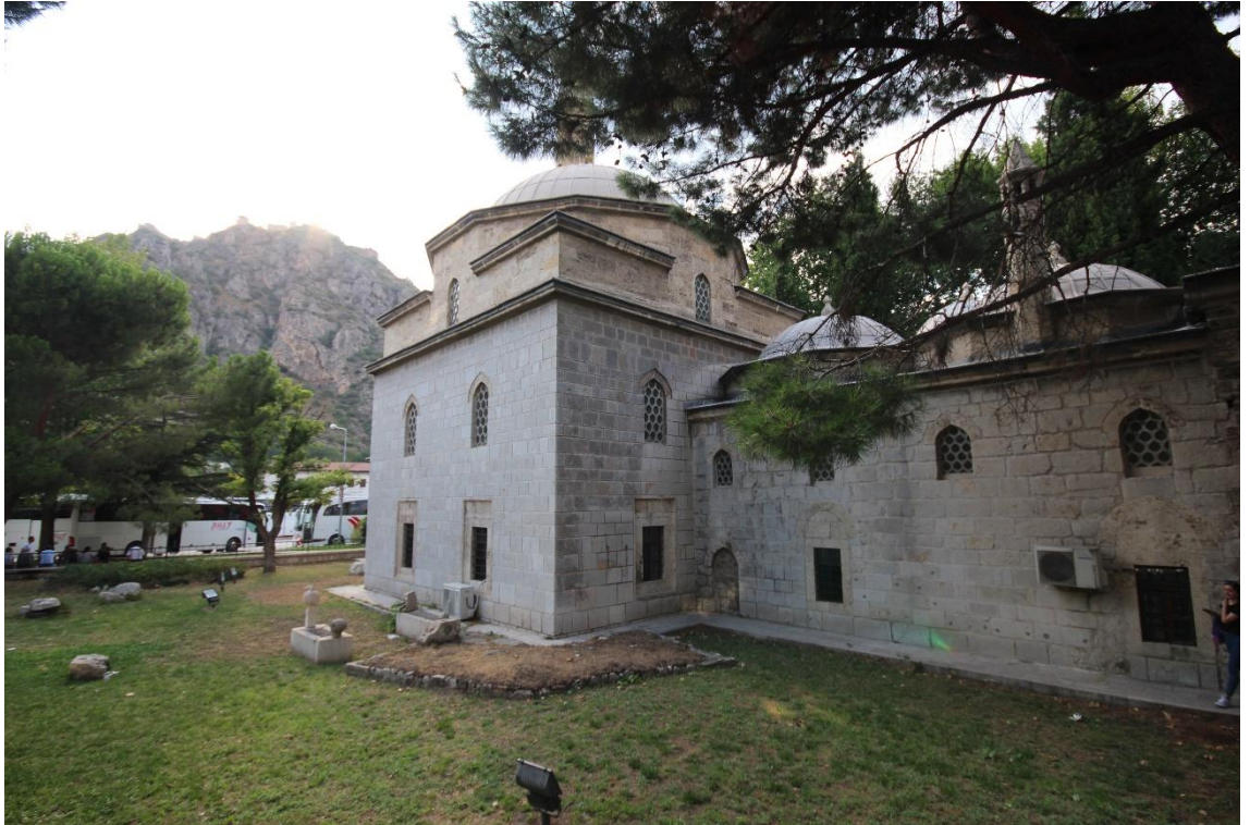
Fotoğraf 151: Mehmed Paşa Camii Doğu Cephesi
