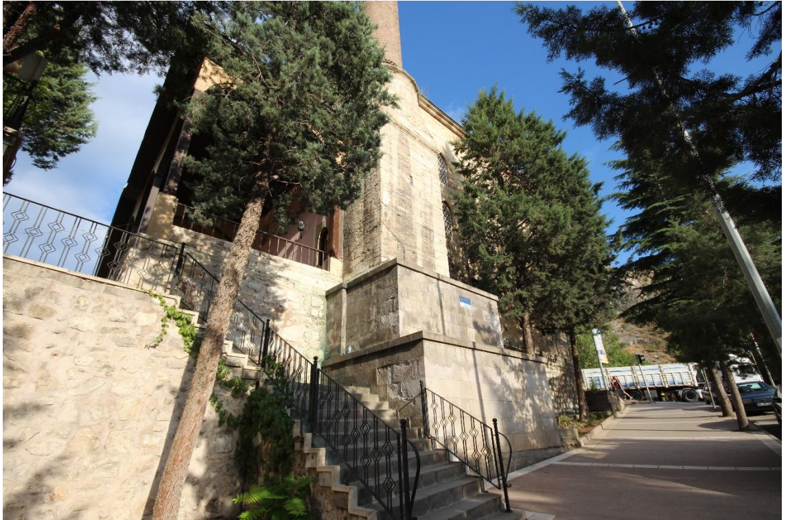
Fotoğraf 41: Gümüşlü Camii'nin Batı Cephesi Görünümü ve Minare Kaidesi
