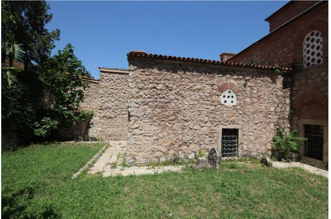
Fotoğraf 197: Şamlar Camii Batısındaki Medrese Odaları
