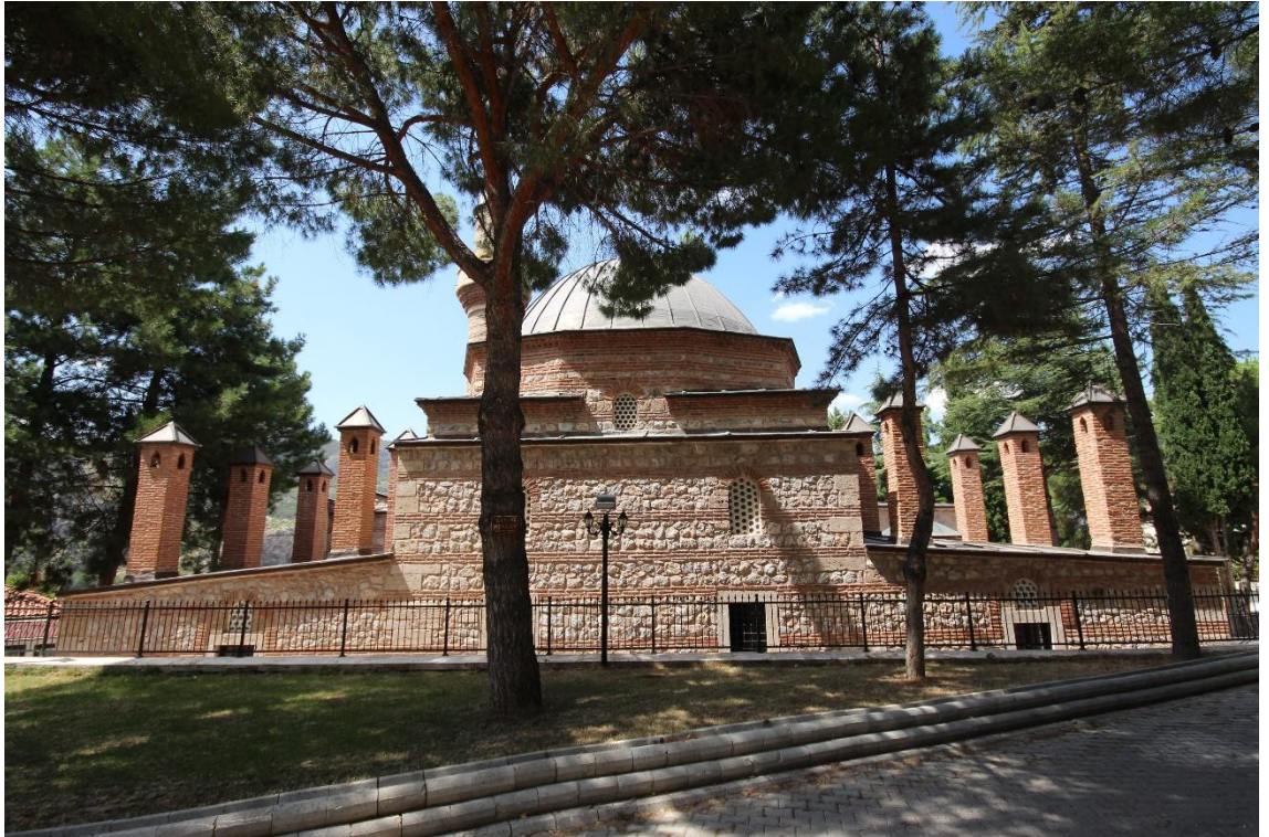
Fotoğraf 51: Çilehane Tekkesi Güney Cephesi
