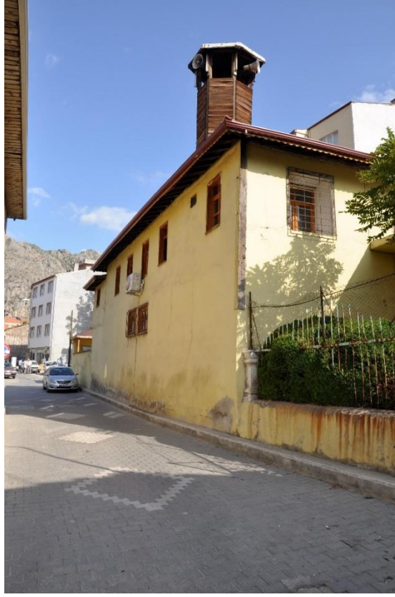
Fotoğraf 226: Üçler Camii Kuzey Cephesi
