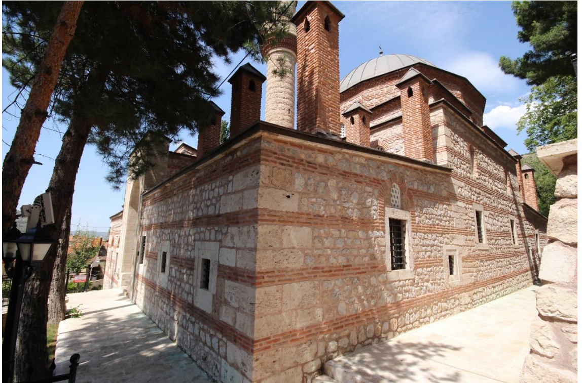
Fotoğraf 53: Çilehane Tekkesi Güney ve Batı Cephesi Görünümü
