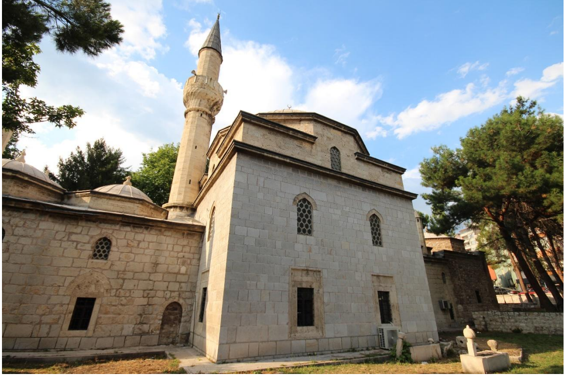
Fotoğraf 152: Mehmed Paşa Camii Doğu Cephesi
