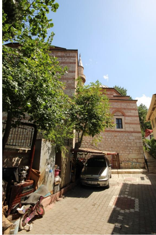
Fotoğraf 57: Çilehane Tekkesi Batı Cephesi ve Dışa Taşkın Sofasının Kuzeyden Görünümü
