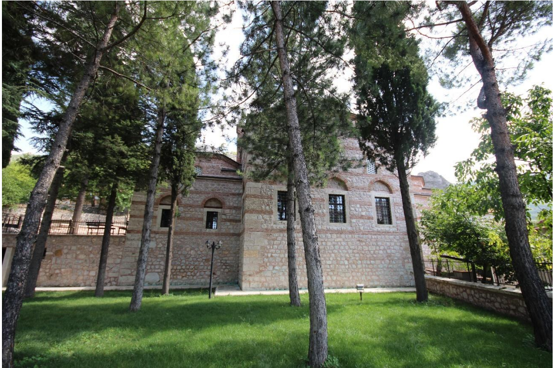
Fotoğraf 59: Çilehane Tekkesi Kuzey Cephesi
