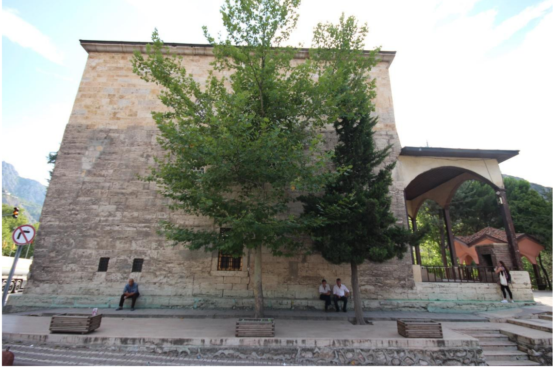
Fotoğraf 36: Gümüşlü Camii'nin Doğu Cephesinden Görünümü
