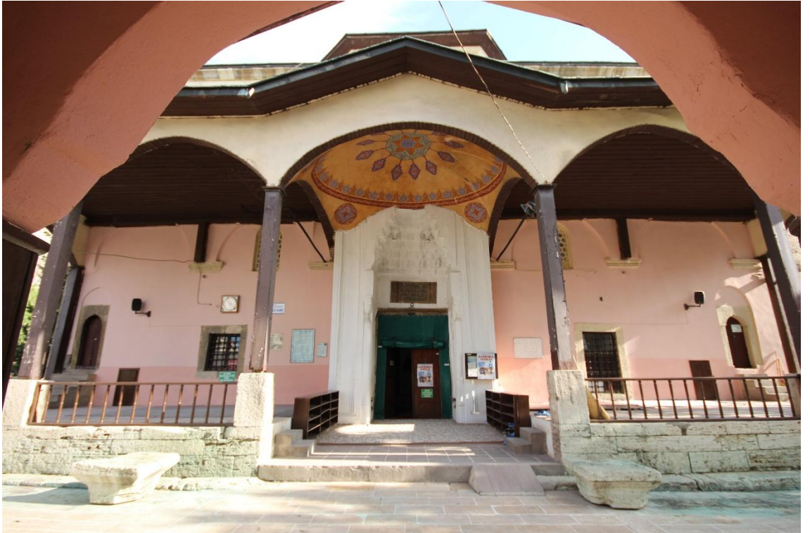
Fotoğraf 39: Gümüşlü Camii'nin Kuzey Cephesinden Görünümü
