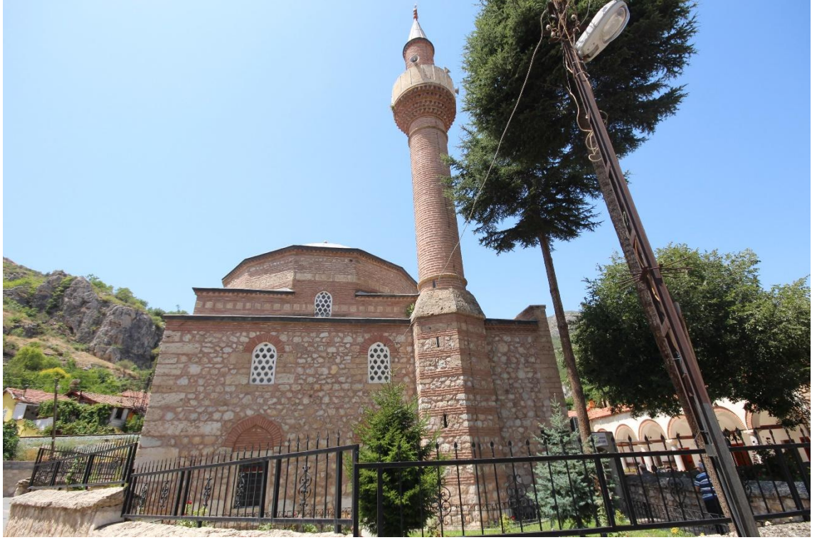
Fotoğraf 198: Şamlar Camii Doğu Cephesi
