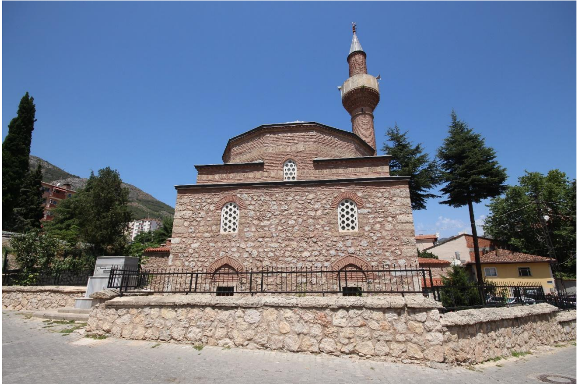
Fotoğraf 195: Şamlar Camii Güney Cephesi
