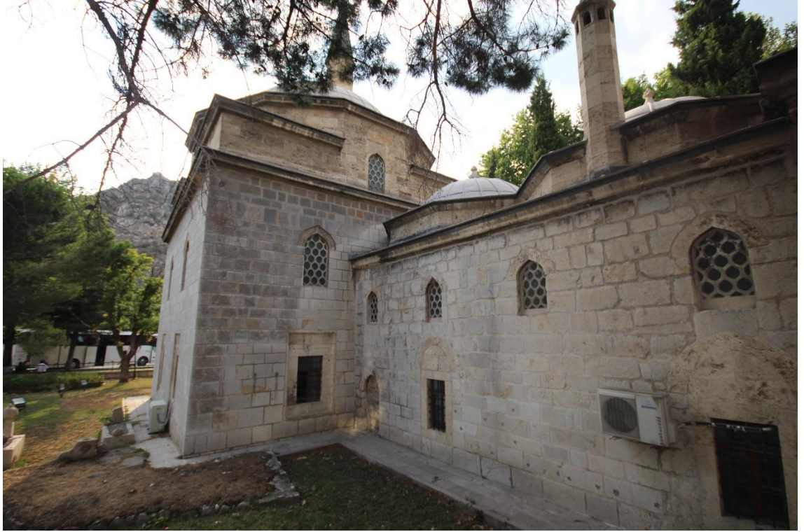
Fotoğraf 150: Mehmed Paşa Camii Doğu Cephesi
