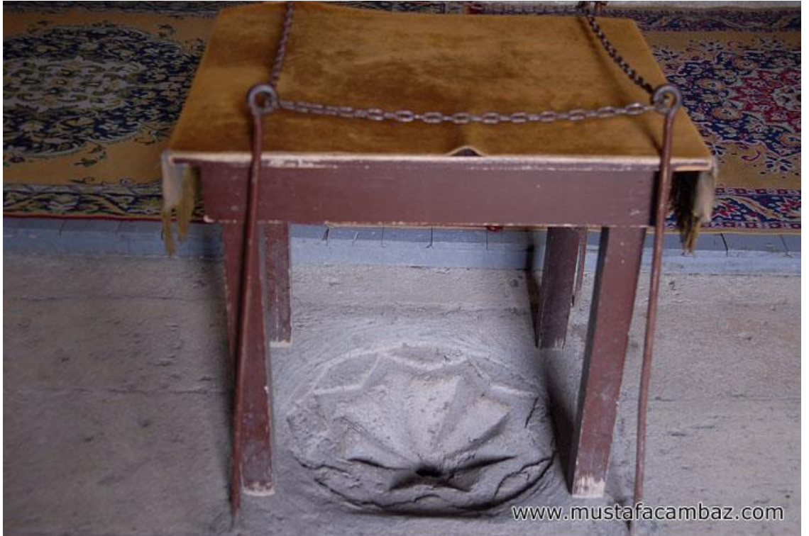
Fotoğraf 30: Torumtay Cami'nin Aydınlık Fenerli Kubbesinin Altındaki Tahliye Gideri
