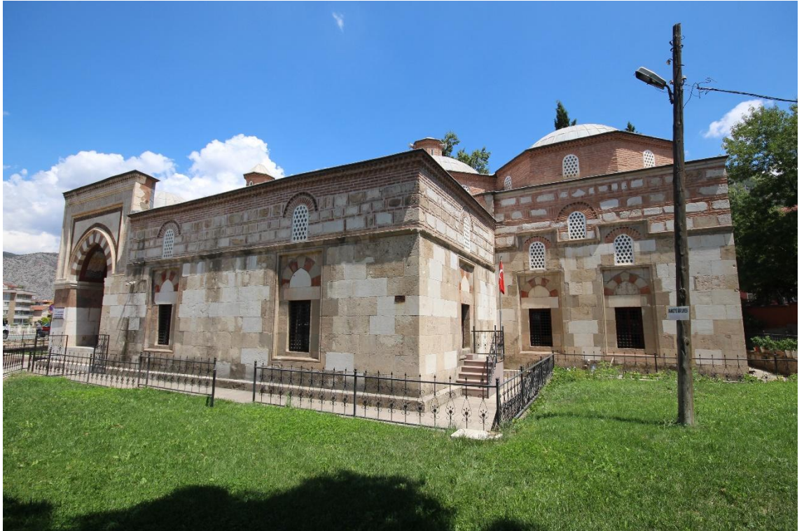
Fotoğraf 99: Bayezid Paşa İmaretî Batı Cephesi ve Tabhane Girişi
