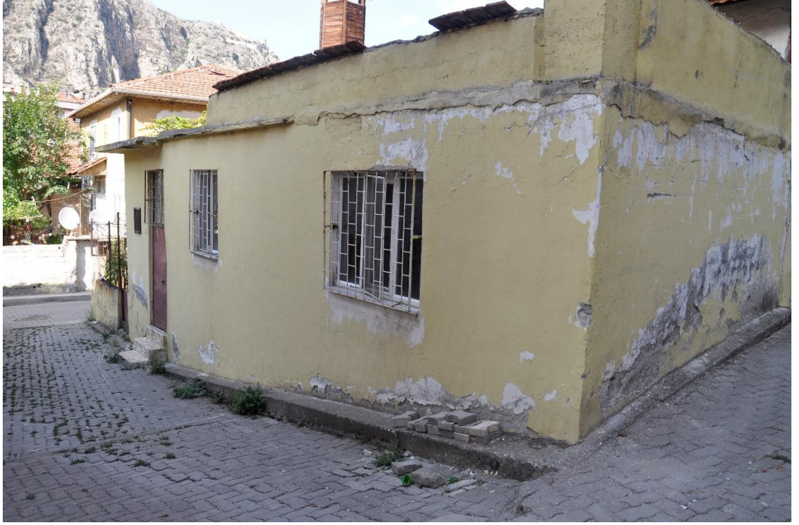
Fotoğraf 224: Üçler Camii Batı Cephesi
