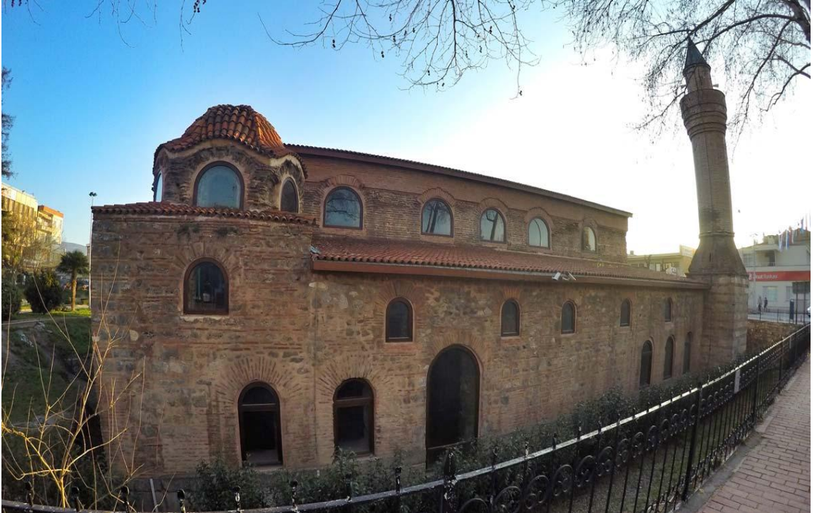
Resim 18: İznik Ayasofya Kilisesi kuzey cephesinin kuzeydoğudan görünümü, 2019.
