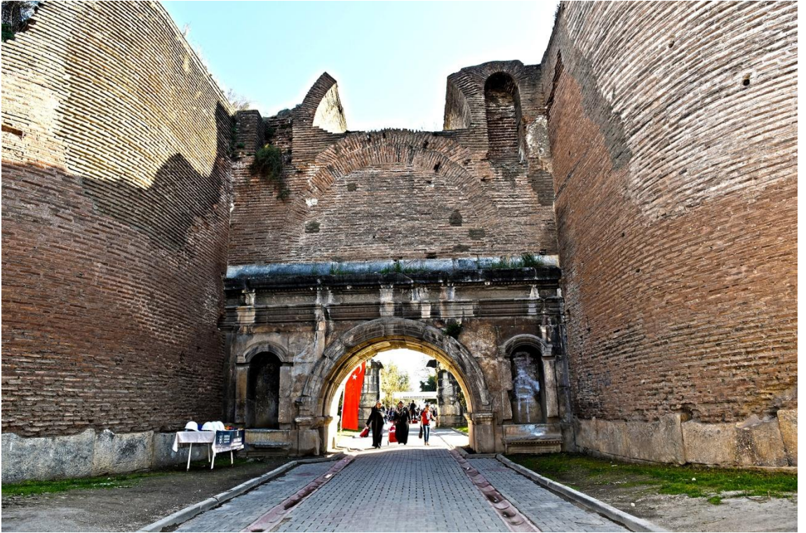
Resim 8: İstanbul Kapı'nın sur dışından görünümü.
