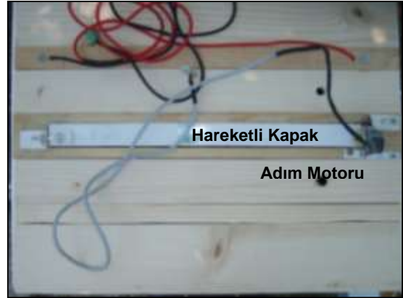
Şekil 5. Havalandırma çerçevesinin görünümü.
