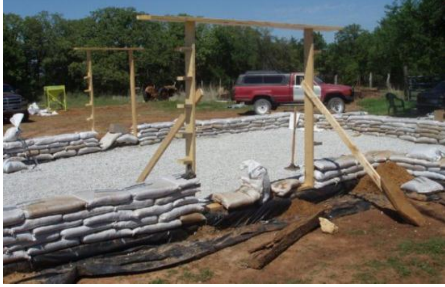
Şekil 2.30. Toprak dolu çuvallardan depreme dayanıklı yapım ( http://www.linklup.com/toprak-cuval-depreme-dayanikli-evler.htm/3 , 2014)
