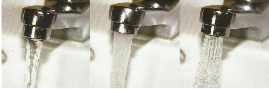
Şekil 2.26. Düzenlenmiş musluk akışı örnekleri; 6lt/sn yoğun akış, 6lt/sn havayla karıştırılmış akış, 1,7lt/sn püsküren akış (Roaf 2013).
