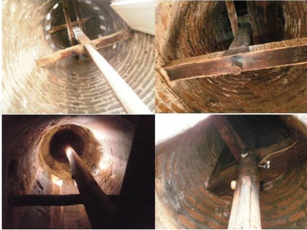
Şekil 1.13. Petek içi ahşap bağlantı elemanları (Baştürk 2013)
