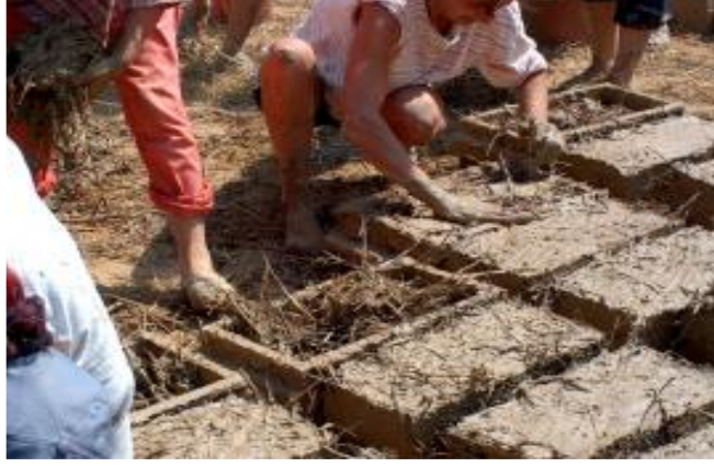
Şekil 1.19. El ile yapılıp güneşte bekletilen tuğla imalatı (Özen 2006)
