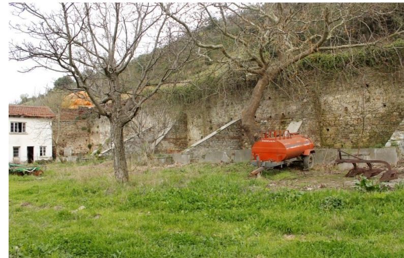
8) 2256 ADA 15 PARSEL'DE BULUNAN BAHÇE DUVARI / DÖKEK
