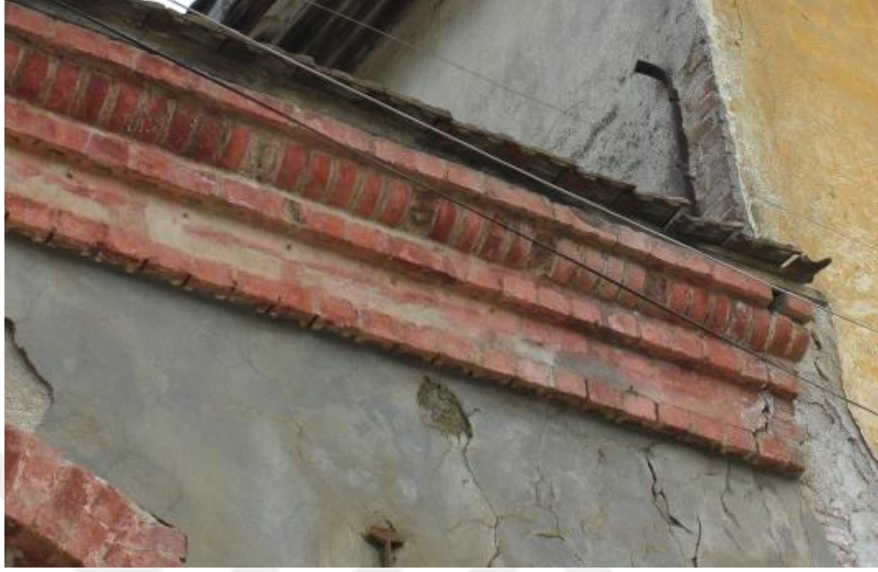
Şekil 6.45. Kuzeybatı cephesi tuğla saçak detayı
