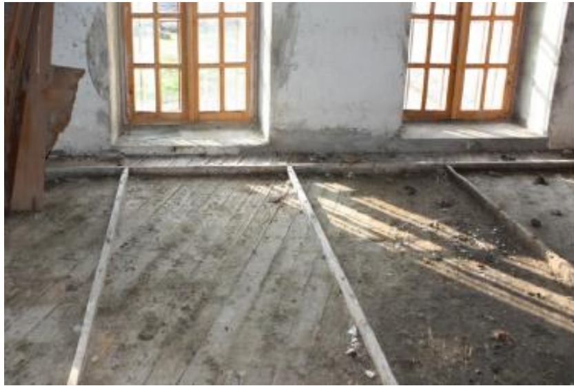
Şekil 4. Sabunhane 1. kat diyagonal ahşap döşeme (Akın 2014)
