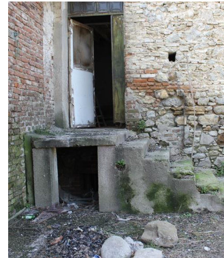
GÜNEYDOĞU ARKA BAHÇE GİRİŞİ
