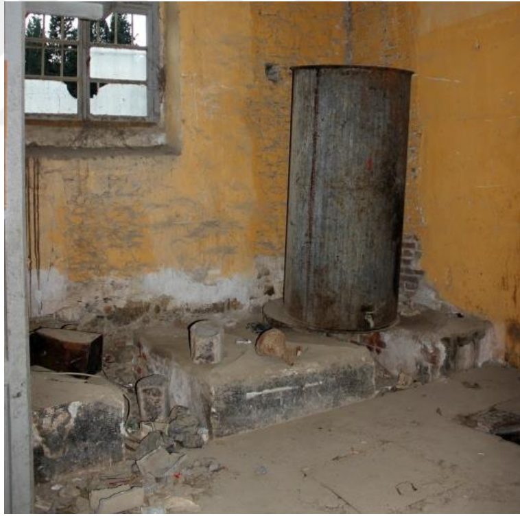
Şekil 6.75. Tuğla kademeler ve önünde zemine gömülü küplerin kapakları
