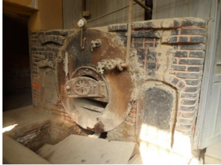
Şekil 6.30. Buhar enerjisi üreten buhar kazanı
