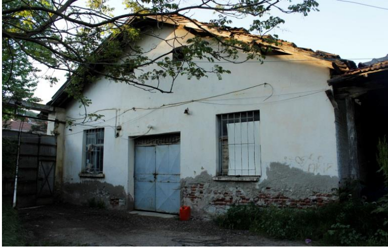
1) 2257 ADA 7 PARSEL'DE BULUNAN KOMŞU BİNA
