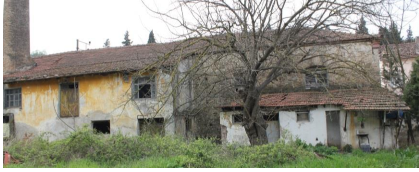
Şekil 6.49. Güneydoğu cephesi – müştemilatlar
