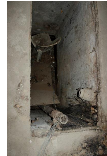
9) Z01 YAĞHANE ZEMİNİNDEKİ SARNIÇ
