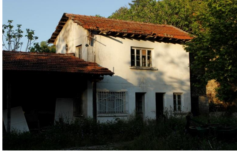
2) 2256 ADA 14 PARSEL'DE BULUNAN KOMŞU BİNA
