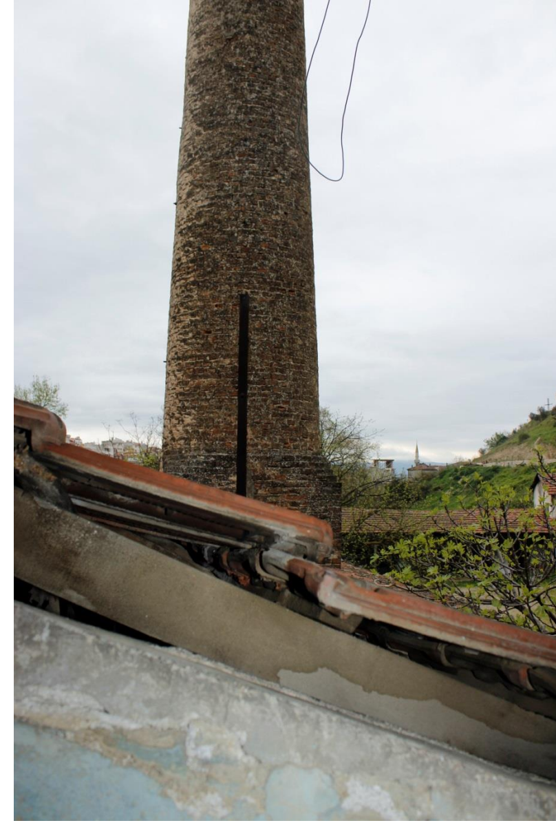
TUĞLA BACADA DEMİR BAĞLANTI DETAYI
