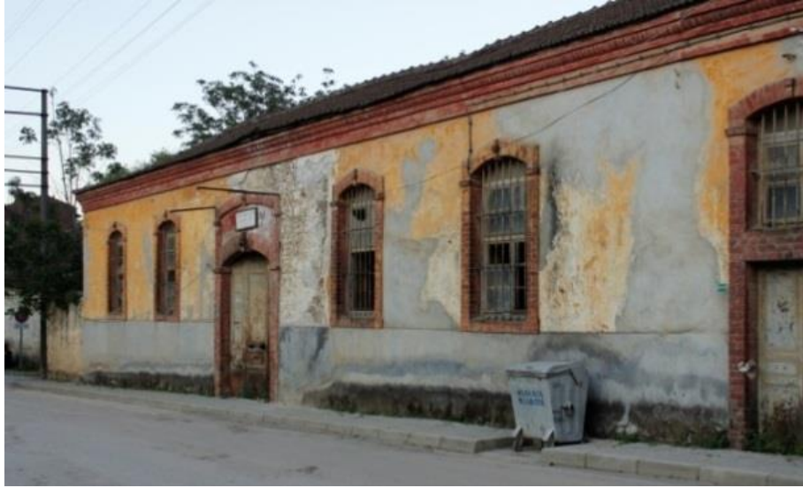
Şekil 6.43. Kuzeybatı cephesi – 1.bölüm – Z01 Yağhane
