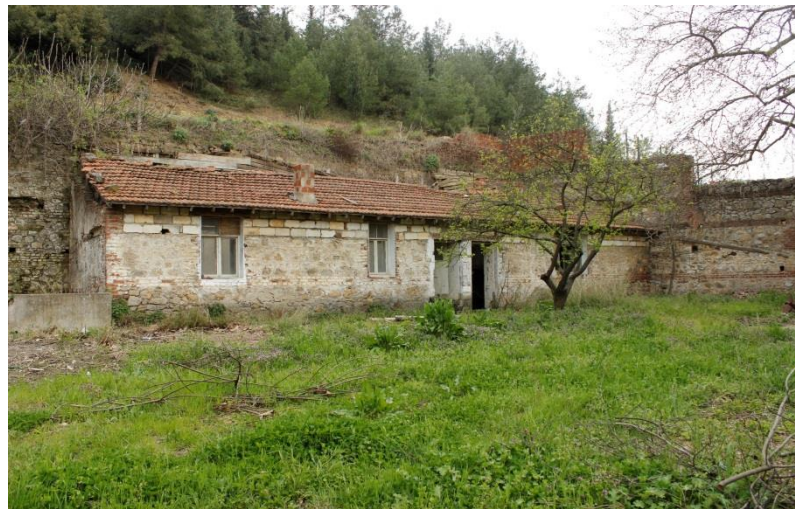
7) 2256 ADA 15 PARSEL'DE BULUNAN İŞÇİ YATAKHANELERİ
