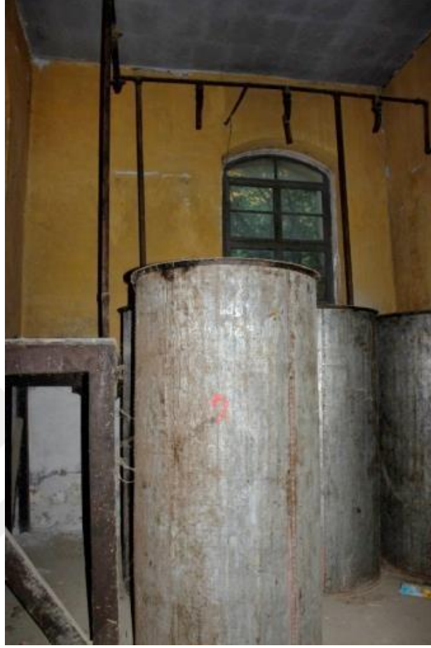
Şekil 6.25. Z02 Filtre odası – filtreden geçen zeytinyağının depolandığı metal tanklar
