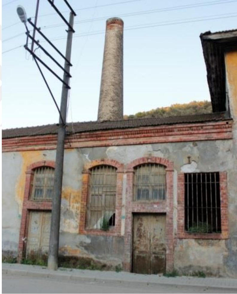
Şekil 6.44. Kuzeybatı cephesi – 2.bölüm - Z04 Buhar kazanı
