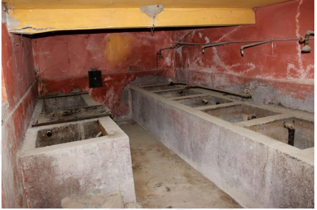
Şekil 6.35. Z08 Zeytinyağı ayırıştırma – beton havuzlar (polima)
