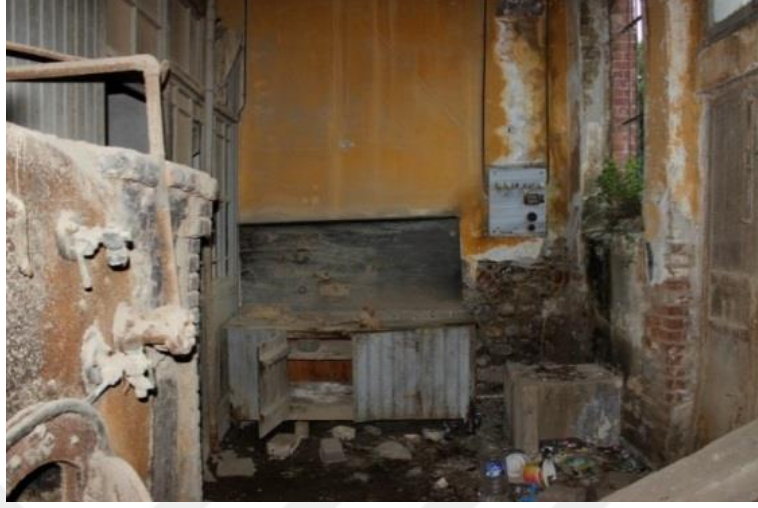
Şekil 6.29. Z04 Buhar kazanı mekanı ve giriş kapısı
