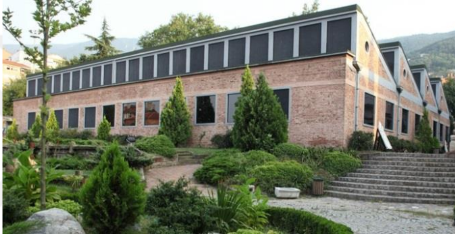
Şekil 3.11. Umurbey Mahallesi'nde İpek Fabrikası
