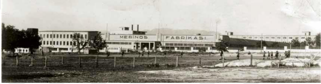
Şekil 2.1. Merinos Fabrikası (Kaplanoğlu ve Balkan 2009)
