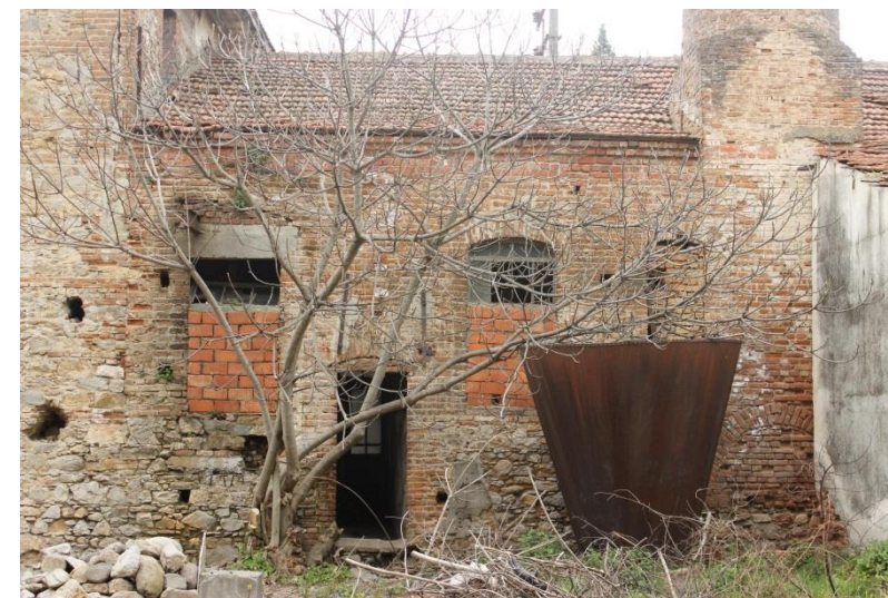
GÜNEYDOĞU CEPHESİ MAKİNE DAİRESİ BAHÇE ÇIKIŞI
