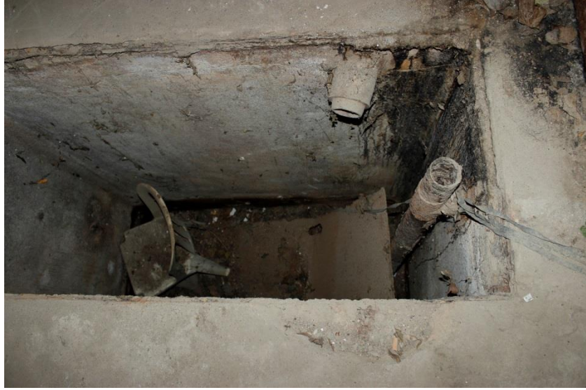
řekil 6.23. Z01 Yađhane zemininde zeytinyađı ayırıtırma sarnıı
