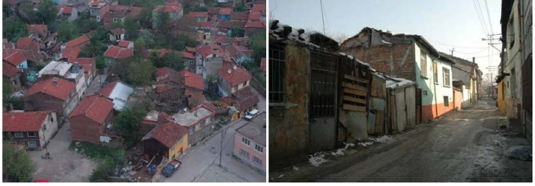
Şekil 4.36 ve Şekil 4.37. Yıkım öncesi güneyden görünüş ve sokak dokusu
