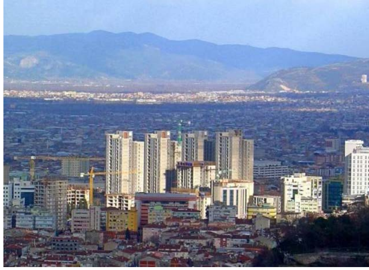
Şekil 4.40. Doğanbey Kentsel Dönüşüm Projesi tamamlandıktan sonraki görünüş
