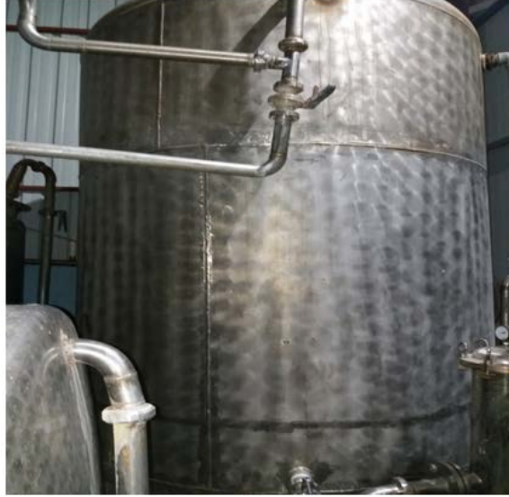
Şekil 4.2. Kum ve granüle aktif karbon tankı
