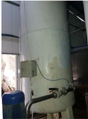
Şekil 4.1. Debi dengeleme ve klorlama tankı
