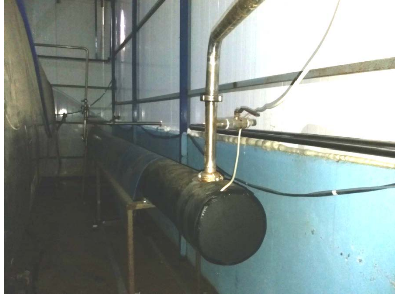
Şekil 4.5. Ters osmoz membran filtrasyon sistemi
