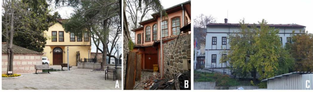
Şekil 3.37. Hisar Bölgesi'ndeki idari yapılar.
