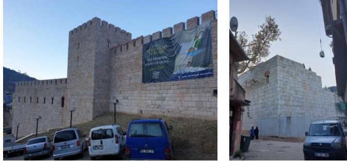
Şekil 3.49. Zindan Kapı Restorasyonu.
