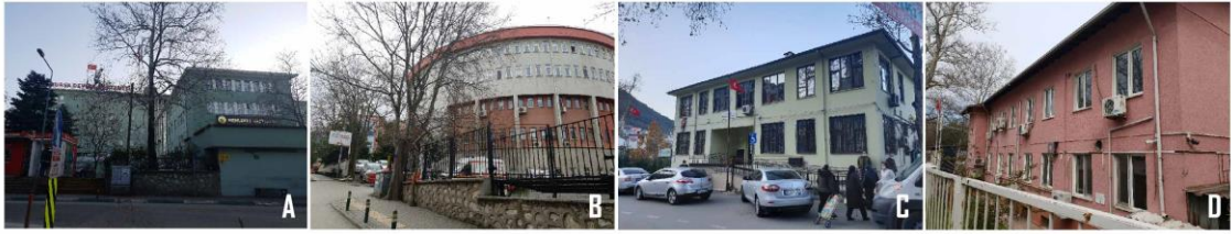
Şekil 3.35. Hisar Bölgesi'ndeki sağlık yapıları.
