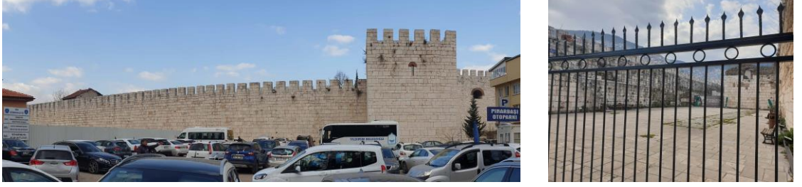
Şekil 3.45. Yer Kapı Surları Restorasyonu.
