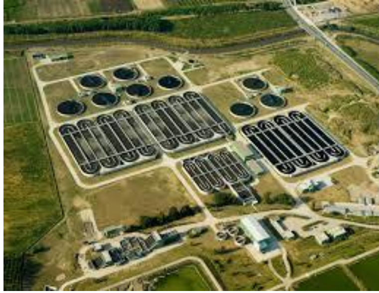
Şekil 3.1. BUSKİ doğu atıksu arıtma tesisi
