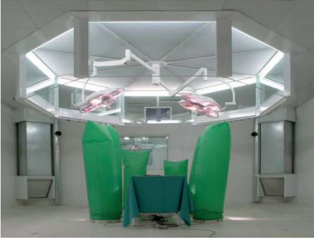
Şekil 3.19 – Laminer akış ünitesi
