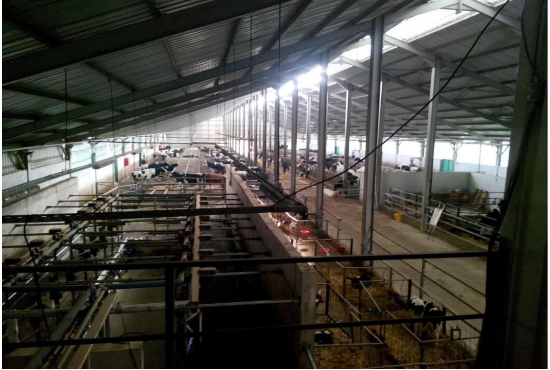
Şekil 3.9. 2. İşletme iç görünüş, sağımhane ve durak yapısı, yem yolu
