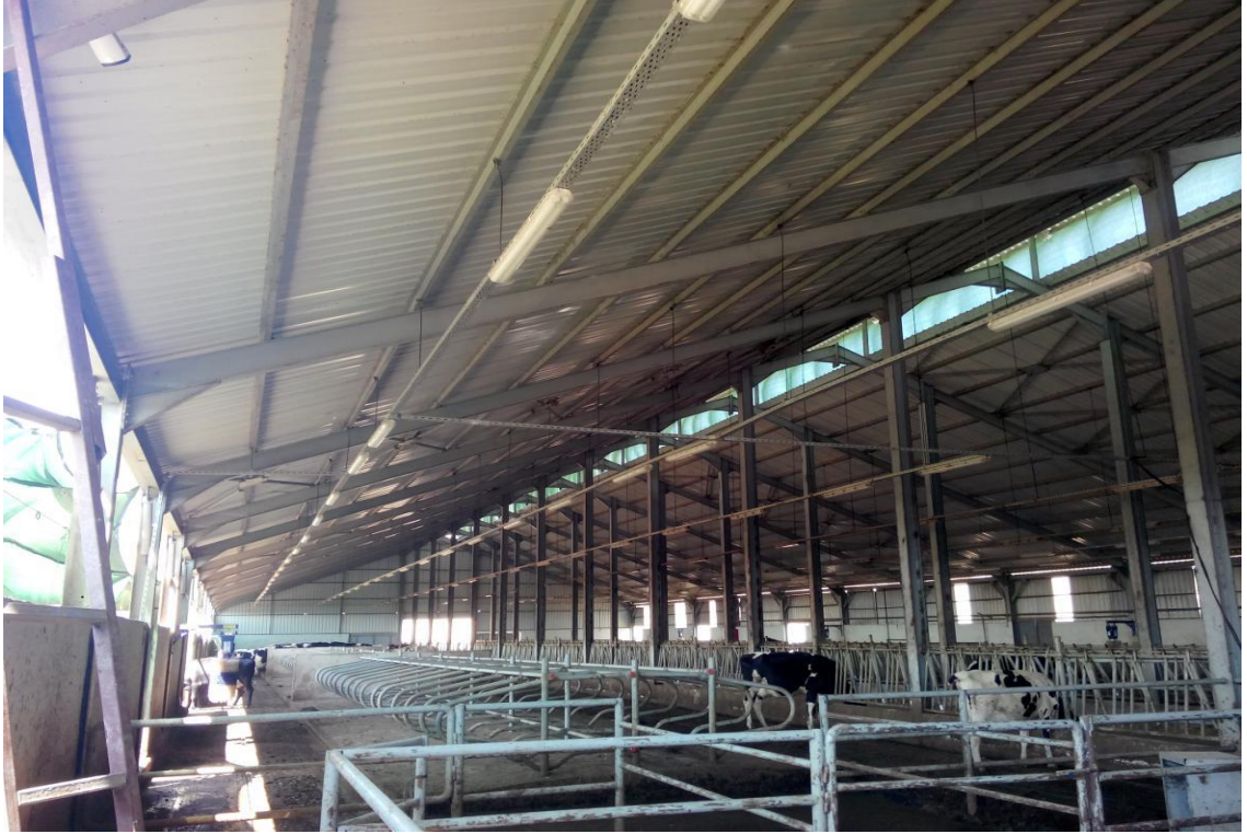
Şekil 3.8. 1. İşletme iç görünüş ve durak yapısı
