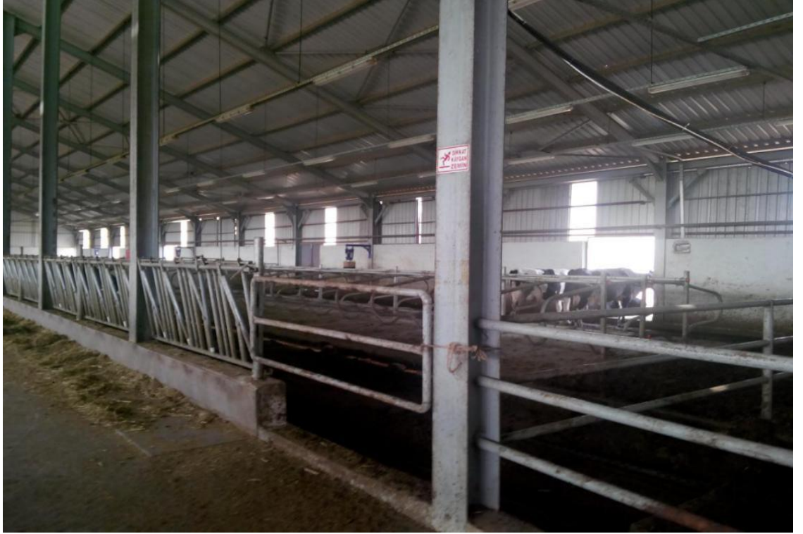
Şekil 3.6. 1. İşletme iç görünüş ve hâkim rüzgâr yönündeki yan duvar kapama şekli
