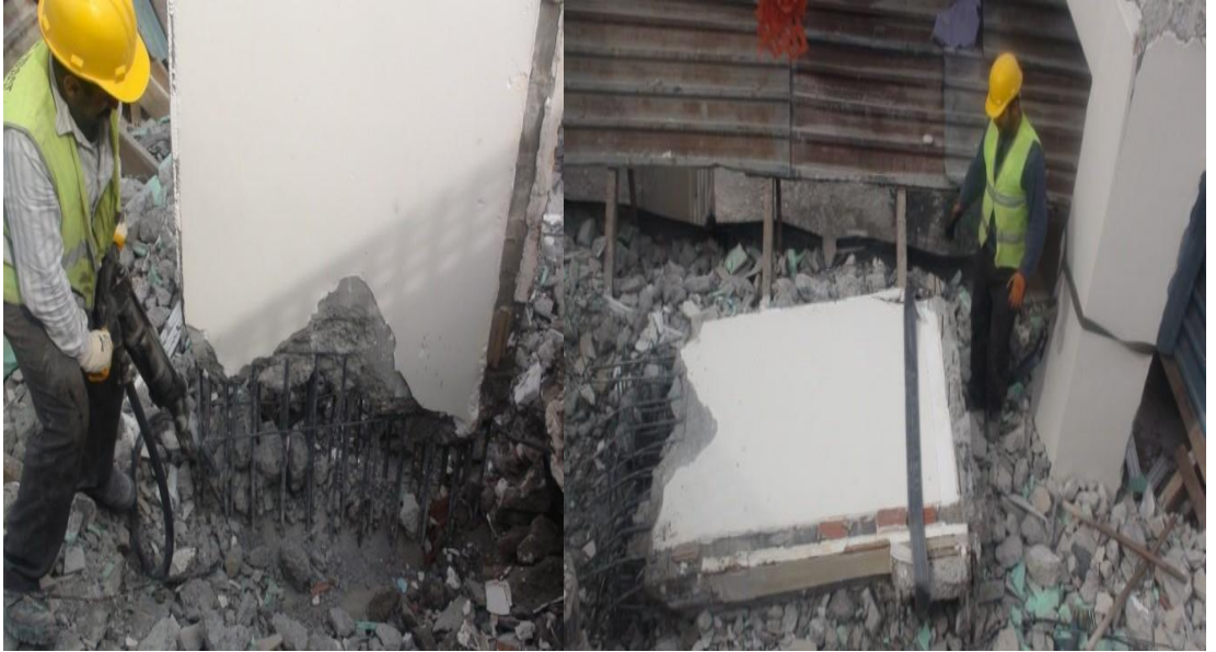
Şekil 3.7. El aletleri ile kolon yıkımı 2 (DEPAR 2017)
