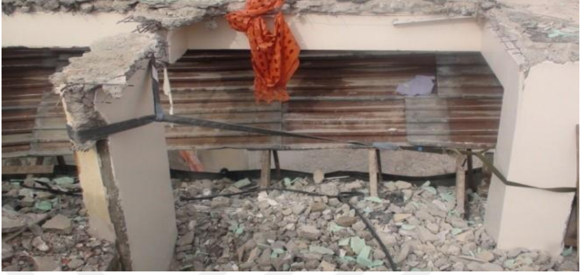
Şekil 3.6. El aletleri ile kolon yıkımı 1 (DEPAR 2017)
