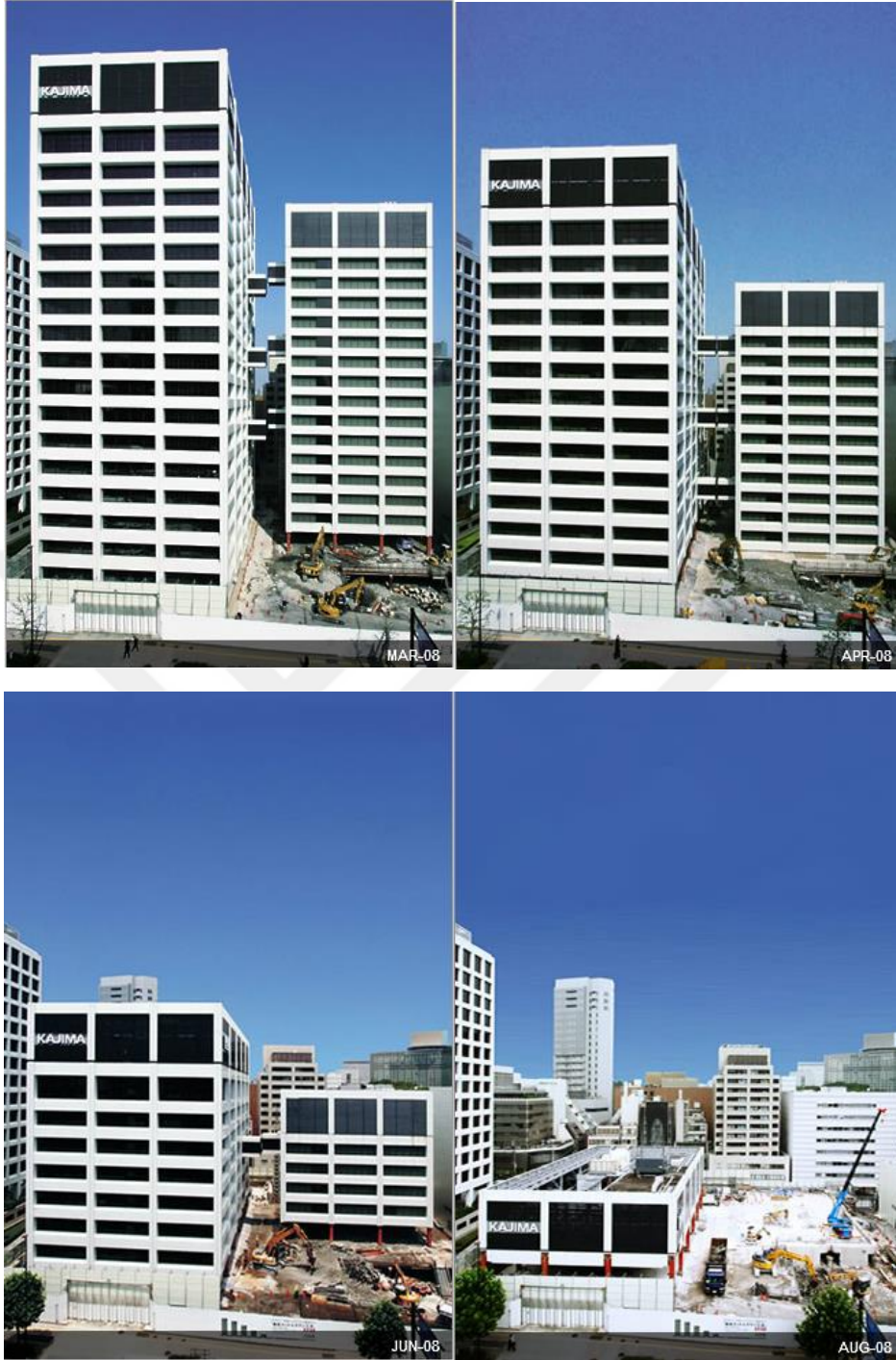
Şekil 3.33. Kajima kesme ve kaldırma yöntemiyle yıkımın uygulanması (Kajima 2017)
