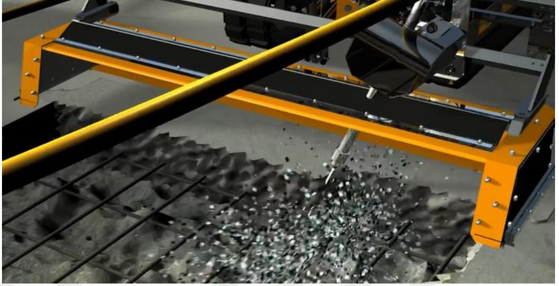
Şekil 3.47. Robot başlığının iç kısmı (Conjet 2019)
