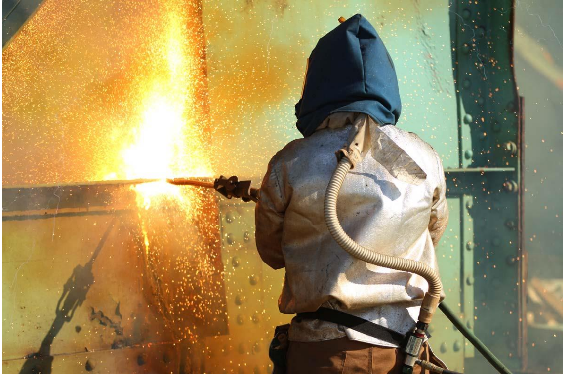
Şekil 3.39. Termik kesici 2 - Güney Portland, ABD (Scrapmetals 2019)
