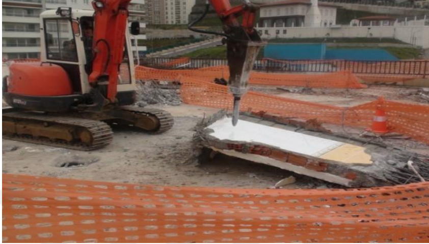
Şekil 3.21. Mini ekskavatör ile kolonun yerde parçalanması (DEPAR 2017)
