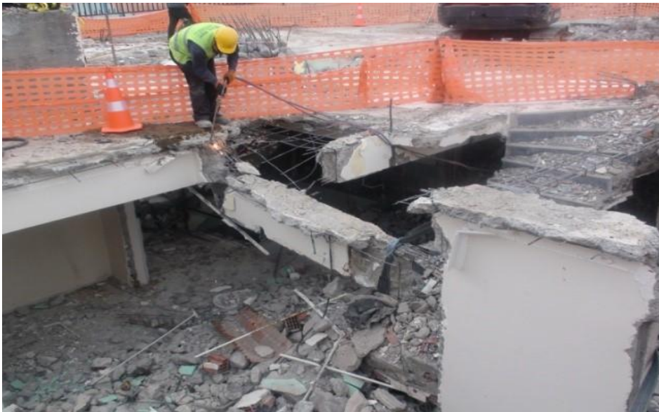
Şekil 3.5. El aletleri ile kiriş yıkımı 2 (DEPAR 2017)
