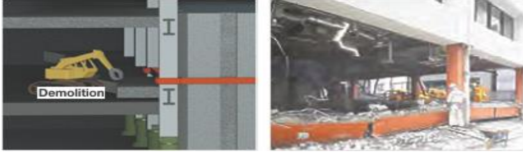
Şekil 3.37. Kajima yöntemi 4. adım (Kajima 2017)
