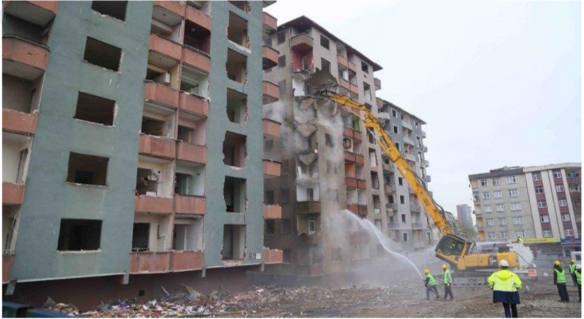
Şekil 4.2. Ayrık nizamlı bloklardan oluşan site. (THY Sitesi, Bağcılar, İstanbul.)
