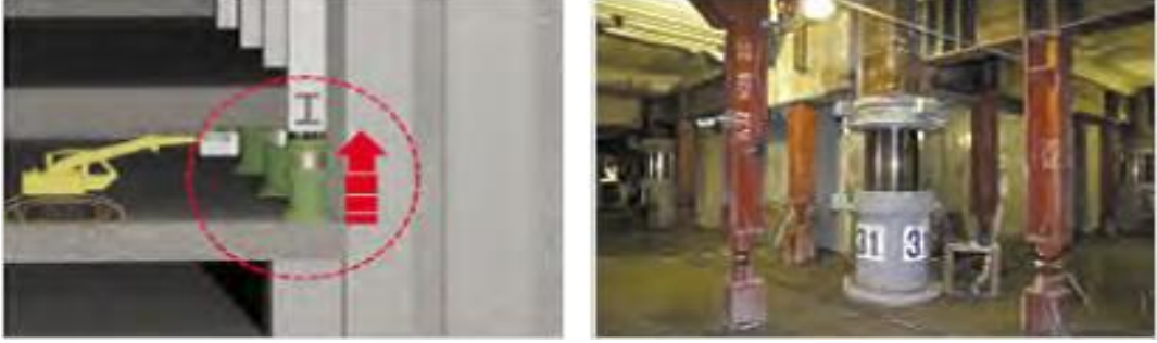
Şekil 3.34. Kajima yöntemi 1. adım (Kajima 2017)
