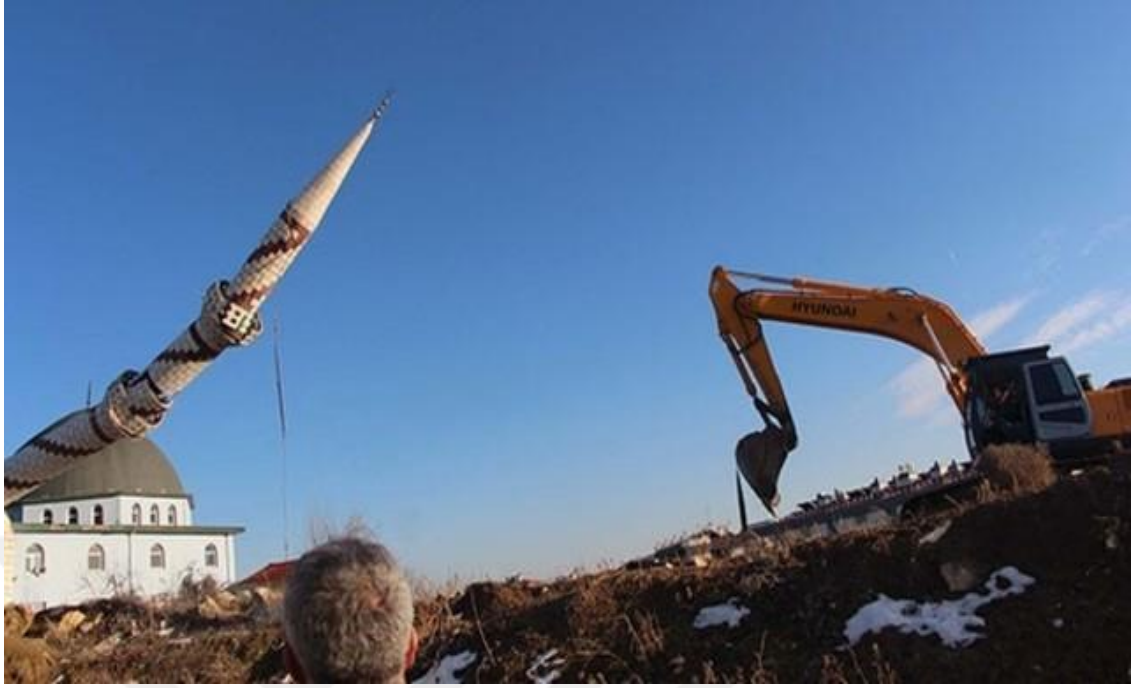
Şekil 3.31. Çelik halat ile çekerek minare yıkımı (Anonim 2019)
