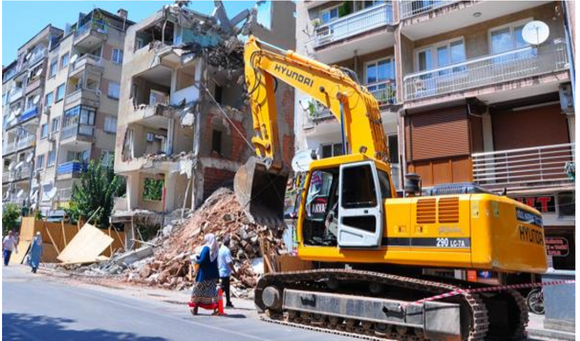
Şekil 3.30. Çelik halat ile bina yıkımı (Anonim 2019)
