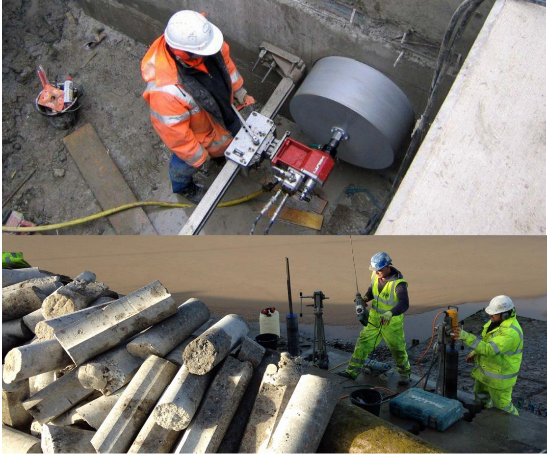
Şekil 3.12. Elmas kesici – Karot alma makinesi (Ram 2017)
