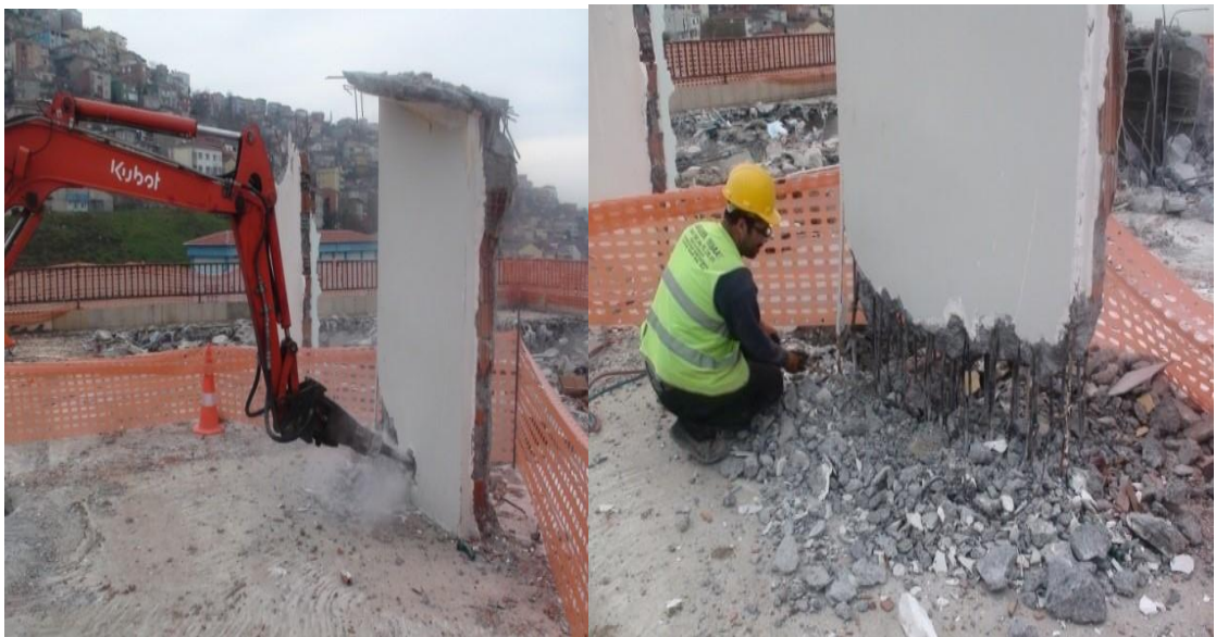
Şekil 3.20. Mini ekskavatör ile kolon yıkımı (DEPAR 2017)
