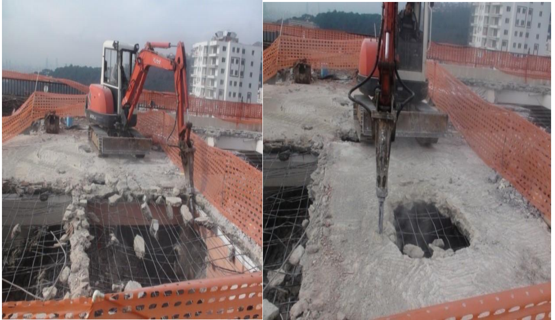
Şekil 3.18. Mini ekskavatör ile döşeme yıkımı (DEPAR 2017)
