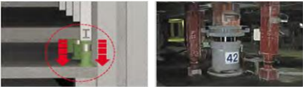
Şekil 3.36. Kajima yöntemi 3. adım (Kajima 2017)
