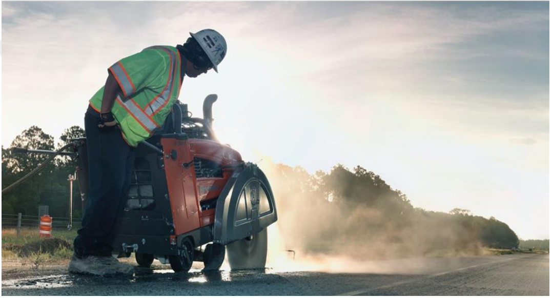
Şekil 3.13. Elmas yol ve zemin kesici (Esisan 2019)
