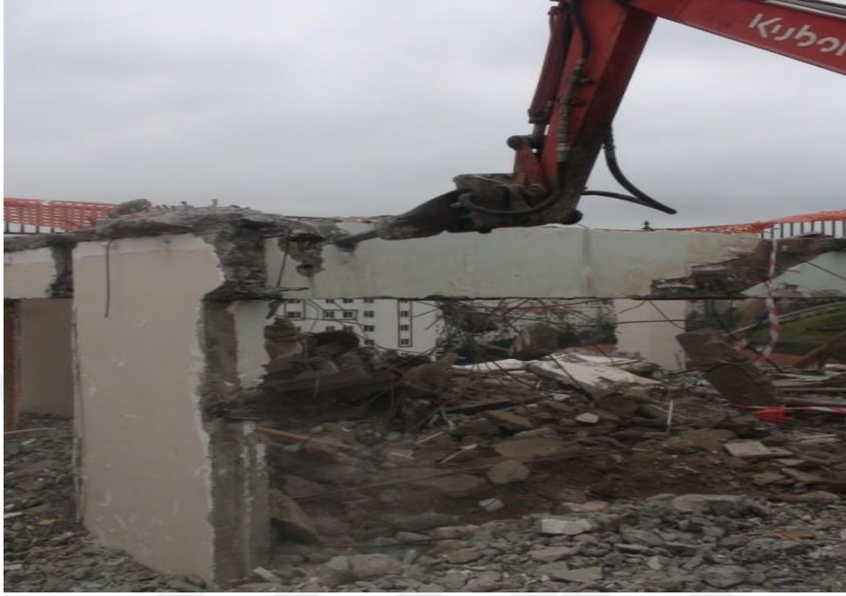
Şekil 3.19. Mini ekskavatör ile kiriş yıkımı (DEPAR 2017)
