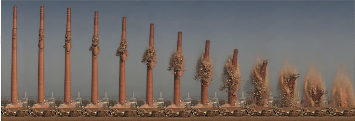
Şekil 3.41. Almanya Frankfurt’ta Henninger Fabrikası bacasının yıkılması (Wikipedia 2019)
