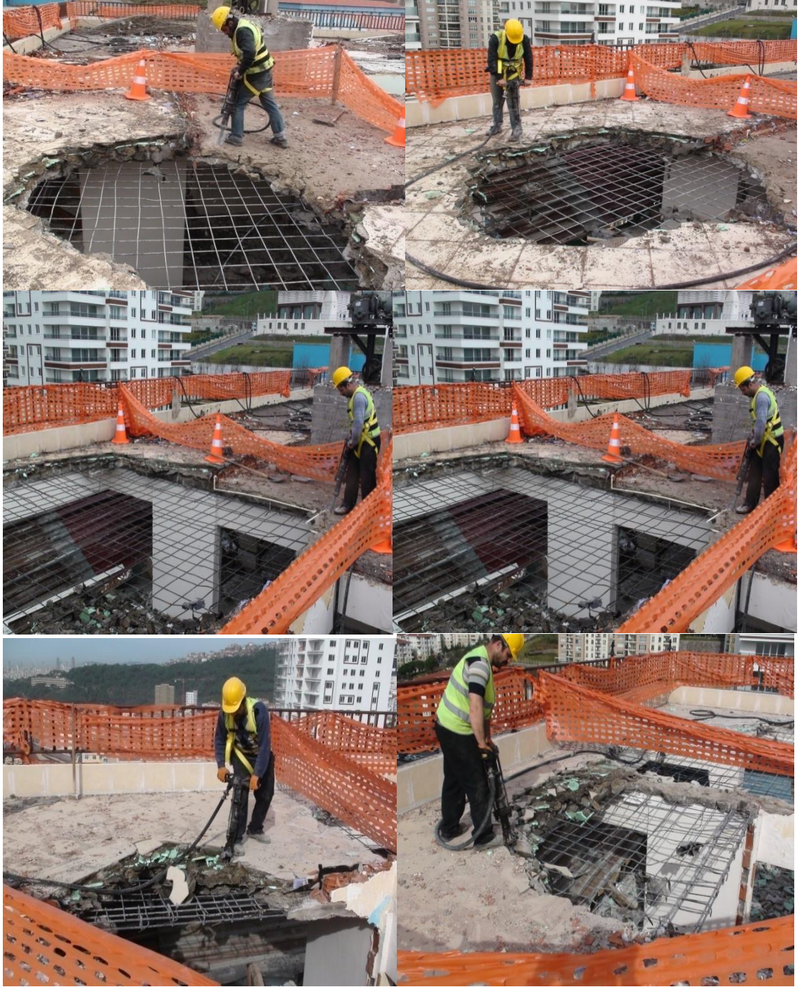
Şekil 3.3. El aletleri ile döşeme yıkımı (DEPAR 2017)
