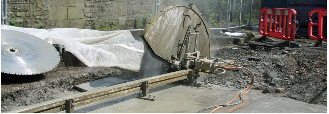
Şekil 3.14. Elmas parça kesici (Ram 2017)
