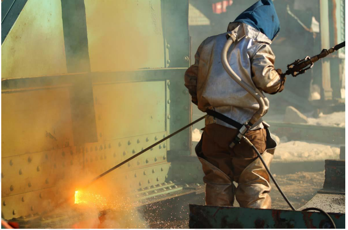
Şekil 3.40. Termik kesici 3 - Güney Portland, ABD (Scrapmetals 2019)
