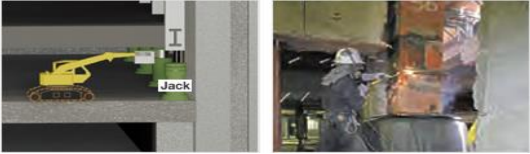
Şekil 3.35. Kajima yöntemi 2. adım (Kajima 2017)
