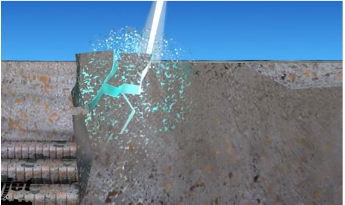
Şekil 3.48. Basınçlı suyun katı malzemeyi parçalaması (Conjet 2019)
