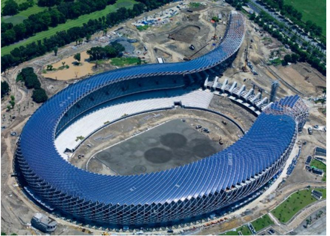
Şekil 3.31. Stadyumun çatısında bulunan güneş pilleri ( http://www.doaraku.com )
