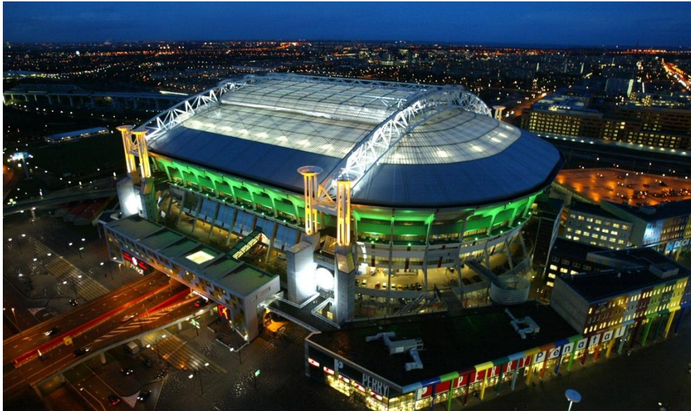
Şekil 3.9. Çatısı açılıp kapanabilen stadlara ilk örneklerden Amsterdam Arena Stadi
