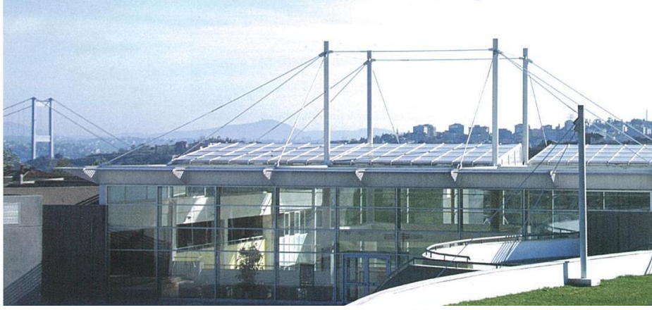
Şekil 4.34. Yapı ve fatih köprüsü (Yapı 2003)
