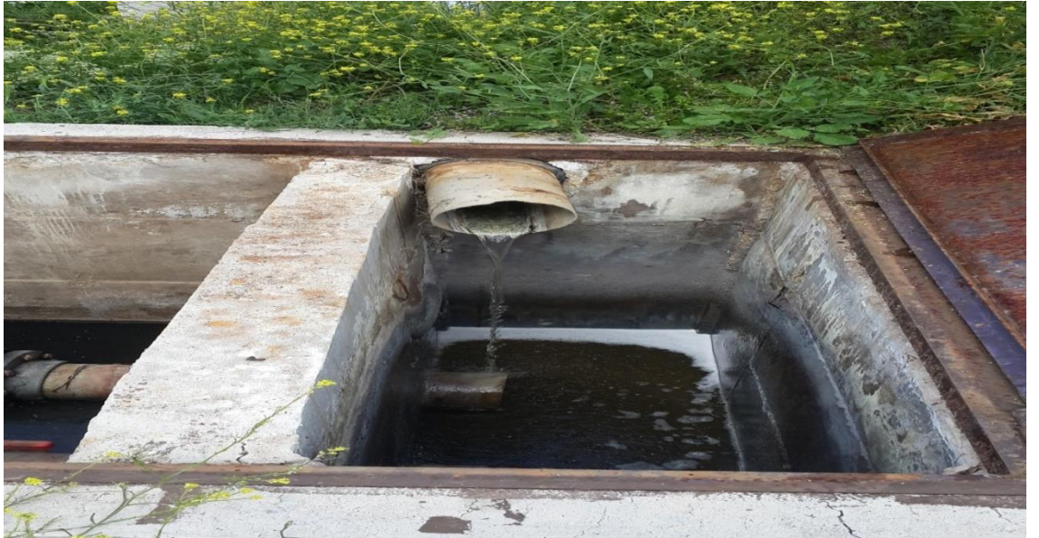
Şekil 4.32. Yenice Doğal Arıtma Tesisi (Çıkış Yapısı)
