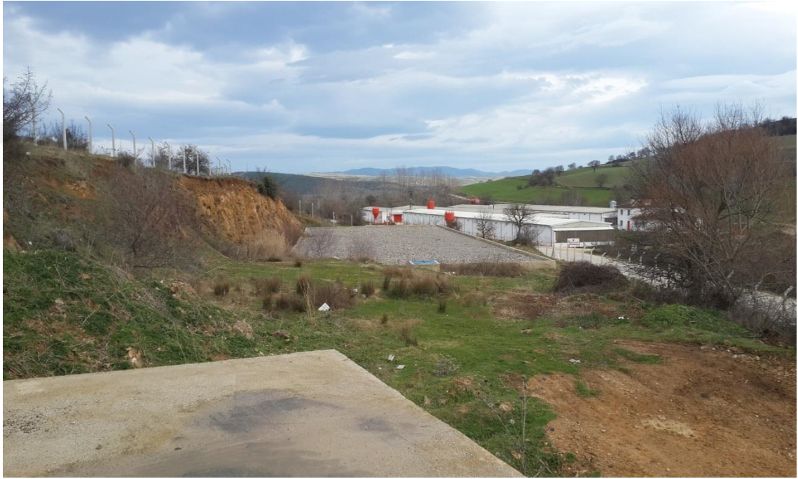
Şekil 4.11. Karacabey Taşpınar Doğal Arıtma Tesisi
