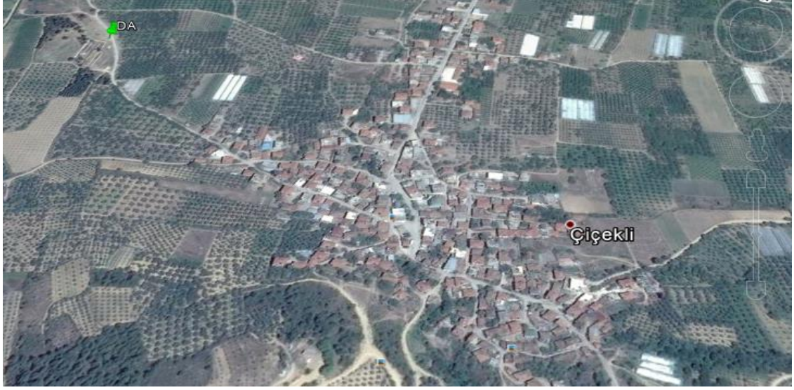
Şekil 4.6. Çiçekli Doğal Arıtma Tesisinin Konumu
