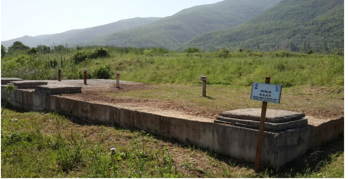
Şekil 4.6. Gürle Doğal Arıtma Tesisi (Foseptik Yapısı)
