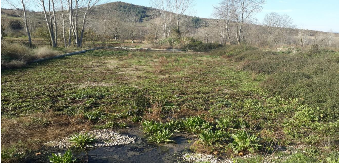
Şekil 4.40. İncirli Doğal Arıtma Tesisi (Yüzey Altı Akış Yapısı)
