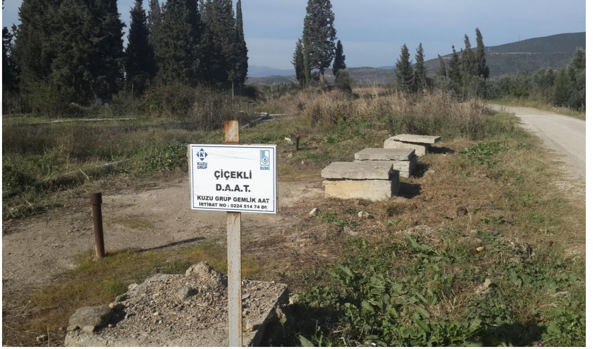
Şekil 4.237. Çiçekli Doğal Arıtma Tesisi (Foseptik Yapısı)
