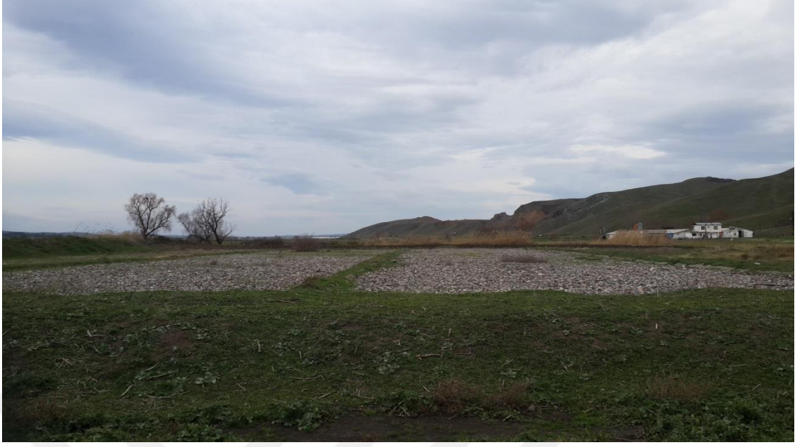
Şekil 4.4. Ocaklı Doğal Arıtma Tesisi (Yüzeyaltı Akış Yapısı)
