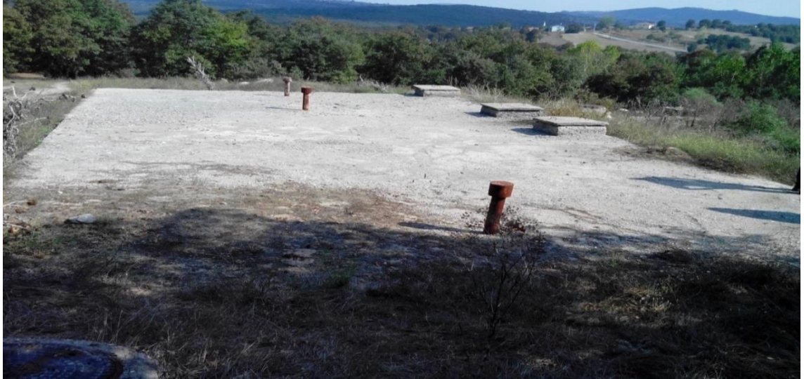
Şekil 4.34. Pınar Doğal Arıtma Tesisini (Foseptik Yapısı)
