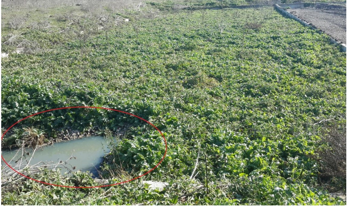
Şekil 4.14. Mentese Doğal Arıtma Tesisi (Arıtma Yapısına Giriş)
