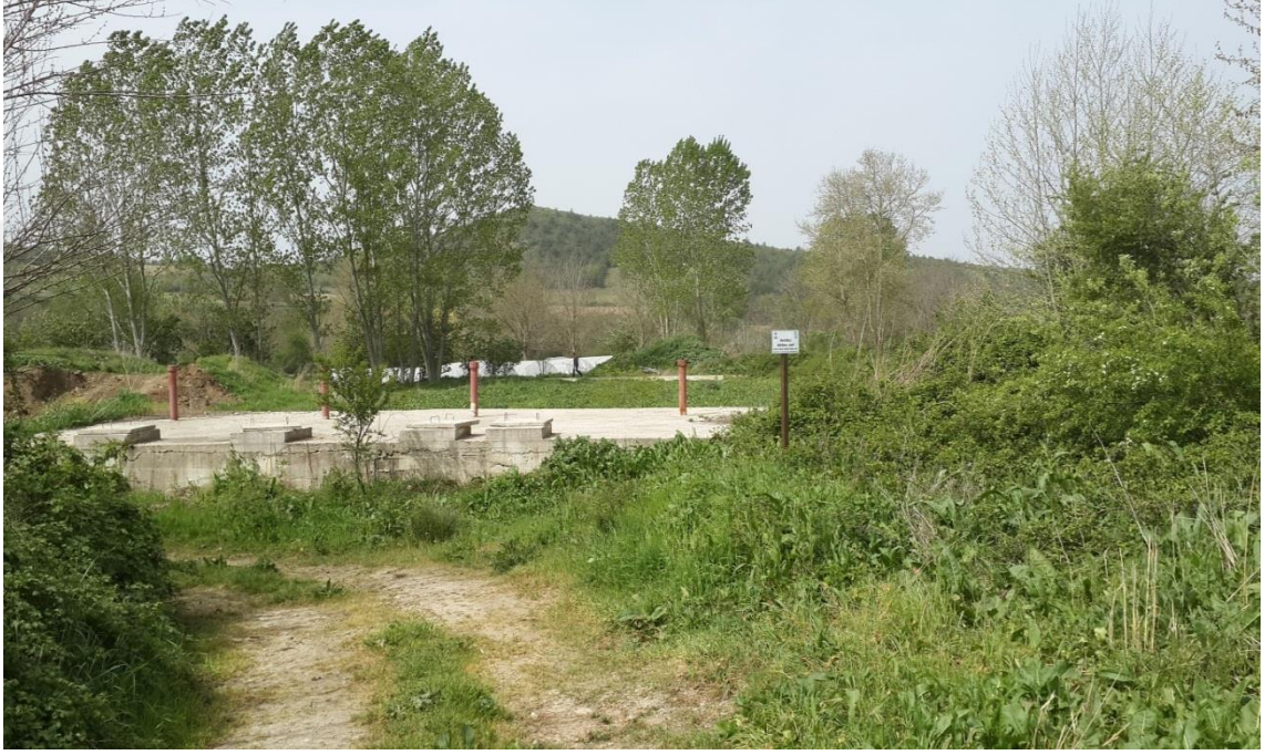
Şekil 4.41. İncirli Doğal Arıtma Tesisi (Foseptik Yapısı)
