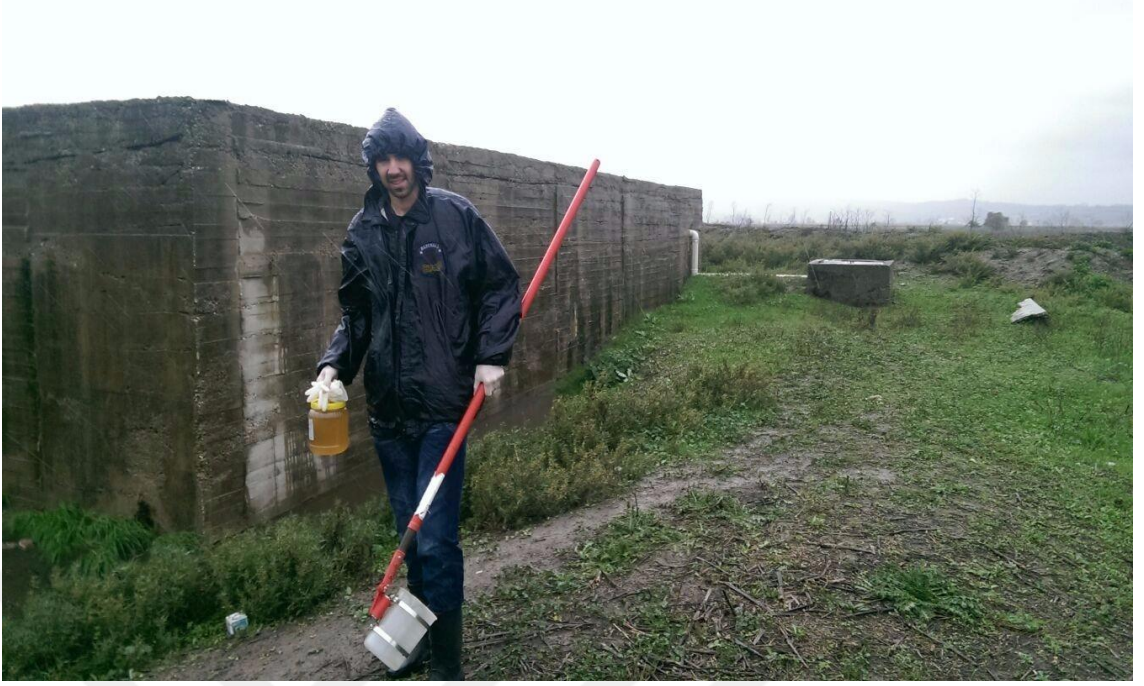
Şekil 4.2. Ocaklı Doğal Arıtma Tesisi Genel Görüntüsü
