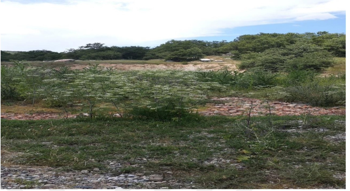
Şekil 4.37. Pınar Doğal Arıtma Yapısı (A Yüzey Altı Akış Yapısı)
