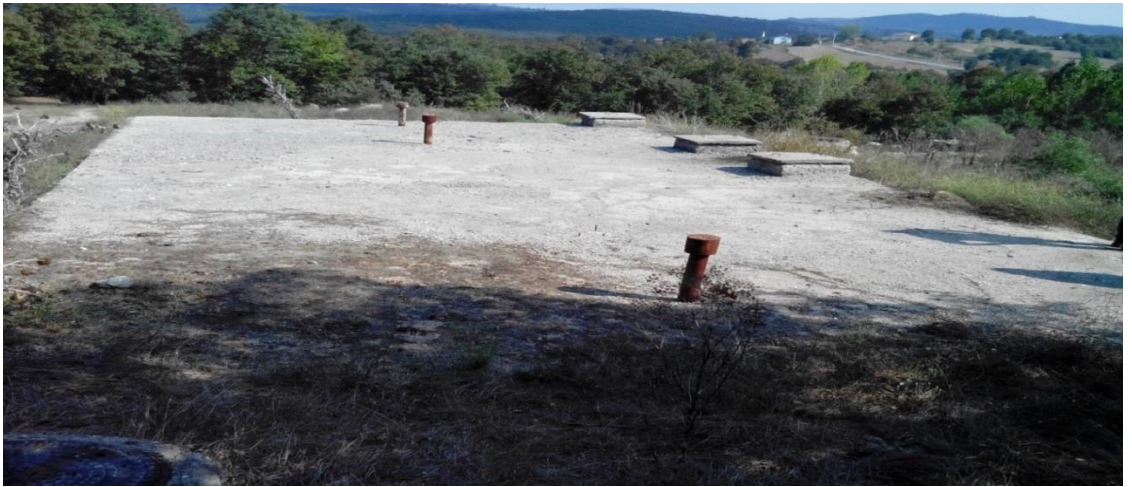
Şekil 4.33. Pınar Doğal Arıtma Tesisi
