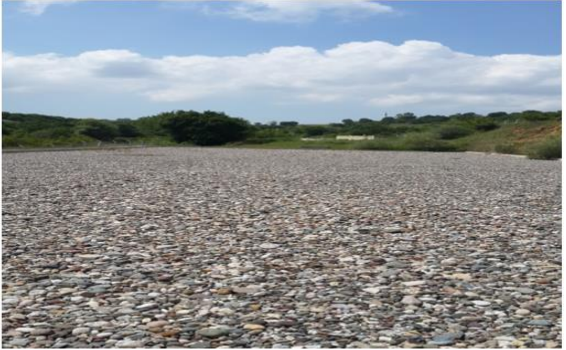
Şekil 4.23. Karacabey Taşpınar Doğal Arıtma Tesisi (Yüzey Altı Akış Yapısı)
