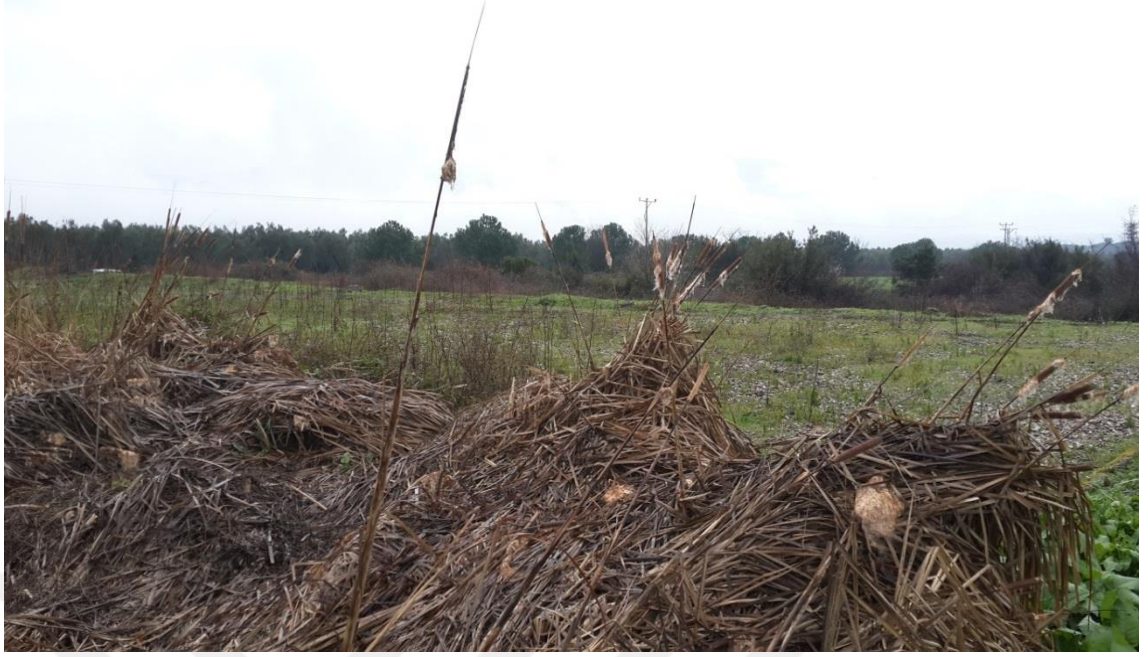
Şekil 4.58. Gürle Doğal Arıtma Tesisi (Yüzey Altı Akış Yapısı)
