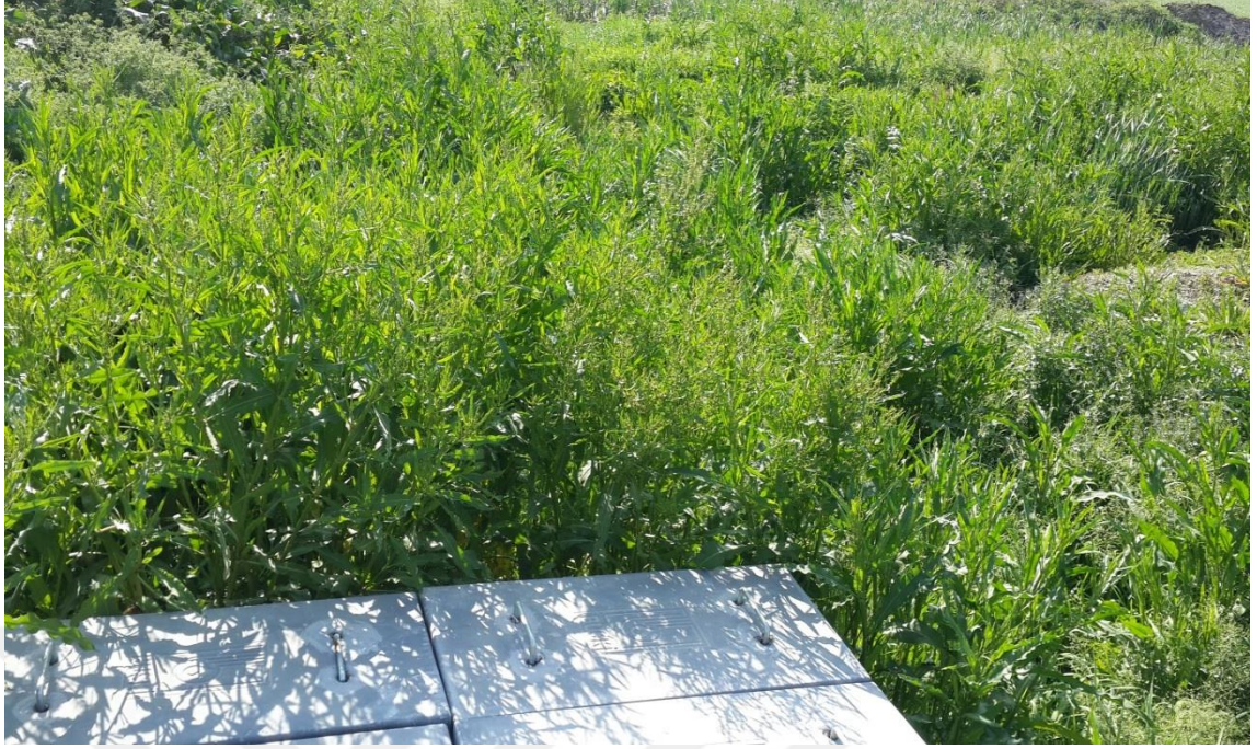
Şekil 4.63. İnegöl Deydinler Doğal Arıtma Tesisi (Çıkış Yapısı)
