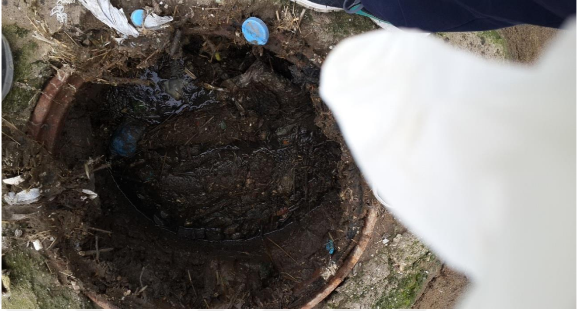
Şekil 4.6. Ocaklı Doğal Arıtma Tesisi giriş yapısı
