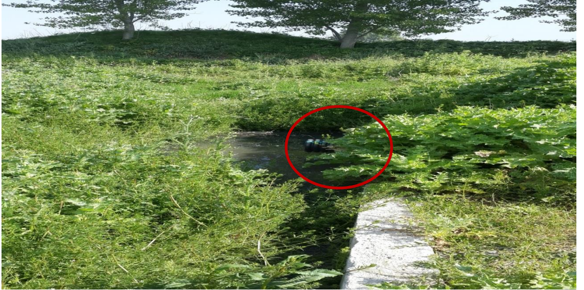
Şekil 4.56. Alibeyk y Dođal Arıtma Tesisi (Y zey Altı Akıř Yapısı ve Giriş Borusu)
