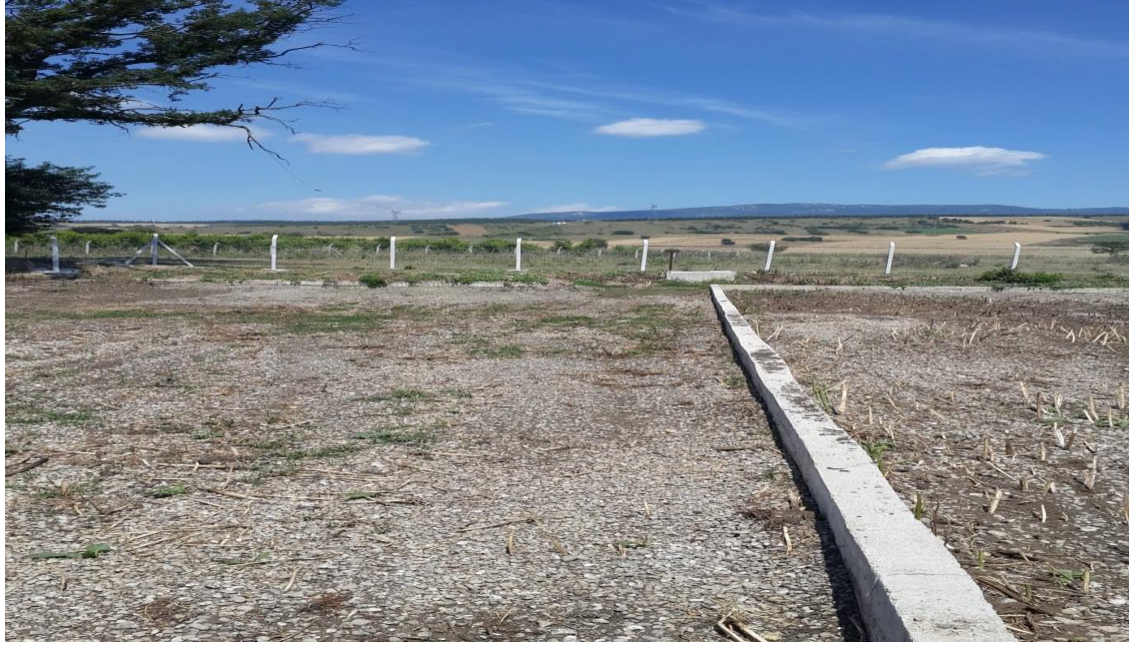
Şekil 4.18. Mentese Doğal Arıtma Tesisi (Yüzey Altı Akış Yapısı)
