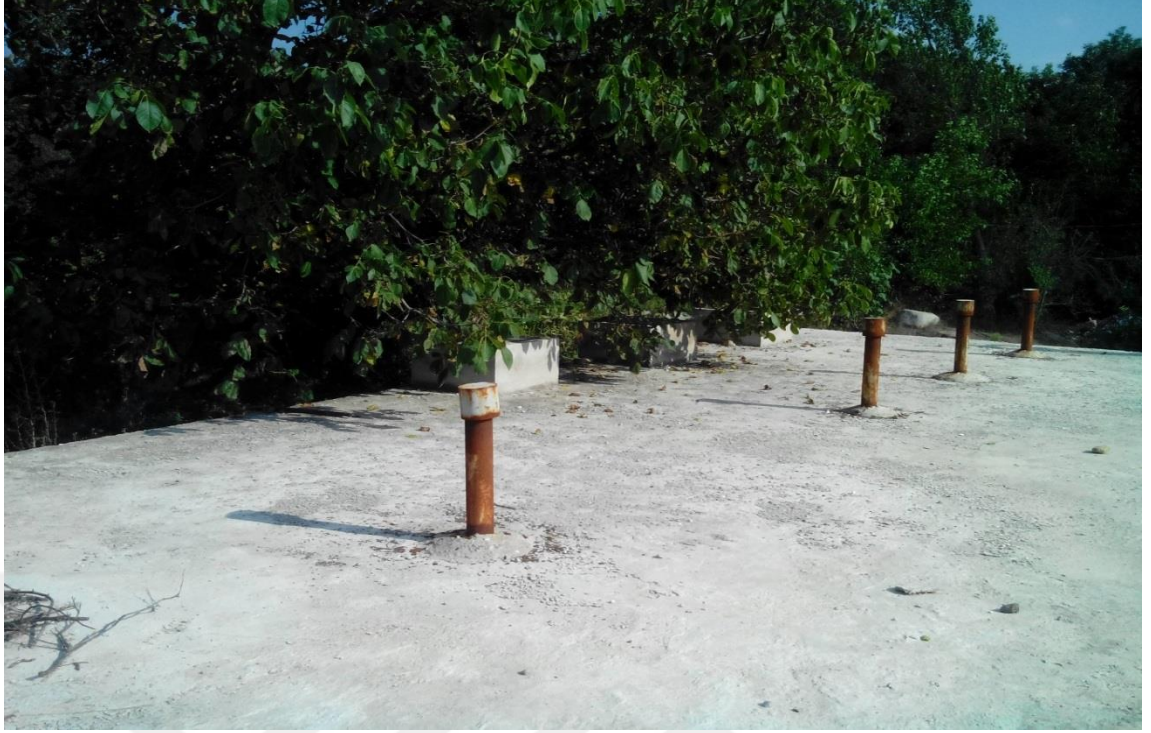
Şekil 4.98. Yenice Doğal Arıtma Tesisi (Foseptik Yapısı)
