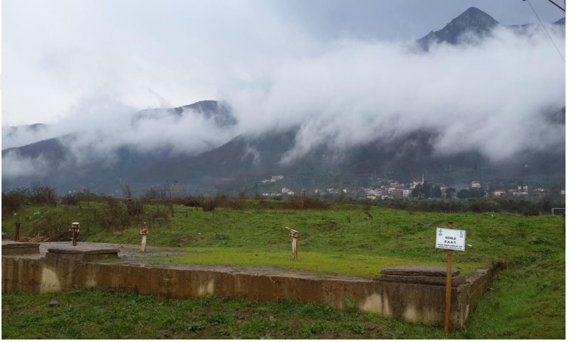
Şekil 4.47. Gürle Doğal Arıtma Tesisini (Foseptik Yapısı)
