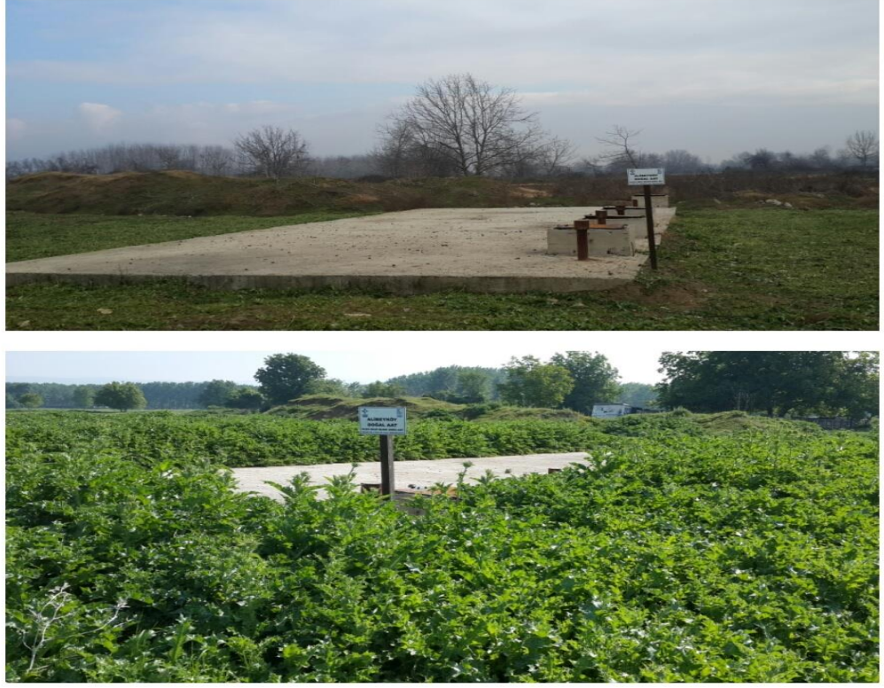
Şekil 4.57. Alibeyköy Doğal Arıtma Tesisi Kış (Üstte) ve İlkbahar (Altta) Çalışmaları
