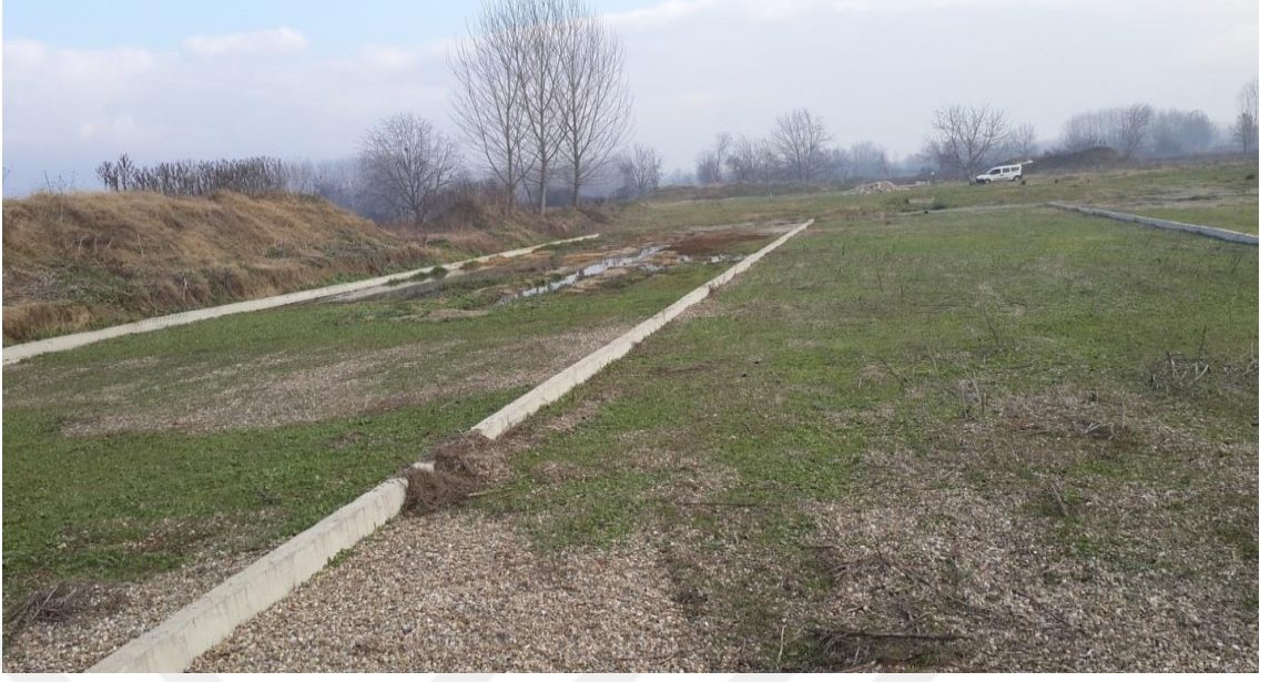
Őekil 4.53. Alibeyk y Doęal Arıtma Tesisi (Y zey Altı Akıő Yapısı)
