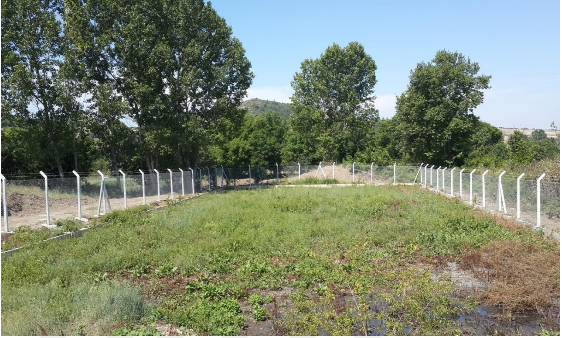
Şekil 4.412. İncirli Doğal Arıtma Tesisi (Yüzey Altı Akış Yapısı)
