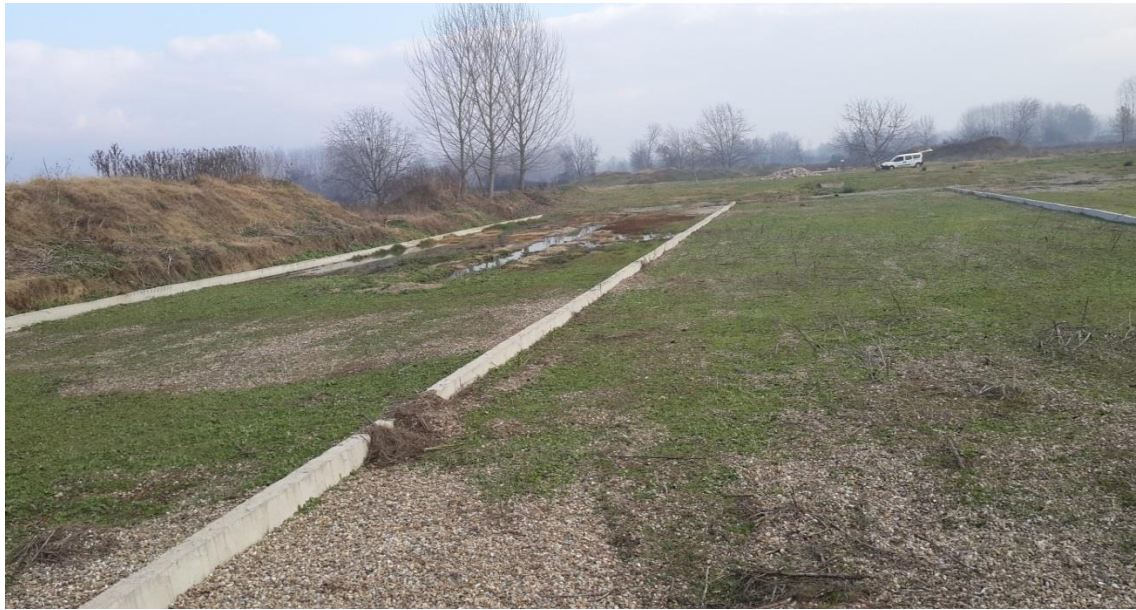
Şekil 4.51. Alibeyköy Doğal Arıtma Tesisi (Yüzey Altı Akış Yapısı)
