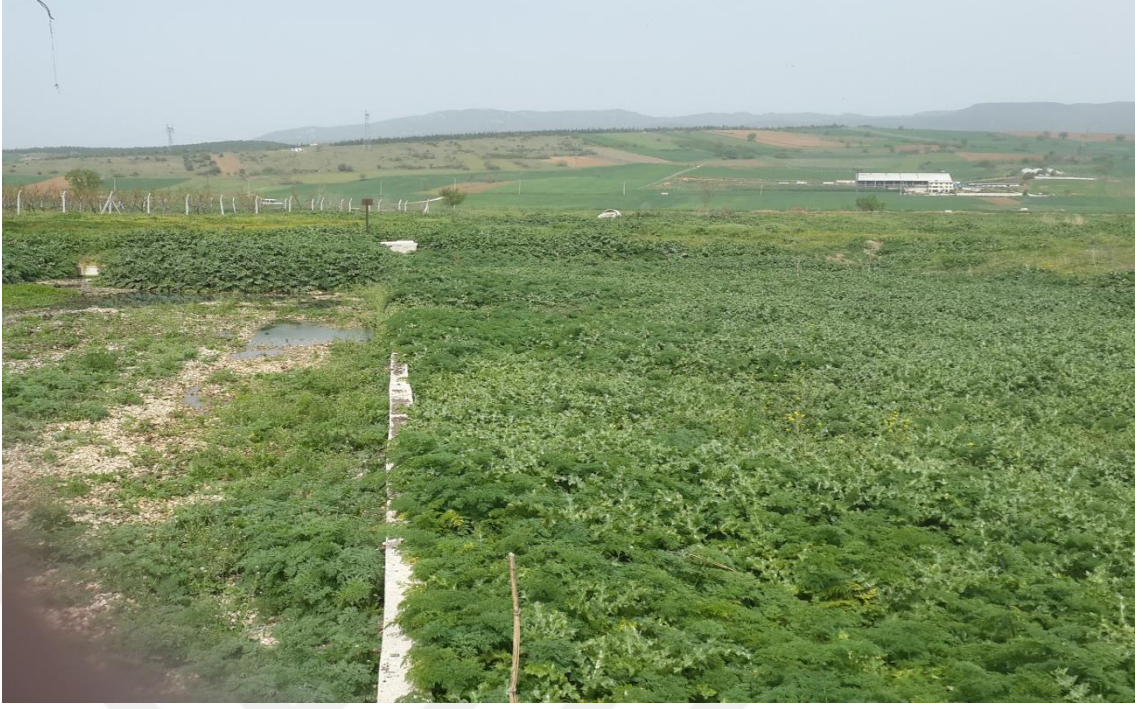
Şekil 4.15. Mentese Doğal Arıtma Tesisi (Yüzey Altı Akış Yapısı)
