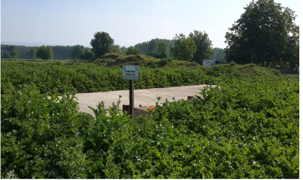
Şekil 4.19. Alibeyk y Dođal Arıtma Tesisi (Giriş ve Fosseptik Yapısı)
