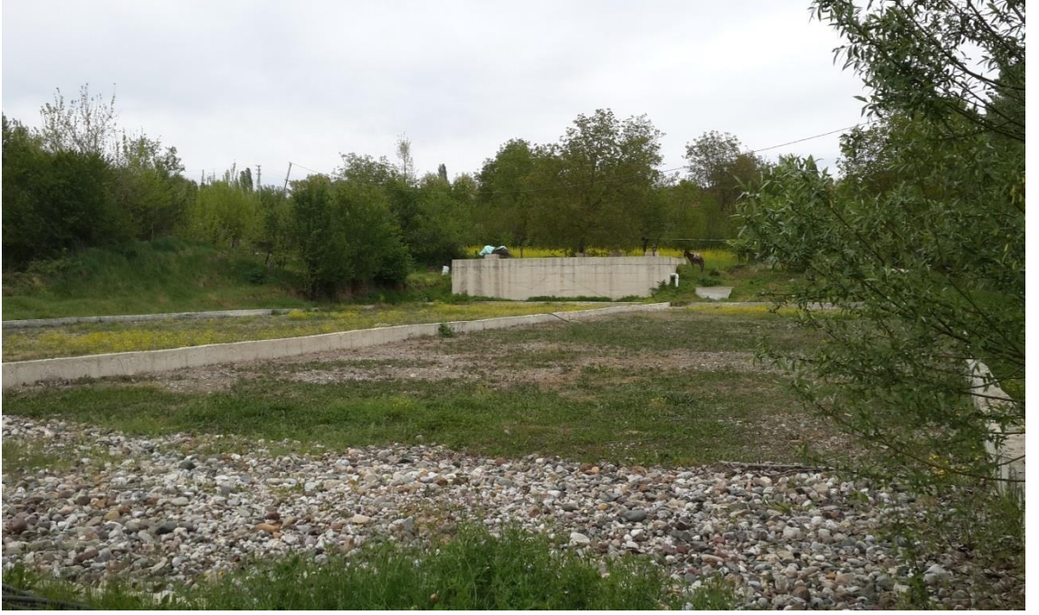
Şekil 4.109. Yenice Doğal Arıtma Tesisi
