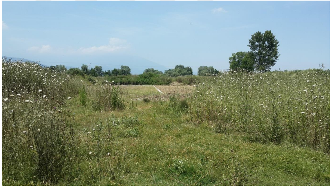
Şekil 4.59. Alibeyk y Dođal Arıtma Tesisi (Y zey Altı Akıř Yapısı)
