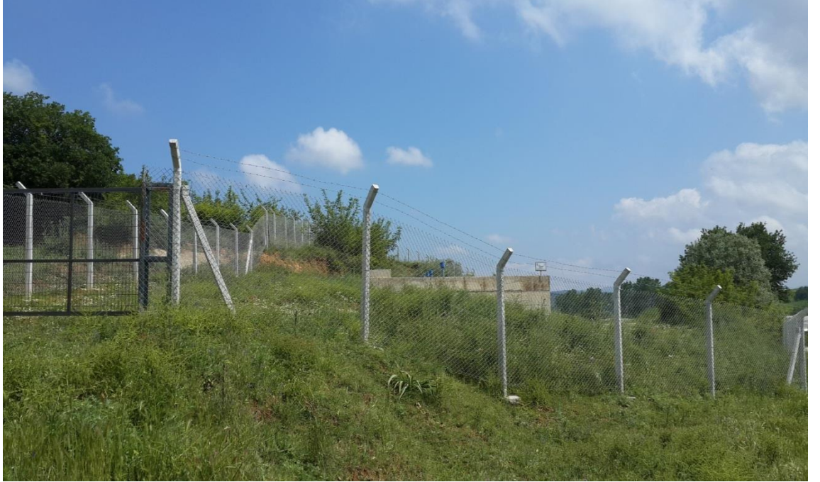
Şekil 4.12. Karacabey Taşpınar Doğal Arıtma Tesisi
