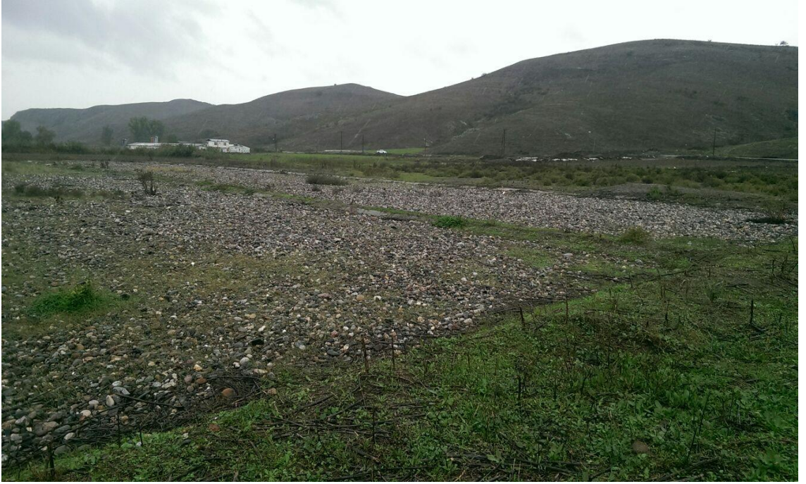
Şekil 4.3. Ocaklı Doğal Arıtma Tesisi
