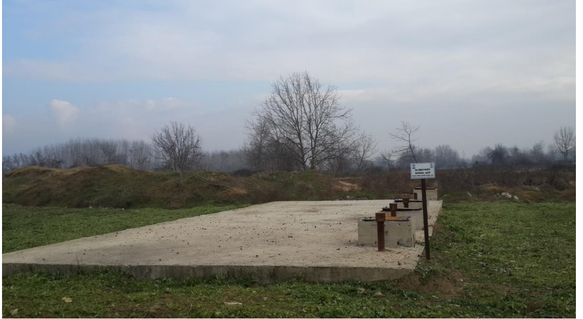
řekil 4.52. Alibeyk y Dođal Arıtma Tesisi (Foseptik Yapısı)
