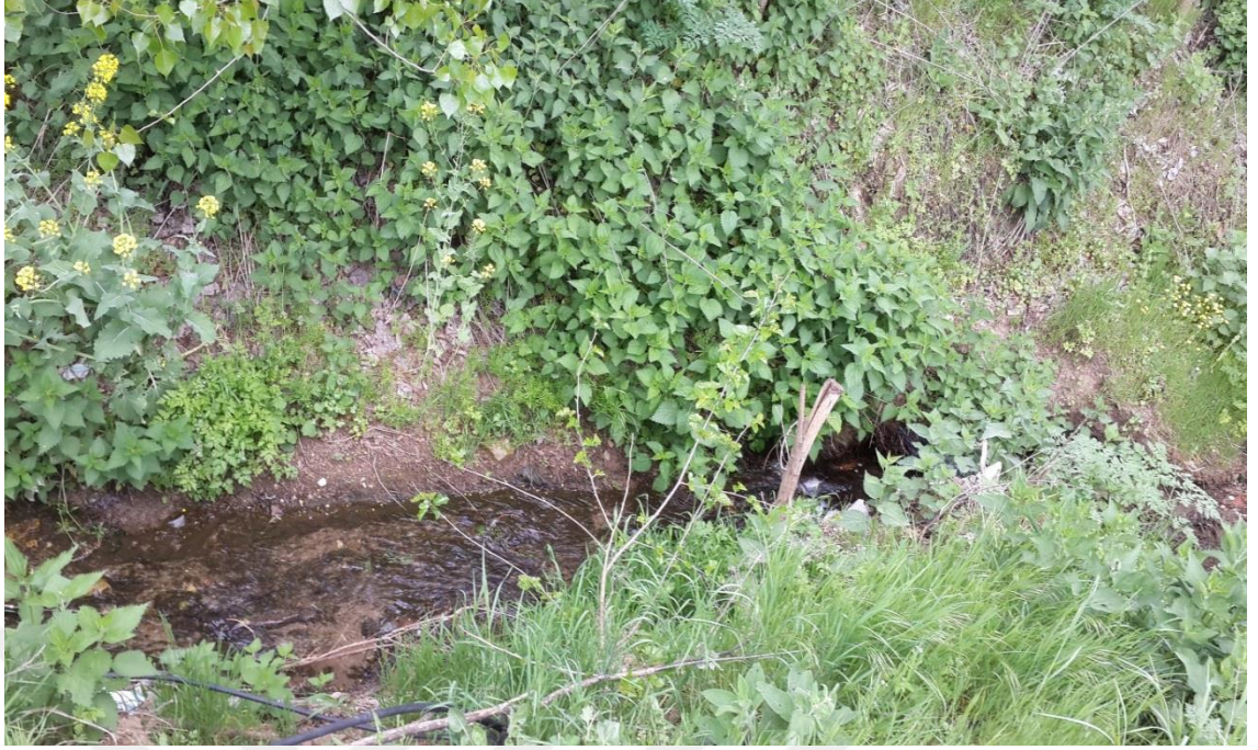
Şekil 4.30. Yenice Doğal Arıtma Tesisi (Deşarj Noktası)
