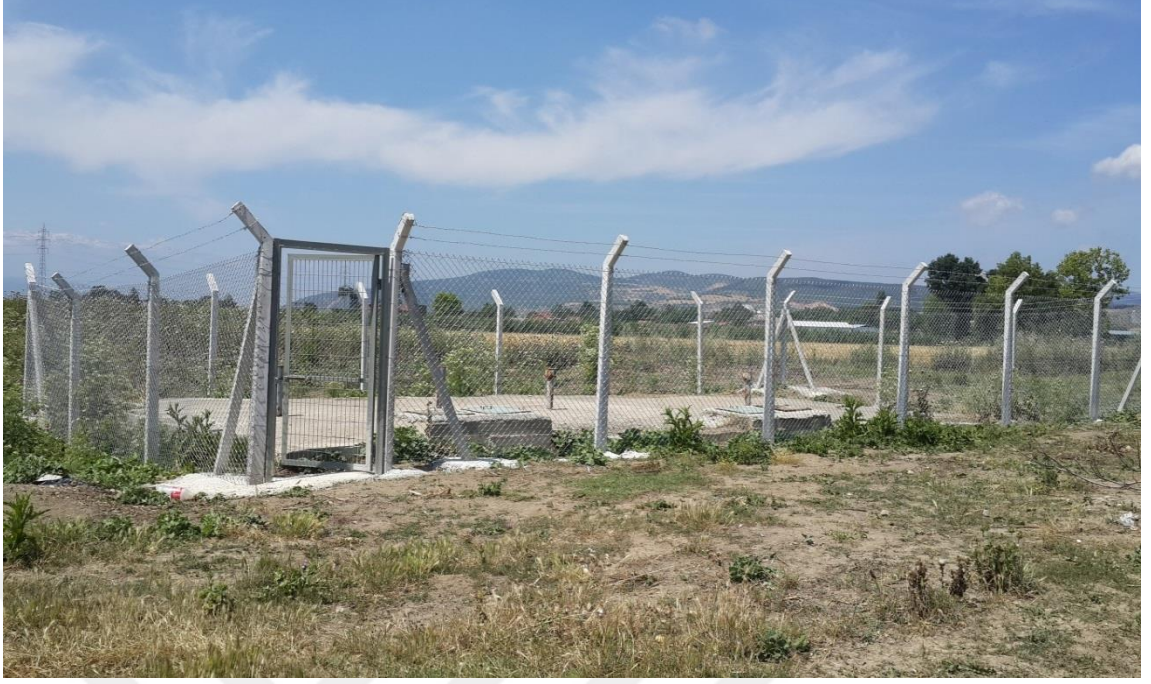
Şekil 4.17. Mentese Doğal Arıtma Tesisi (Foseptik Yapısı)
