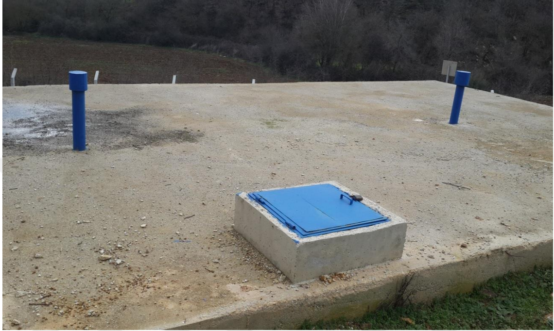
Şekil 4.10. Taşpınar Doğal Arıtma Tesisi (Giriş Yapısı)
