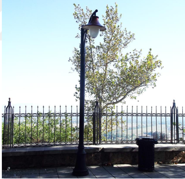
Şekil 4.59. Yaya yolu aydınlatmasında kullanılan tek armatürlü aydınlatma elemanı (Fotoğraf: Gülşah MERCAN 2016)
