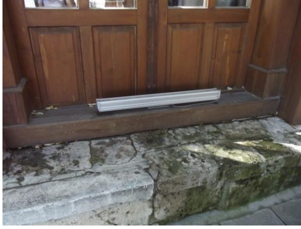
Şekil 4.58. Solda: Türbe cephesini aydınlatma amacıyla kullanılan led armatür, sağda: Şadırvanı aydınlatma amacıyla kullanılan sarkıt armatür (Fotoğraf: Gülşah MERCAN 2016)
