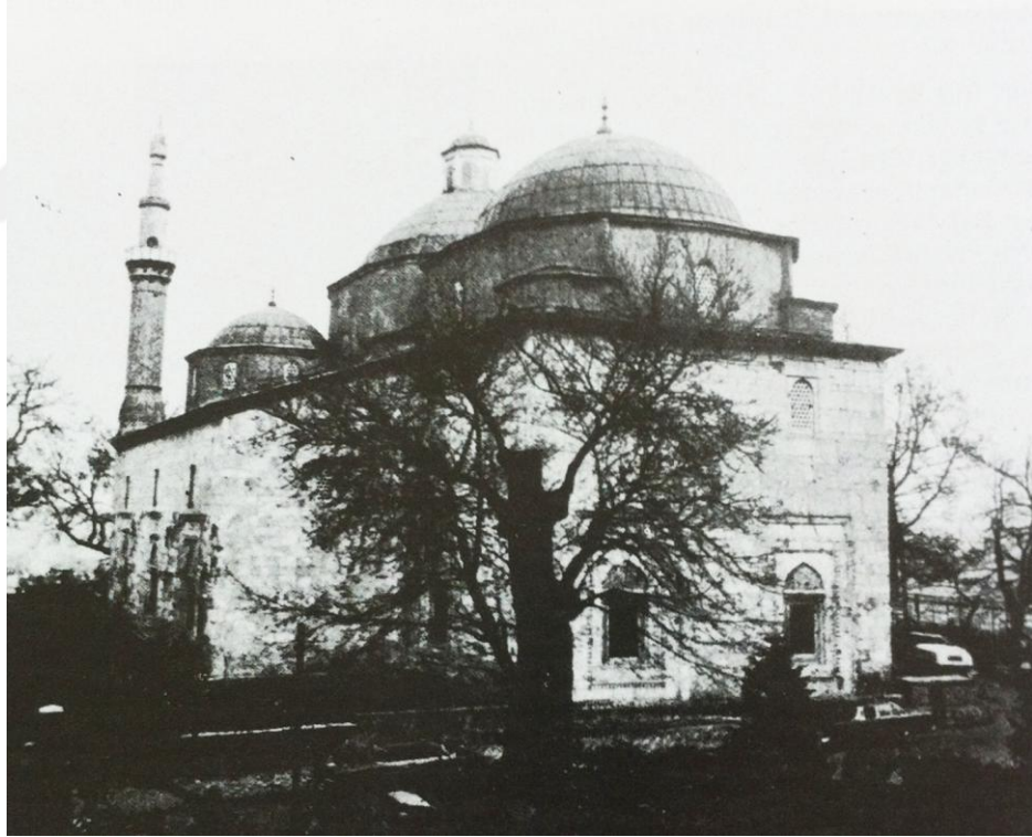
Şekil 4.165. Yeşil caminin güney cephesi (Ayverdi 1966)
