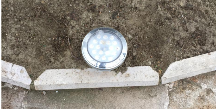
Şekil 4.149. Anıt ağaçları aydınlatma amacıyla kullanılan spot armatür (Fotoğraf: Gülşah MERCAN 2017)
