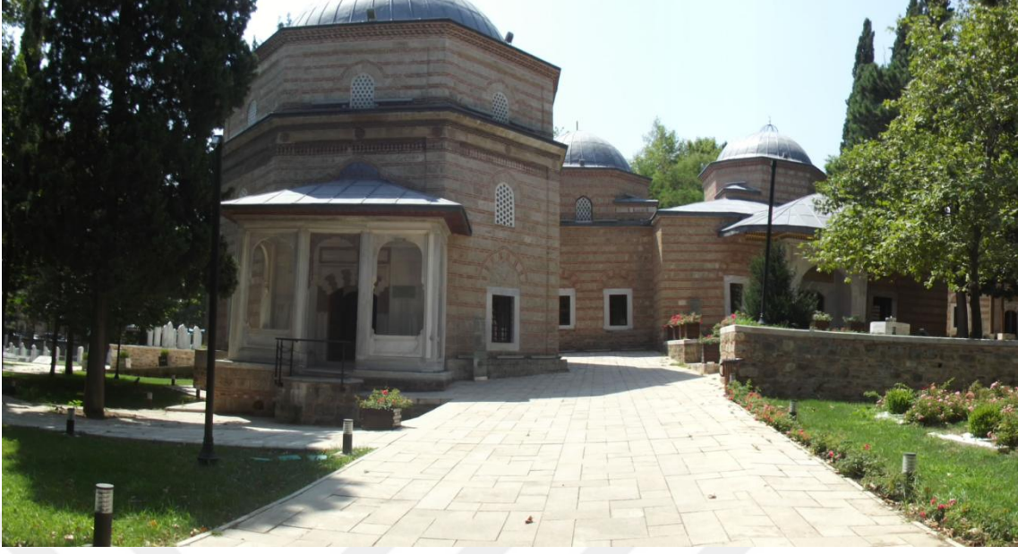
Şekil 4.338. Restorasyon sonrası eskitme traverten zemin döşemeleri (Fotoğraf: Gülşah MERCAN 2016)
