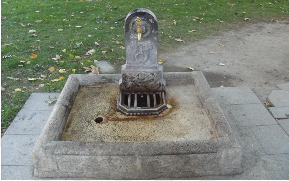
Şekil 4.249. Türbe bahçesinde yer alan bağımsız çeşme (Fotoğraf: Gülşah MERCAN 2016)
