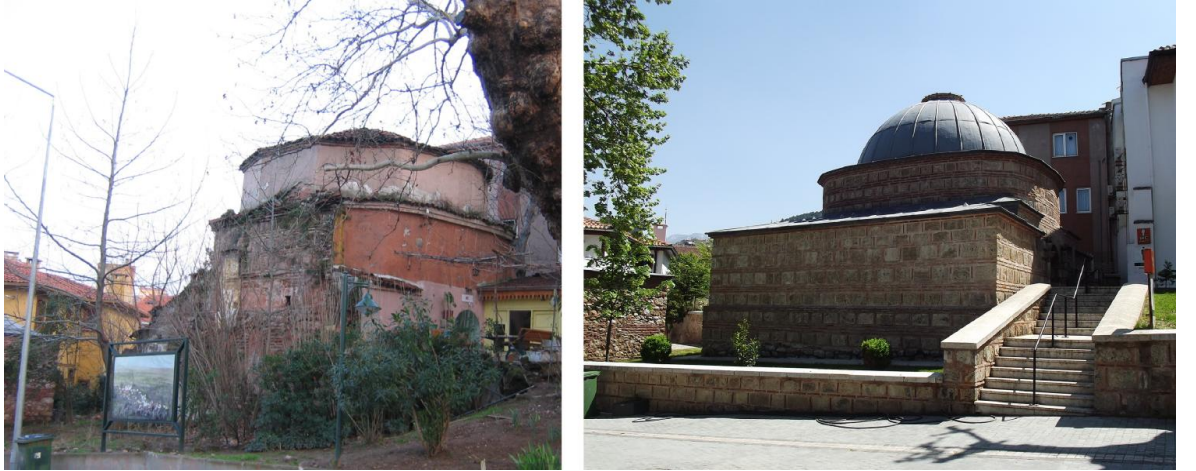
řekil 4.29. Solda: 2012 yılı restorasyon alıřmaları ncesinde hamam ve evresinin durumu, V.G.M. Arřivi (2005), saęda: Aynı aıdan grnm ile hamam giriřindeki merdivenler (Fotoęraf: Glřah MERCAN 2016)
