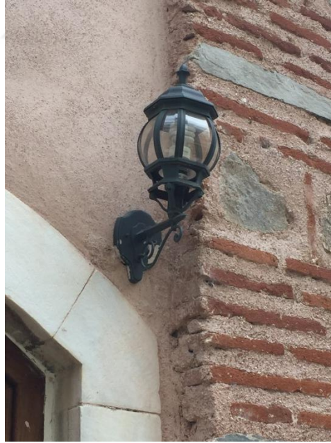
Şekil 4.361. Muradiye camisine ait duvara monte aydınlatma elemanın yakın görünümü (Fotoğraf: Gülşah MERCAN 2016)
