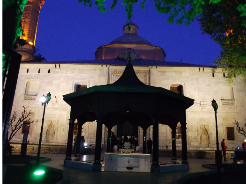
Şekil 4.263. Caminin kuzey cephesinin aydınlatılması (Fotoğraf: Gülşah MERCAN 2017)
