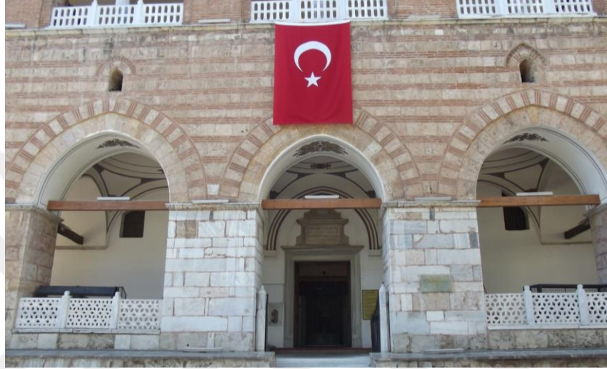
Şekil 4.62. Caminin cephesini aydınlatma amacıyla kullanılan led armatürler. (Fotoğraf: Gülşah MERCAN 2016)
