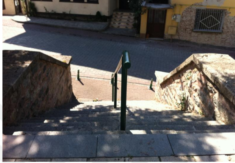
Şekil 4.114. Caminin güneybatısında yer alan sınırlandırma elemanı (Fotoğraf: Gülşah MERCAN 2016)
