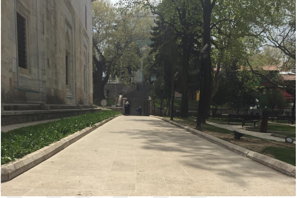
Şekil 4.234. Yeşil Caminin batısında yer alan eskitme traverten malzemeli aks (Fotoğraf: Gülşah MERCAN 2017)
