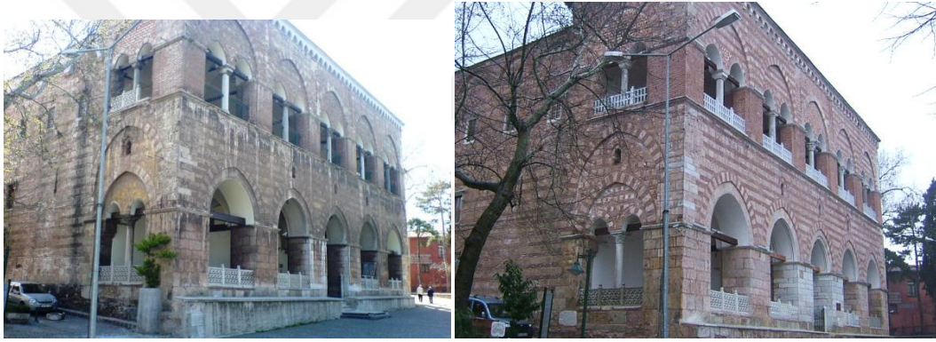
Şekil 4.8. Solda: caminin 1990'lı yıllara ait mermer malzemeli saçağı, sağda: 1990'lı yıllardan sonra yapılan restorasyonu sonrası tuğla malzemeli kirpi saçağı, V.G.M. Arşivi (2005)
