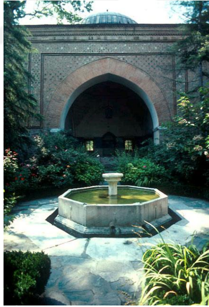
Şekil 4.356. 1981 yılına ait Muradiye medresesi avlusu ve şadırvanı, arkada açık eyvanlı dershane (Anonim 2017ş)
