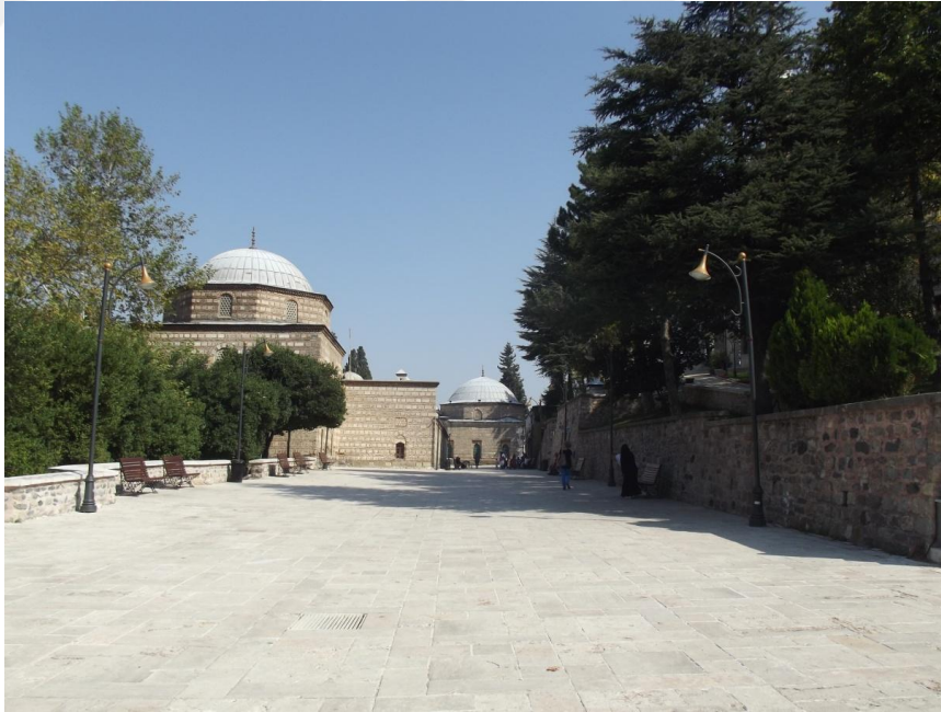
Şekil 4.126. Medrese ve türbe yapılarının bulunduğu bölümdeki aks (Fotoğraf: Gülşah MERCAN 2016)
