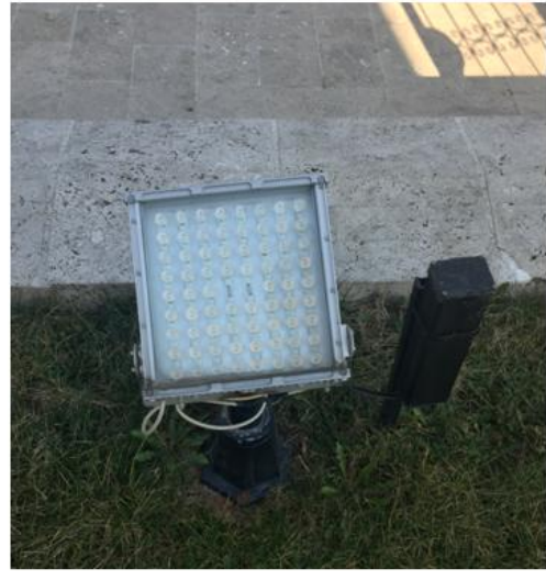
Şekil 4.259. Cami cephelerini aydınlatmak amacıyla kullanılan spot armatür (Fotoğraf: Gülşah MERCAN 2017)
