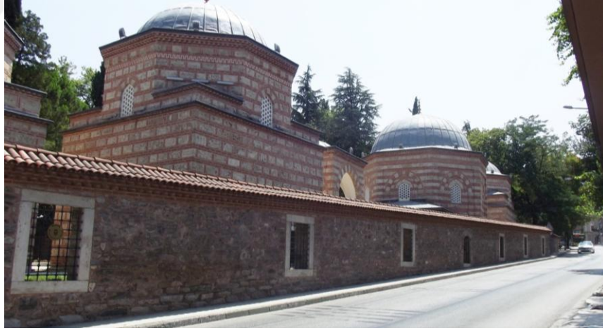
Şekil 4.314. Kaplıca caddesi üzerinde yer alan kuzey-güney aksı üzerindeki almaşık taş duvar sınır elemanı (Fotoğraf: Gülşah MERCAN 2016)
