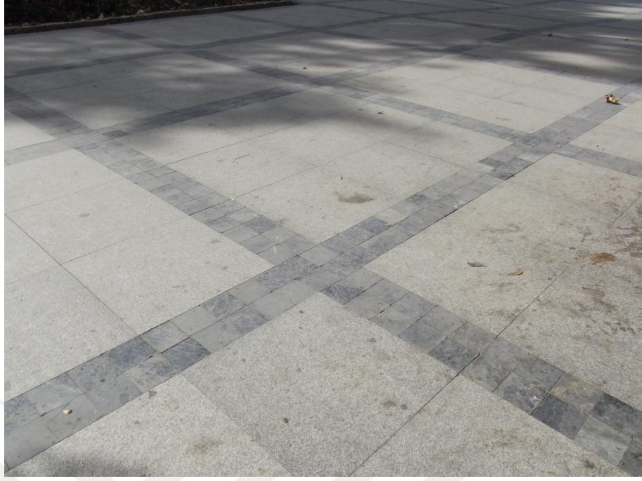
Şekil 4.226. Orta kotta yer alan toplanma alanına ait granit plak taş ve granit küp taş döşeme (Fotoğraf: Gülşah MERCAN 2016)
