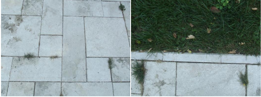
Şekil 4.339. Muradiye Külliyesi farklı ebatlardaki eskitme traverten zemin döşemesi ve bordür detayı (Fotoğraf: Gülşah MERCAN 2016)
