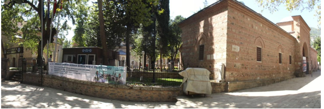
Şekil 4.317. Günümüzde taş örme duvar yerine olan istinat duvarı üzerine kirpi parmaklıklılı ferforje sınır elemanı (Fotoğraf: Gülşah MERCAN 2016)
