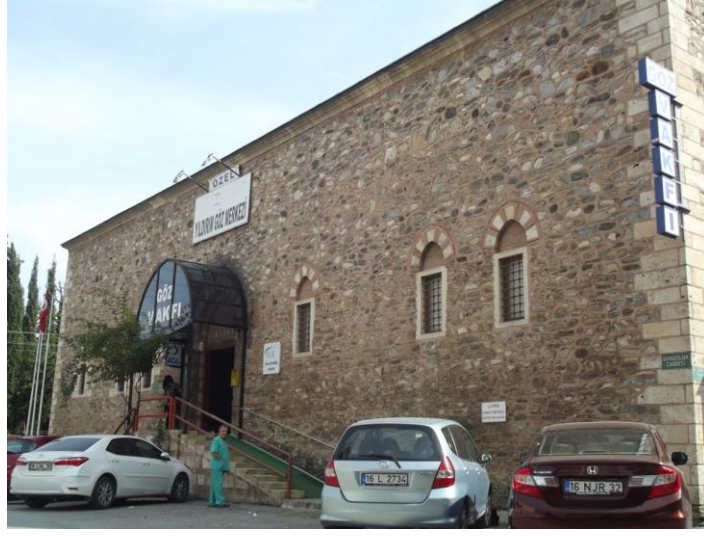
Şekil 4.109. Yıldırım darüşşifa binasının kuzey cephesi (Fotoğraf: Gülşah MERCAN 2016)
