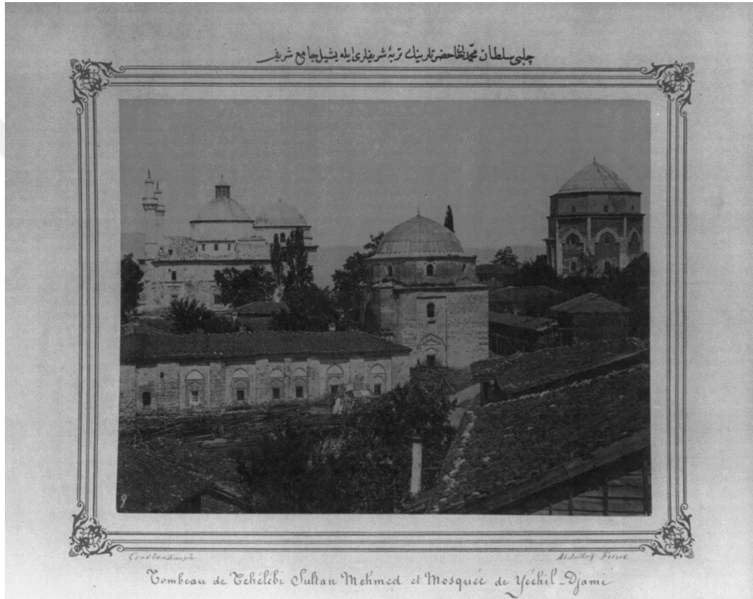
Şekil 4.164. 1800-1893 yılları arası Yeşil Külliyesi, solda önde Yeşil Medrese, sol arkada Yeşil cami ve sağda Yeşil türbe (Anonim 2017ö)
