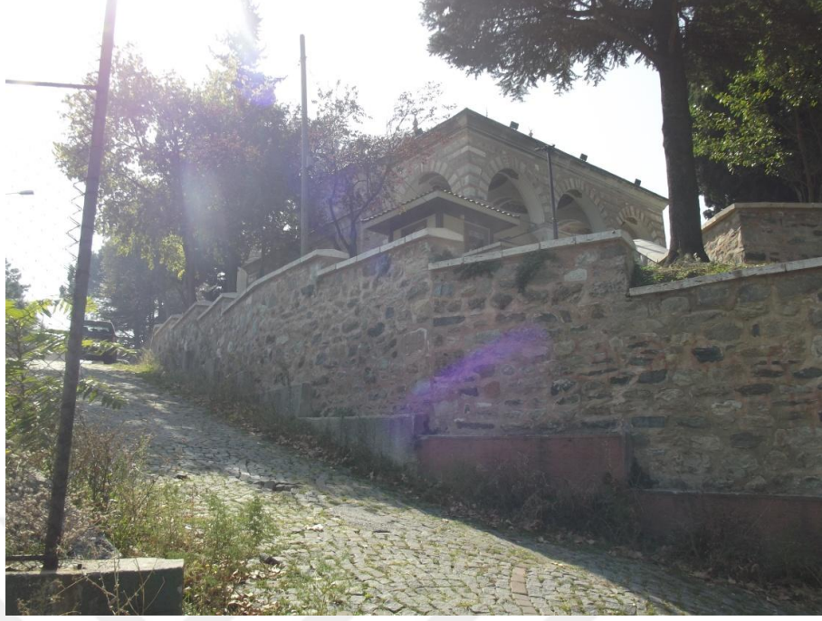
Şekil 4.112. Külliye'nin kuzeydoğusundaki istinat duvarlarının görünümü, arkada: Yıldırım Bayezid türbesi (Fotoğraf: Gülşah MERCAN 2016)
