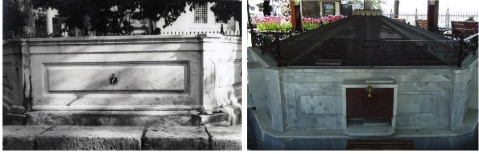
Şekil.4.48. Solda: I. Murad (Murad Hüdavendigâr) Külliyesi'ne ait şadırvan, V.G.M. Arşivi, (Tarihi bilinmiyor), sağda: Su haznesi üzerinde yer alan ferforje üst örtü, mermer ve granit malzemeli cep (Fotoğraf: Gülşah MERCAN 2017)
