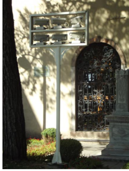
Şekil 4.60. Türbe önündeki altı armatürlü yüksek spot aydınlatma elemanı (Fotoğraf: Gülşah MERCAN 2016)
