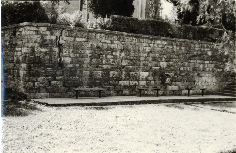
Şekil 4.221. Toplanma alanında yer alan yeşil alan üzerindeki sert zemin ve oturma birimleri (V.G.M. Arşivi)
