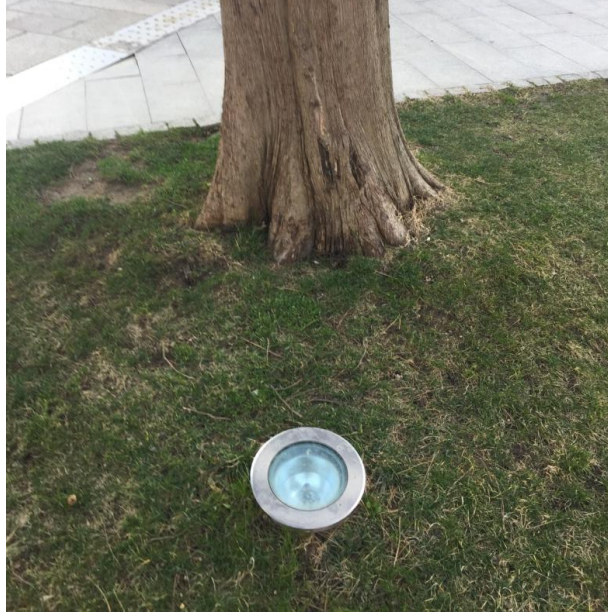
Şekil 4.265. Ağaçları vurgulamak amacıyla kullanılan yere monte spot armatür (Fotoğraf: Gülşah MERCAN 2017)
