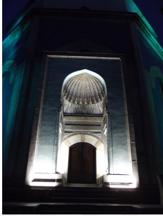
Şekil 4.262. Türbeye ait kuzey cephenin aydınlatılması (Fotoğraf: Gülşah MERCAN 2017)
