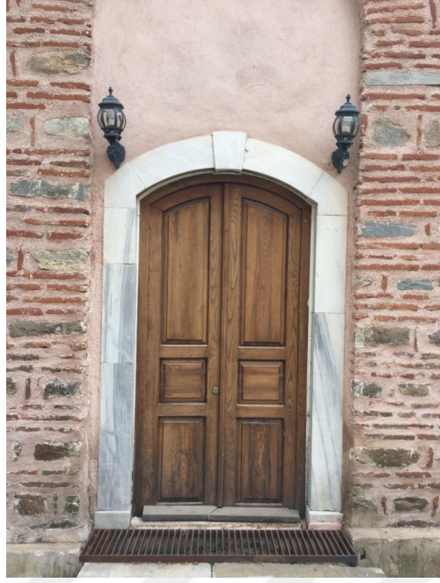
Şekil 4.360. Muradiye camisinin batı cephesindeki duvara monte aydınlatmalar (Fotoğraf: Gülşah MERCAN 2016)
