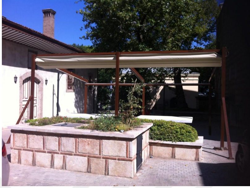
Şekil 4.71. Musalla taşının arkasında çiçek tarhı olarak kullanılan taş ve tuğla malzemeli alçak duvar (Fotoğraf: Gülşah MERCAN 2016)
